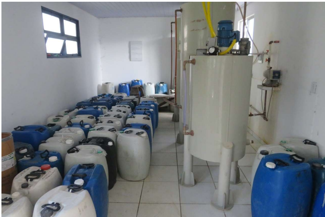
Figura 7. Processo de desinfecção da água na ETA de Afuá.
