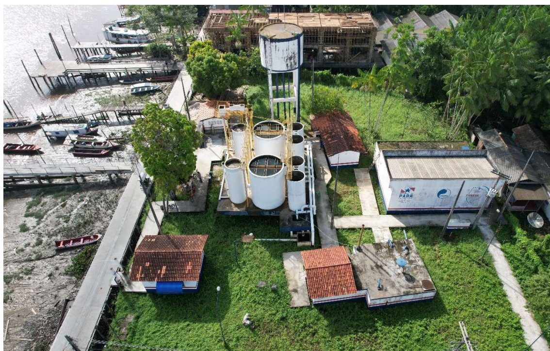
Figura 10. Distribuição geográfica dos reservatórios localizados na área da ETA.
