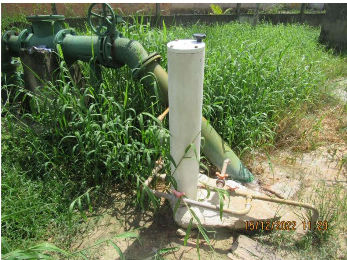
Figura 155. BEL038-DESINFECÇÃO, dosador de cloro em pastilha.
