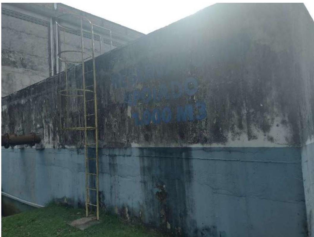
Figura 115. Reservatório Apoiado  $V= 1000m^3$ , BEL010.
