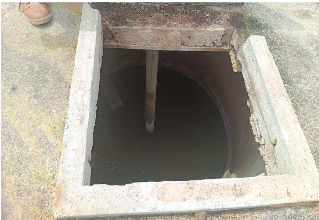
*Figura 280. BEL102-ETE Maracá, área interna do filtro anaeróbio.*
