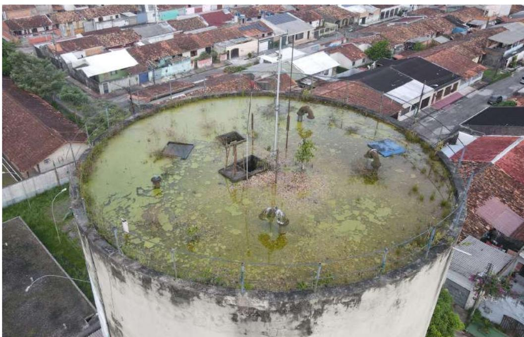
Figura 126. BEL011 REL, acúmulo de água na laje superior.
