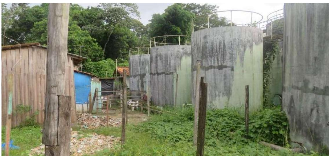
*Figura 348. BEL093-ETE Fé em Deus, reatores anaeróbios.*
