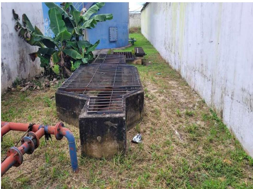
*Figura 292. BEL057-ETE Vila da Barca, gradeamento e caixa de areia.*
