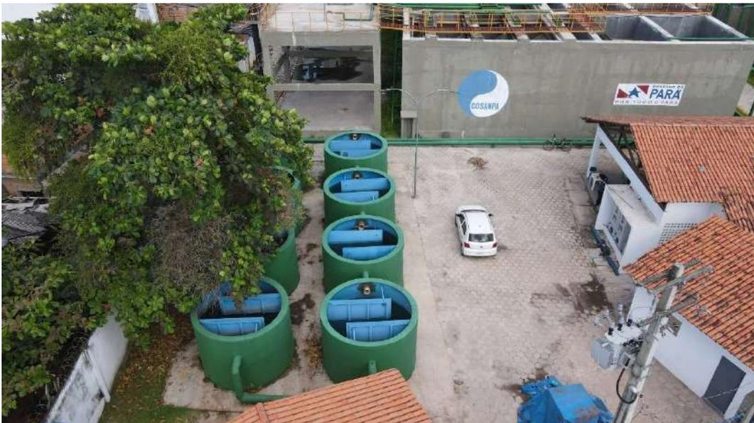
Figura 338. BEL082-ETE Tucunduba, tanques de contato.
