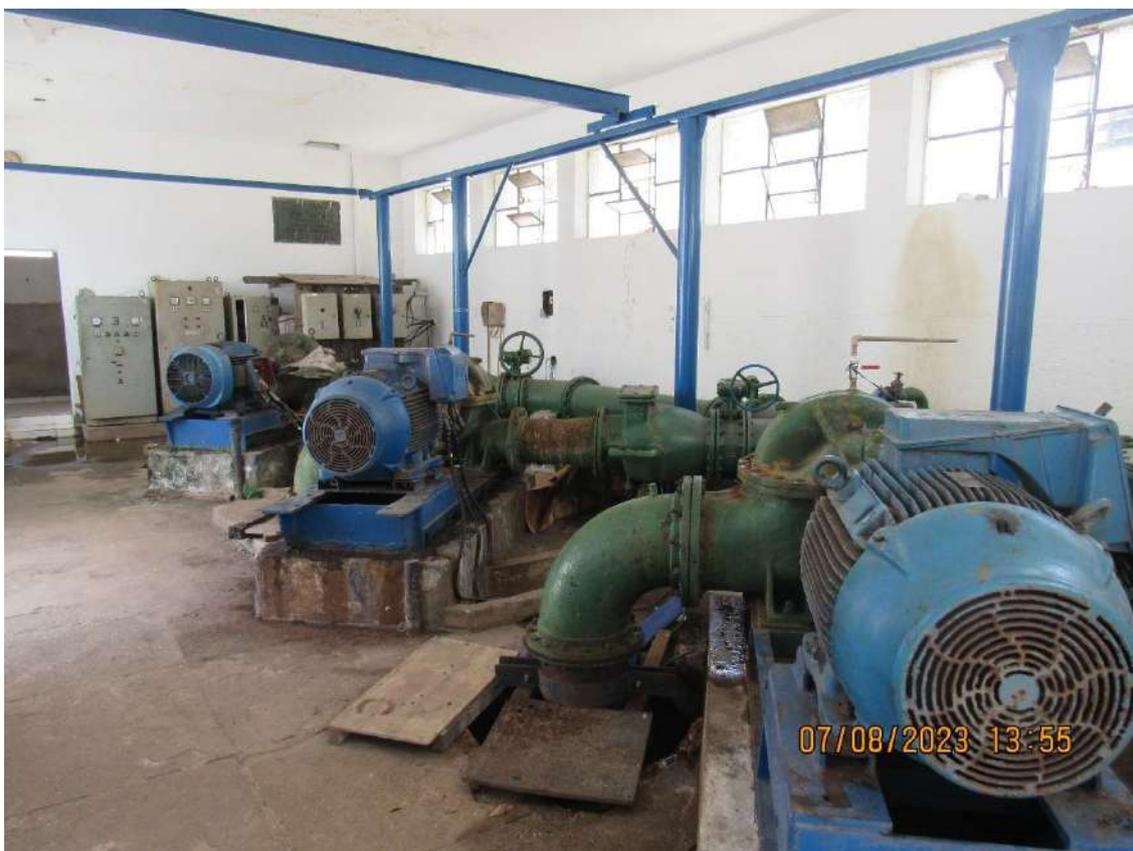
*Figura 48. BEL018-EEAT, Estação Elevatória de Água Tratada.*
