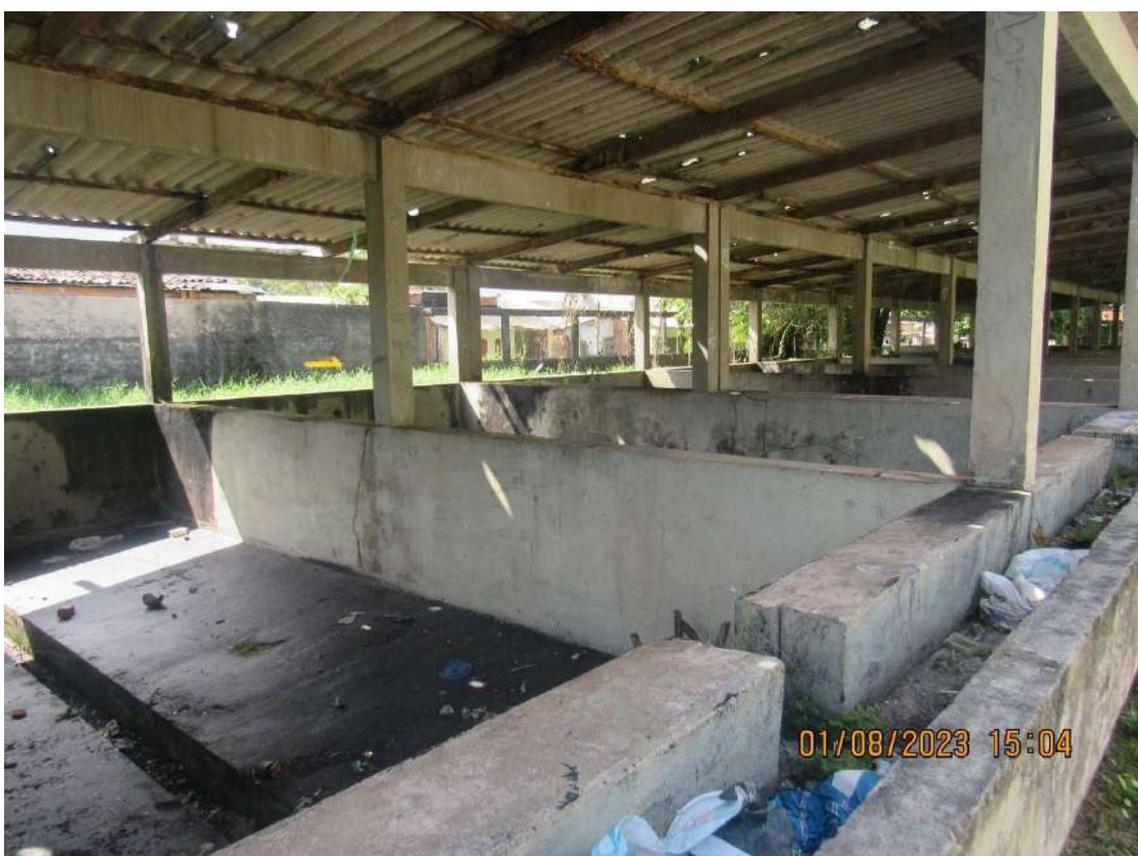
Figura 341. BEL009-ETE Coqueiro, leitos de secagem com acúmulo de resíduos.
