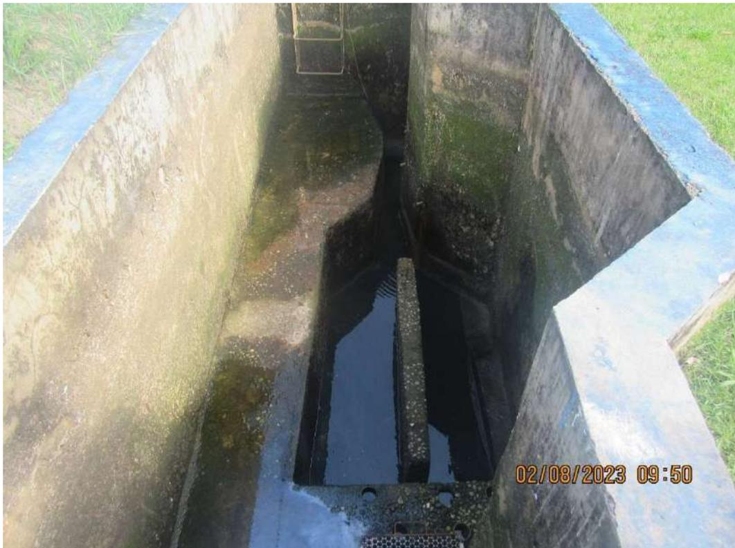
*Figura 297. BEL051-ETE Outeiro, gradeamento e caixa de areia.*
