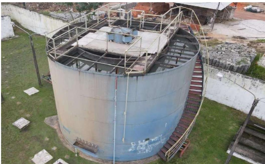
*Figura 293. BEL057-ETE Vila da Barca, reator UASB compacto.*
