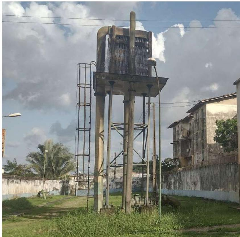
*Figura 110-BEL010-ETA, aerador tipo tabuleiro.*
