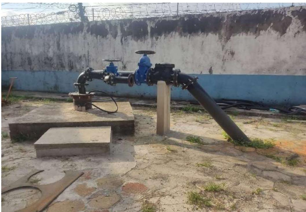
Figura 108. BEL010-CAPTAÇÃO004, subterrânea (poço tubular- EM CONSTRUÇÃO)
