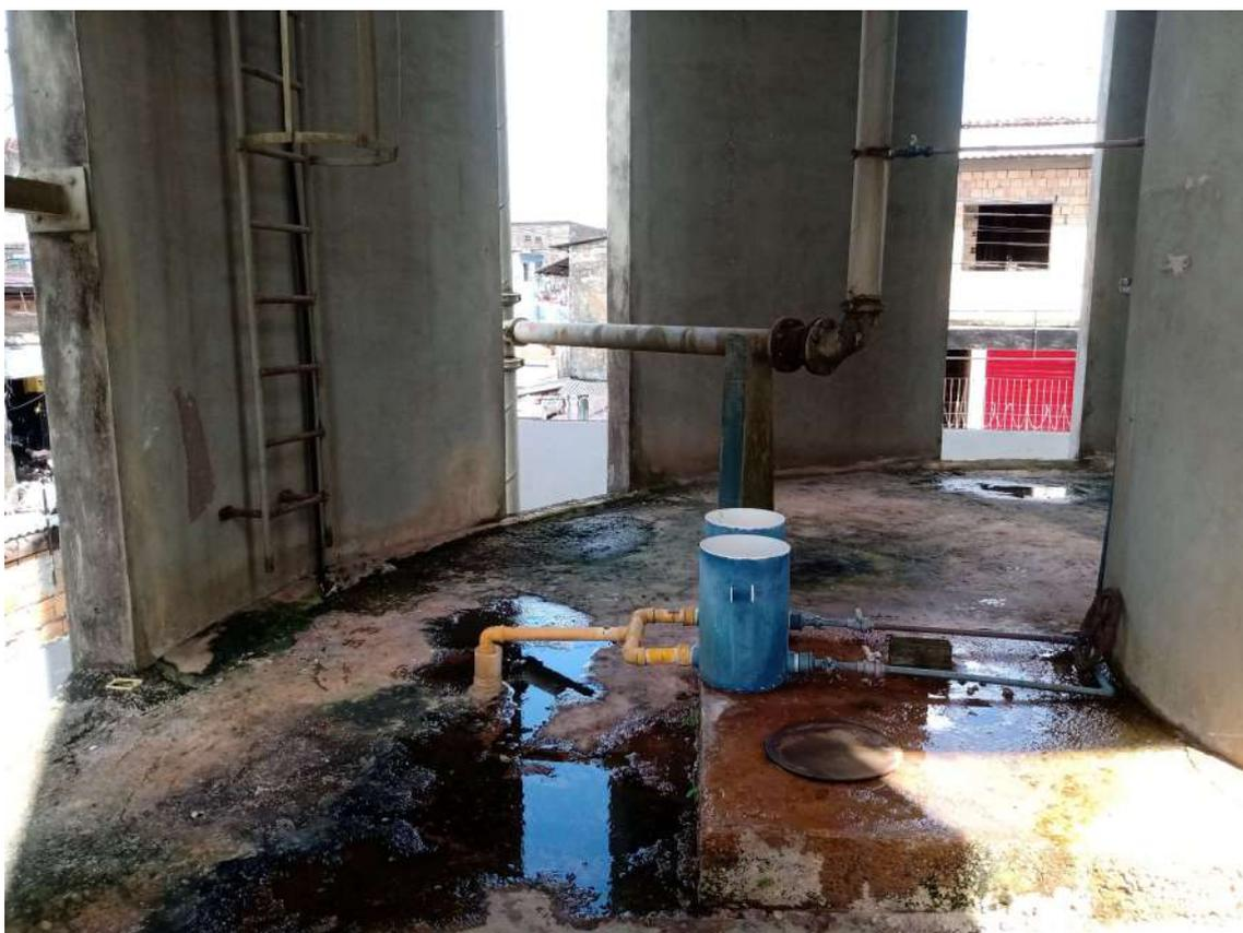
*Figura 94. BEL007-DESINFECÇÃO, dosador de cloro em pastilha.*
