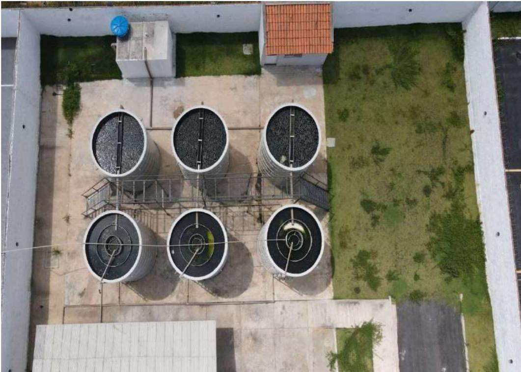
*Figura 283. BEL100-ETE Viver Maracacuera, reatores anaeróbios e filtros anaeróbios.*
