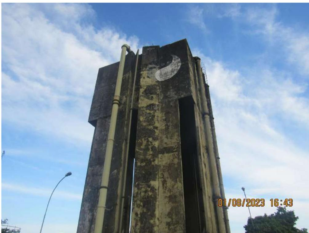
Figura 127. BEL011 REL de lavagem, acúmulo de água na laje superior.
