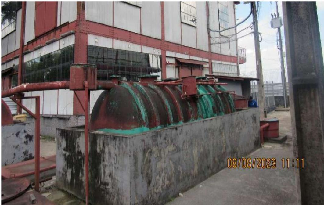
Figura 307. BEL122-ETE Porto, reator anaeróbico e aeróbico.
