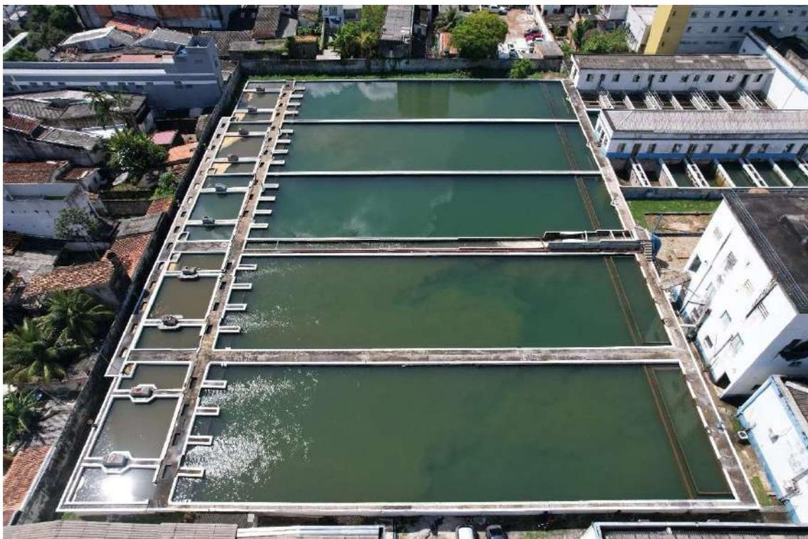
Figura 31. BEL002-ETA, Estação de Tratamento de Água (convencional).
