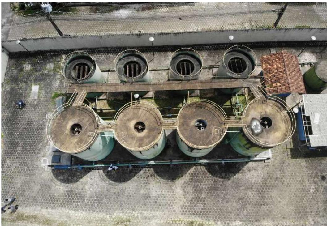
*Figura 334. BEL103-ETE Taboquinha, reatores anaeróbios e filtros aerados.*
