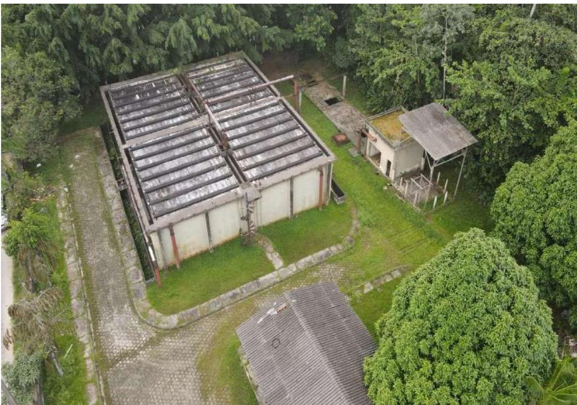
*Figura 330. BEL072-ETE Sideral, reator UASB desativado.*
