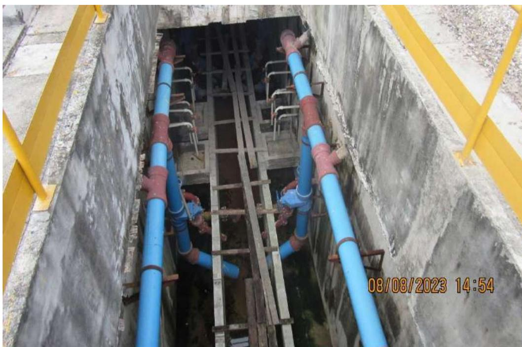
*Figura 290. BELO17-ETE Una, tubulações de esgoto e passarela de madeira.*
