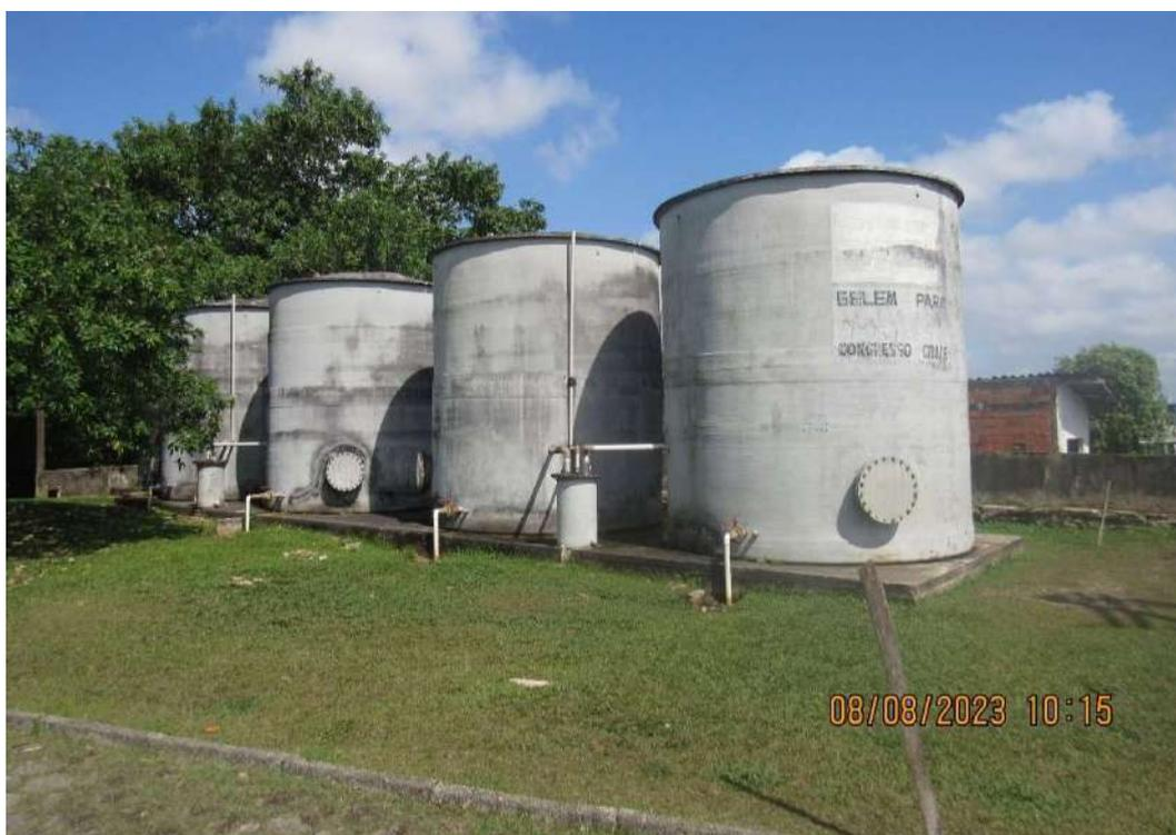
Figura 321. BEL043-ETE Pratinha, reatores anaeróbios (UASB).
