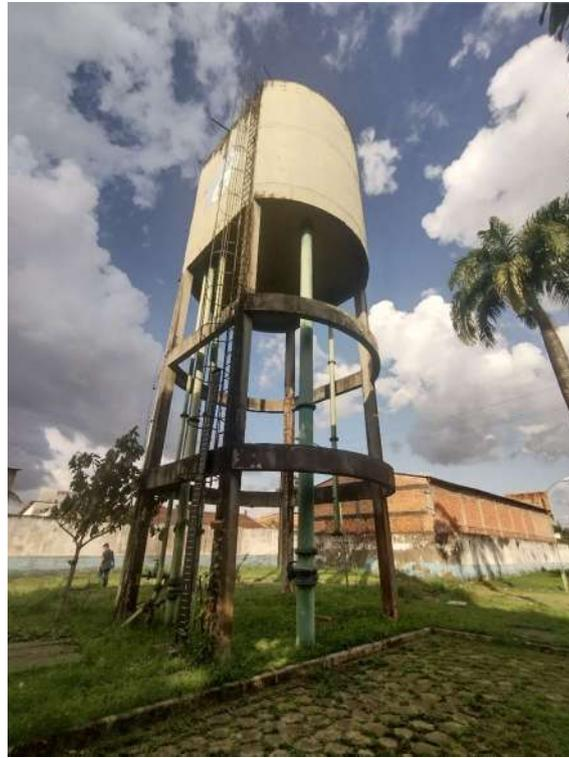
*Figura 113. Reservatório Elevado lavagem dos filtros, BEL010.
