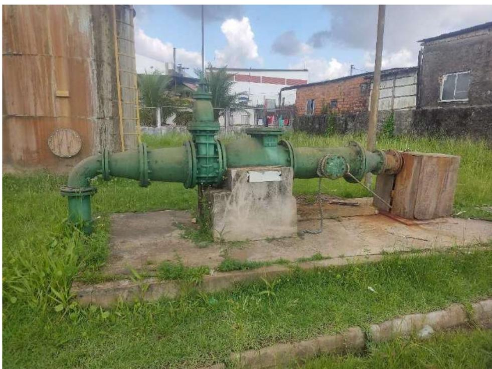
*Figura 157. BEL040- Captação – Poço tubular.*
