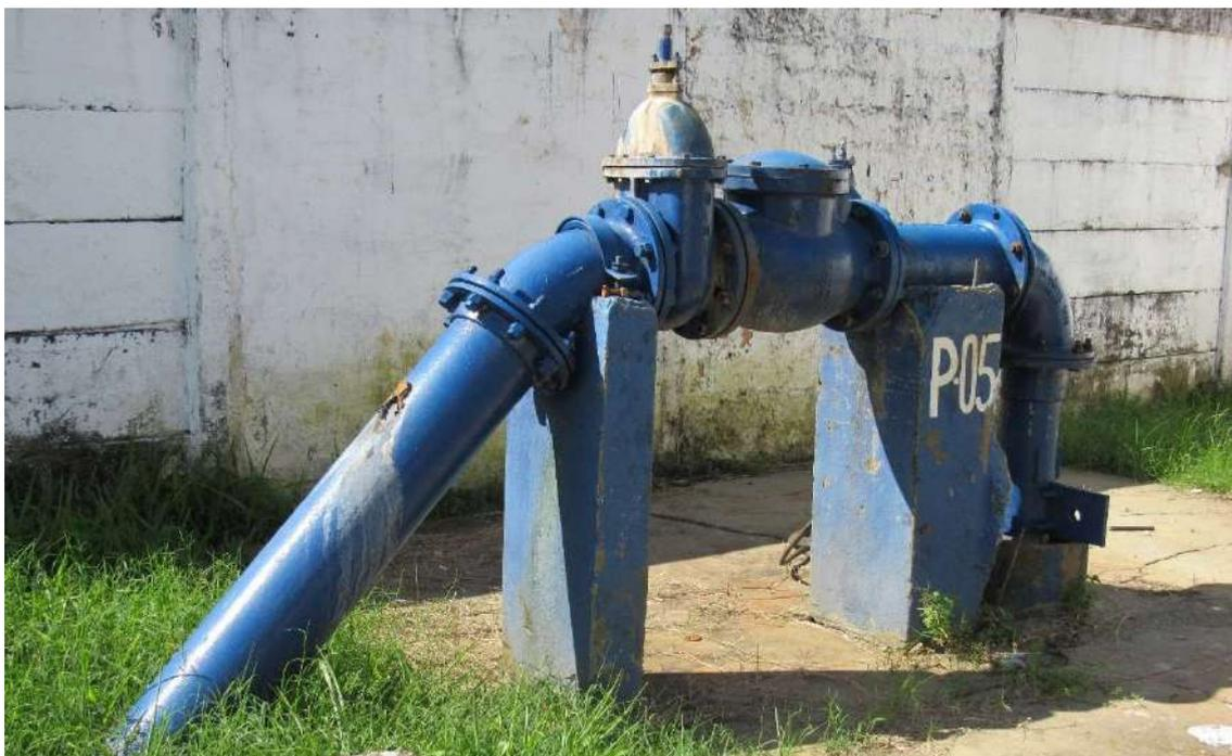
*Figura 83. Captação - BEL031, poço tubular profundo 05.*
