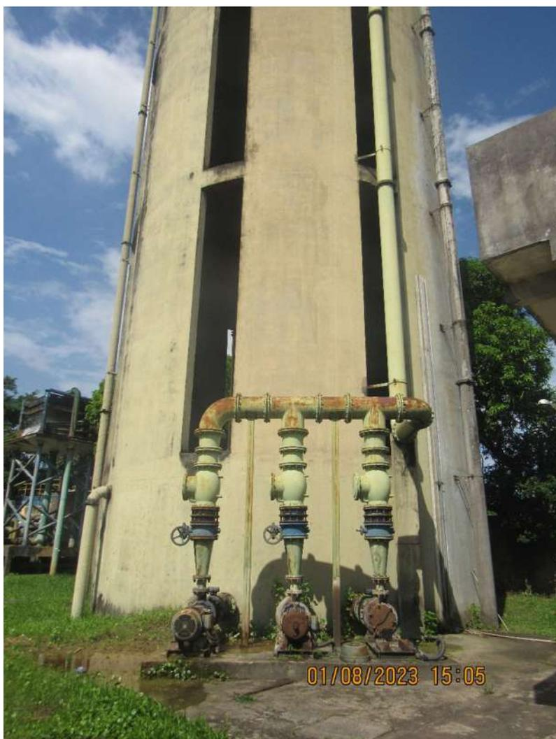
Figura 104. RAP localizado na base do Reservatório Elevado, BEL009.
