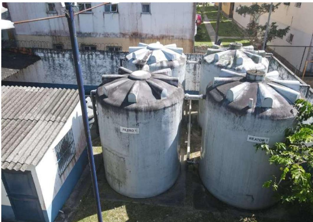
*Figura 311. BEL070-ETE Viver Portal, reatores anaeróbios e filtros aerados.*
