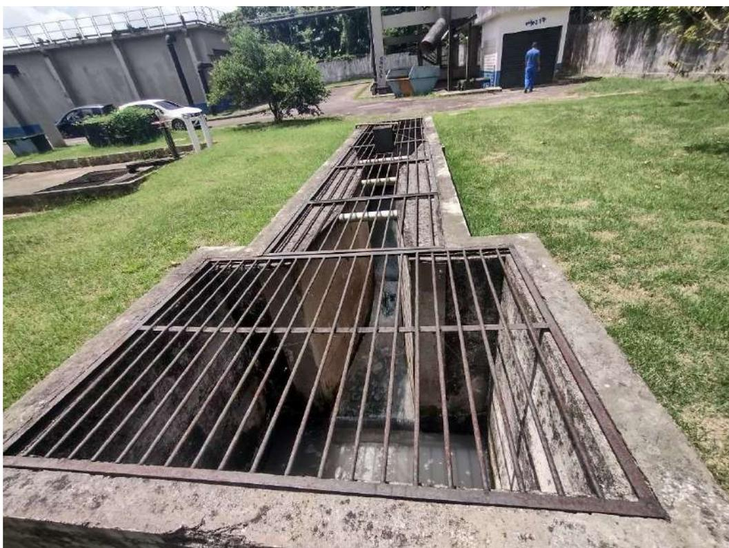
*Figura 328. BEL013-ETE Benguí IV, medidor Parshall e saída da ETE.*
