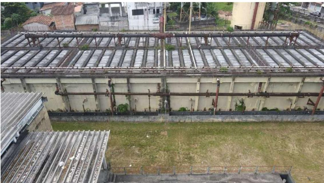
*Figura 343. BEL016-ETE II Marambaia, reator UASB desativado.*
