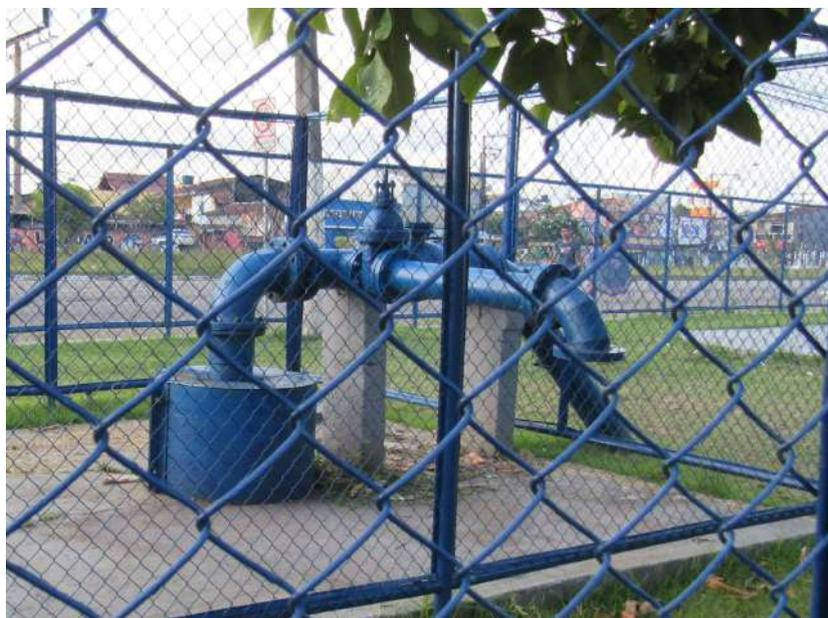
Figura 137. Captação - BEL014/BEL042, poço tubular.
