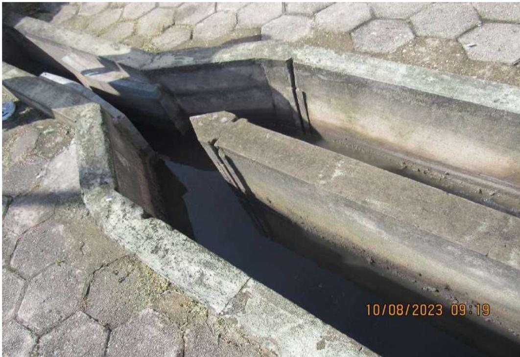
*Figura 315. BEL064-ETE Viver Primavera, caixa de areia e medidor Parshall.
