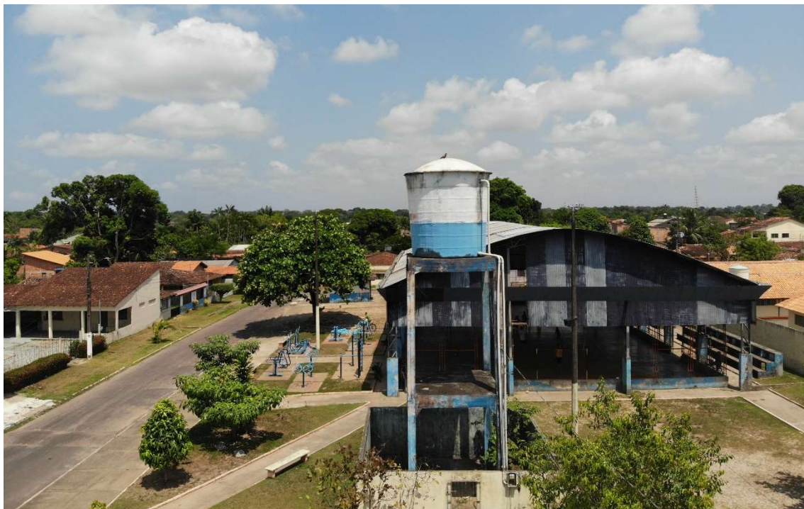
Figura 28. BNV08-REL, reservatório elevado (Bairro Santos Dumont).
