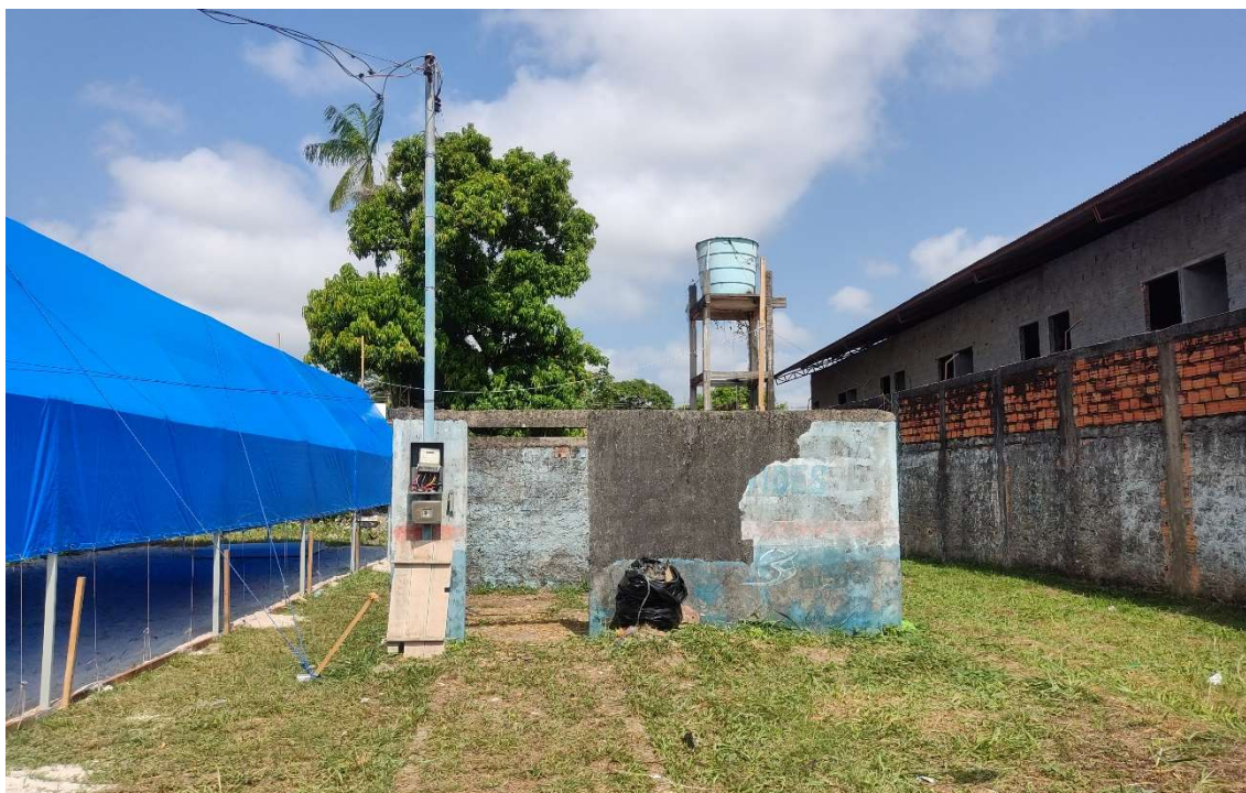
Figura 37. BNV23-REL, reservatório elevado (Bairro Independente).
