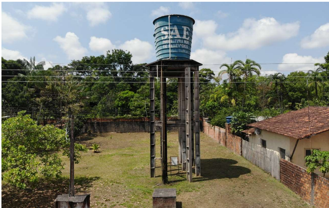
Figura 29. BNV09-REL, reservatório elevado (Bairro Madre Tereza).
