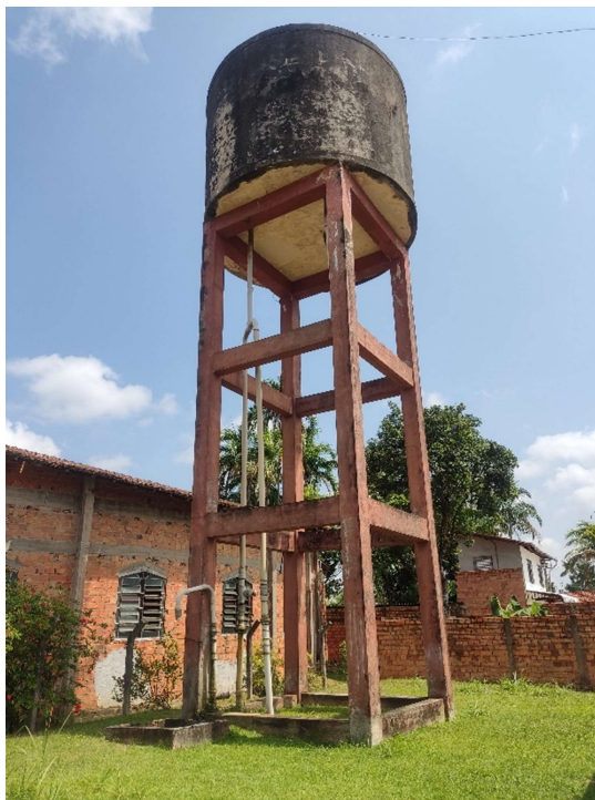
Figura 30. BNV12-REL, reservatório elevado (Bairro das Flores).
