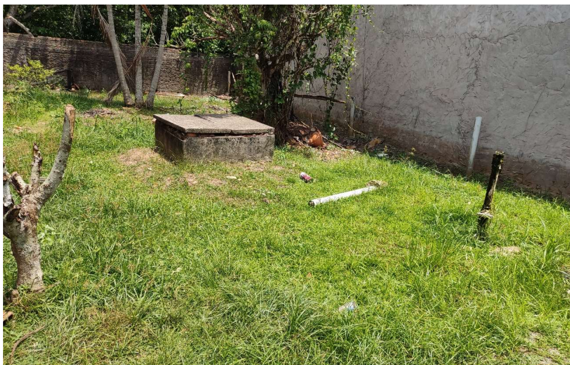
Figura 4. BNV02-CAPTAÇÃO, captação subterrânea (Bairro Maguari). Fonte: Consórcio, 2023.
