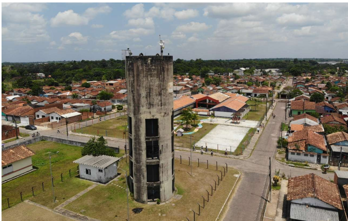
Figura 27. BNV05-REL, reservatório elevado (Bairro Cohab).
