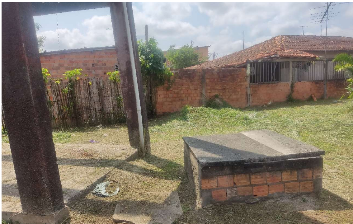
Figura 19. BNV19-CAPTAÇÃO, captação subterrânea (Bairro Santa Rosa).
