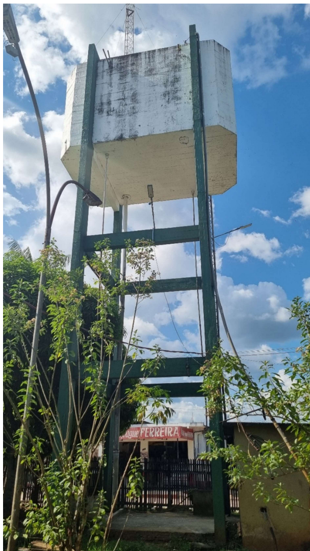
Figura 20. REL – BRV05, Estrutura.
