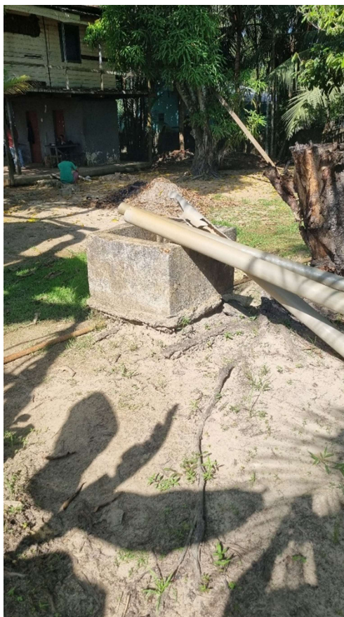
Figura 9. Captação – BRV05, Poço (desativado).
