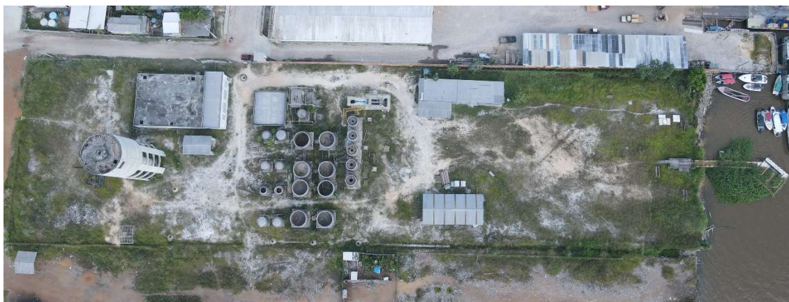
Figura 21. BRV04, Setor em construção.
