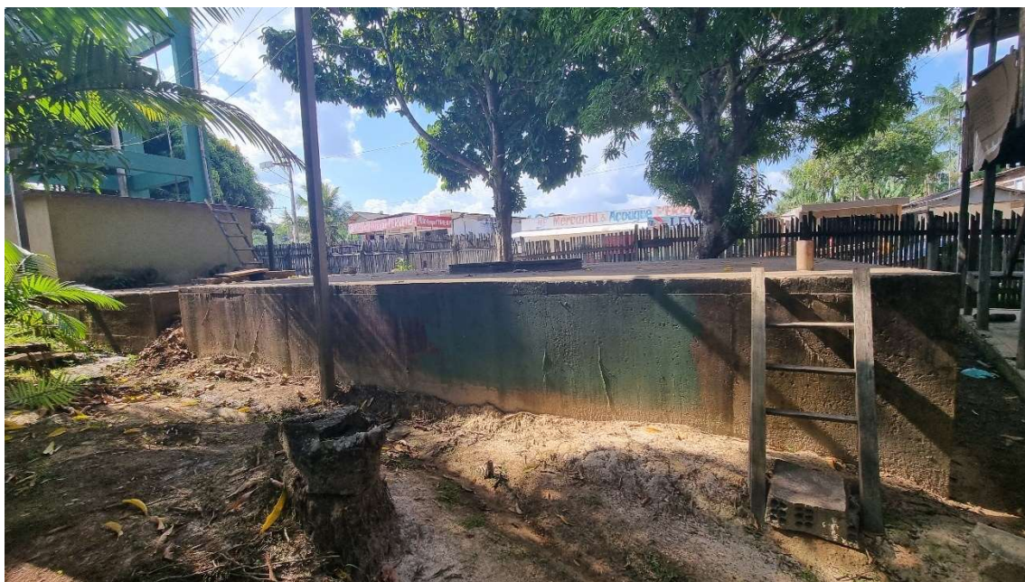
Figura 19. RAP – BRV05, Estrutura.
