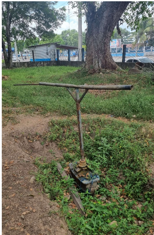
Figura 4. Captação - BRV01, poço 02 (desativado). Fonte: Consórcio, 2023.
