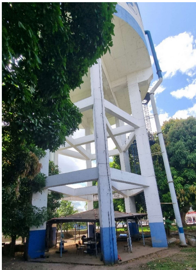
Figura 17. REL 01 – BRV01, Estrutura.
