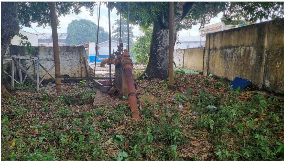
Figura 7. Captação – BRV03, poço desativado. Fonte: Consórcio, 2023.
