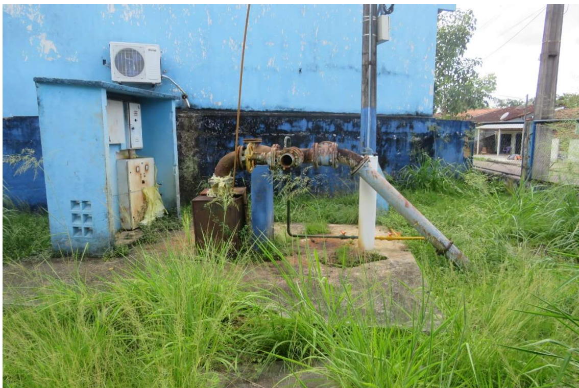
Figura 18. CAS016-CAPTAÇÃO, poço tubular. Fonte: Consórcio, 2023.
