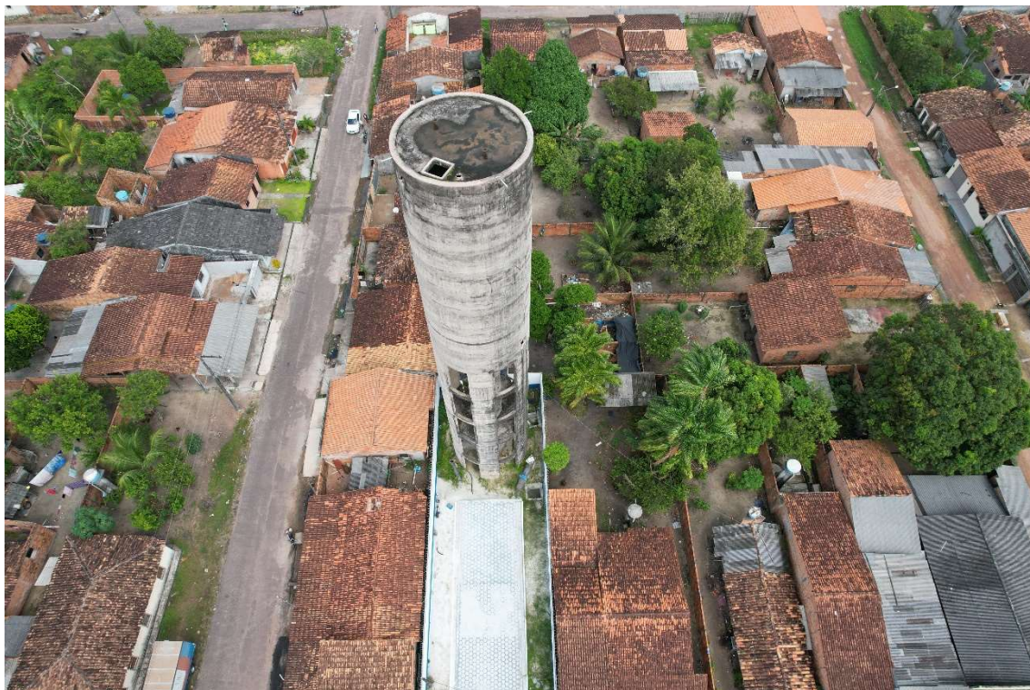
Figura 70. CAS013-REL, reservatório elevado.
