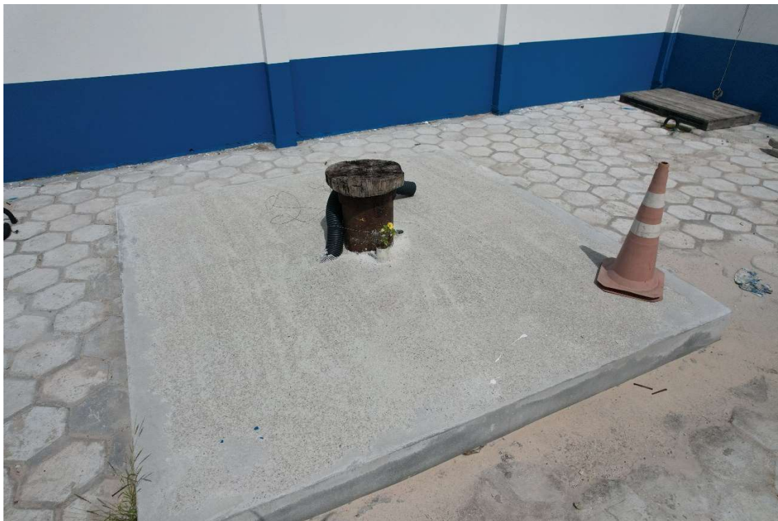
Figura 17. CAS015-CAPTAÇÃO, poço tubular. Fonte: Consórcio, 2023.
