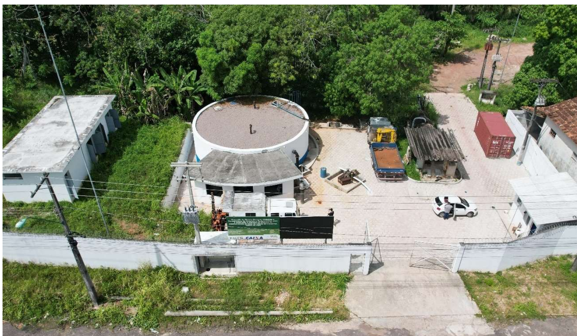
Figura 67. CAS010-RAP01,02, reservatório apoiado.
