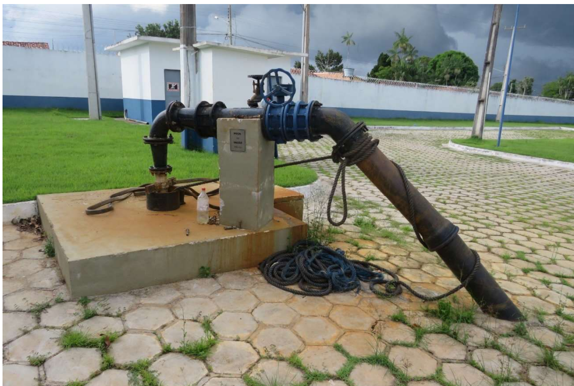
Figura 25. CAS019-CAPTAÇÃO001, poço tubular. Fonte: Consórcio, 2023.
