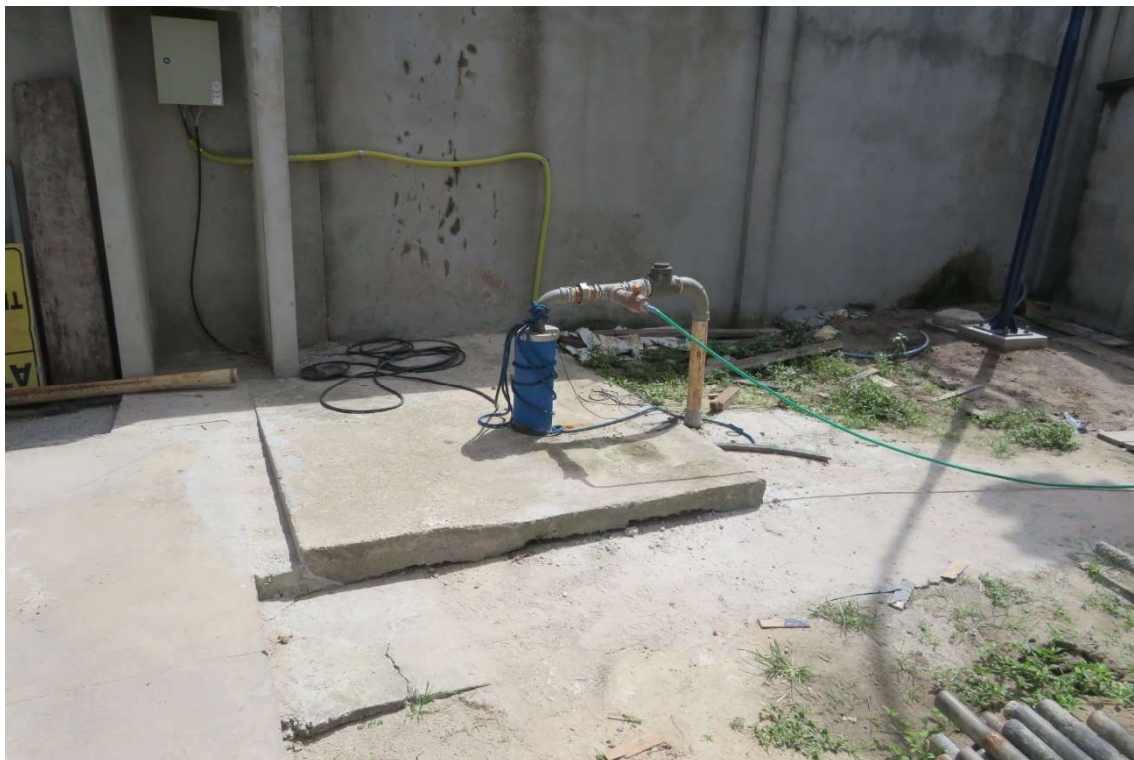
Figura 19. CAS017-CAPTAÇÃO001, poço tubular. Fonte: Consórcio, 2023.
