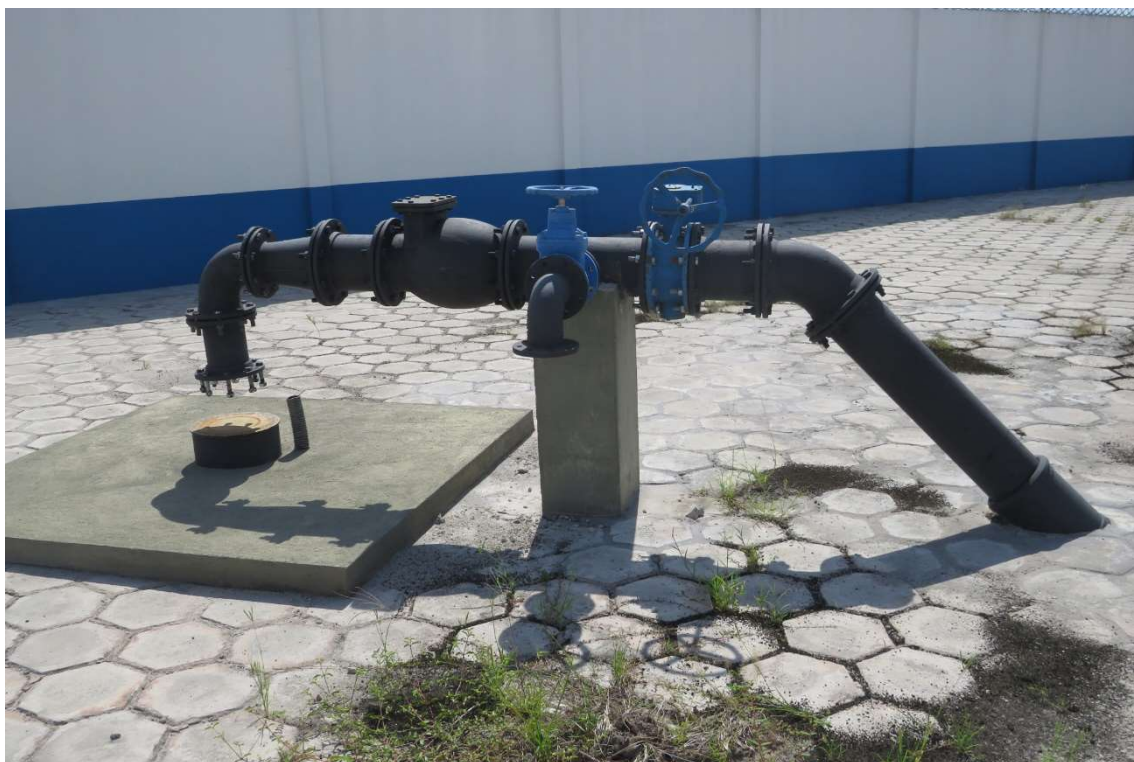
Figura 36. CAS024-CAPTAÇÃO002, poço tubular. Fonte: Consórcio, 2023.
