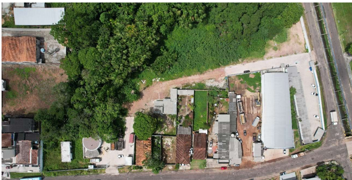
Figura 12. CAS010-CAPTAÇÃO002, poços rasos.
