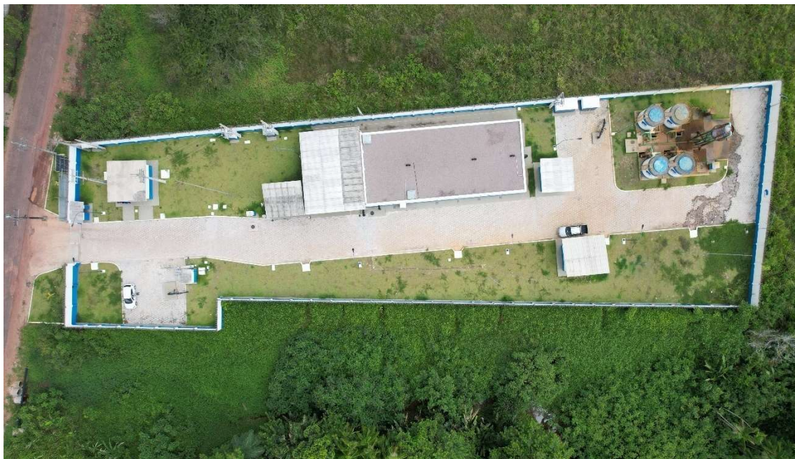
Figura 72. CAS018-RAP, reservatório apoiado.
