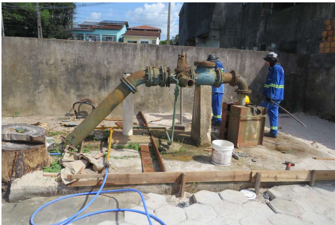
Figura 16. CAS014-CAPTAÇÃO, poço tubular. Fonte: Consórcio, 2023.
