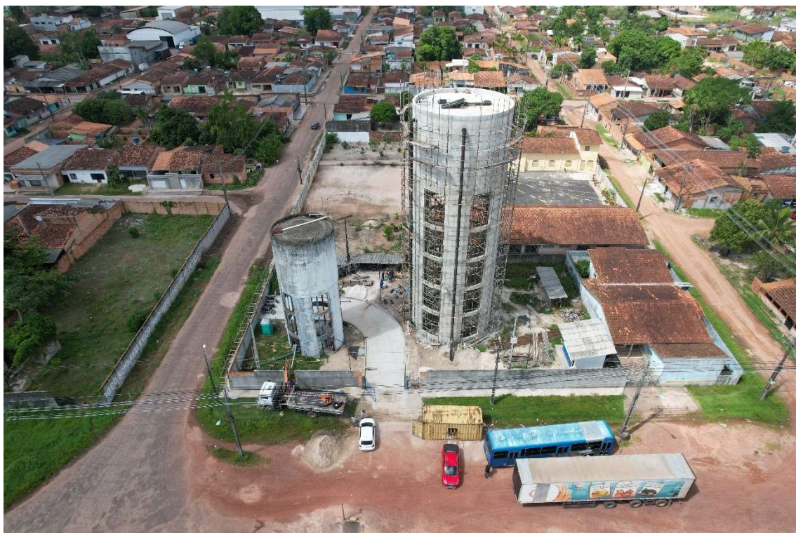
Figura 71. CAS017-REL01,02, reservatório elevado.
