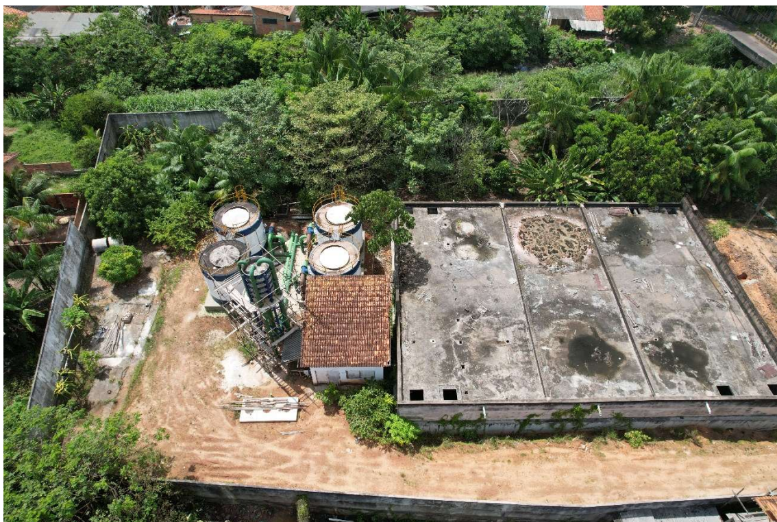
Figura 37. CAS002-ETA, Estação de Tratamento de Água (desferrização).
