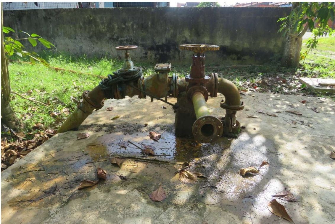
Figura 13. CAS011-CAPTAÇÃO001, poço tubular. Fonte: Consórcio, 2023.
