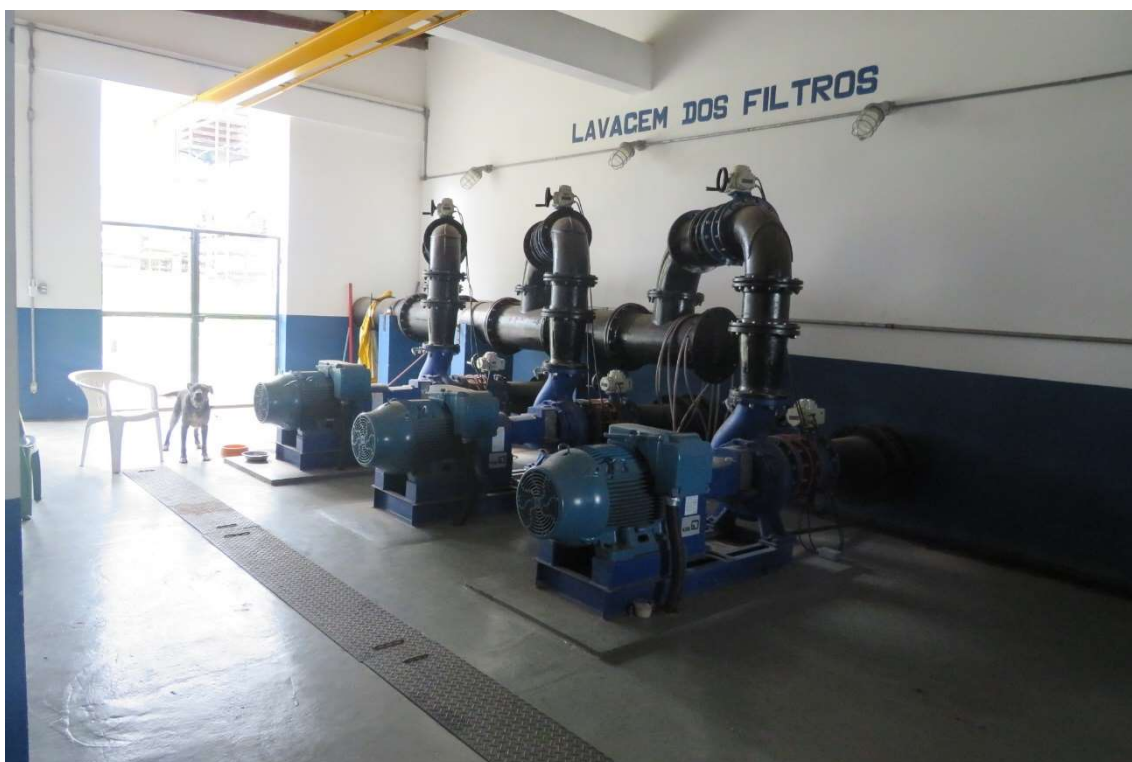
Figura 59. CAS019-EELF, Estação Elevatória de Lavagem dos Filtros. Fonte: Consórcio, 2023.
