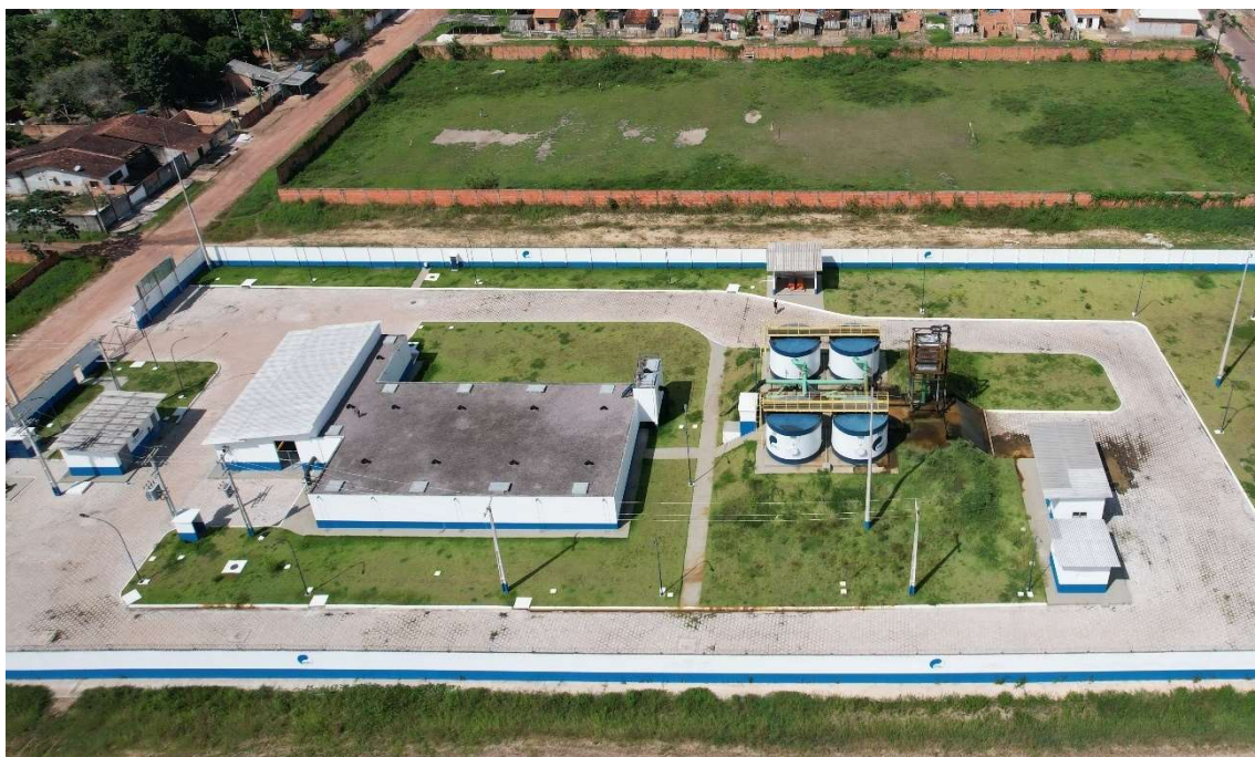
Figura 76. CAS024-RAP, reservatório apoiado.
