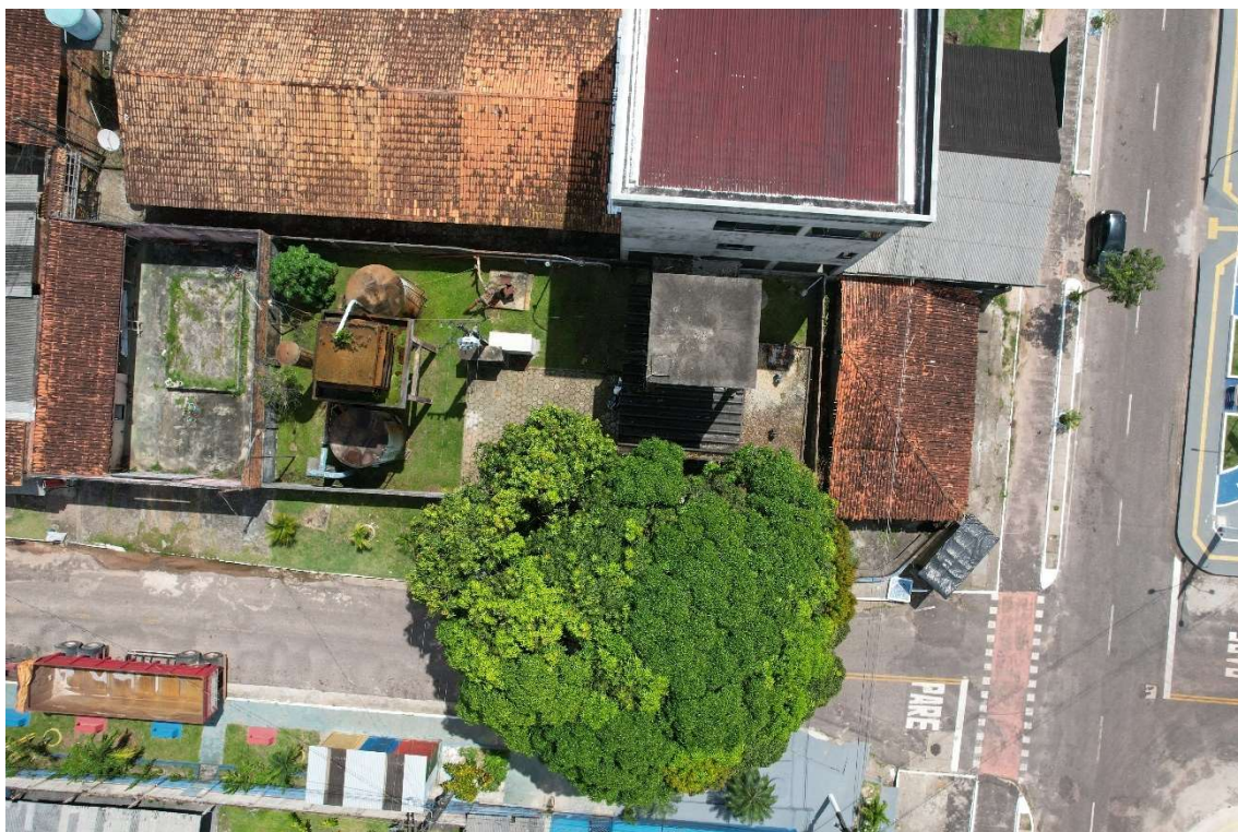
Figura 63. CAS003-RAP, REL, reservatório apoiado e elevado – vista aérea. Fonte: Consórcio, 2023.
