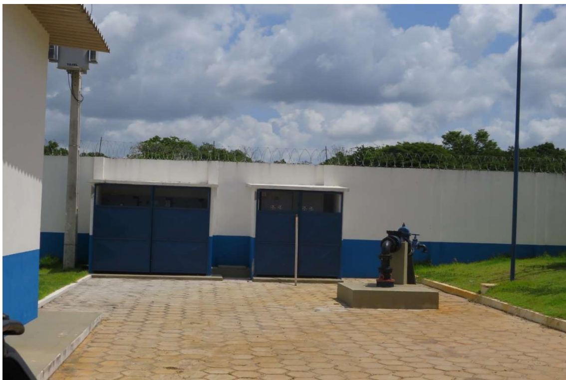
Figura 24. CAS017-CAPTAÇÃO002, poço tubular. Fonte: Consórcio, 2023.
