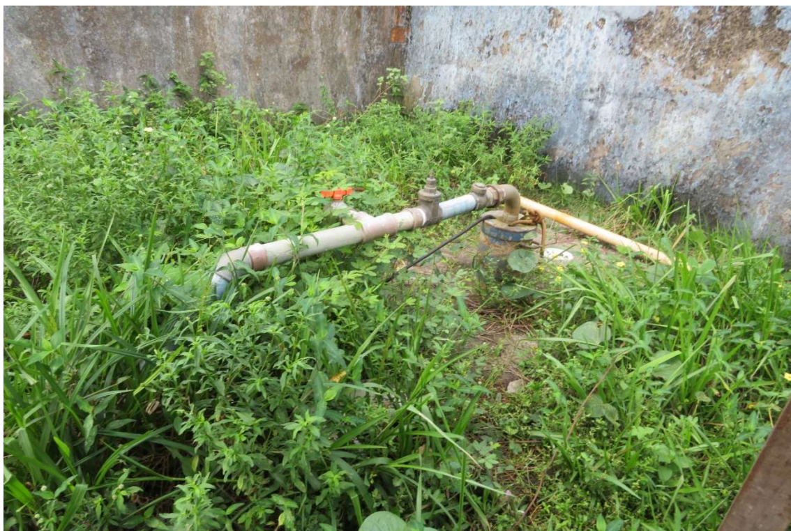
Figura 20. CAS017-CAPTAÇÃO002, poço tubular. Fonte: Consórcio, 2023.
