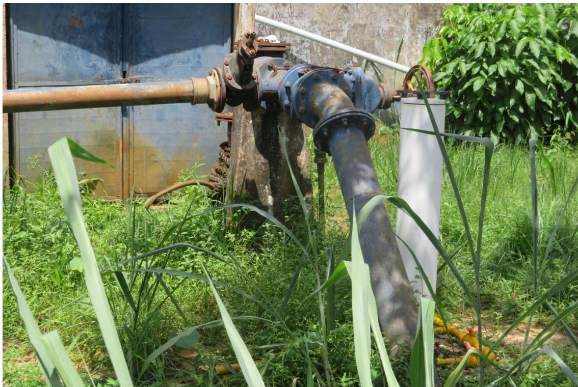
Figura 5. CAS004-CAPTAÇÃO, poço tubular. Fonte: Consórcio, 2023.
