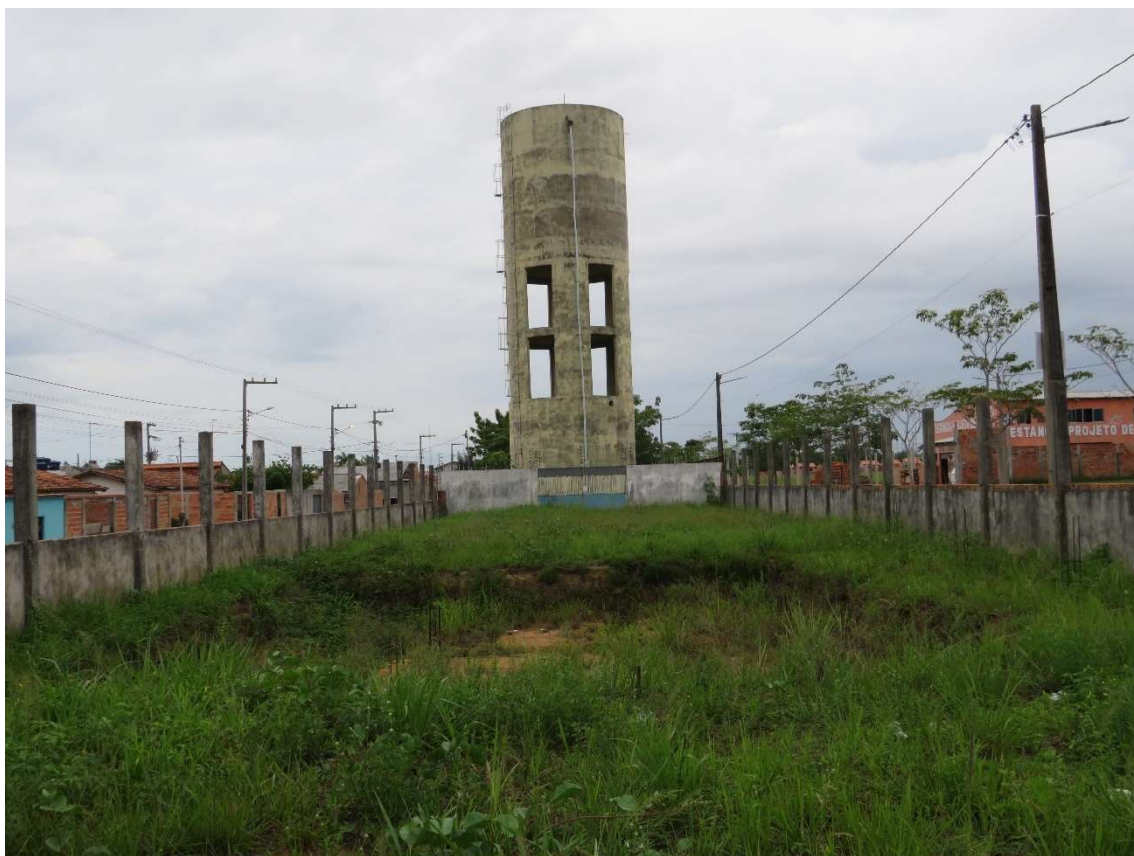
Figura 75. CAS022-REL, reservatório elevado.
