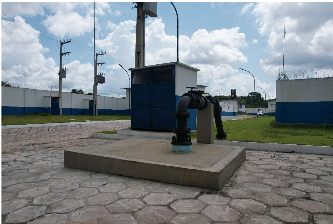
Figura 23. CAS018-CAPTAÇÃO001, poço tubular. Fonte: Consórcio, 2023.
