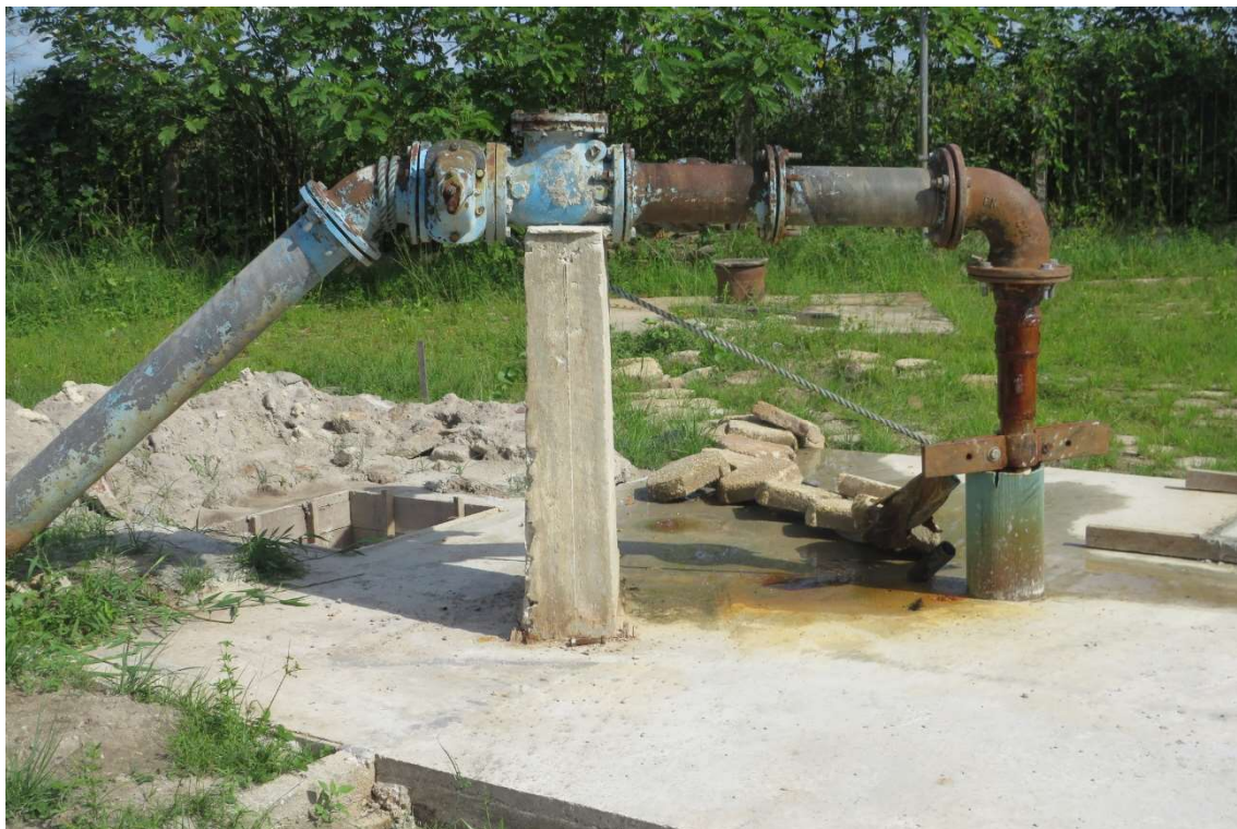
Figura 15. CAS011-CAPTAÇÃO003, poço tubular. Fonte: Consórcio, 2023.
