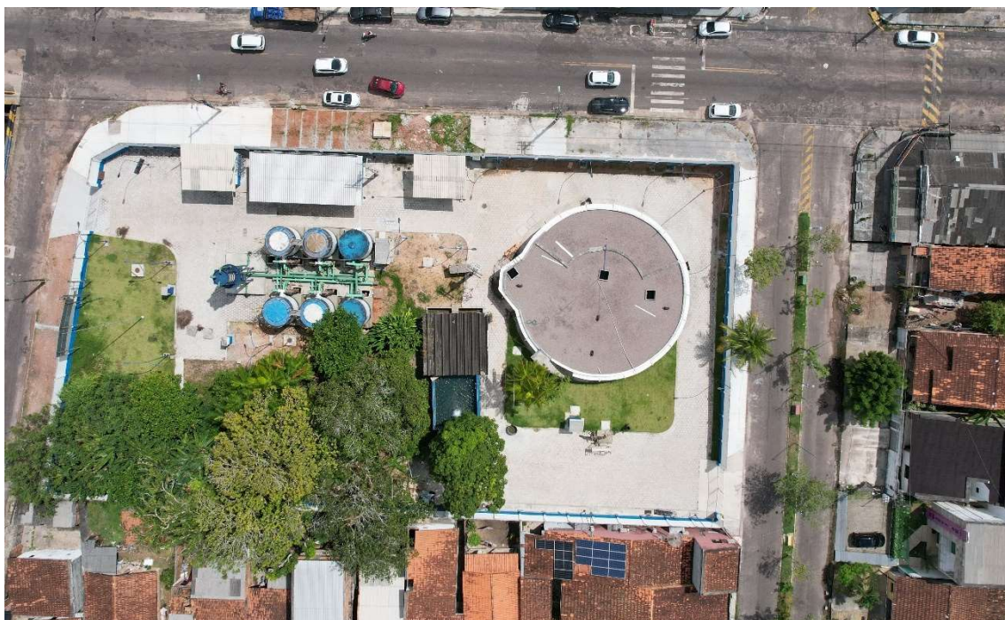
Figura 66. CAS009-RAP, REL, reservatório apoiado e elevado.
