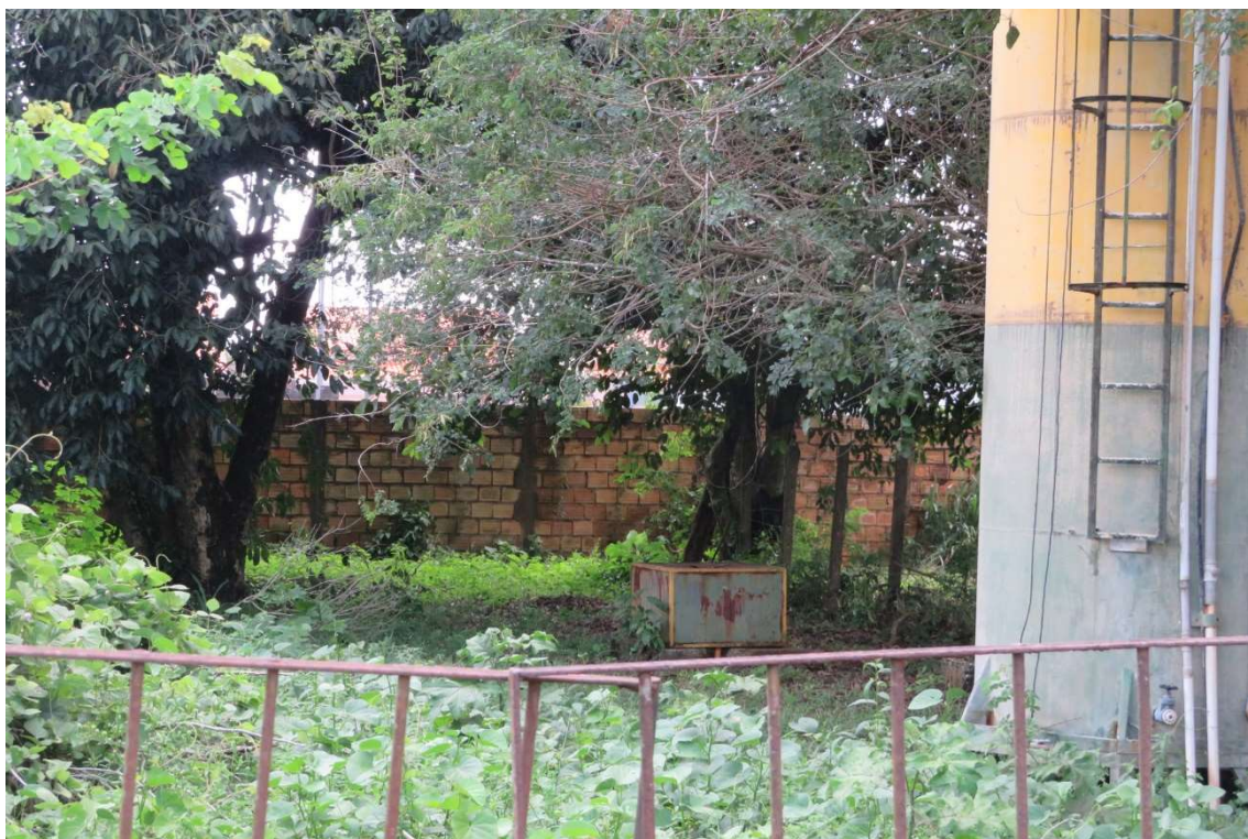
Figura 6. CAS005-CAPTAÇÃO001, poço tubular. Fonte: Consórcio, 2023.
