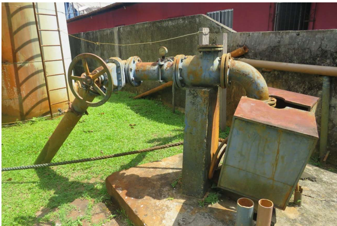
Figura 4. CAS003-CAPTAÇÃO, poço tubular. Fonte: Consórcio, 2023.
