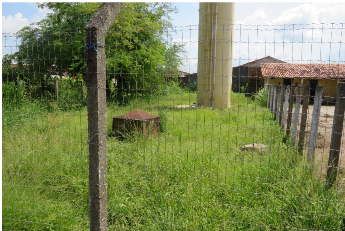
Figura 30. CAS020-CAPTAÇÃO, poço tubular. Fonte: Consórcio, 2023.
