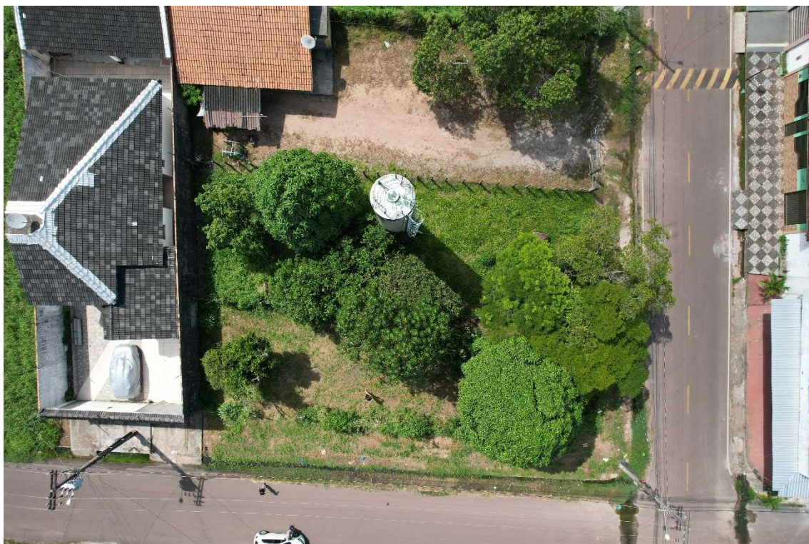
Figura 32. CAS021-CAPTAÇÃO002, poço tubular.
