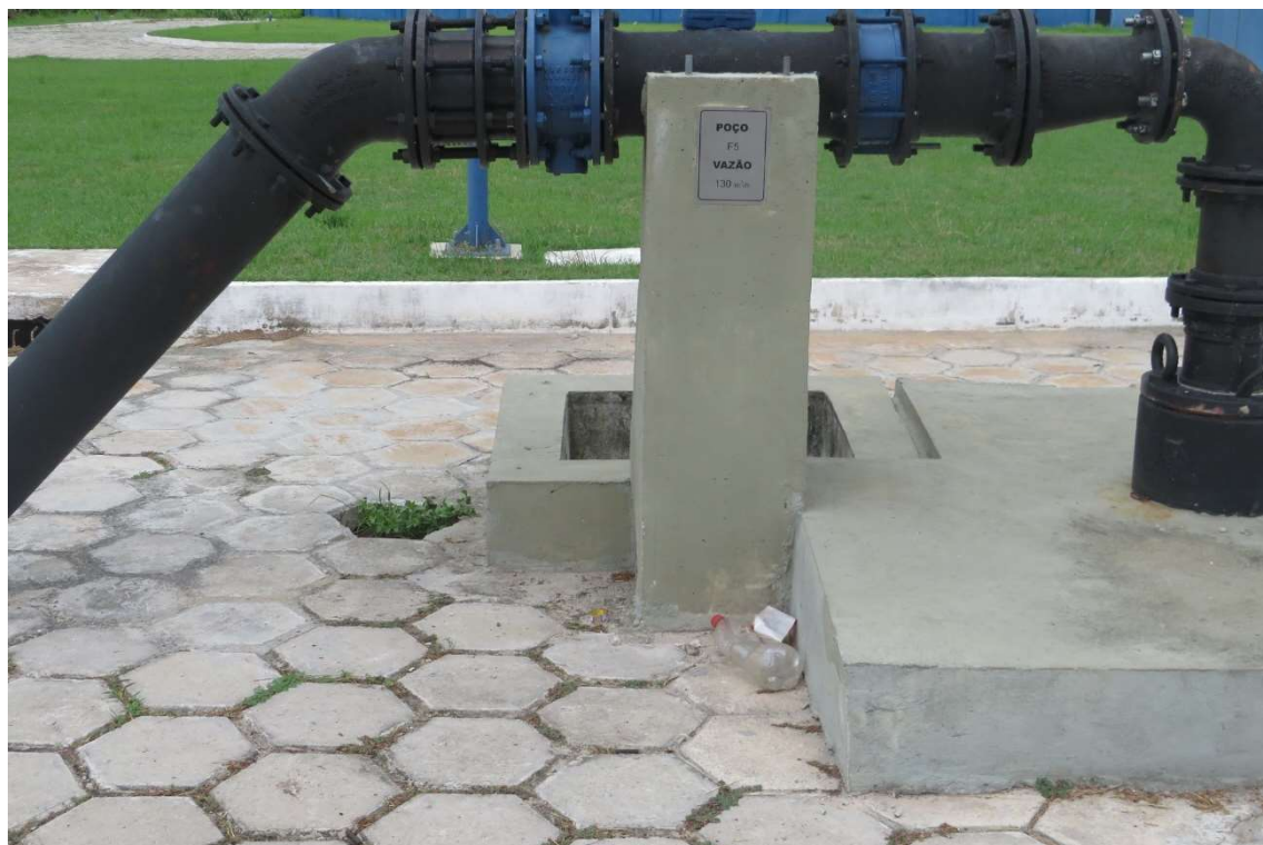
Figura 29. CAS019-CAPTAÇÃO005, poço tubular. Fonte: Consórcio, 2023.
