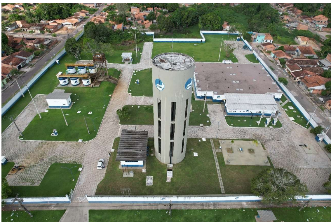
Figura 73. CAS019-RAP, REL, reservatório apoiado e elevado.
