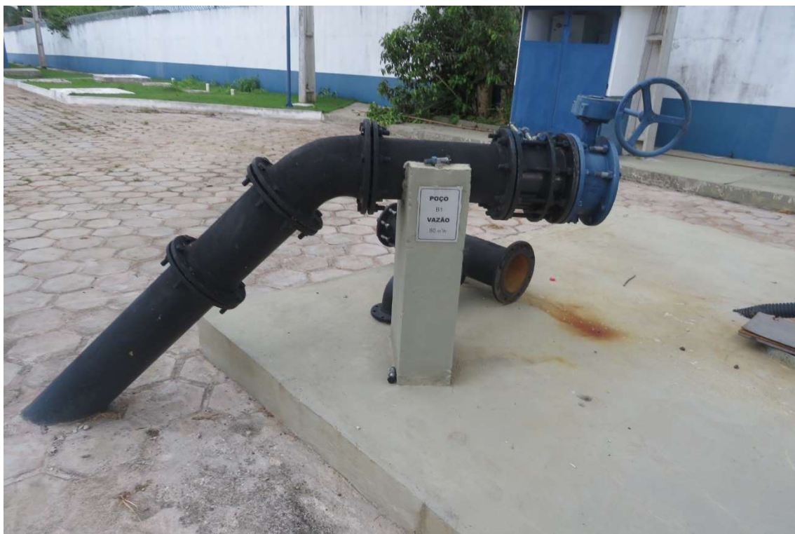
Figura 26. CAS019-CAPTAÇÃO002, poço tubular. Fonte: Consórcio, 2023.
