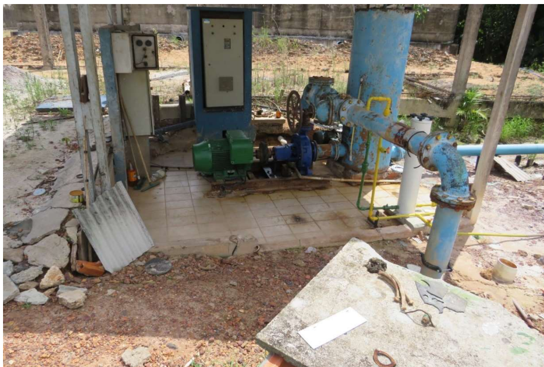
Figura 50. CAS002-EEAB, Estação Elevatória de Água Bruta.
