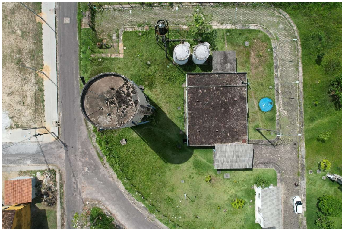
Figura 65. CAS006-RAP, REL, reservatório apoiado e elevado.
