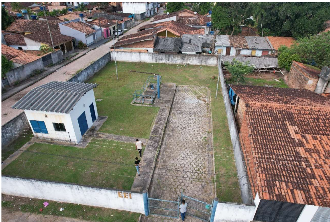
Figura 78. CAS008-EEEB (Estação elevatória de esgoto bruto).
