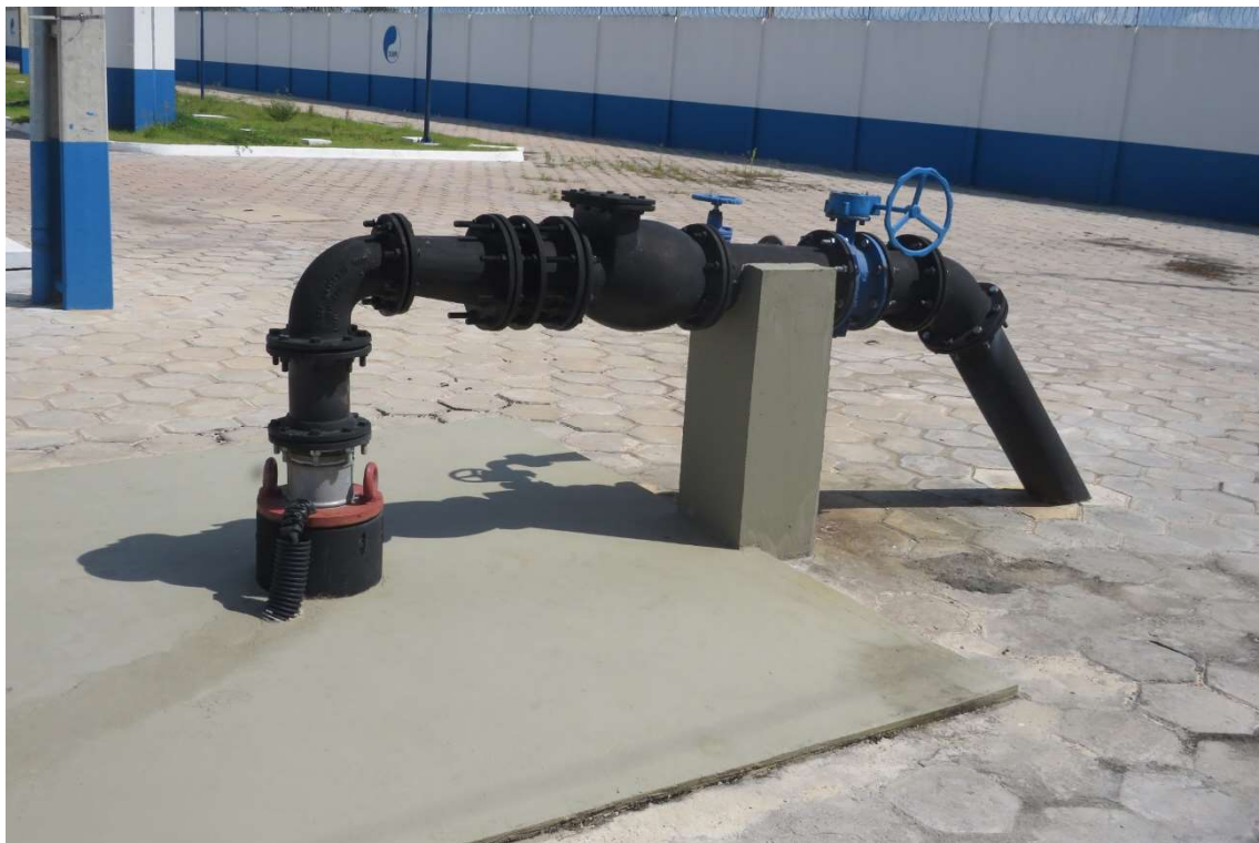
Figura 35. CAS024-CAPTAÇÃO001, poço tubular. Fonte: Consórcio, 2023.
