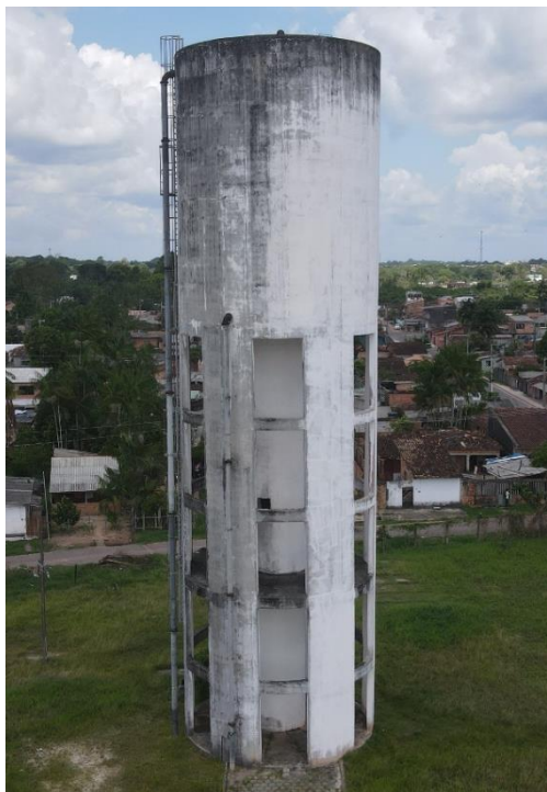
Figura 69. REL-06, estrutura (panorâmica).
