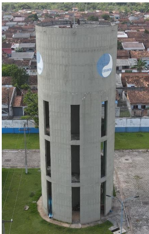
Figura 57. REL01-02, estrutura (panorâmica).
