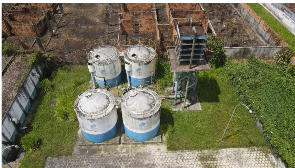
Figura 31. ETA desferrização – MAR04 (panorâmica 02). Fonte: Consórcio, 2023.
