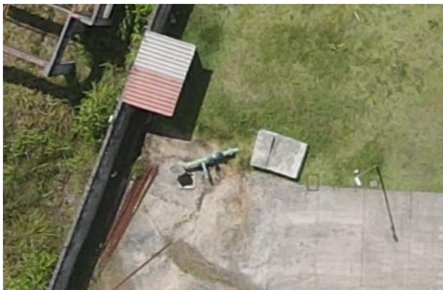
Figura 21. Captação – MAR11 (panorâmica).
