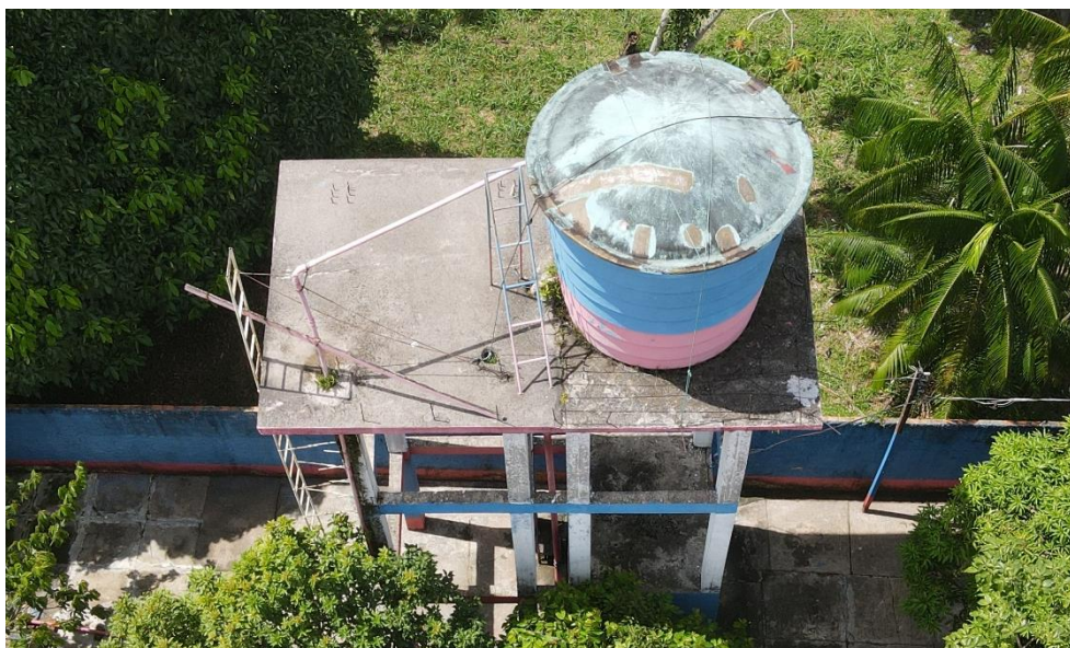
Figura 73. REL-15, estrutura (panorâmica).
