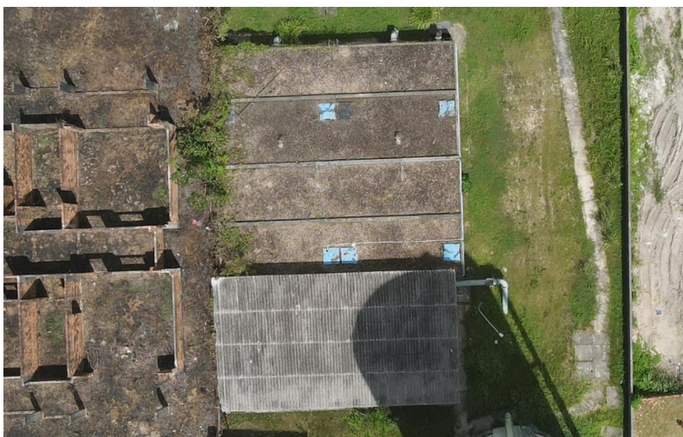
Figura 61. RAP04, estrutura (panorâmica).
