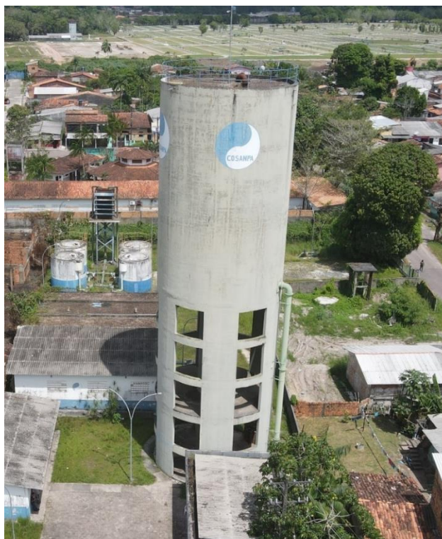
Figura 62. REL04, estrutura (panorâmica).
