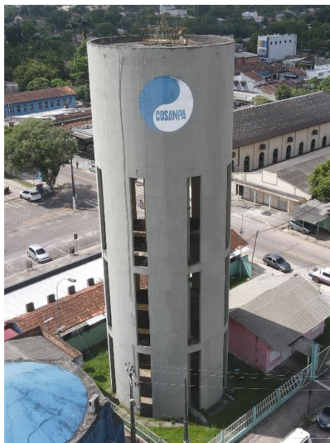
Figura 59. REL03, estrutura (panorâmica).
