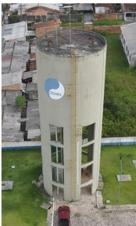
Figura 56. REL01-01, estrutura (panorâmica).
