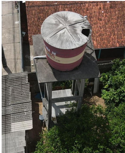
Figura 72. REL-14, estrutura (panorâmica).
