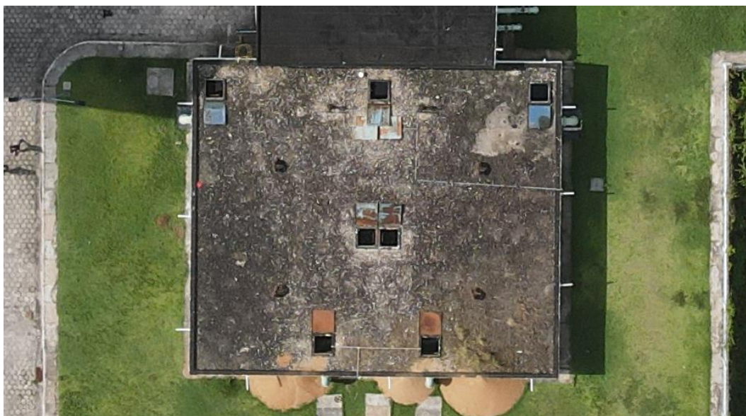
Figura 55. RAP-01, estrutura (panorâmica).
