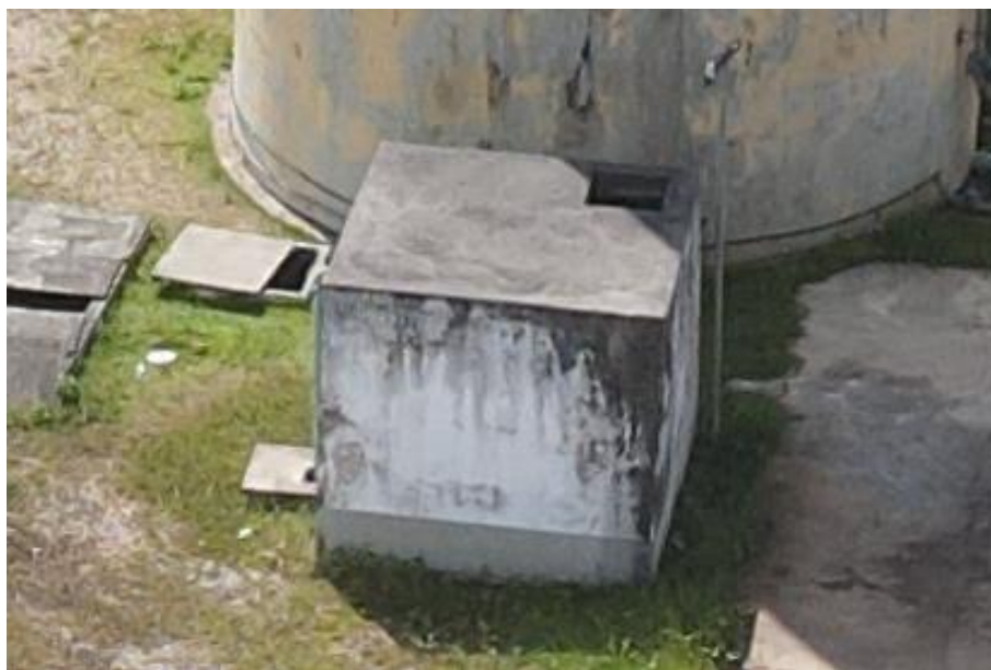
Figura 71. RAP03-11, estrutura (panorâmica).
