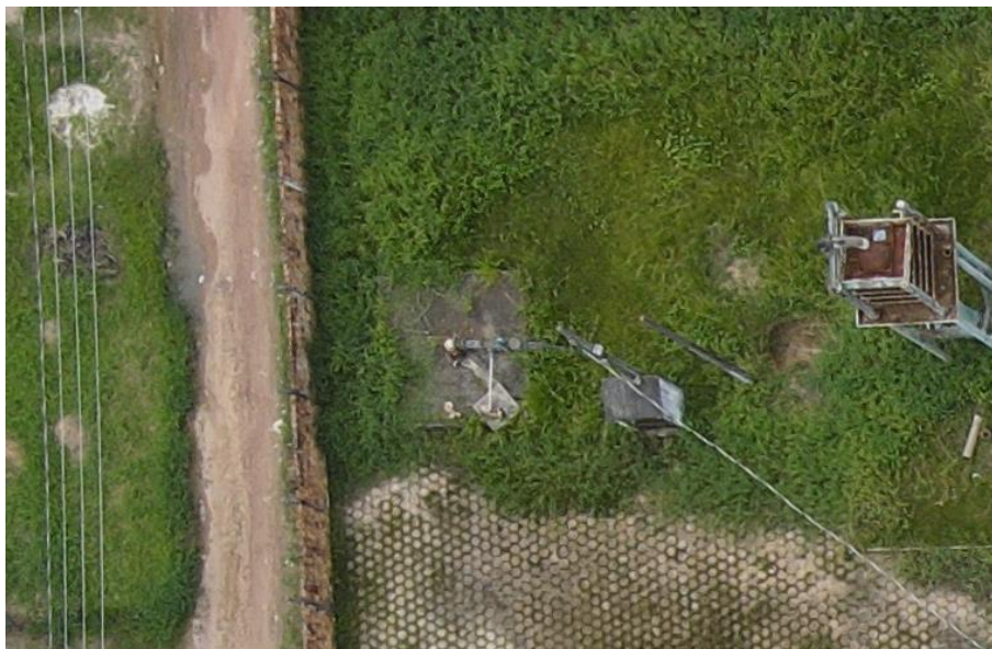
Figura 17. Captação - MAR06 (panorâmica).
