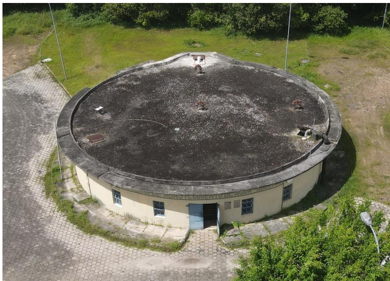
Figura 58. RAP02, estrutura (panorâmica).
