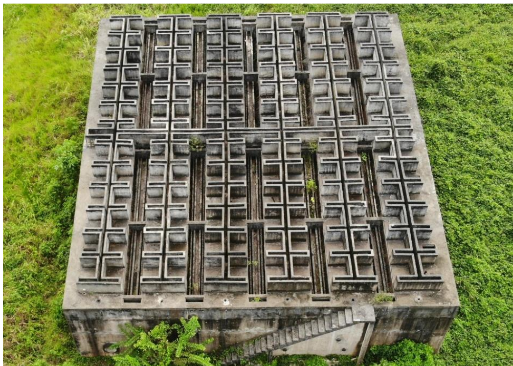
Figura 89. MAR13-ETE, Reator anaeróbio (UASB).
