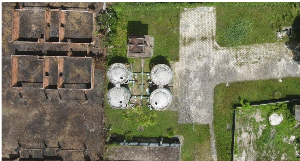
Figura 30. ETA desferrização – MAR04 (panorâmica 01). Fonte: Consórcio, 2023.
