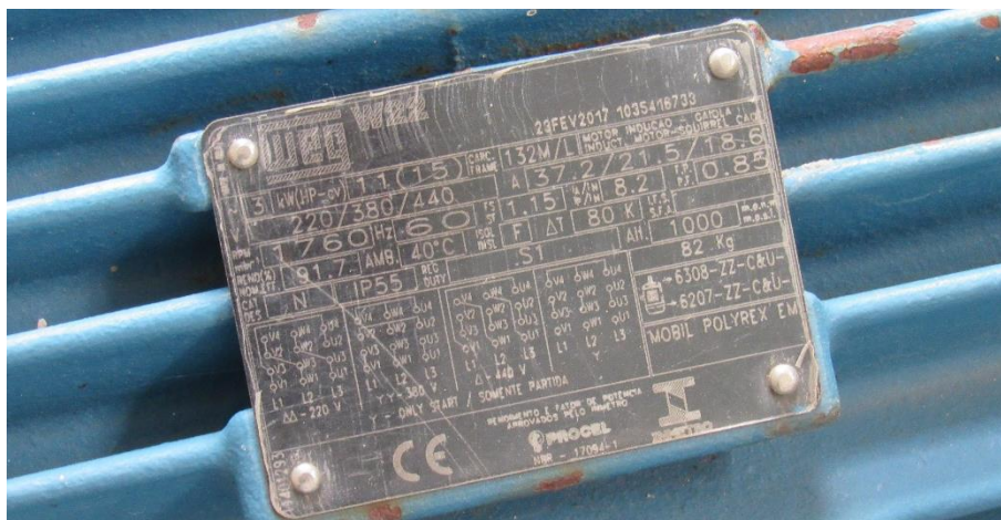
Figura 53. EEAT 02 – MAR11, especificação da bomba.
