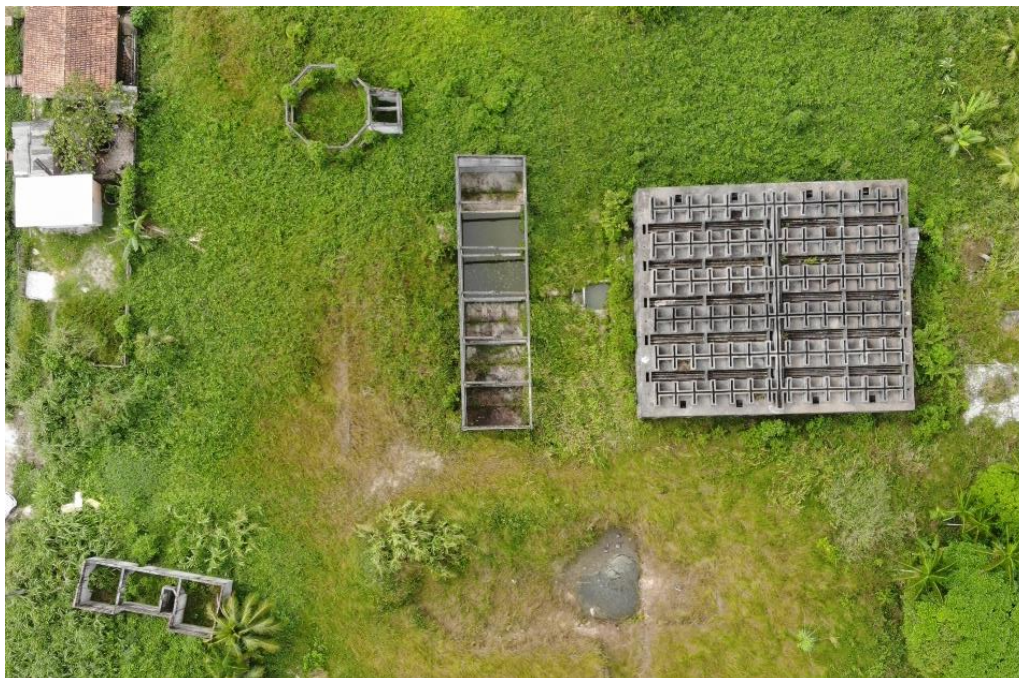
Figura 88. MAR13-ETE, inoperante (panorâmica).
