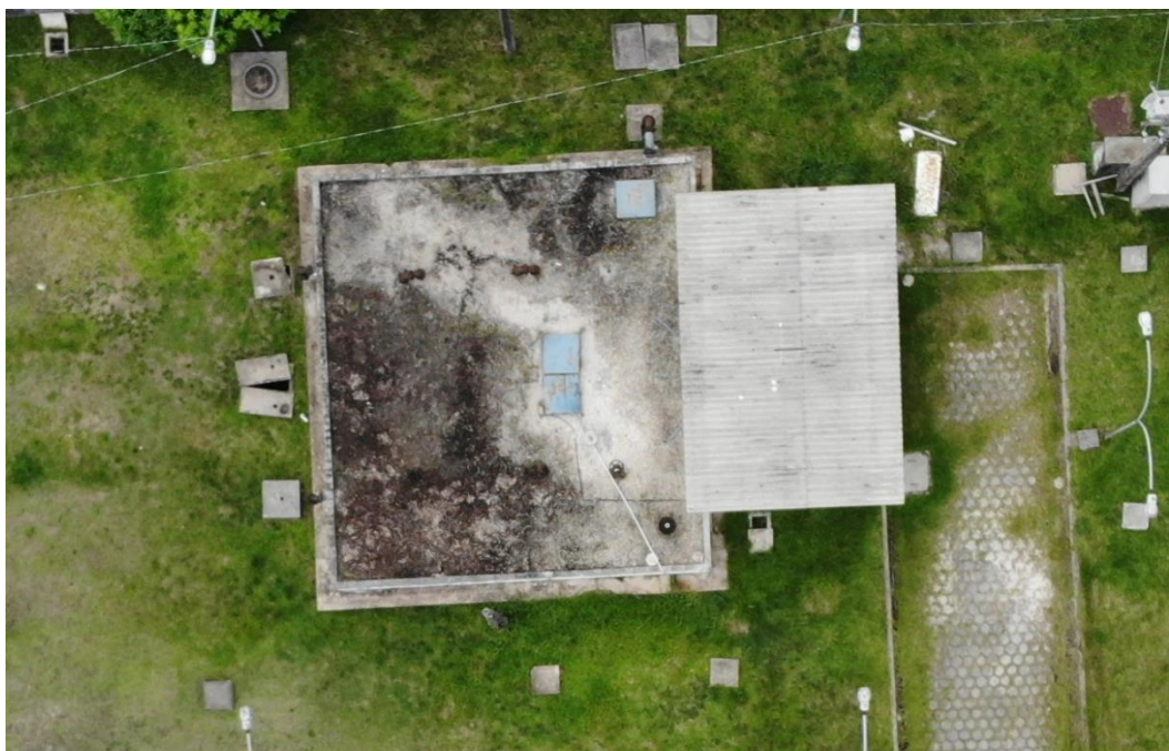
Figura 64. RAP-05, estrutura (panorâmica).
