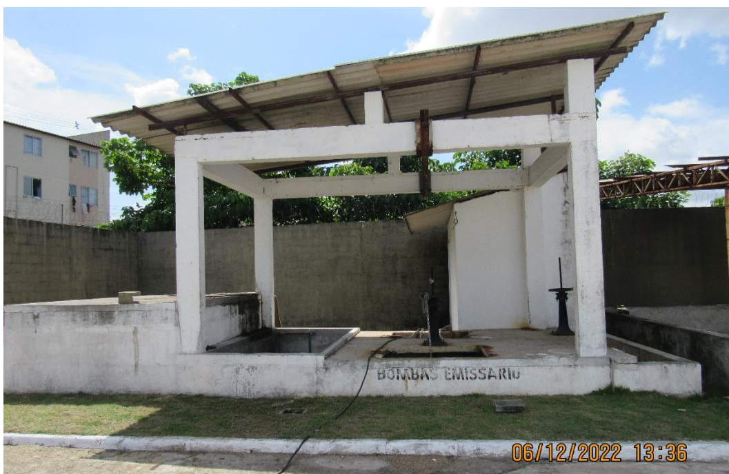
Figura 87. MAR10-ETE, Elevatória do emissário. Fonte: Consórcio, 2023.
