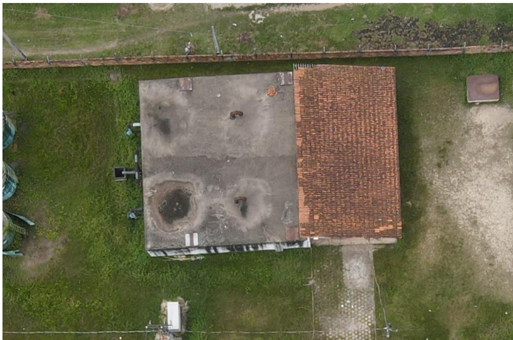
Figura 68. RAP-06, estrutura (panorâmica).
