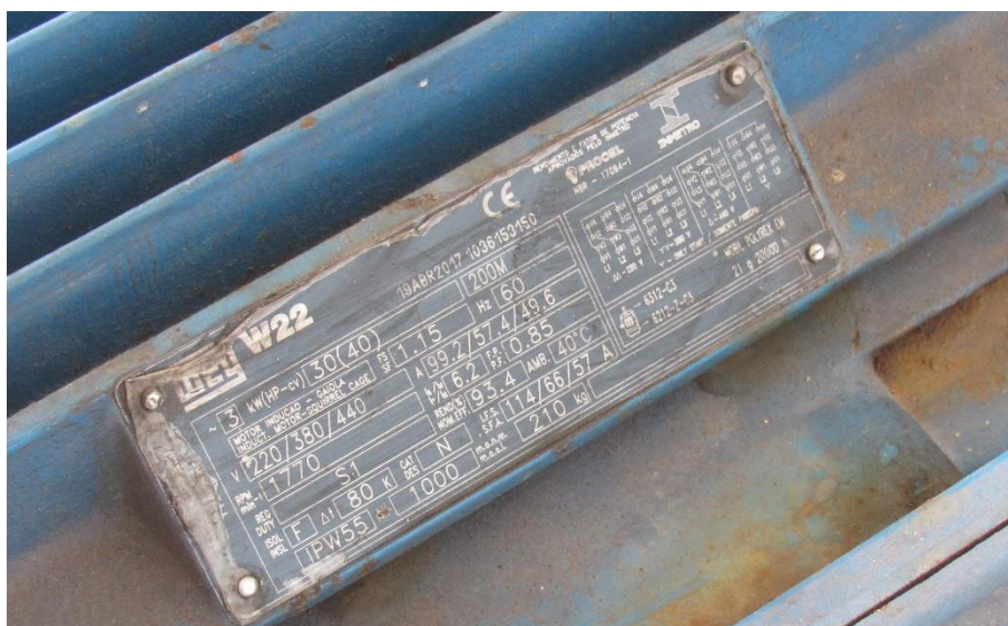
Figura 52. EEAT 01 – MAR11, especificação da bomba. Fonte: Consórcio, 2023.
