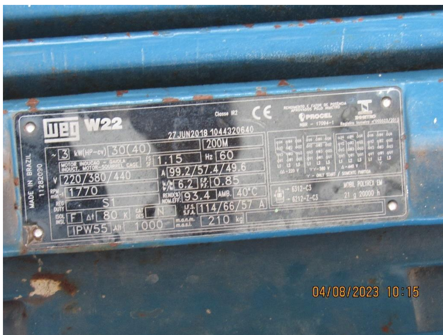
Figura 44. EEAT – MAR01, especificação da bomba.
