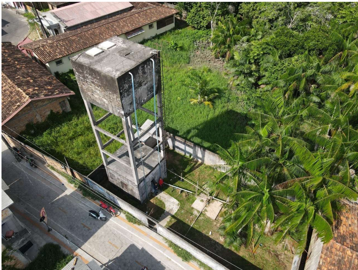
Figura 25. REL- MUA06, Estrutura.
