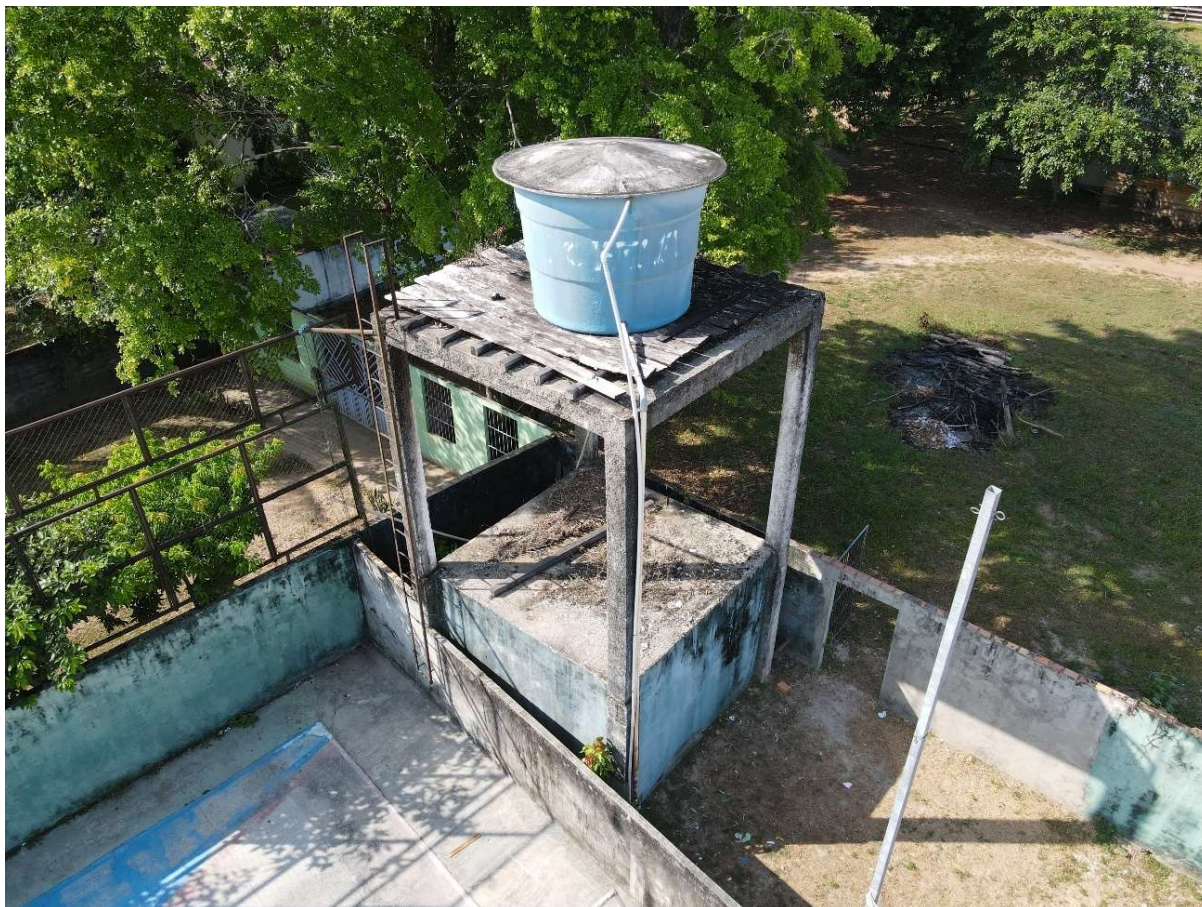
Figura 24. REL- MUA05, Estrutura.
