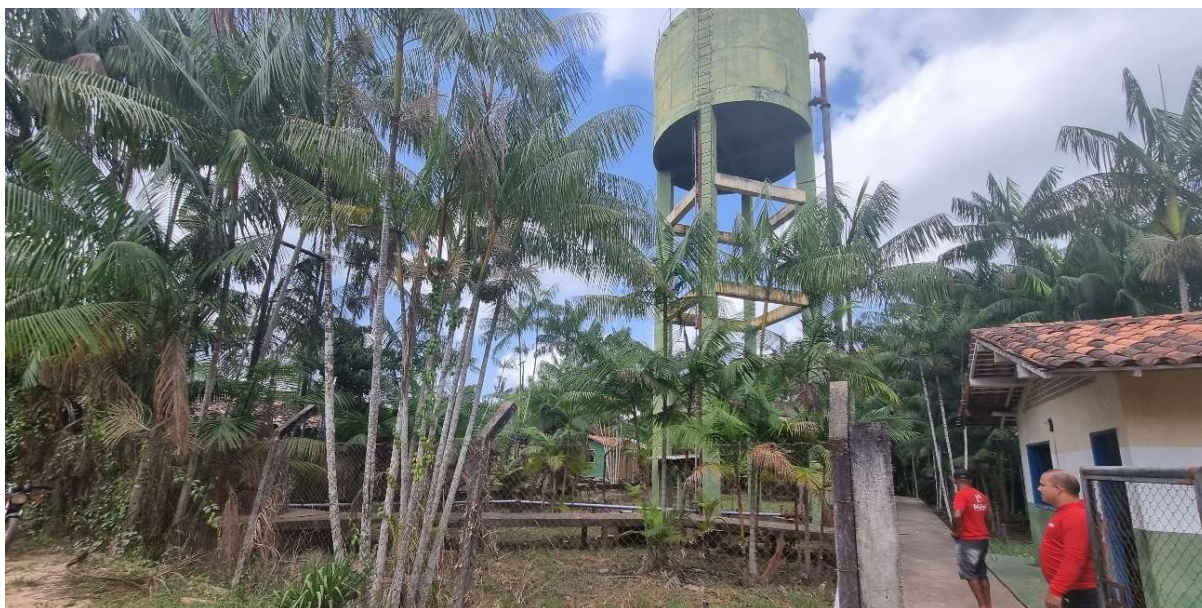
Figura 28. REL- MUA09, Estrutura.
