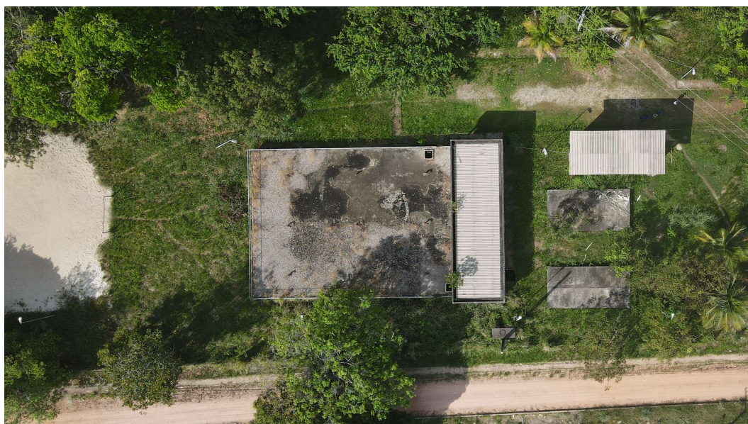
Figura 22. RAP – POR01, estrutura (panorâmica).
