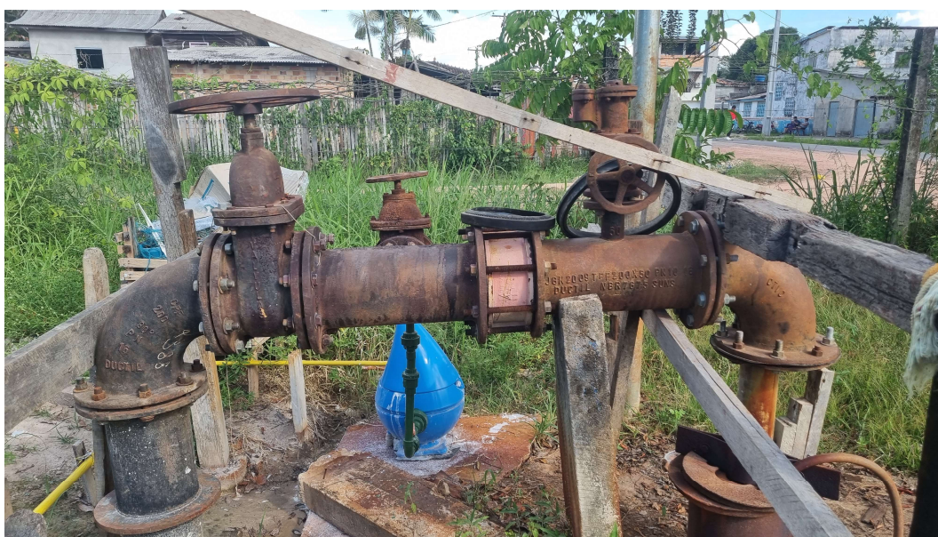
Figura 4. Captação - POR01, poço tubular (aproximada). Fonte: Consórcio, 2023.
