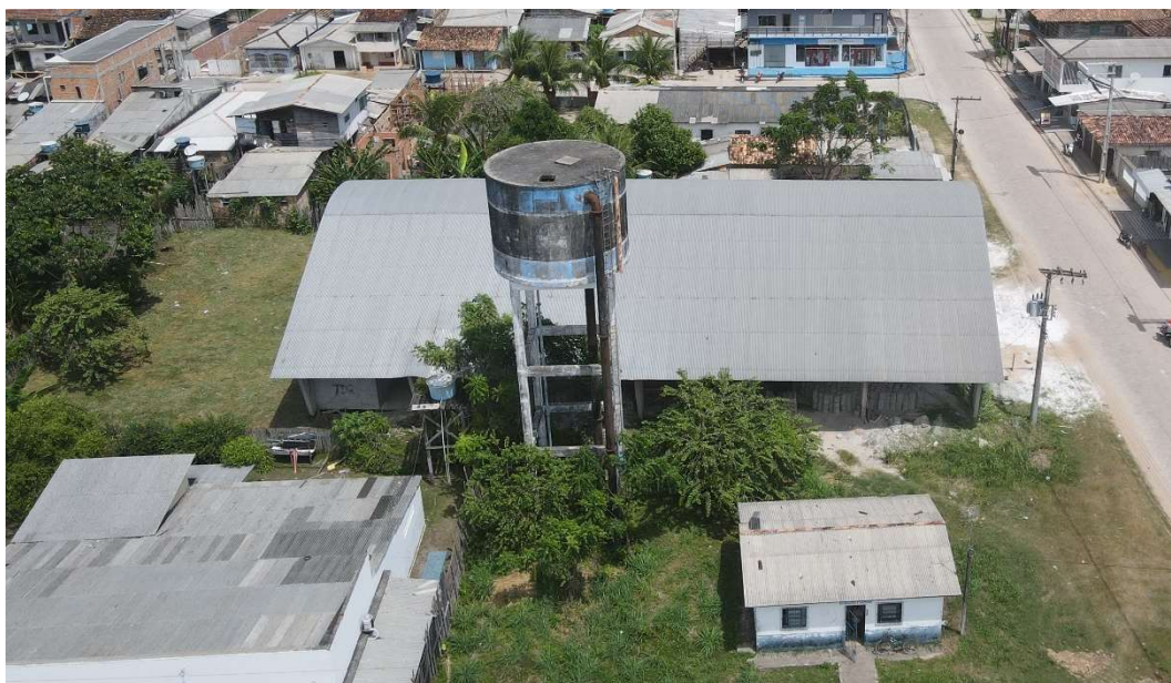
Figura 24. REL – POR02, estrutura (panorâmica).
