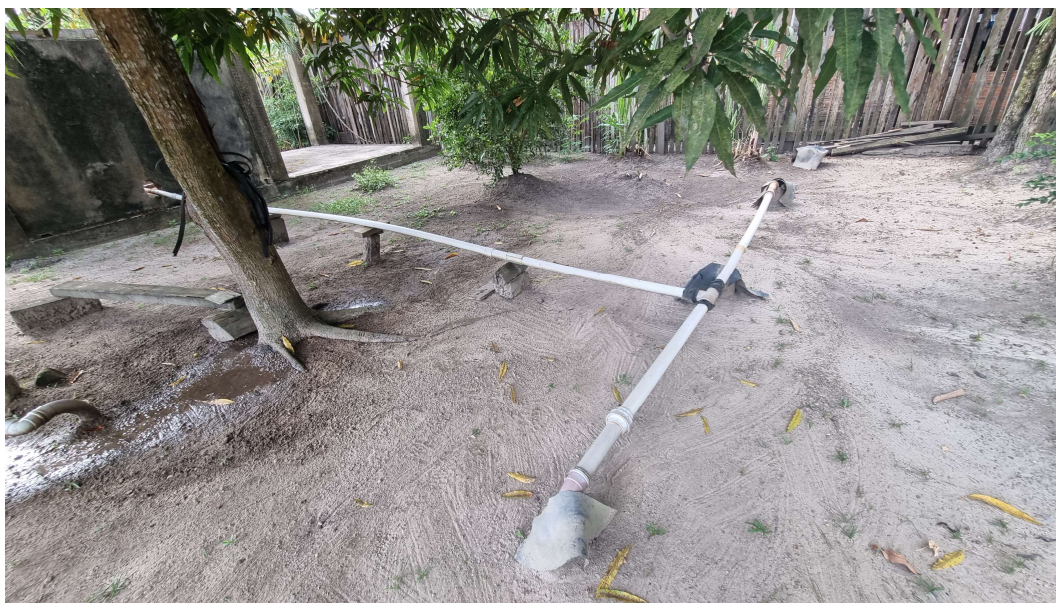
Figura 14. Captação – POR07, poço tubular 01 e 02.
