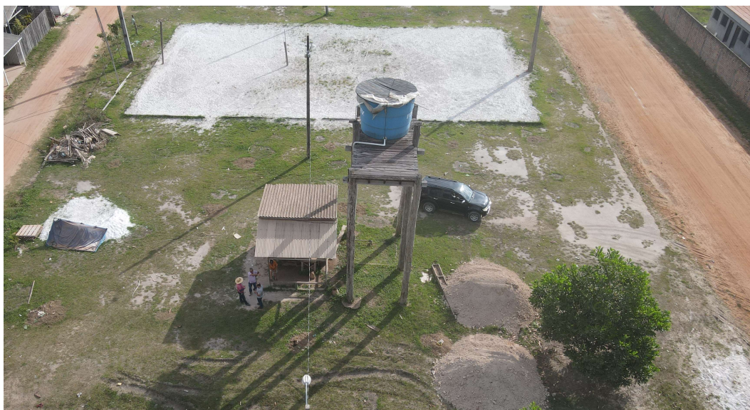
Figura 26. REL – POR03, estrutura (panorâmica). Fonte: Consórcio, 2023.
