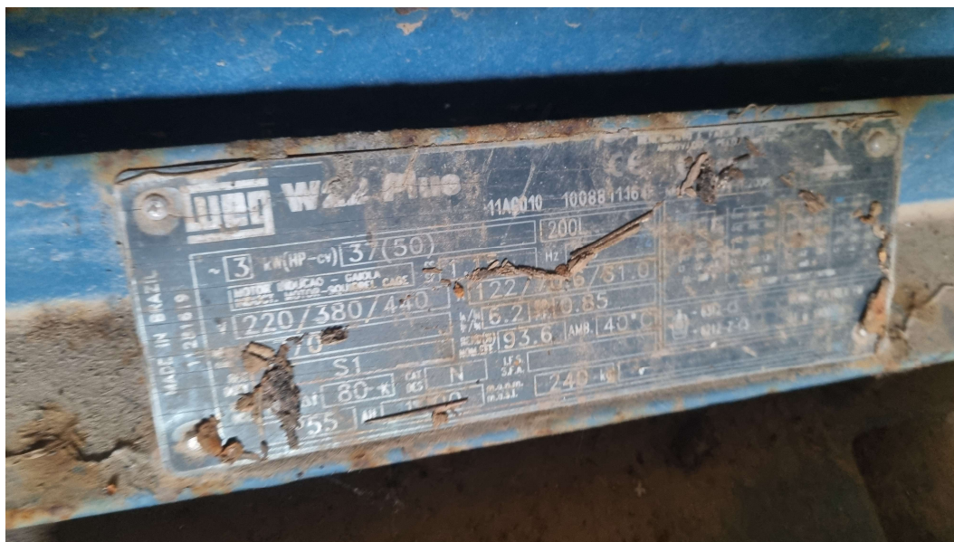
Figura 18. EEAT – POR01, especificações do CMB (inoperante).
