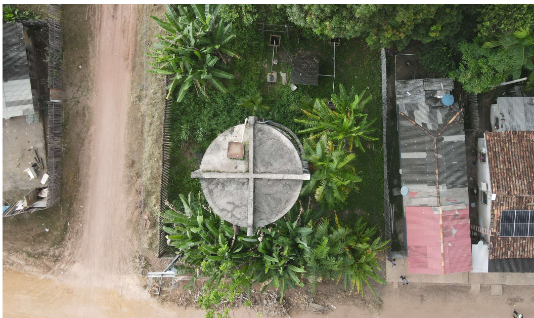
Figura 29. REL - POR04, estrutura (panorâmica).
