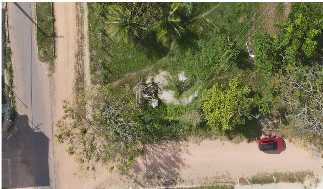
Figura 3. Captação - POR01, poço tubular (panorâmica). Fonte: Consórcio, 2023.
