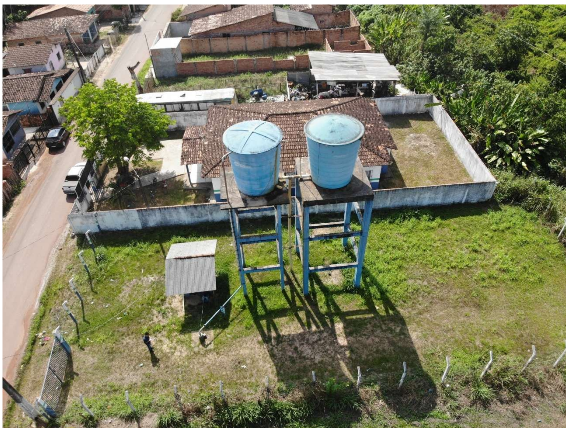
Figura 43. STI03-REL01, (reservatório elevado)
