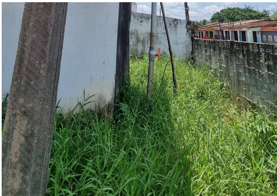
Figura 32. STI18-CAPTAÇÃO, subterrânea (poço tubular)
