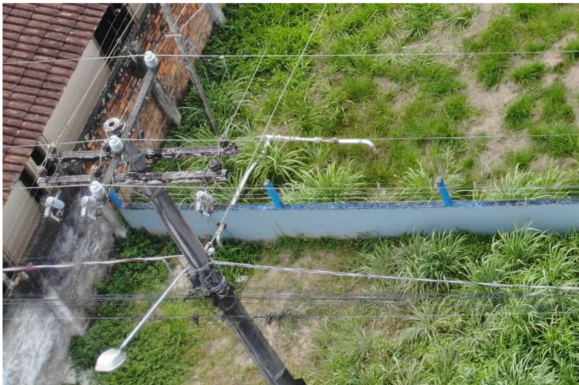
Figura 21. STI12-CAPTAÇÃO001, subterrânea (poço tubular)
