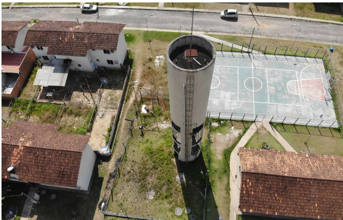
Figura 45. STI04-REL, (reservatório elevado)
