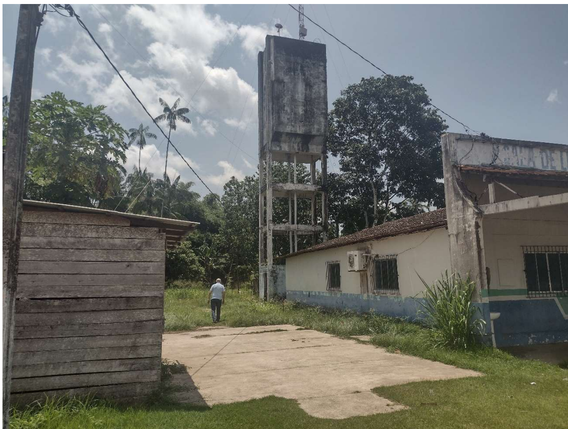
Figura 56. STI19-REL, (reservatório elevado)
