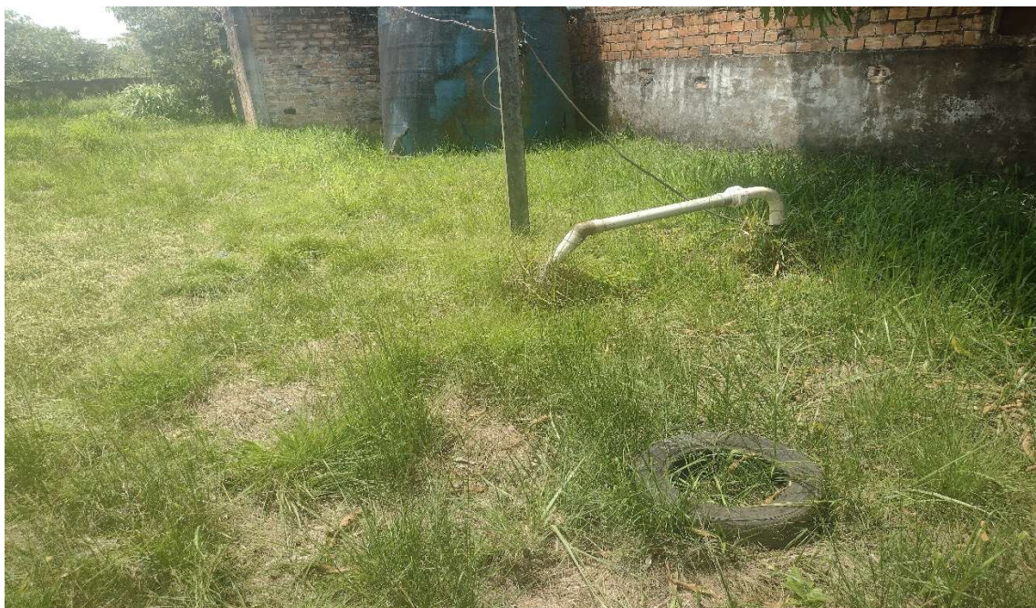
Figura 22. STI12-CAPTAÇÃO002, subterrânea (poço tubular)
