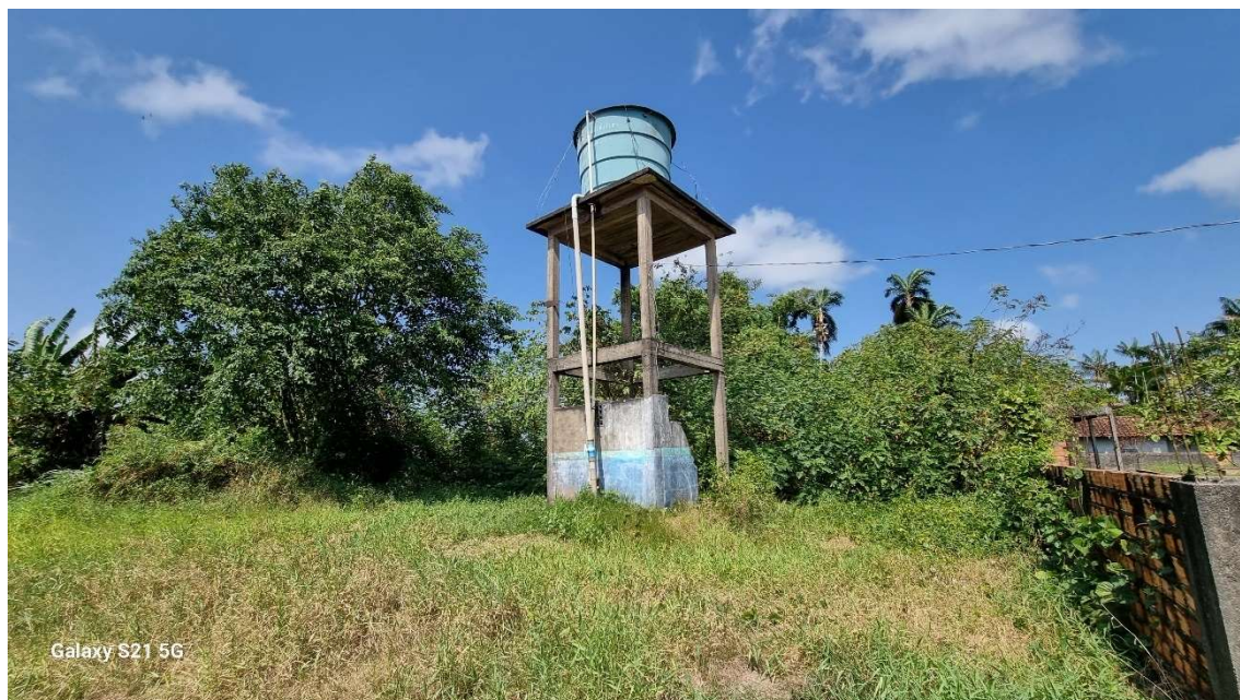
Figura 11. STI05-CAPTAÇÃO, subterrânea (poço tubular)
