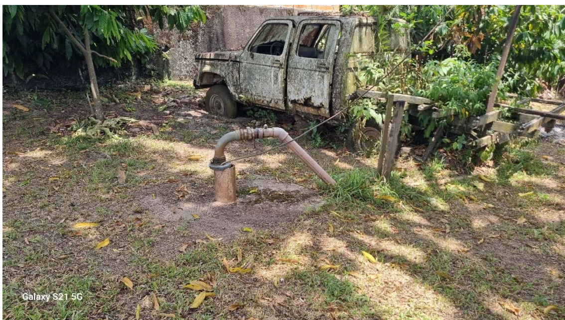
Figura 26. STI15-CAPTAÇÃO01, subterrânea (poço tubular)
