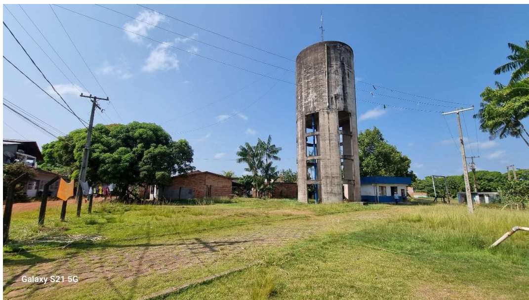
Figura 42. STI02-REL, (reservatório elevado)
