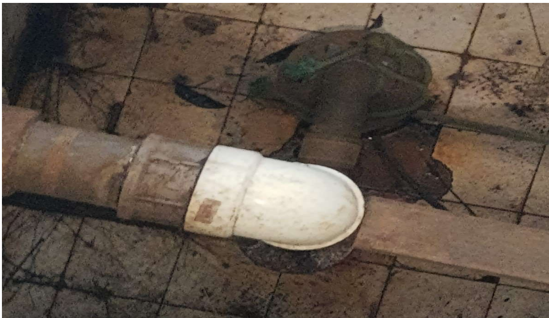
Figura 35. STI21-CAPTAÇÃO, subterrânea (poço tubular)
