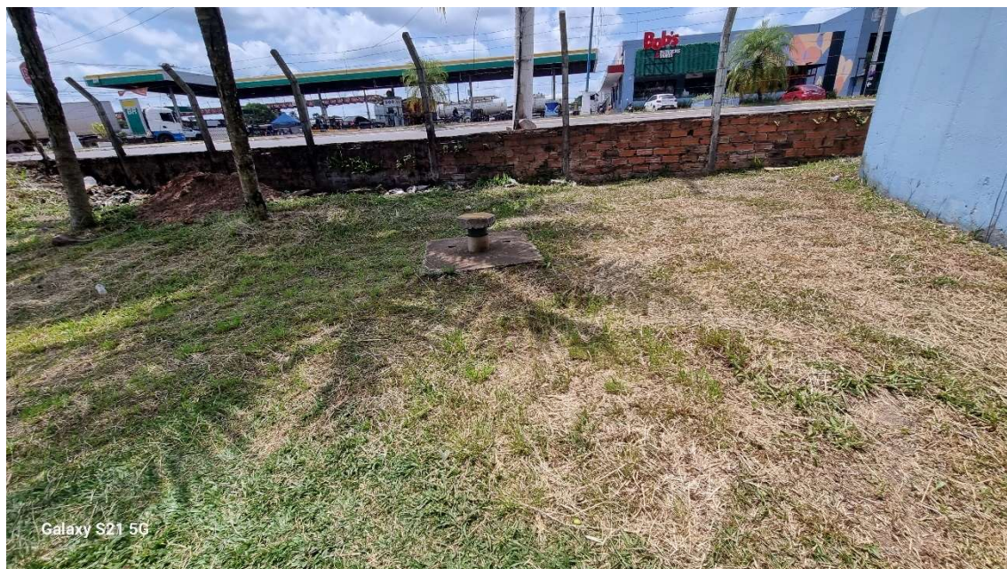
Figura 27. STI15-CAPTAÇÃO02, subterrânea (poço tubular)
