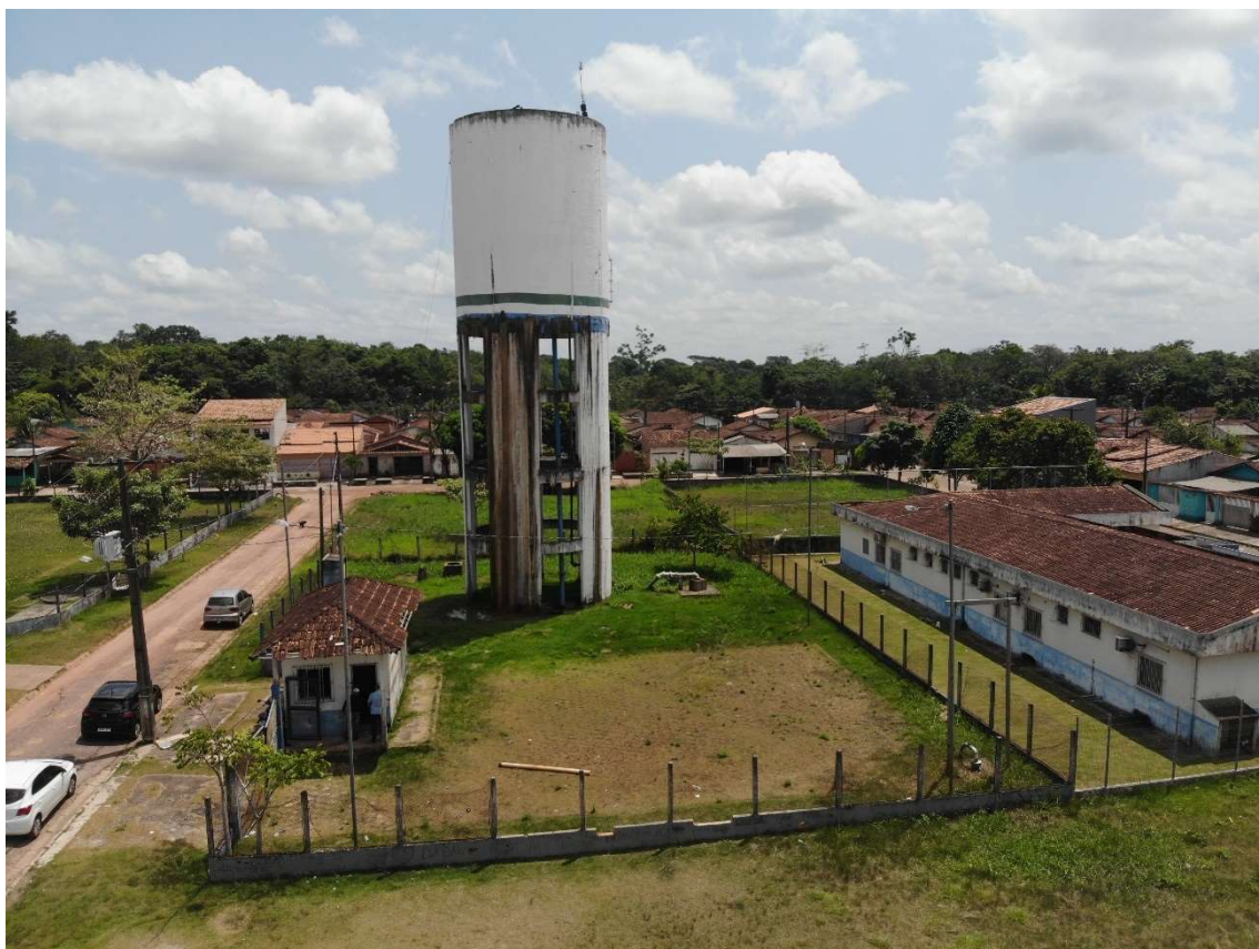
Figura 51. STI13-REL, (reservatório elevado)
