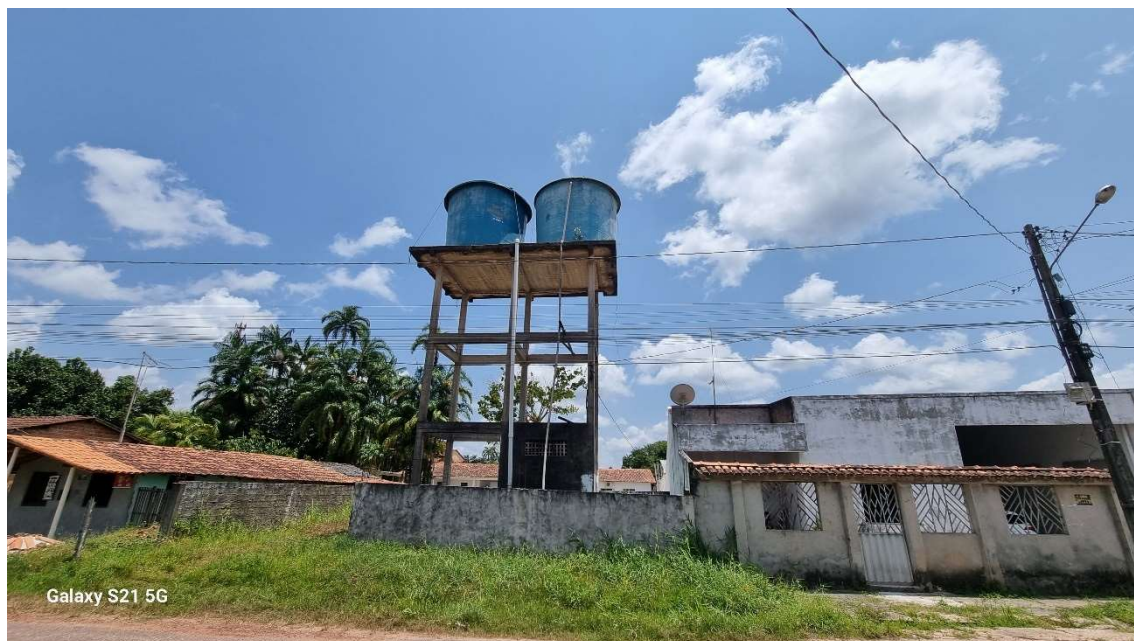
Figura 55. STI18-REL02, (reservatório elevado)
