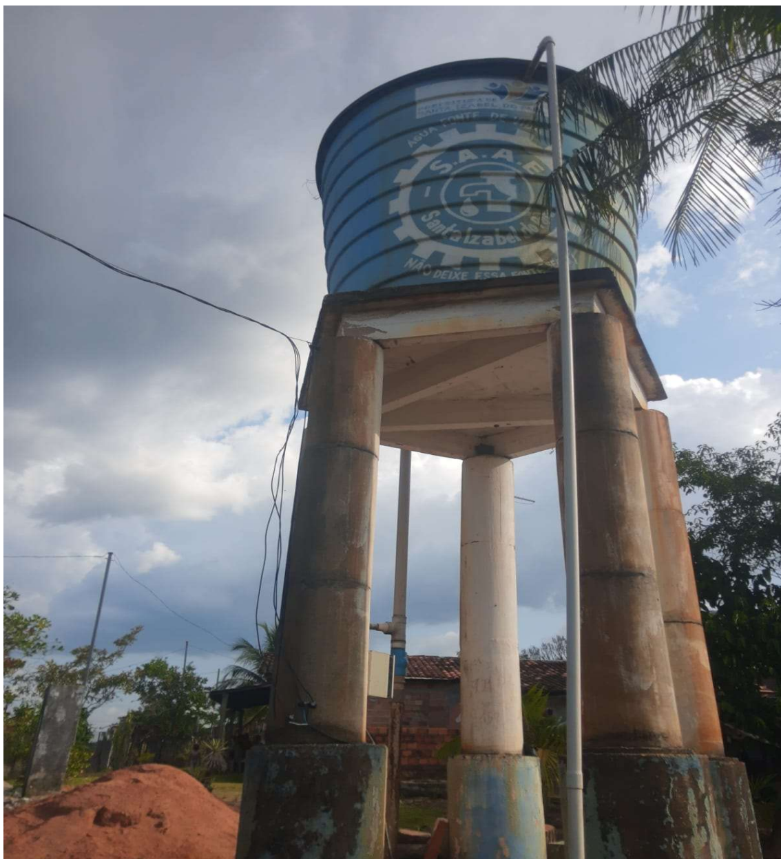
Figura 57. STI22-REL, (reservatório elevado)
