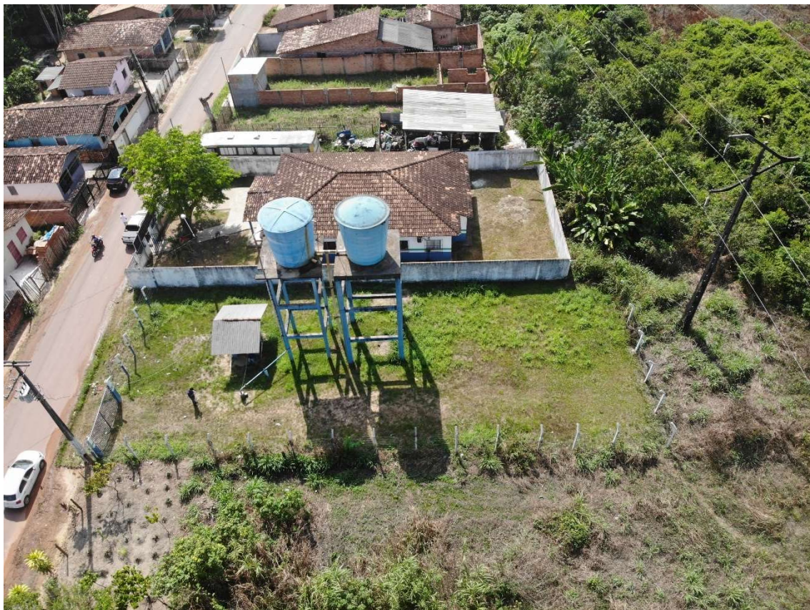
Figura 44. STI03-REL02, (reservatório elevado)
