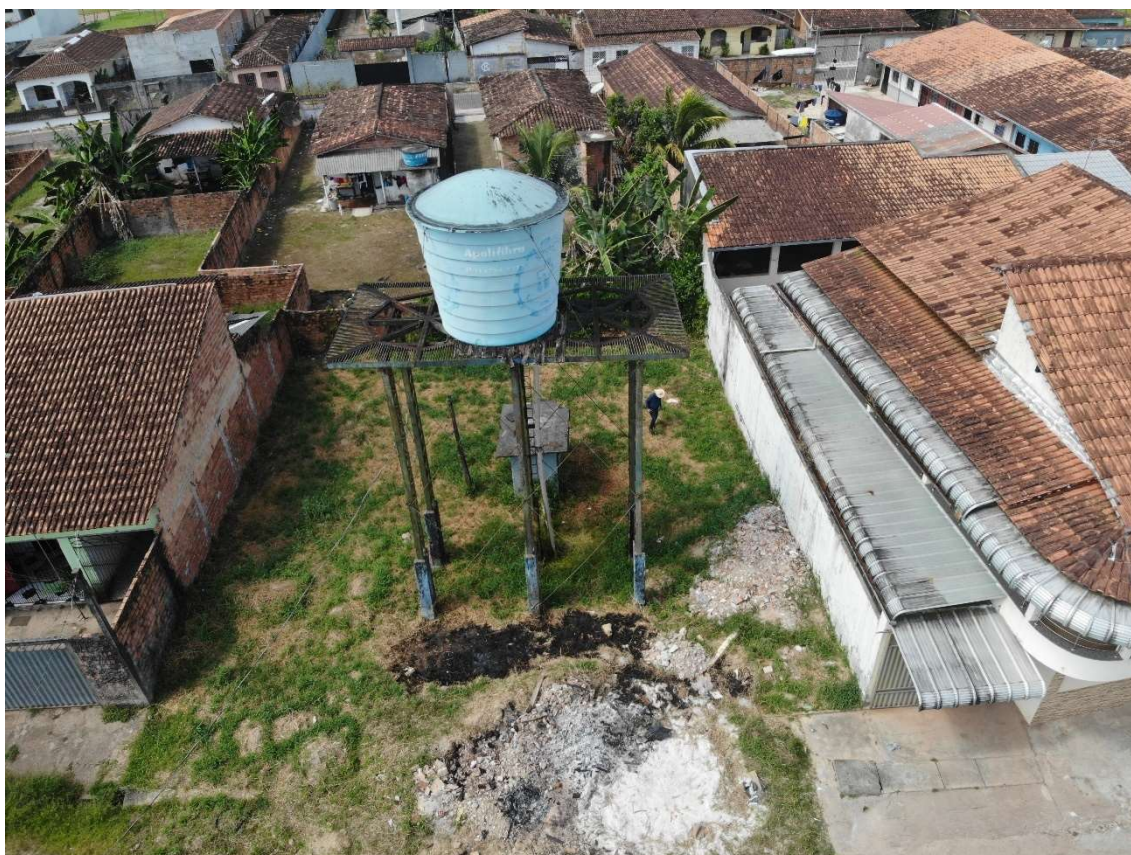
Figura 47. STI06-REL, (reservatório elevado)
