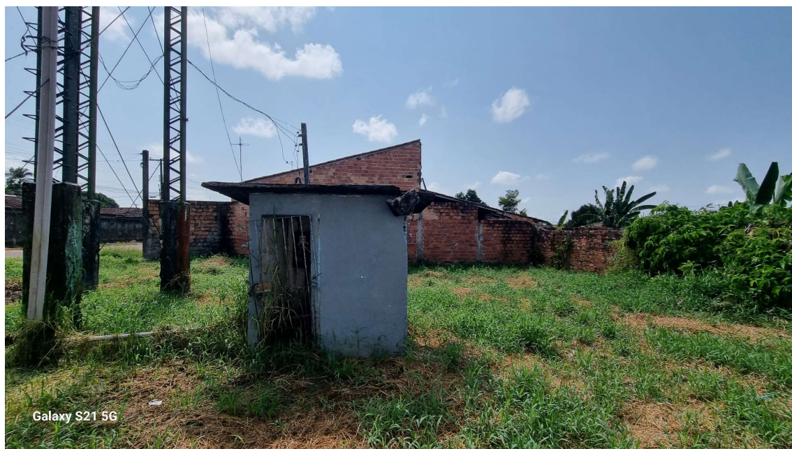
Figura 12. STI06-CAPTAÇÃO, subterrânea (poço tubular)
