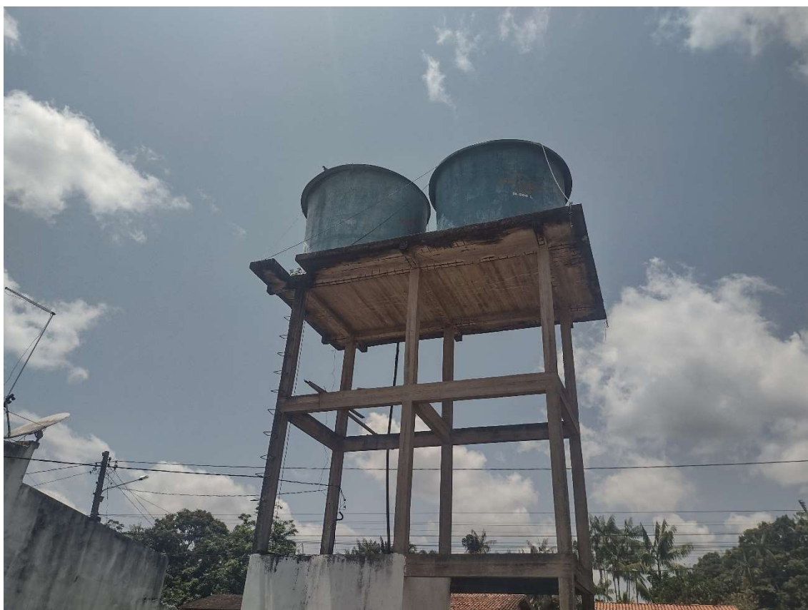
Figura 54. STI18-REL01, (reservatório elevado)
