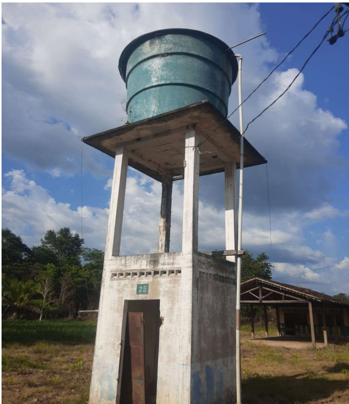
Figura 58. STI23-REL, (reservatório elevado)
