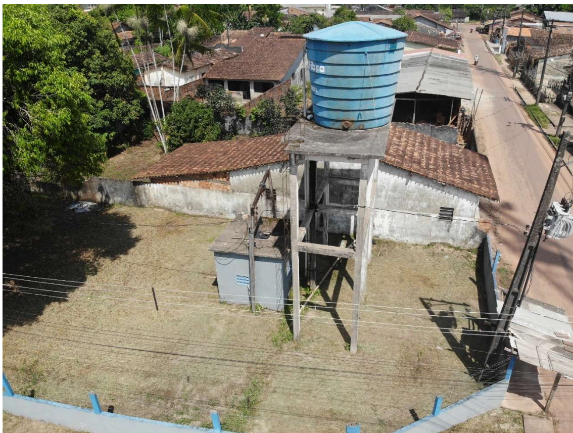
Figura 49. STI09-REL, (reservatório elevado)
