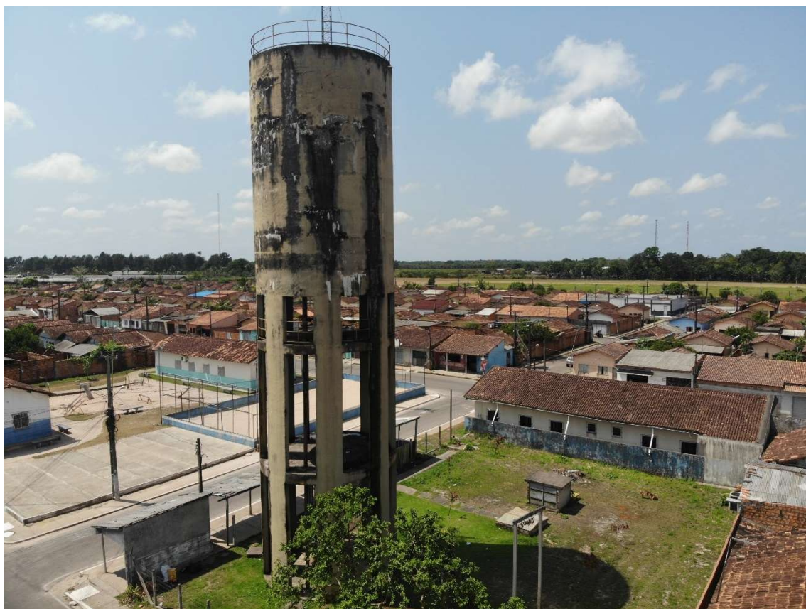
Figura 50. STI10-REL, (reservatório elevado)
