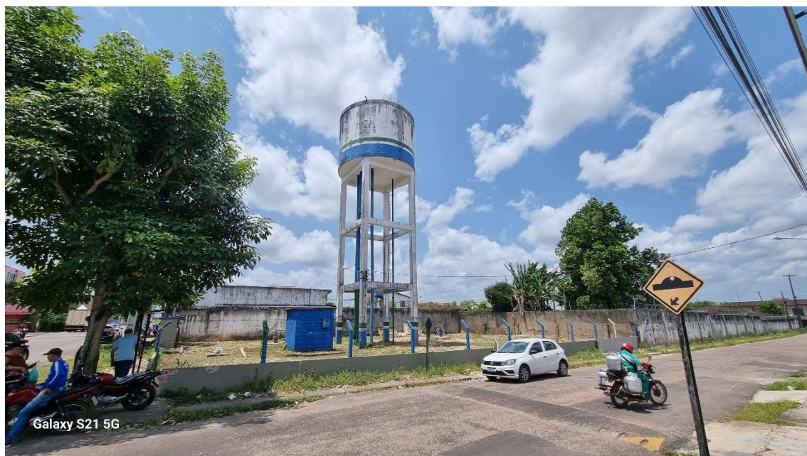
Figura 53. STI16-REL, (reservatório elevado)
