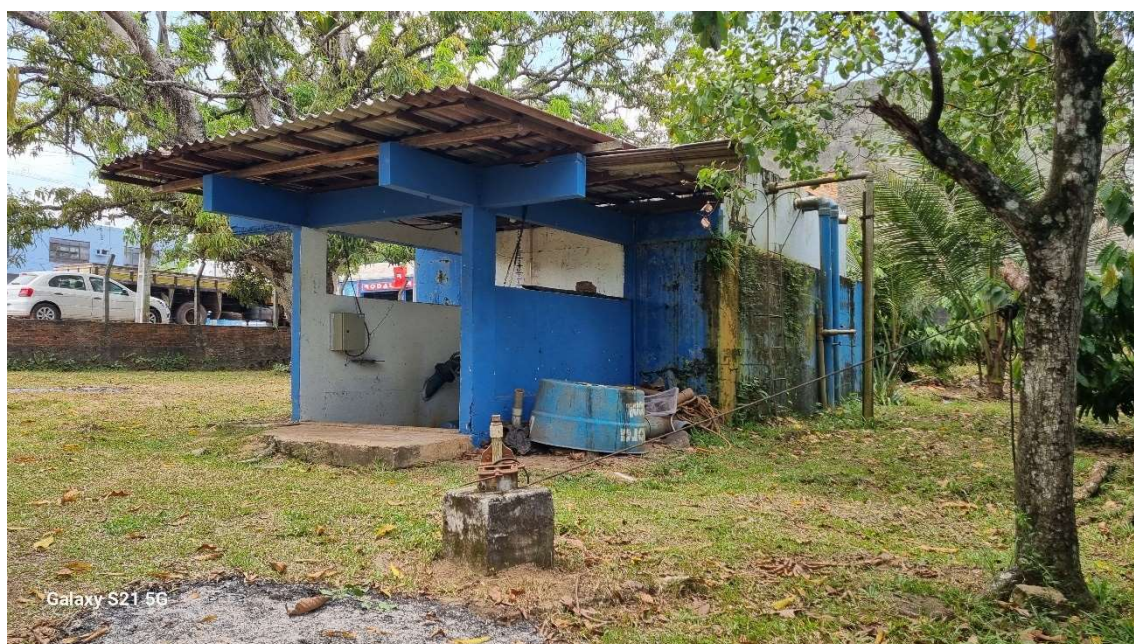
Figura 28. STI15-CAPTAÇÃO03, subterrânea (poço tubular)
