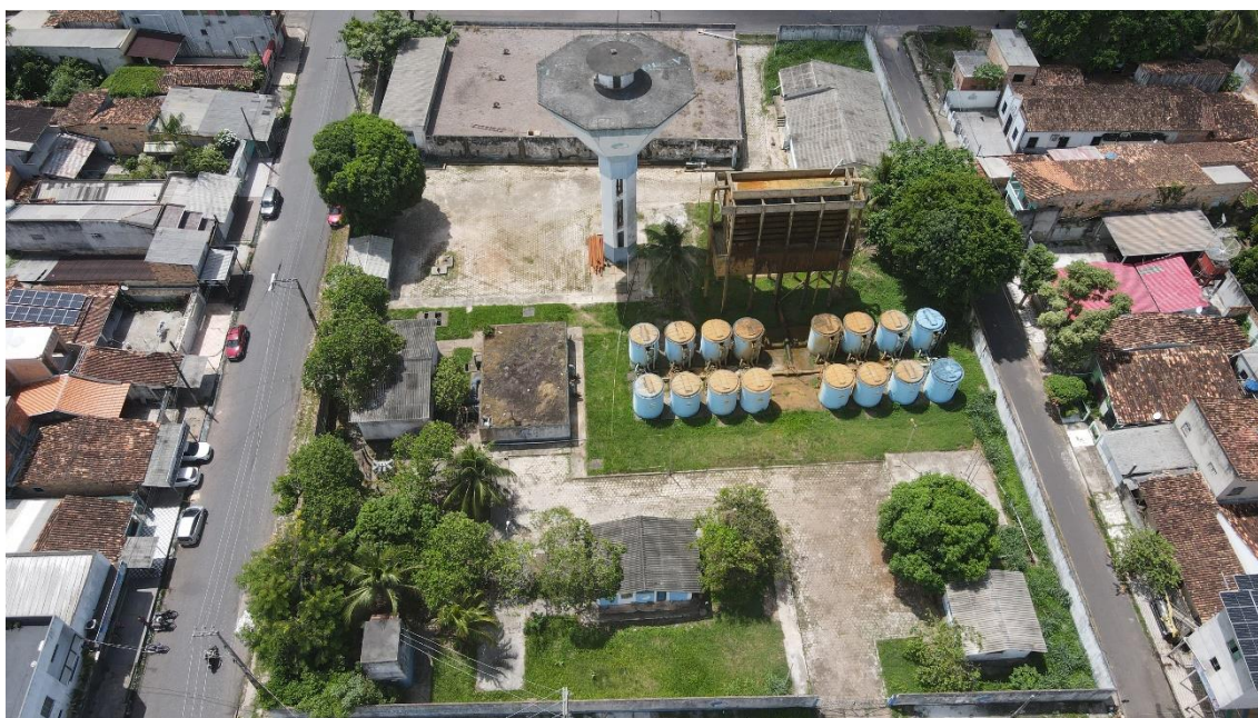
Figura 22. ETA compacta, Estrutura (Panorâmica).
