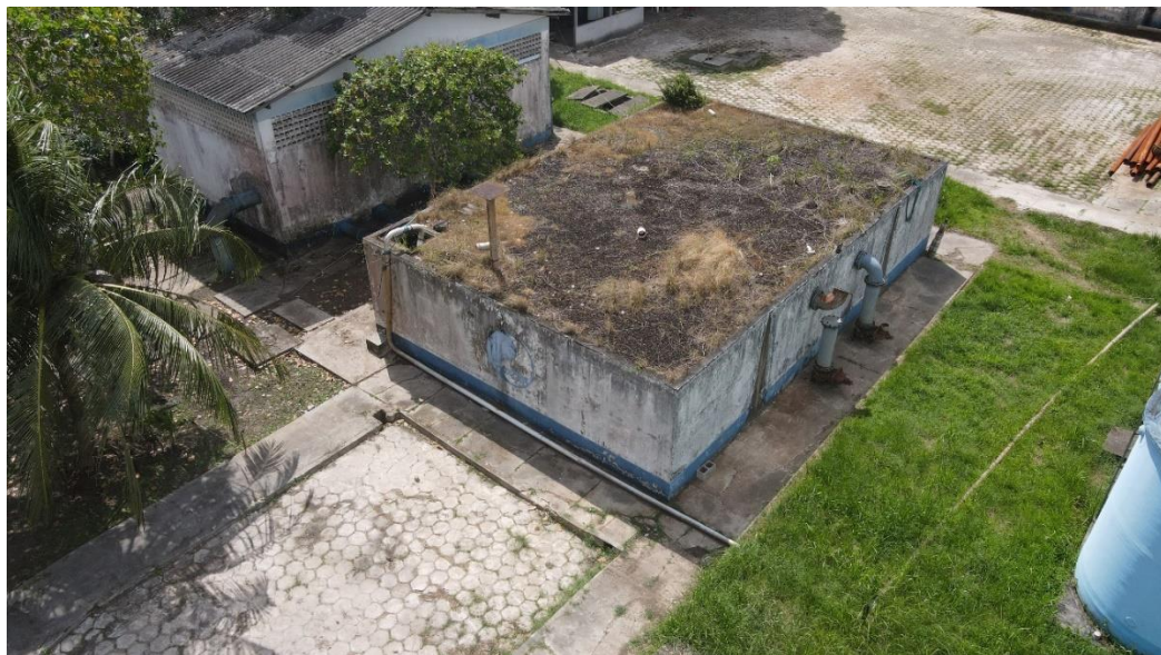
Figura 26. RAP02 de ABT01, estrutura (Aproximado)
