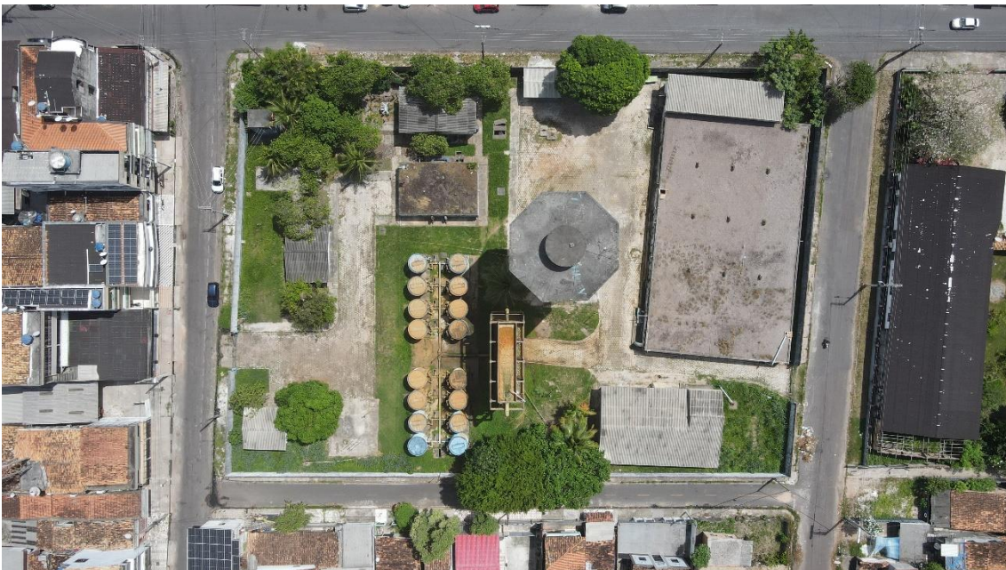
Figura 28. RAP01, RAP02 e REL01, estruturas (Panorâmica)
