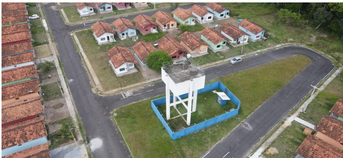
Figura 21. Poço Tubular de ABT16 (Panorâmica).
