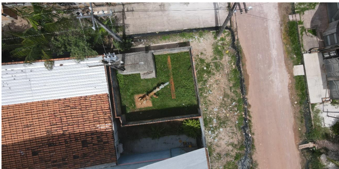
Figura 11. Poço Tubular de ABT06 (Panorâmica).
