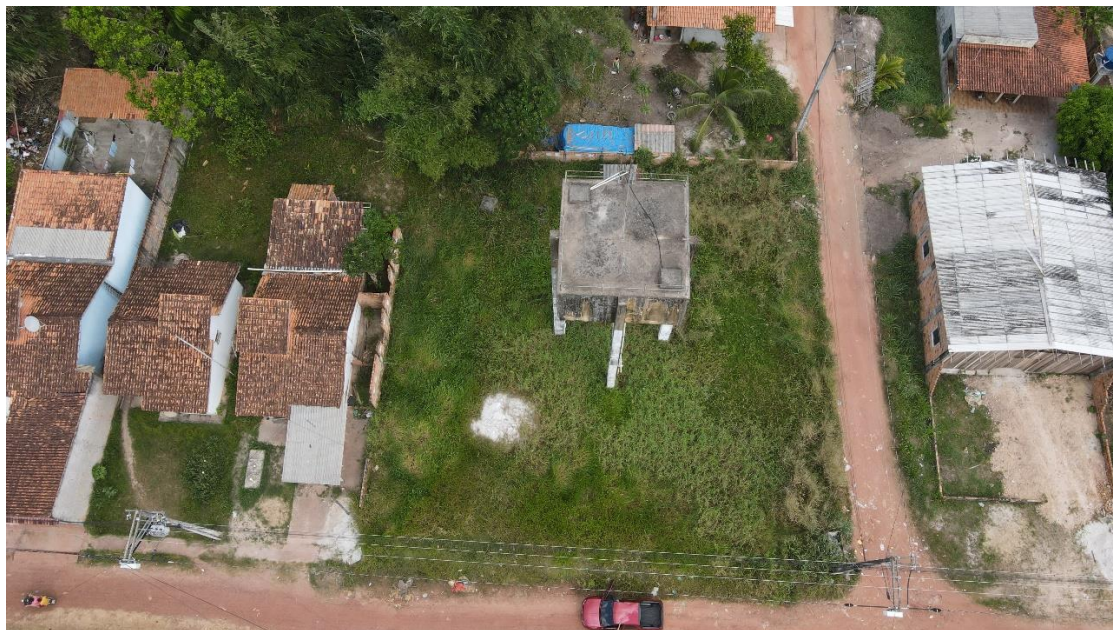
Figura 20. Poço Tubular de ABT12 (Panorâmica).
