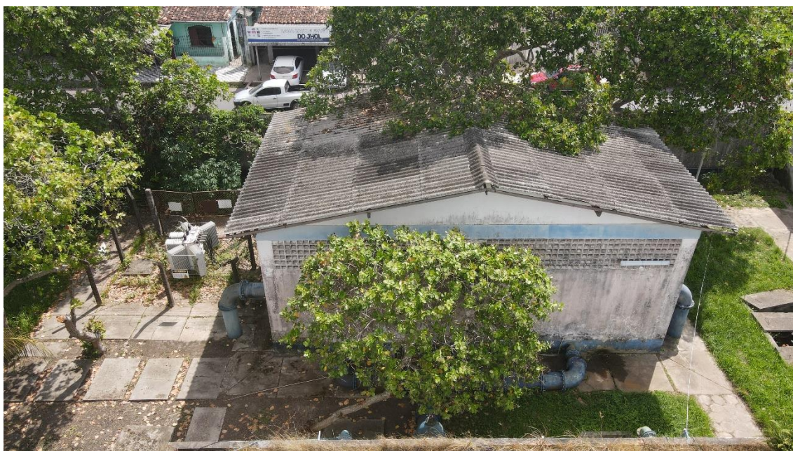
Figura 23. EEAT 01, EEAT02 e EELF Estrutura (Aproximado)
