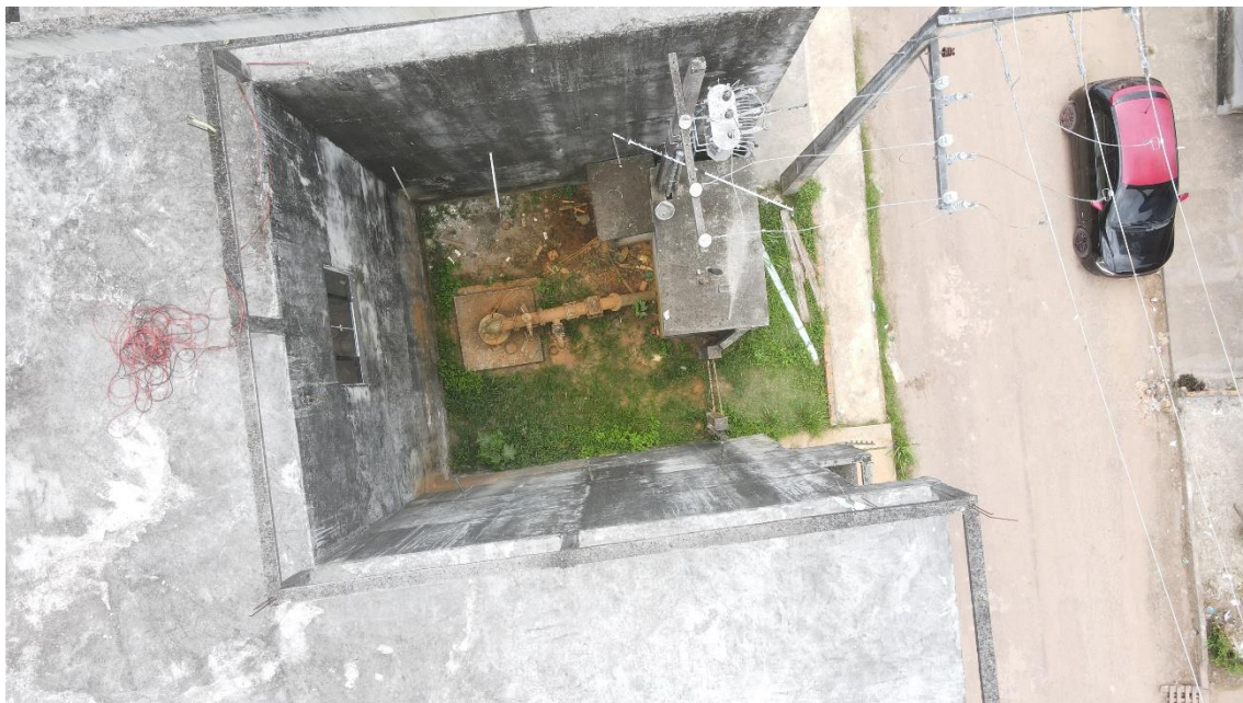
Figura 16. Poço Tubular de ABT09 (Panorâmica).
