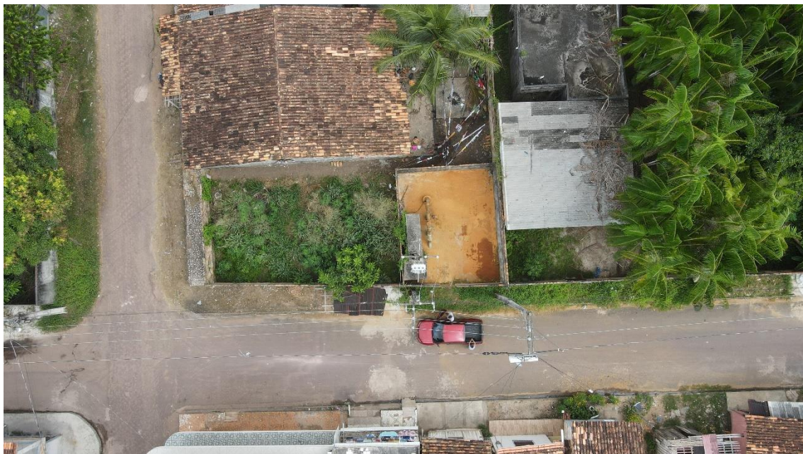
Figura 18. Poço Tubular de ABT10 (Panorâmica).
