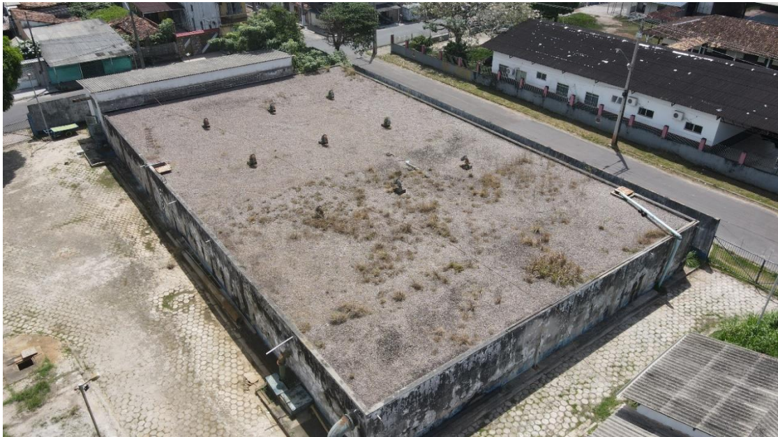
Figura 25. RAP01 de ABT01, estrutura (Aproximado)
