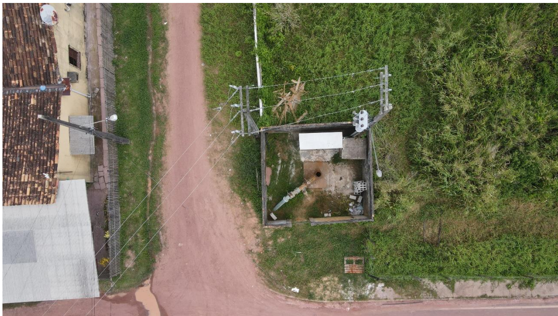
Figura 14. Poço Tubular de ABT07 (Panorâmica).
