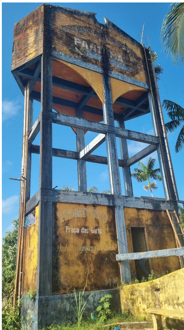
Figura 40. ACA01 - REL (reservatório elevado).
