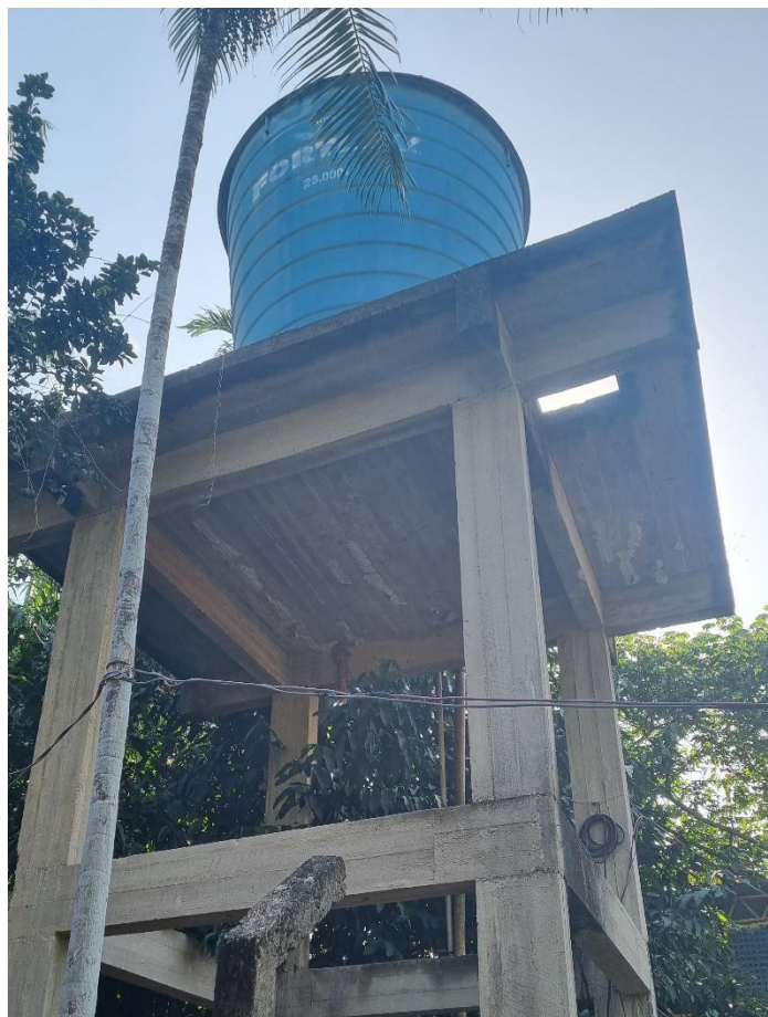
Figura 42. ACA02 - REL (reservatório elevado).
