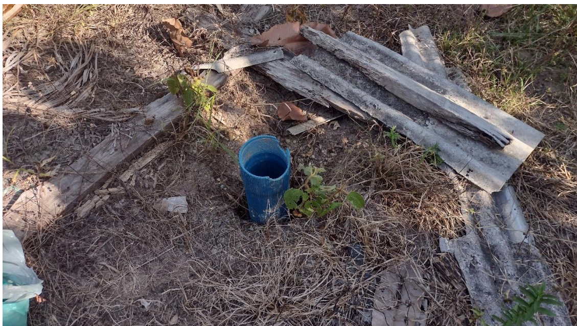
Figura 39. ACA18 - CAPTAÇÃO 01 (poço subterrâneo).
