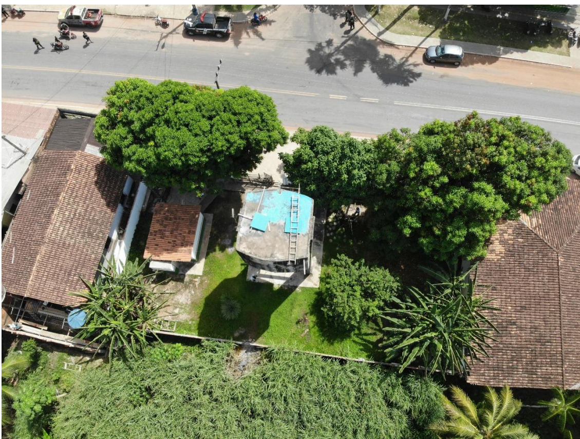
Figura 19. ACA08-CAPTAÇÃO, poço subterrâneo (panorâmica).
