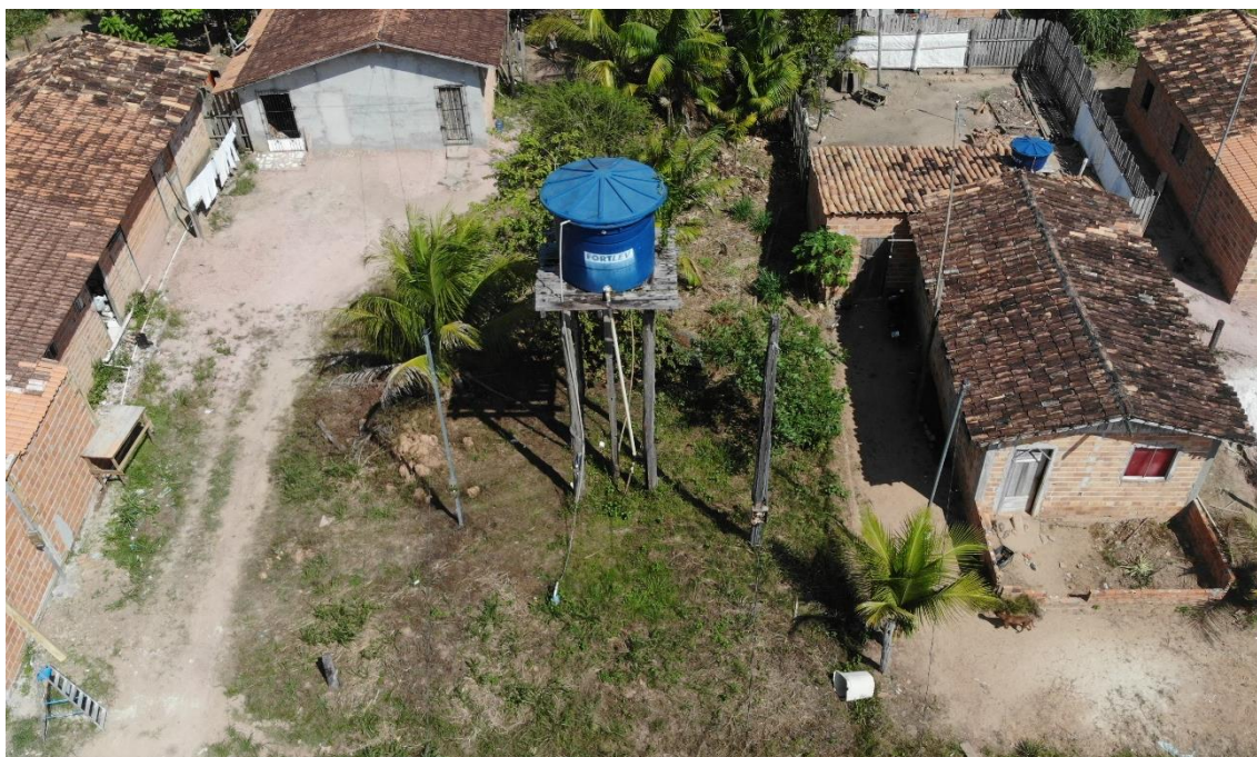
Figura 52. ACA14 - REL (reservatório elevado).
