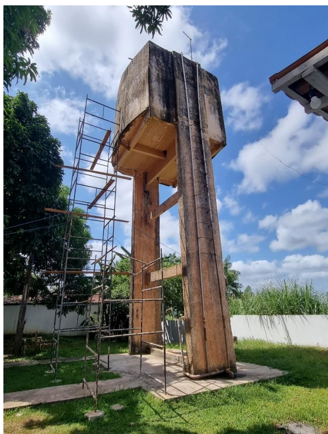
Figura 46. ACA08 - REL (reservatório elevado).
