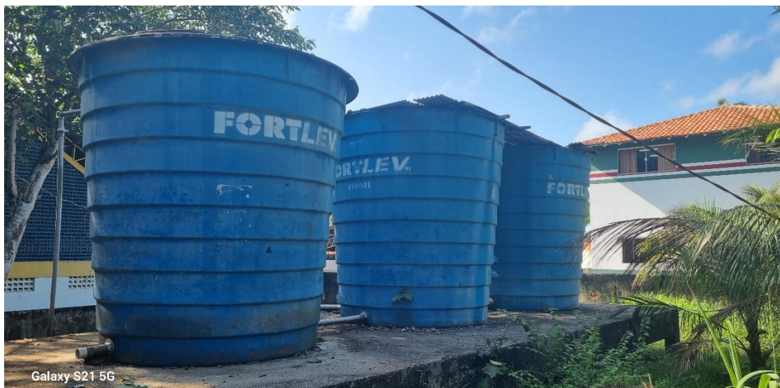
Figura 41. ACA02 - RAP1,2,3 (reservatório apoiado).
