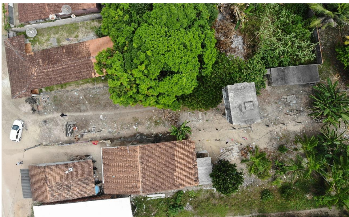
Figura 30. ACA013-CAPTAÇÃO,poço subterrâneo (panorâmica).
