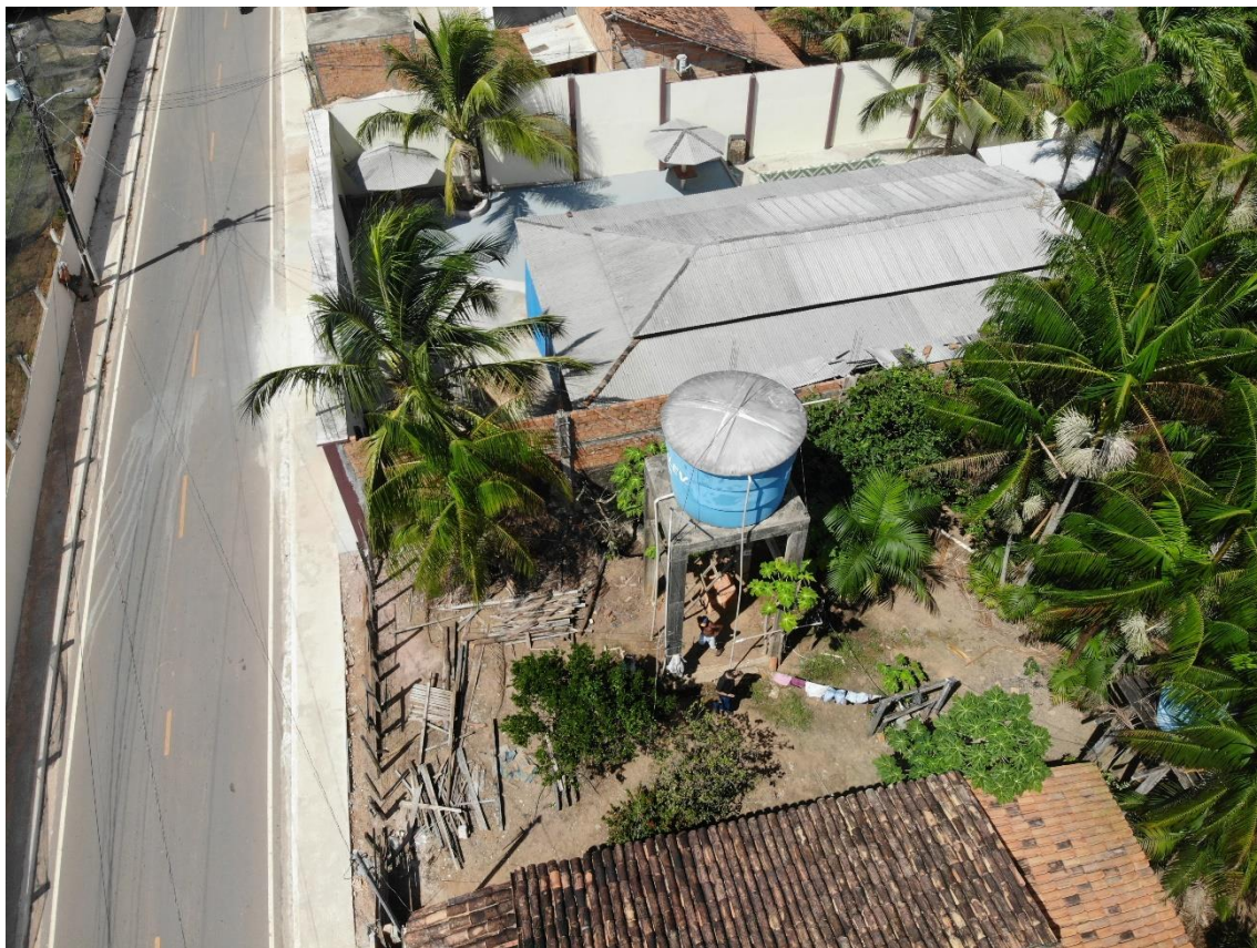
Figura 16. ACA07-CAPTAÇÃO, poço subterrâneo (panorâmica).
