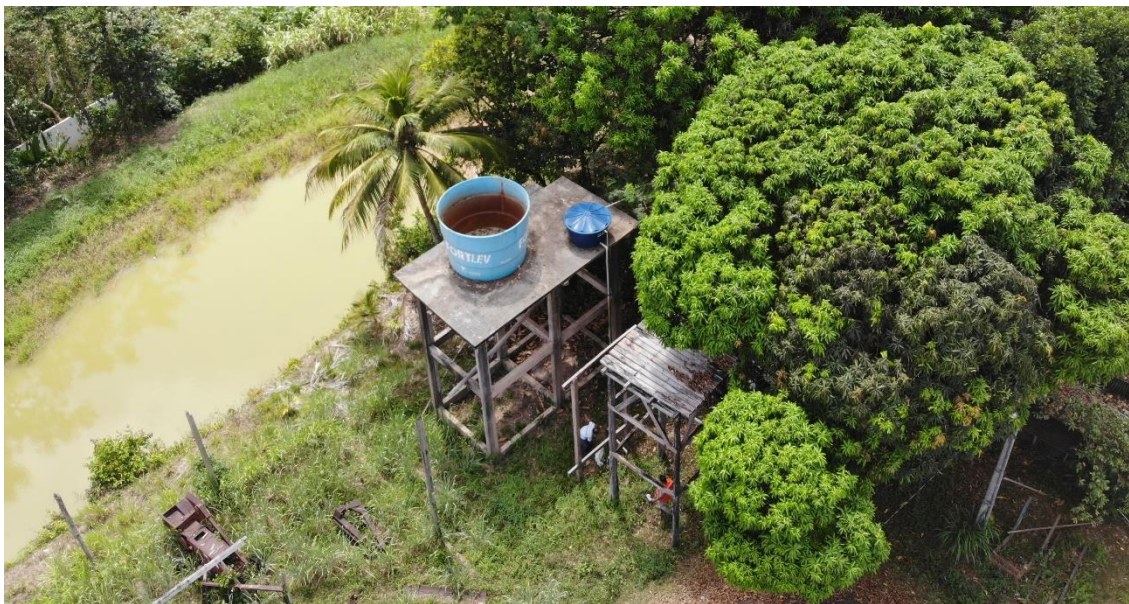
Figura 47. ACA10 - REL (reservatório elevado).
