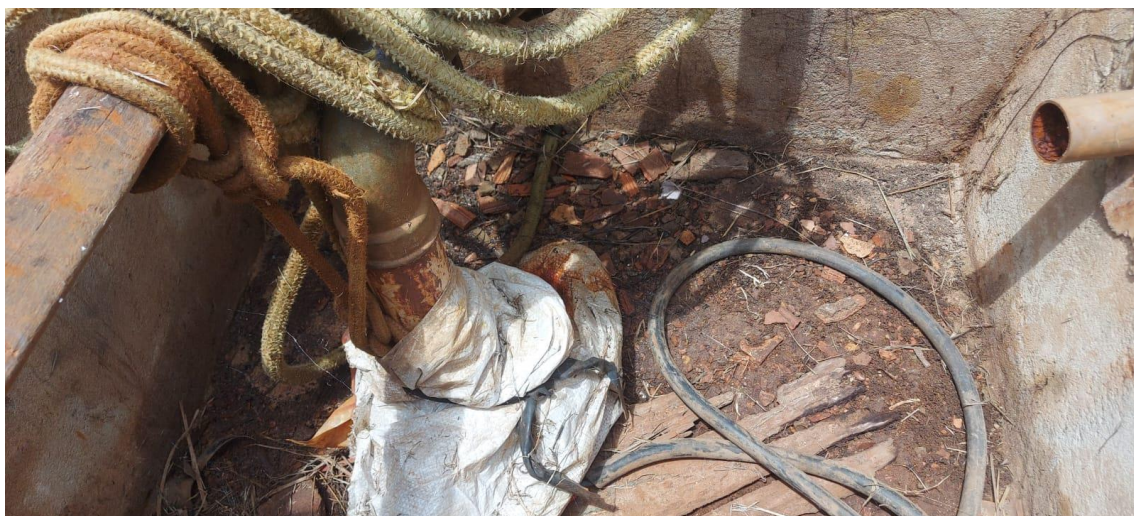
Figura 23. ACA12- CAPTAÇÃO 01 (poço subterrâneo).
