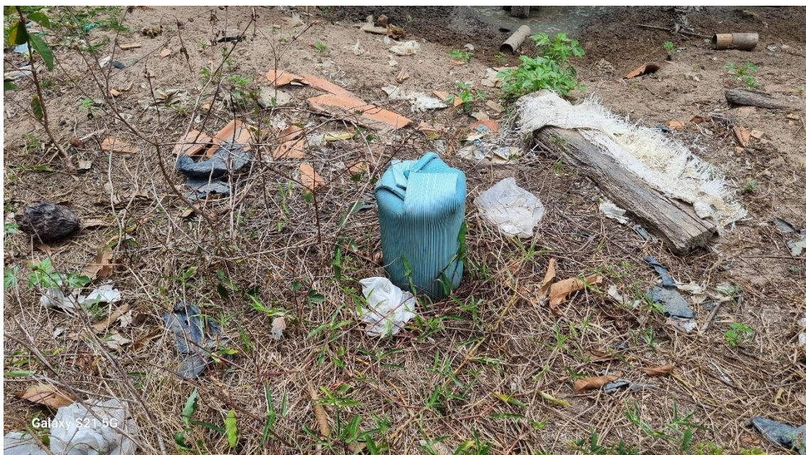
Figura 29. ACA13 - CAPTAÇÃO 03 (poço subterrâneo).
