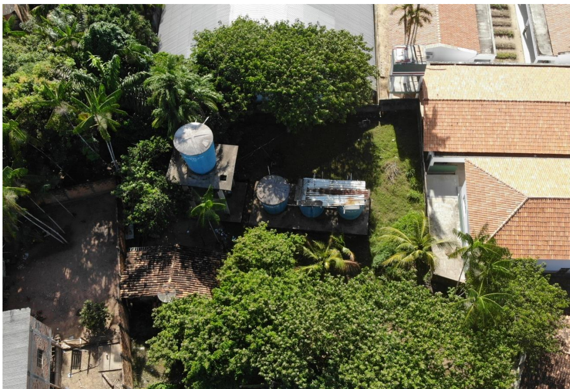
Figura 8. ACA02-CAPTAÇÃO, poço subterrâneo (panorâmica).
