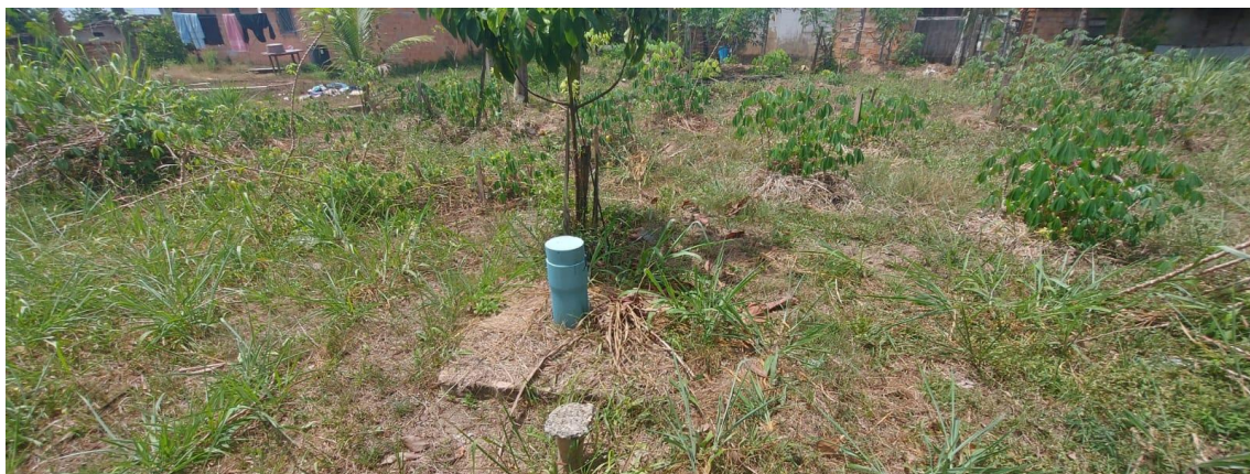
Figura 25. ACA12 - CAPTAÇÃO 03 (poço subterrâneo).
