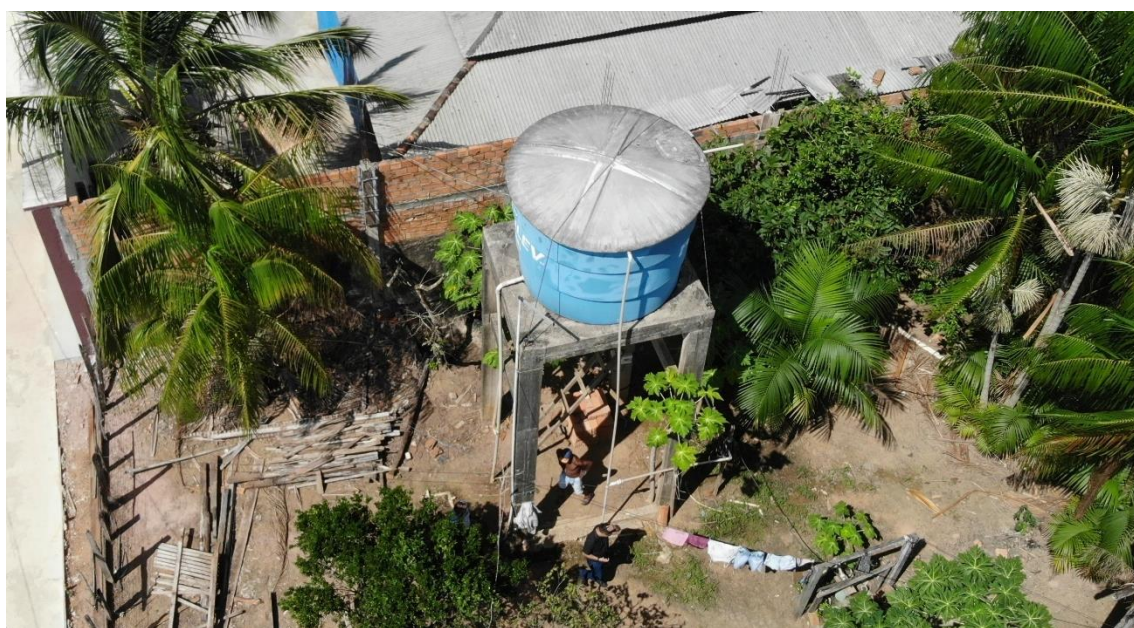
Figura 45. ACA07 - REL (reservatório elevado).
