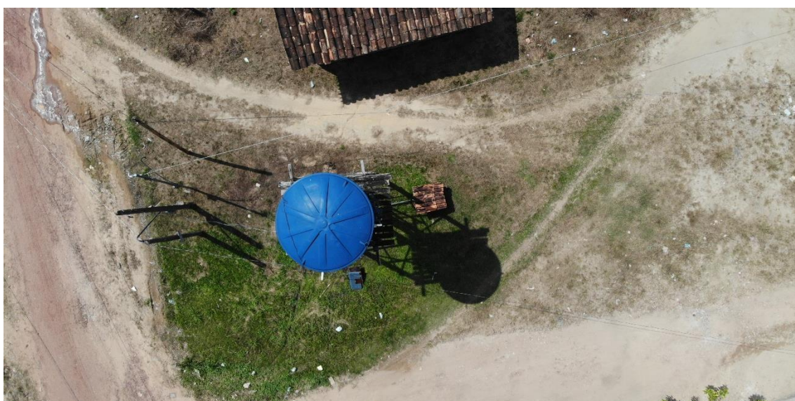
Figura 32. ACA014-CAPTAÇÃO, poço subterrâneo (panorâmica). Fonte: Consórcio, 2023.
