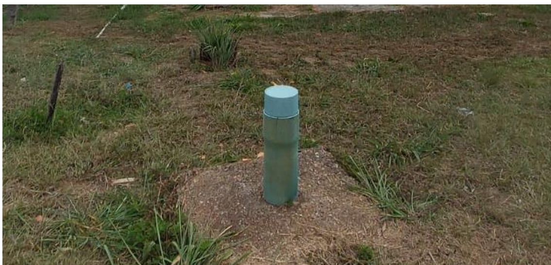
Figura 26. ACA12 - CAPTAÇÃO 04 (poço subterrâneo).
