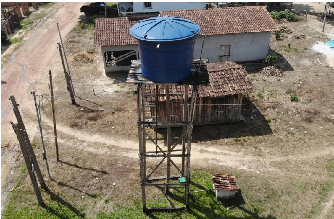
Figura 50. ACA14 - REL (reservatório elevado).
