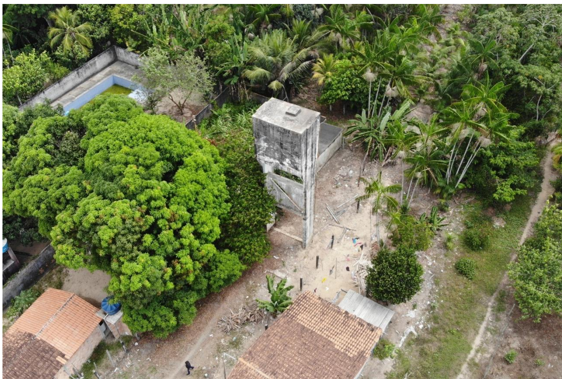
Figura 49. ACA13 - REL (reservatório elevado).
