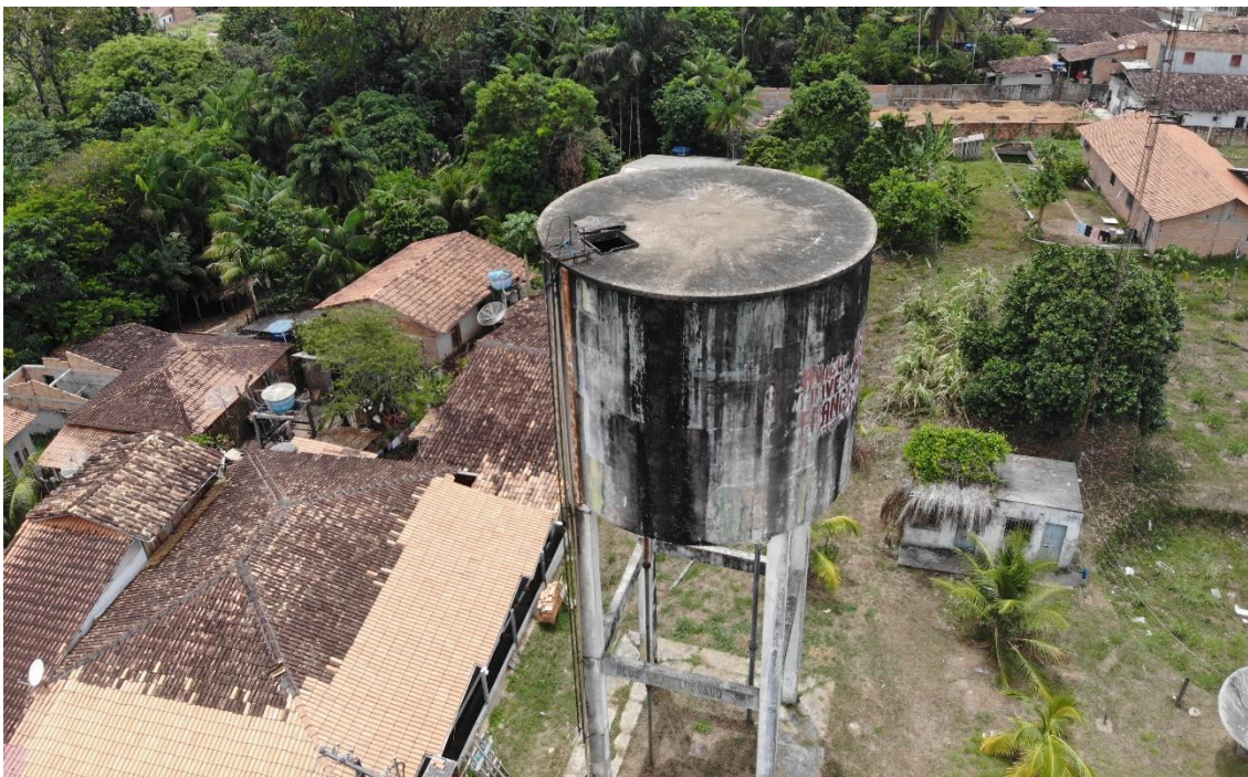
Figura 48. ACA12 - REL (reservatório elevado).
