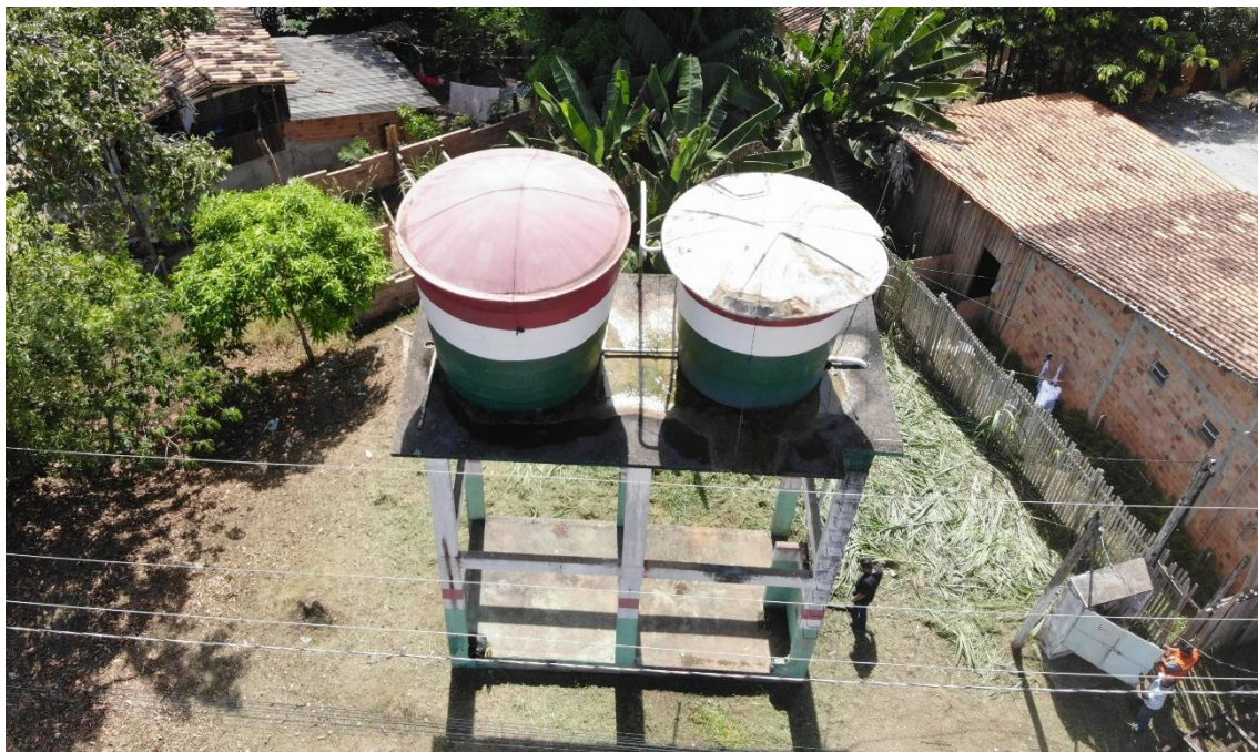
Figura 44. ACA06 - REL (reservatório elevado).
