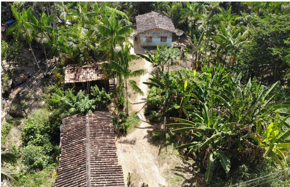
Figura 14. ACA05-CAPTAÇÃO, poço subterrâneo (panorâmica).
