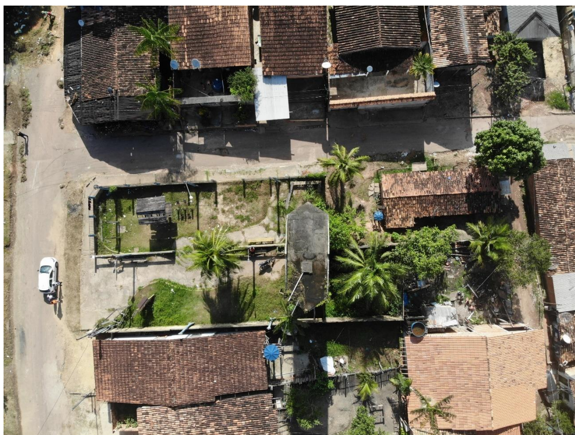
Figura 5. ACA01-CAPTAÇÃO 1 e 2, poço subterrâneo (panorâmica).
