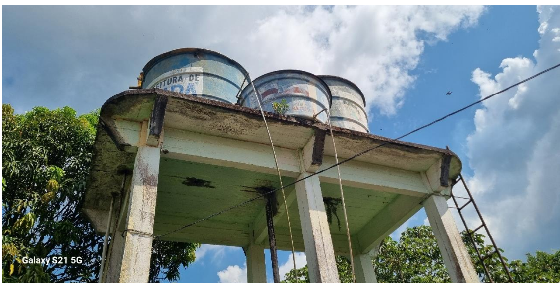
Figura 51. ACA13 - REL (reservatório elevado).
