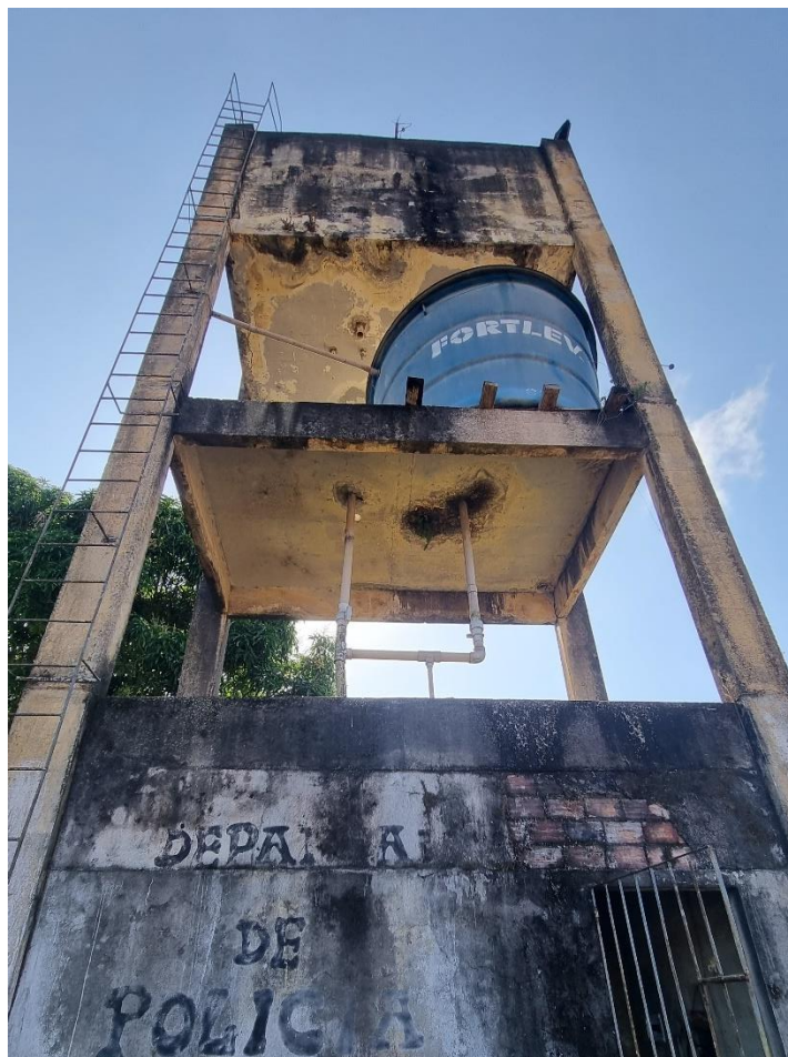
Figura 43. ACA03 - REL (reservatório elevado).
