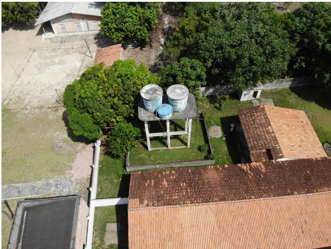
Figura 35. ACA015-CAPTAÇÃO,poço subterrâneo ( panorâmica).
