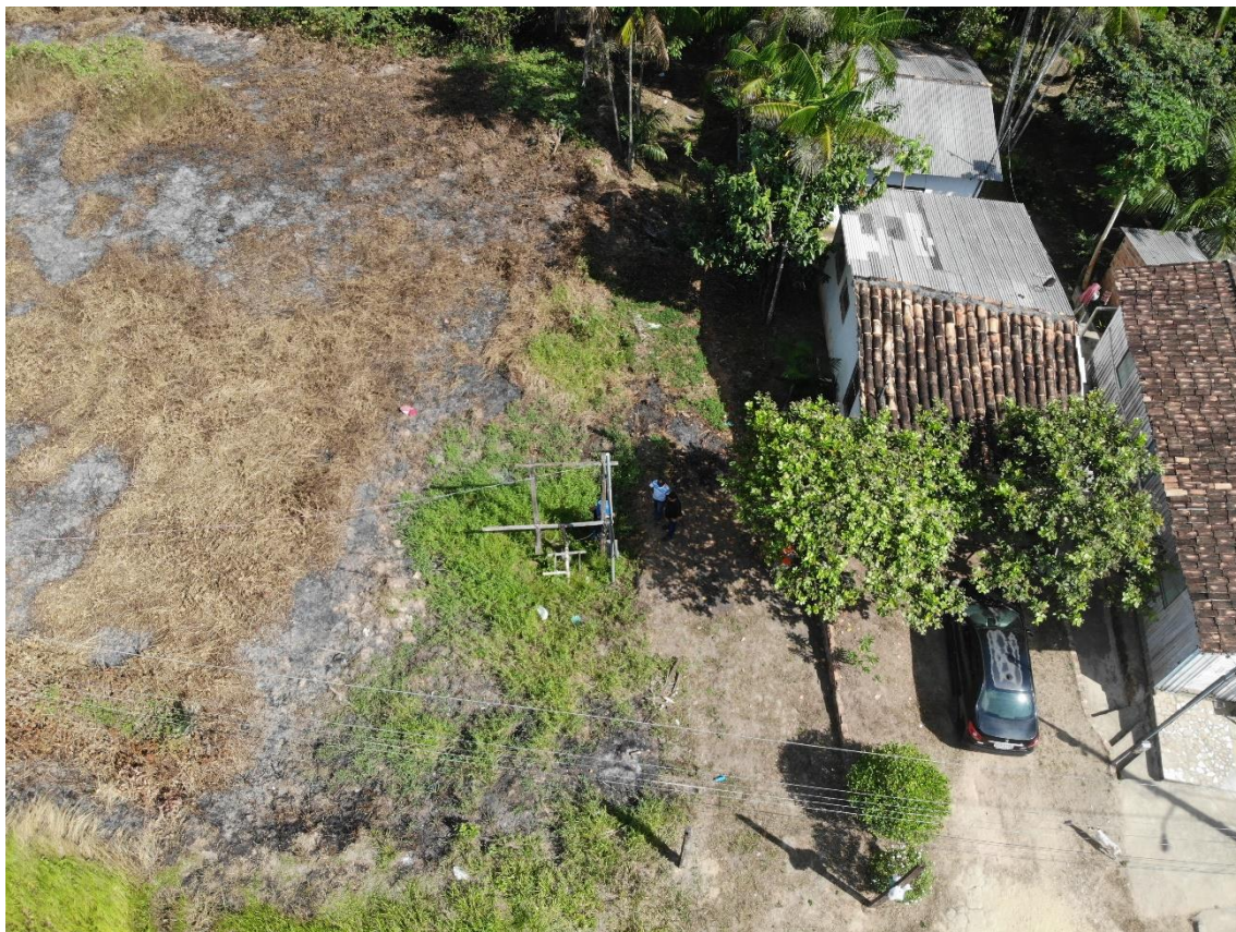
Figura 12. ACA04-CAPTAÇÃO,poço subterrâneo ( panorâmica).
