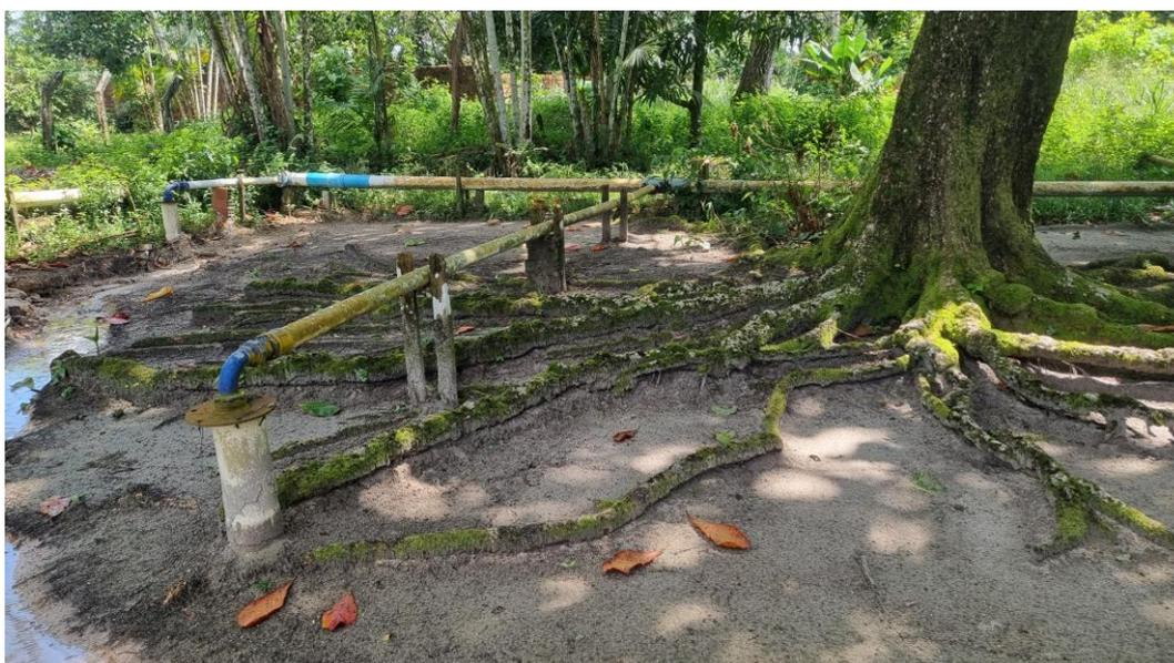
*Figura 4. Captação - AUG01, poços a vácuo.
