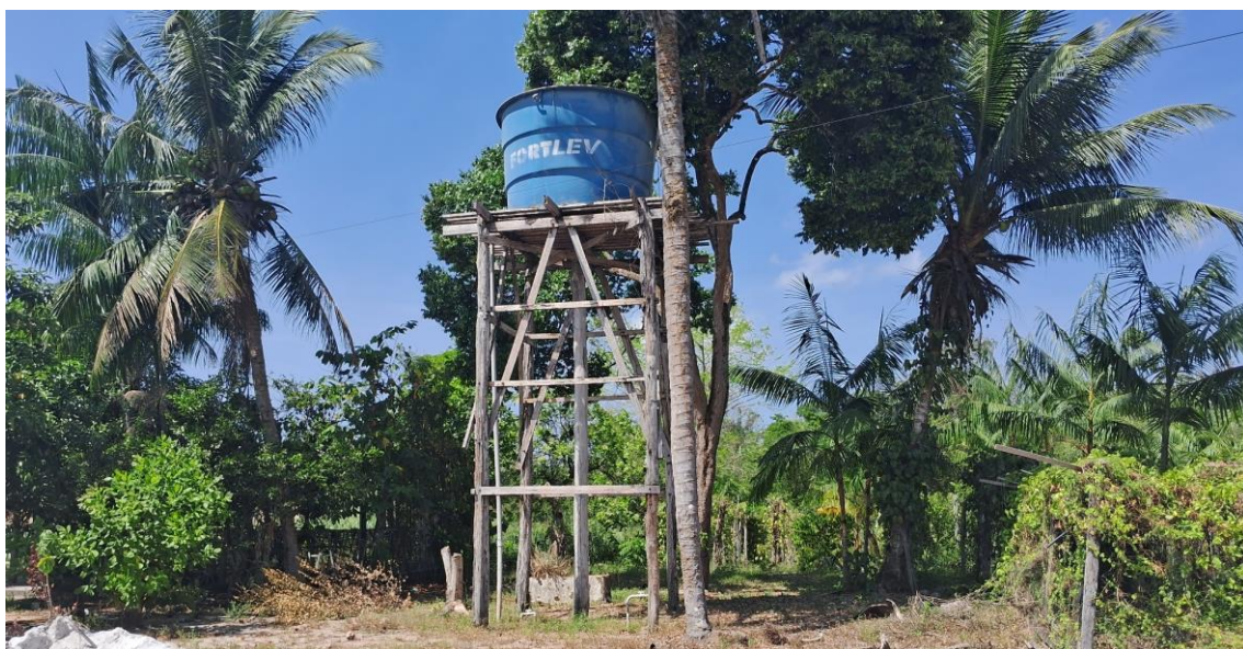
Figura 27. Reservatório de BAI03, estrutura (Aproximado).
