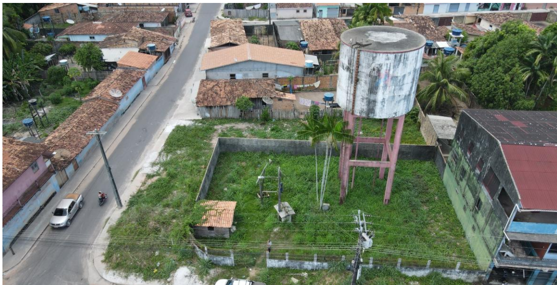
Figura 38. REL de BAI10, estrutura (Panorâmica).
