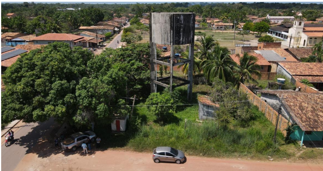
Figura 34. REL de BAI05, estrutura (Panorâmica).
