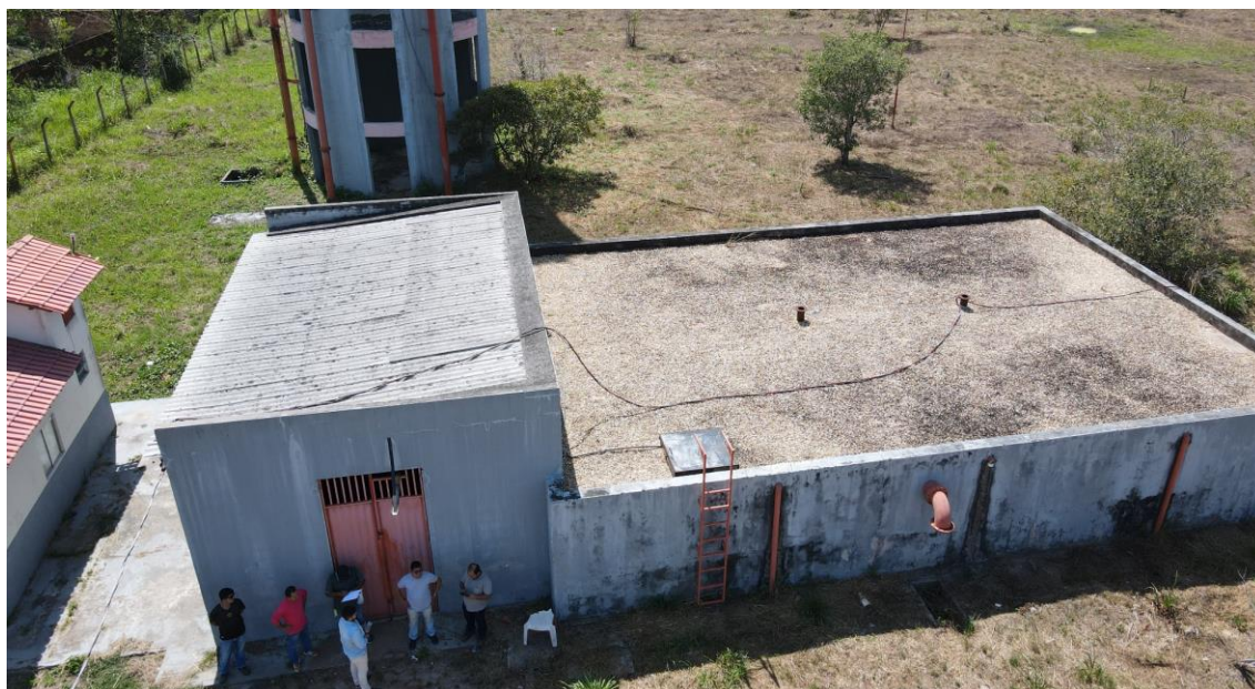
Figura 29. RAP de BAI04, estrutura (Aproximado).
