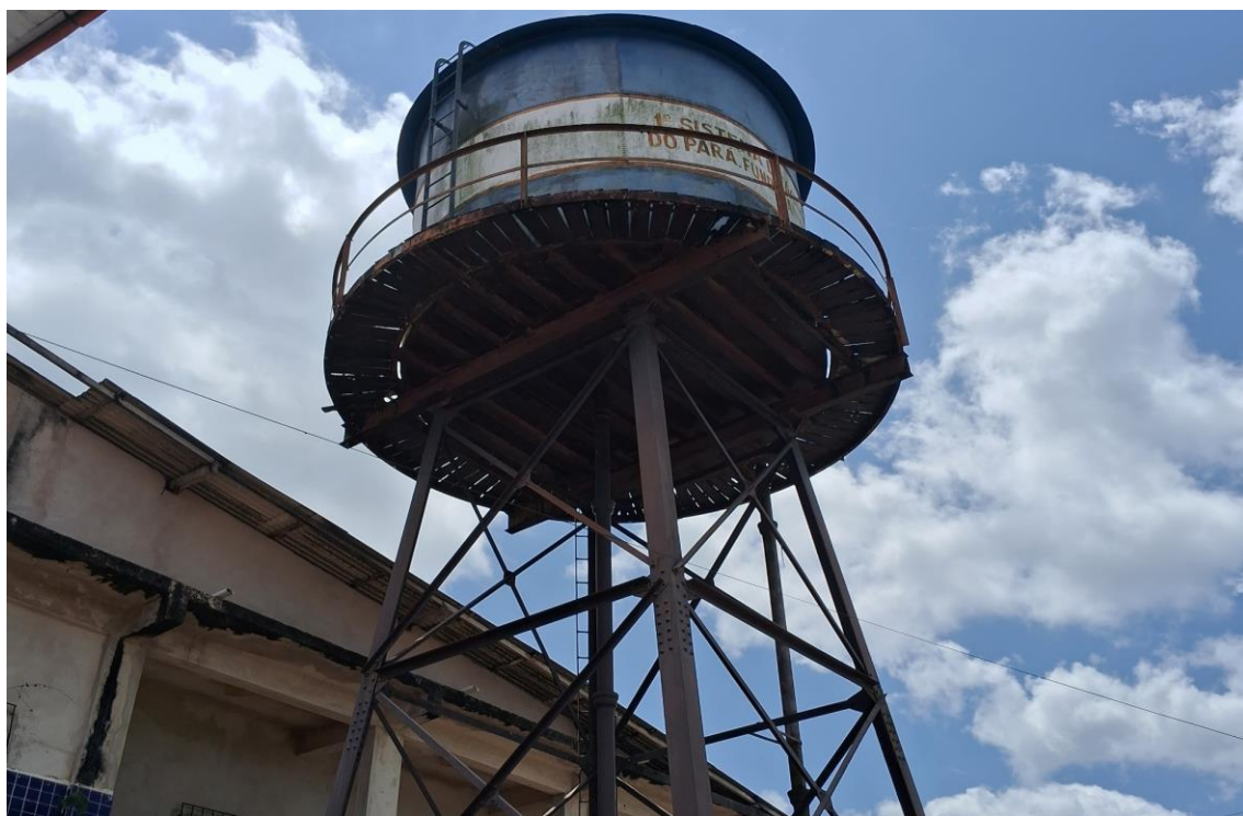
Figura 43. Reservatório de BAI16, estrutura (Aproximado).
