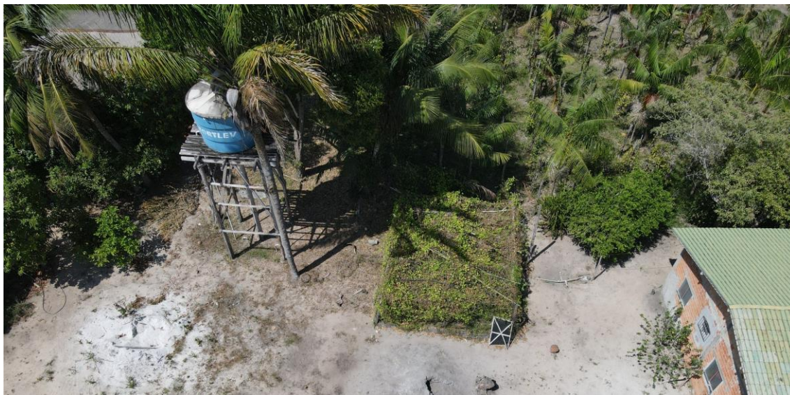
Figura 28. Reservatório de BAI03, estrutura (Panorâmica).
