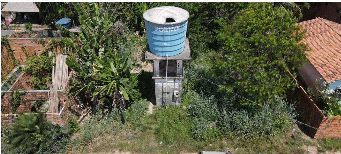
Figura 36. Reservatório de BAI06, estrutura (Panorâmica).
