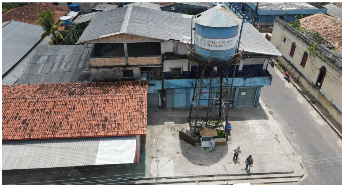
Figura 44. Reservatório de BAI16, estrutura (Panorâmica).
