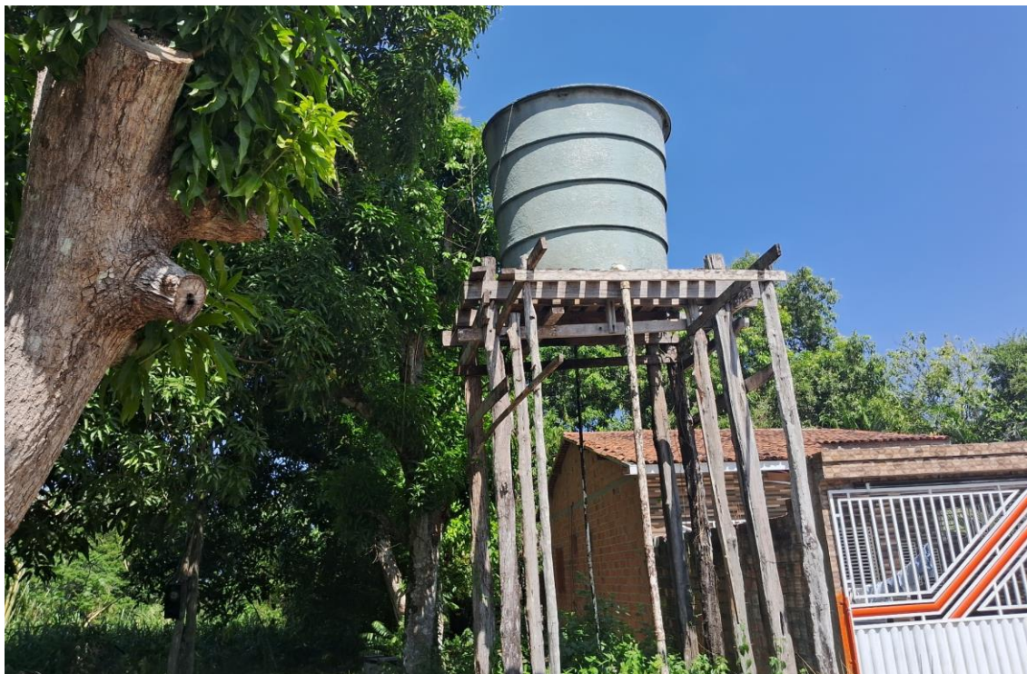
Figura 25. Reservatório de BAI02, estrutura (Aproximado).
