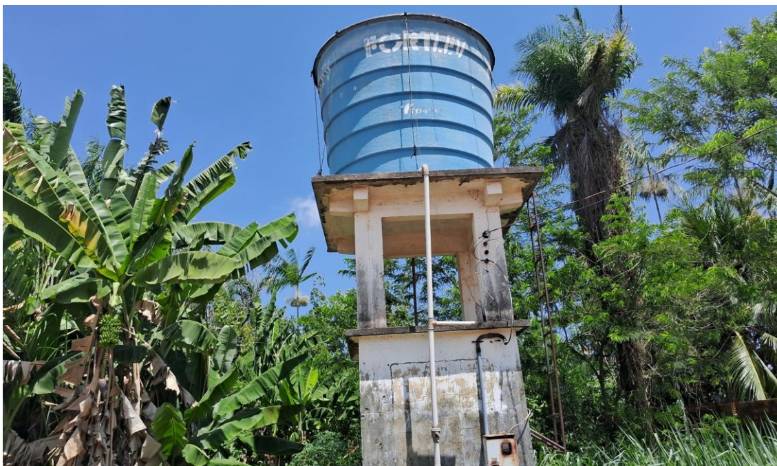
Figura 35. Reservatório de BAI06, estrutura (Aproximado).
