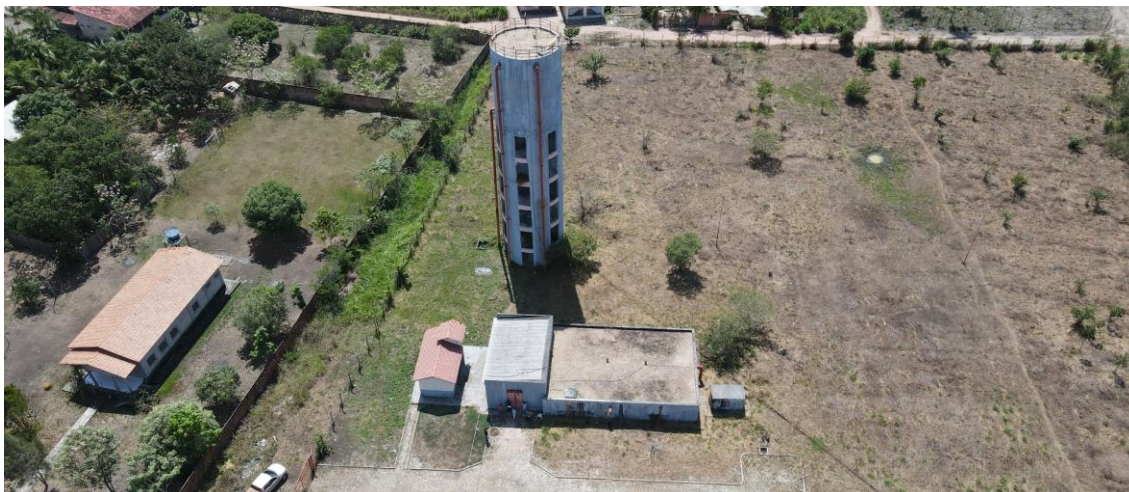
Figura 32. REL de BAI04, estrutura (Panorâmica).
