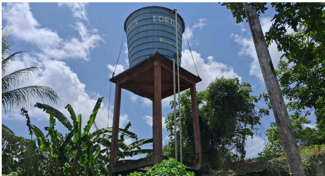
Figura 41. Reservatório de BAI14, estrutura (Aproximado).
