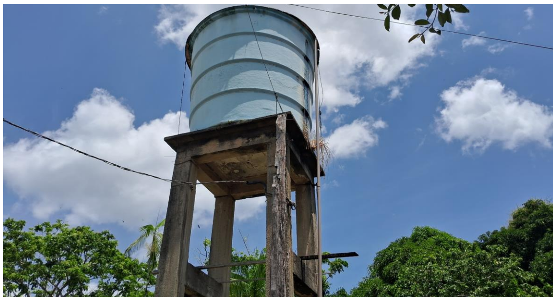
Figura 39. Reservatório de BAI13, estrutura (Aproximado).
