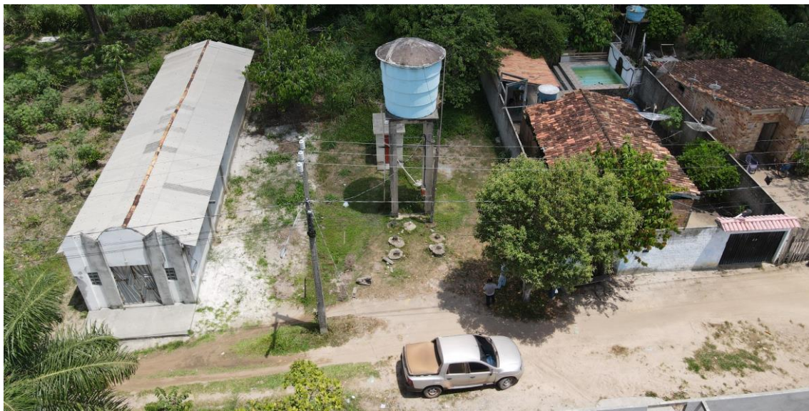
Figura 40. Reservatório de BAI13, estrutura (Panorâmica).
