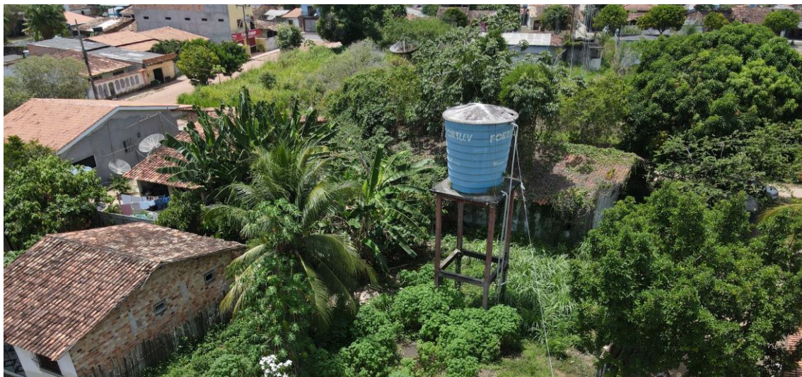
Figura 42. Reservatório de BAI14, estrutura (Panorâmica).
