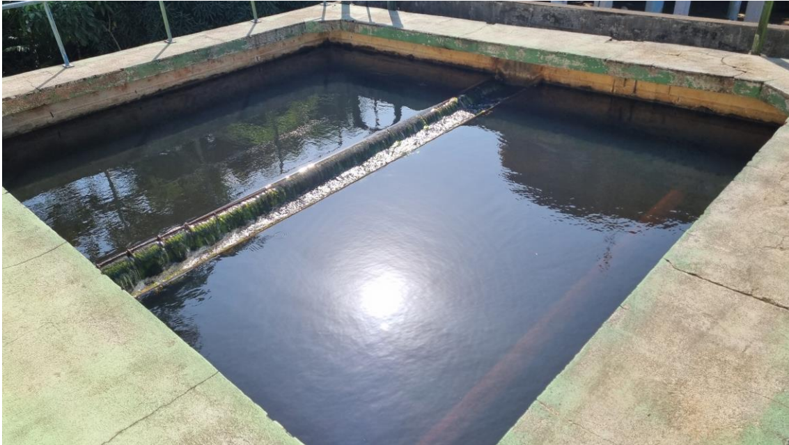
Figura 6. BRA01-ETA, Estação de Tratamento de Água (decantador). Fonte: Consórcio, 2023.
