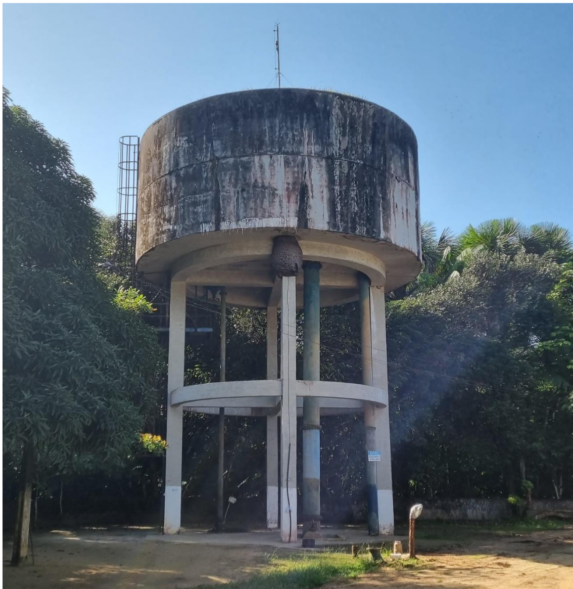
Figura 13. BRA01-REL (reservatório elevado).
