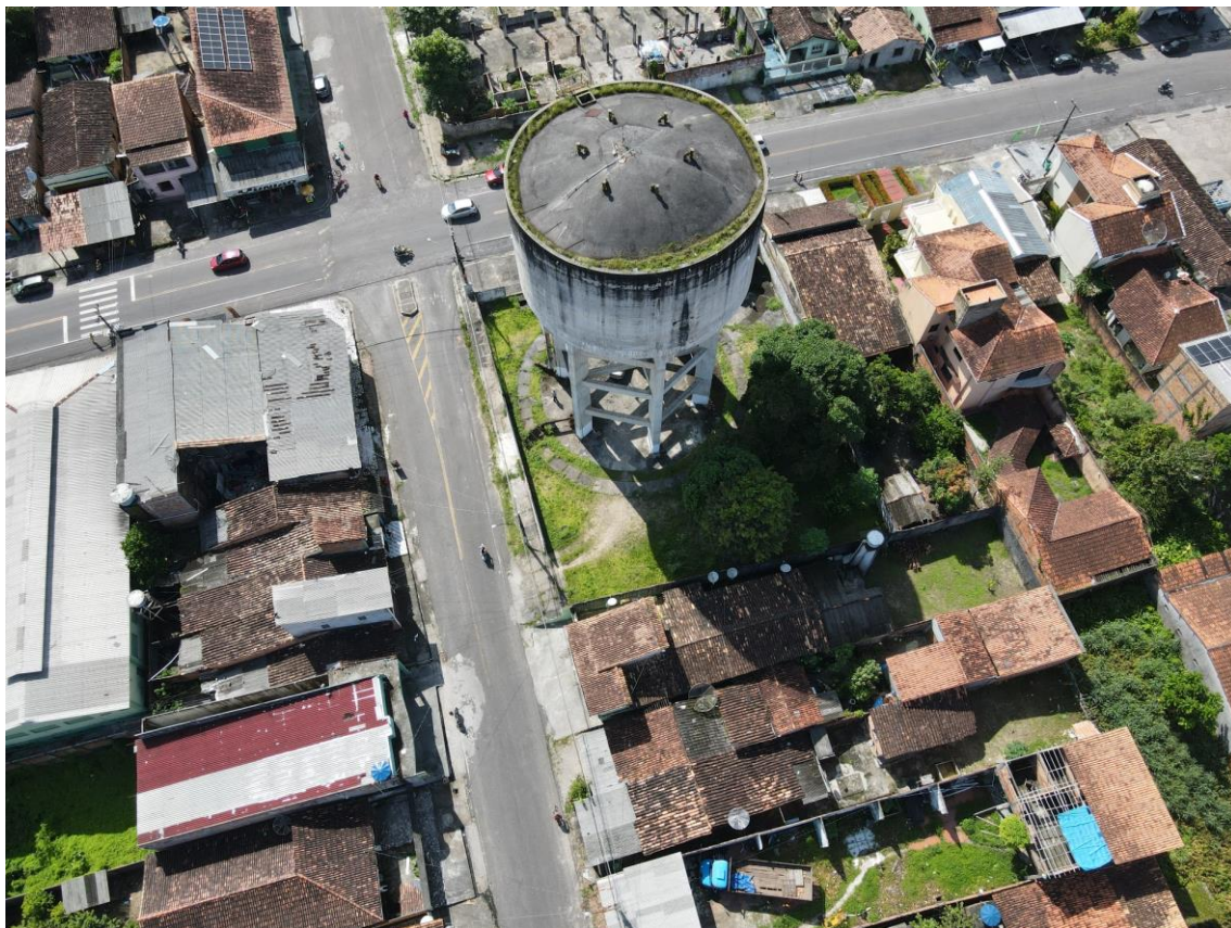
Figura 14. BRA03-REL, (reservatório elevado).
