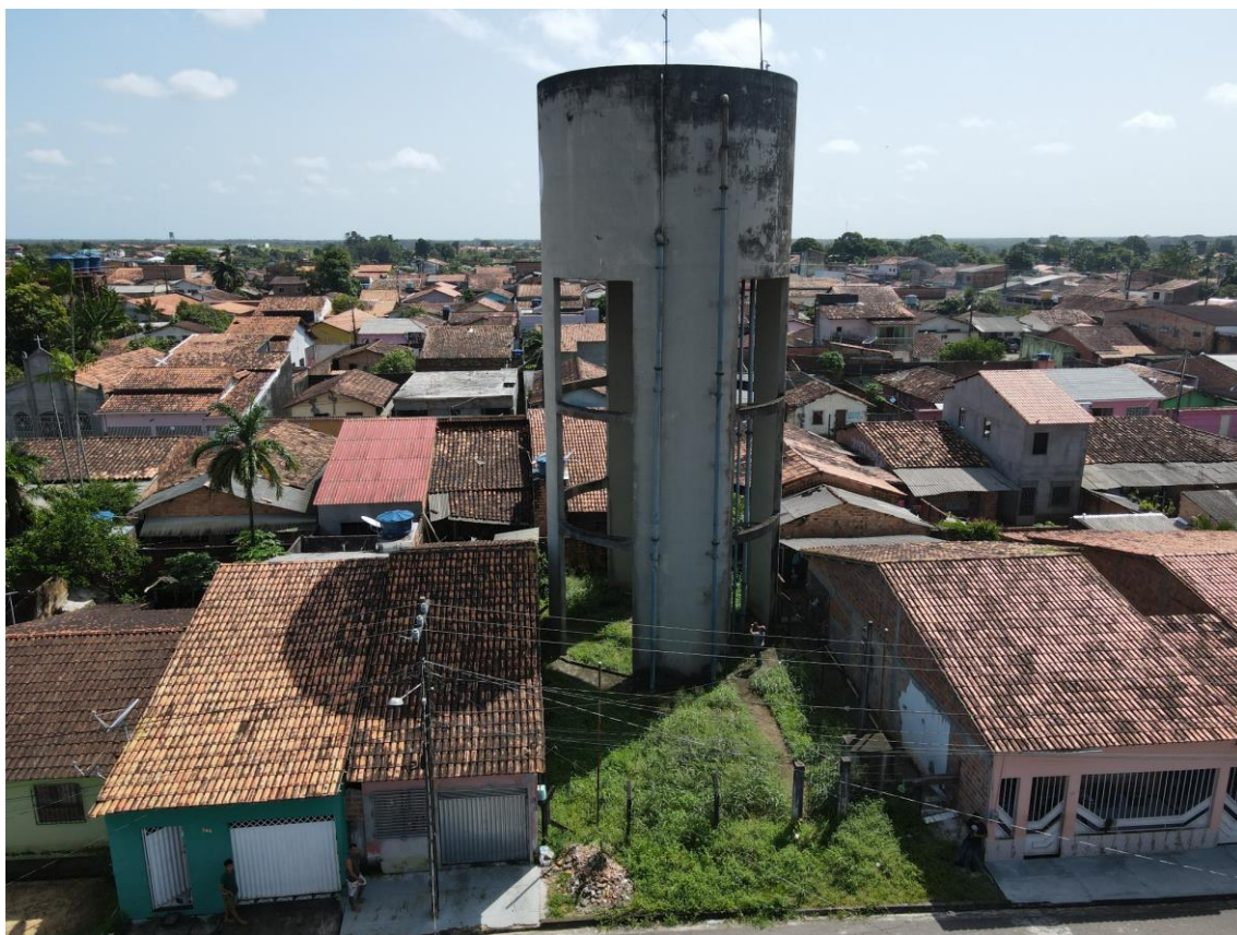
Figura 17. BRA08-REL, (reservatório elevado).
