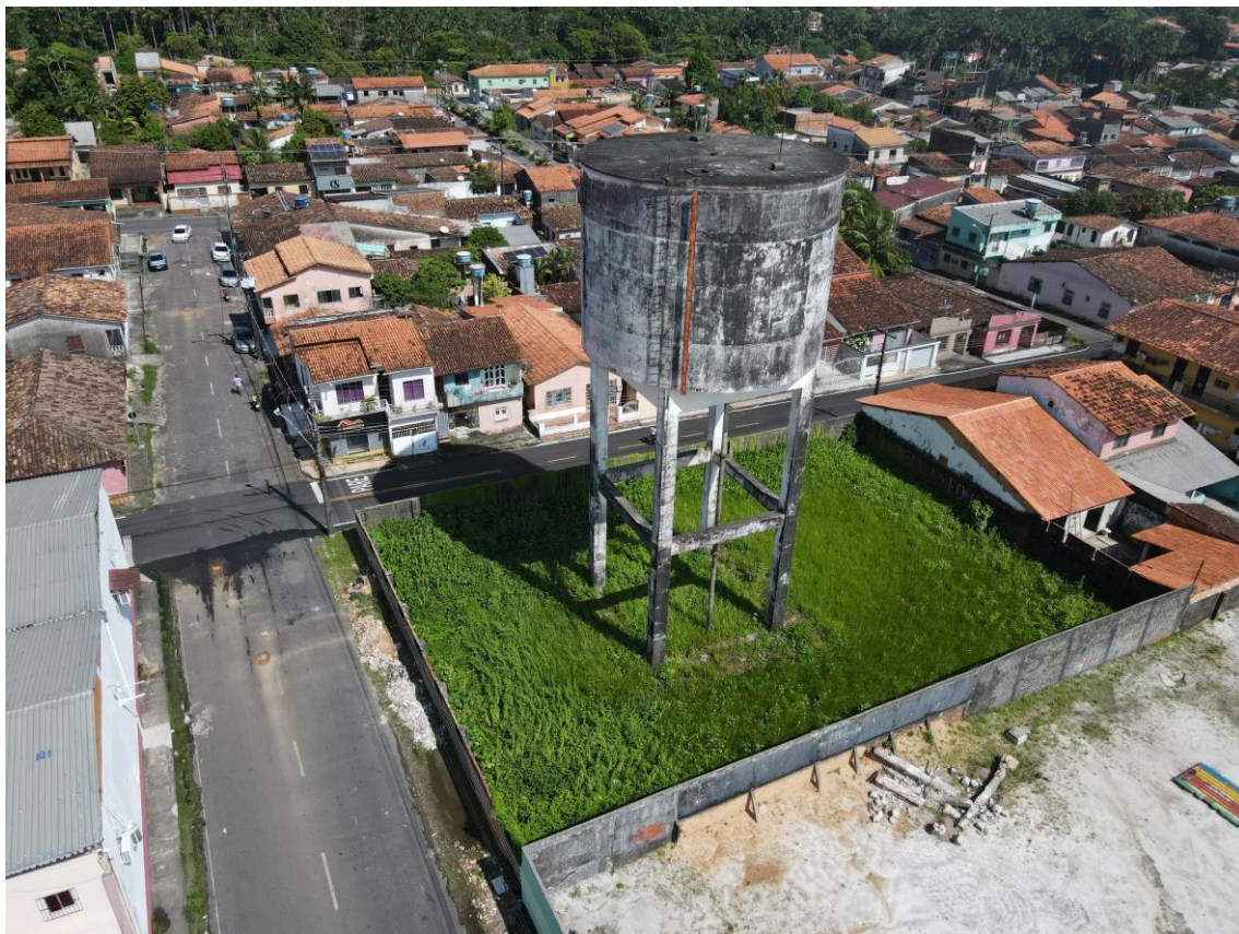
Figura 15. BRA04-REL (reservatório elevado).
