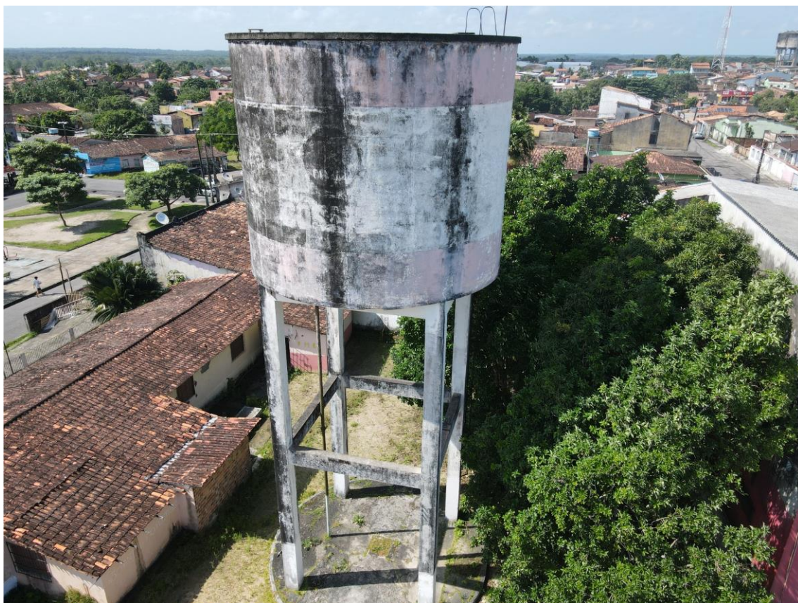
Figura 16. BRA05-REL, (reservatório elevado).
