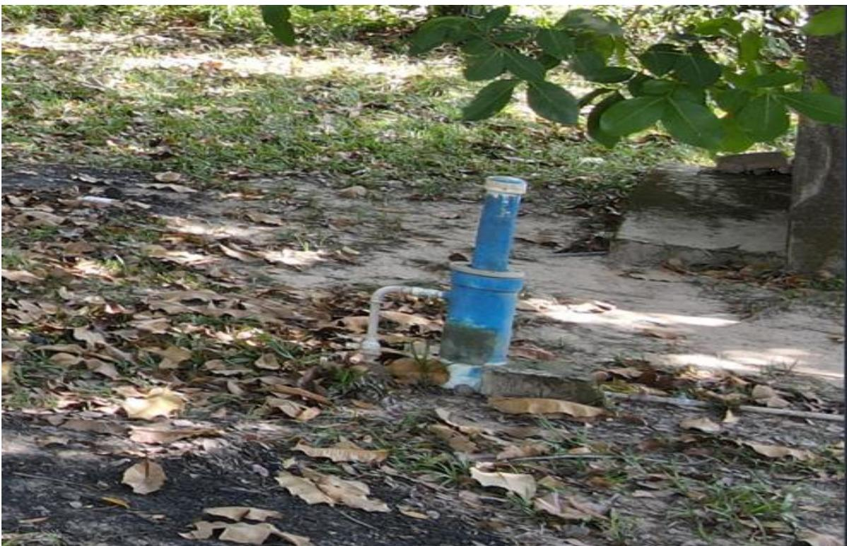
*Figura 34. Unidade de Tratamento (Injeção de Cloro) de CAM14.*
