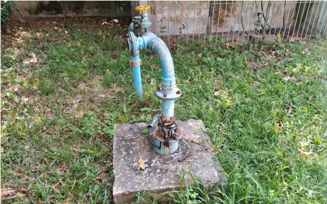
*Figura 26. Captação Tubular de CAM16.
