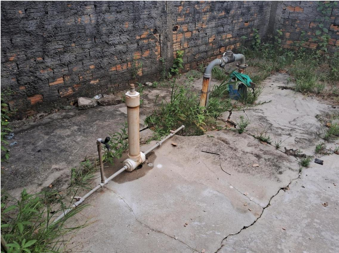
*Figura 30. Unidade de Tratamento (Injeção de Cloro) de CAM04.*
