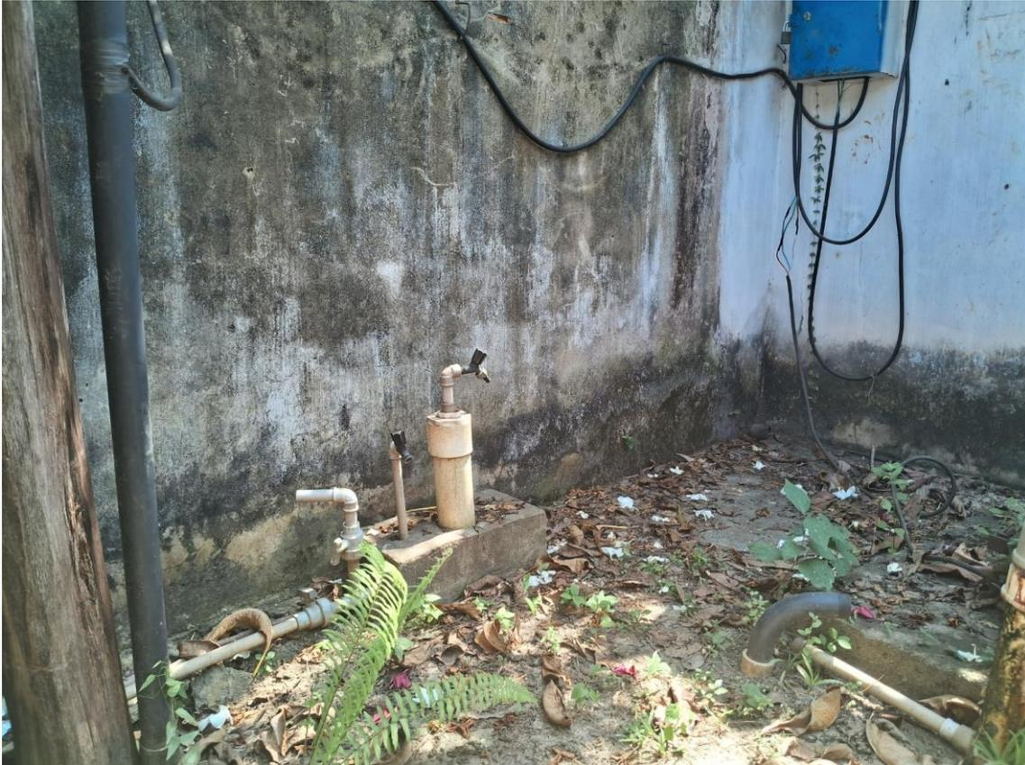
*Figura 35. Unidade de Tratamento (Injeção de Cloro) de CAM17. – Inativo*
