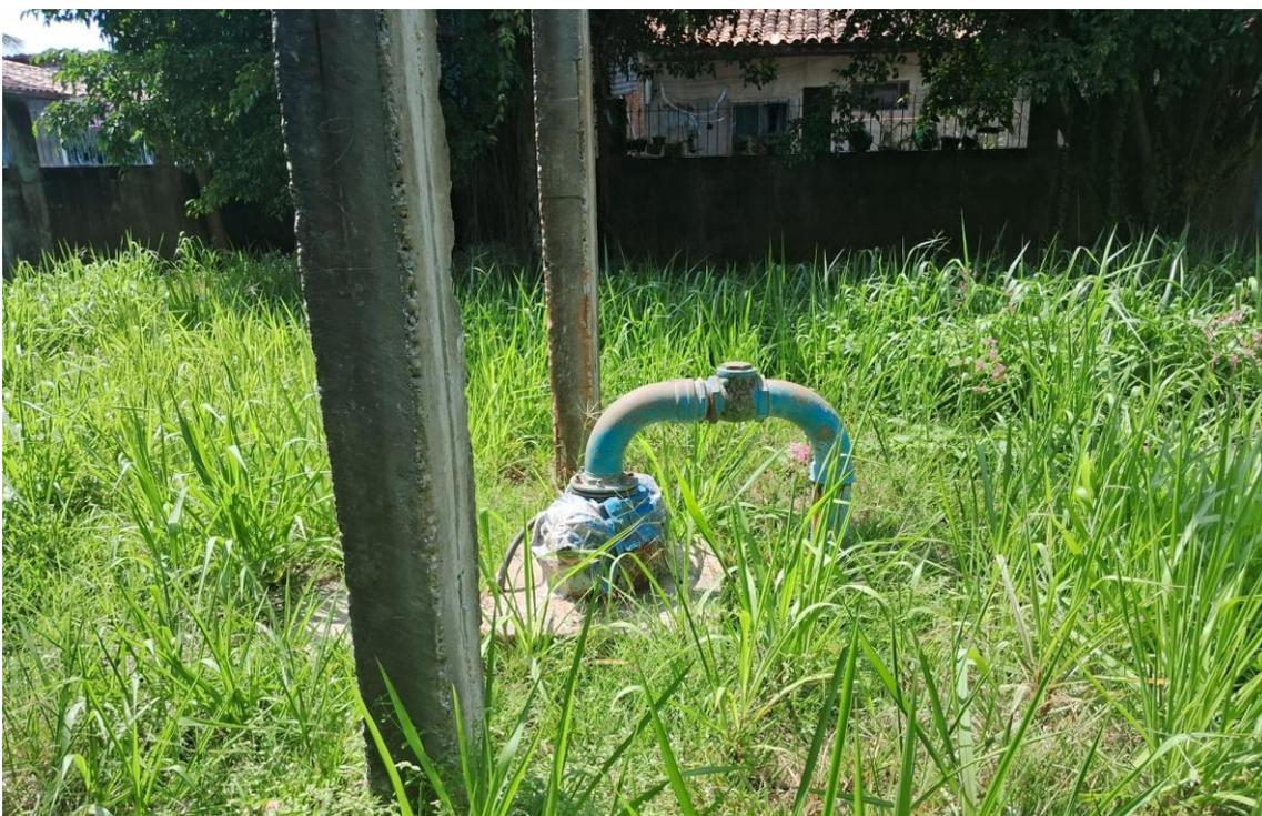
*Figura 27. Captação Tubular de CAM16.
