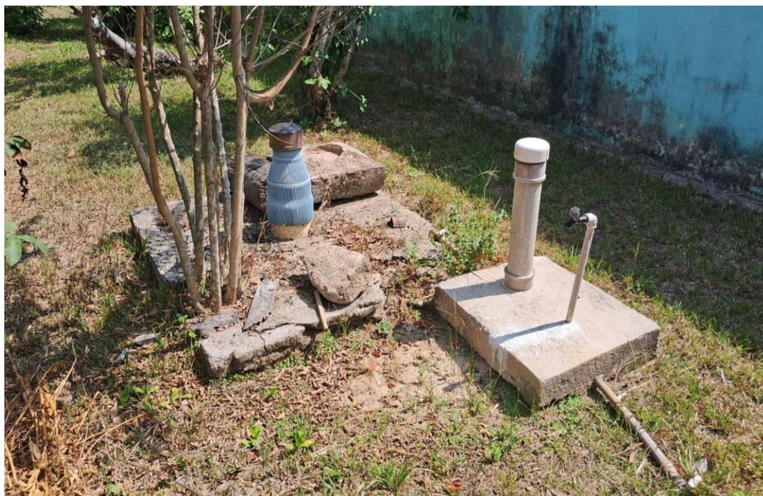
*Figura 25. Captação Tubular de CAM15. – Inativo.*
