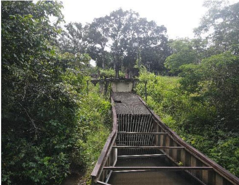
*Figura 5. CPN05-CAPTAÇÃO, (Tomada de água superficial com gradeamento).*
