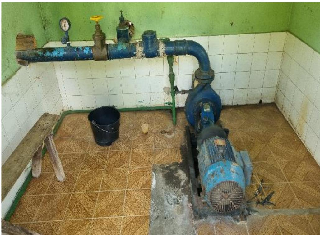
*Figura 10. CPN04-CAPTAÇÃO, Poço tubular.*
