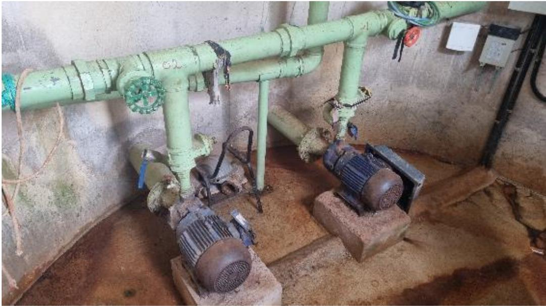
Figura 17. CPN07-EEAB (elevatória e captação de água bruta).
