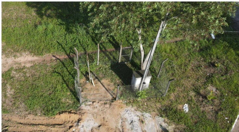
Figura 9. Captação - CAP07, poço tubular (panorâmica).
