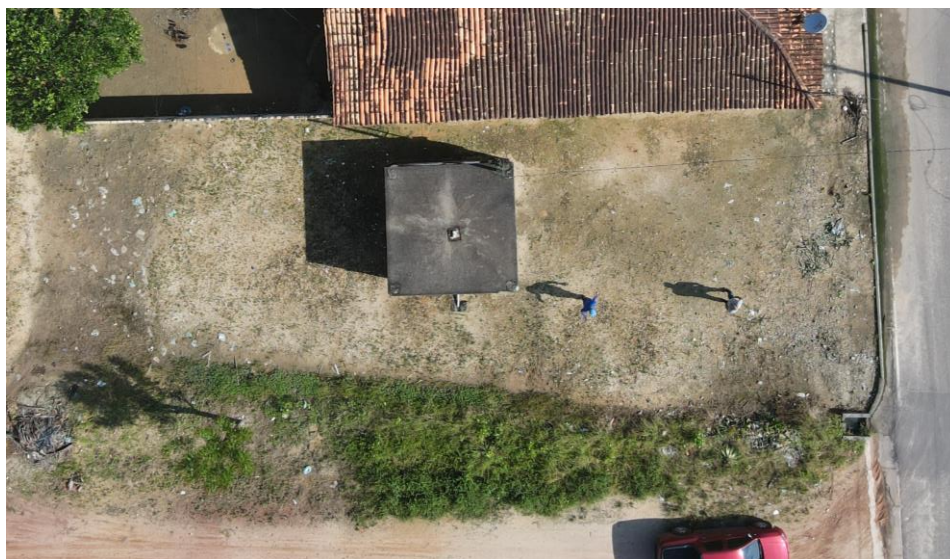
Figura 19. Captação – CAP12, poço tubular (panorâmica).
