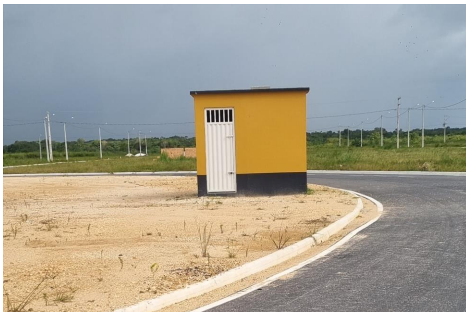
Figura 15. Captação - CAP09, poço tubular (aproximada).
