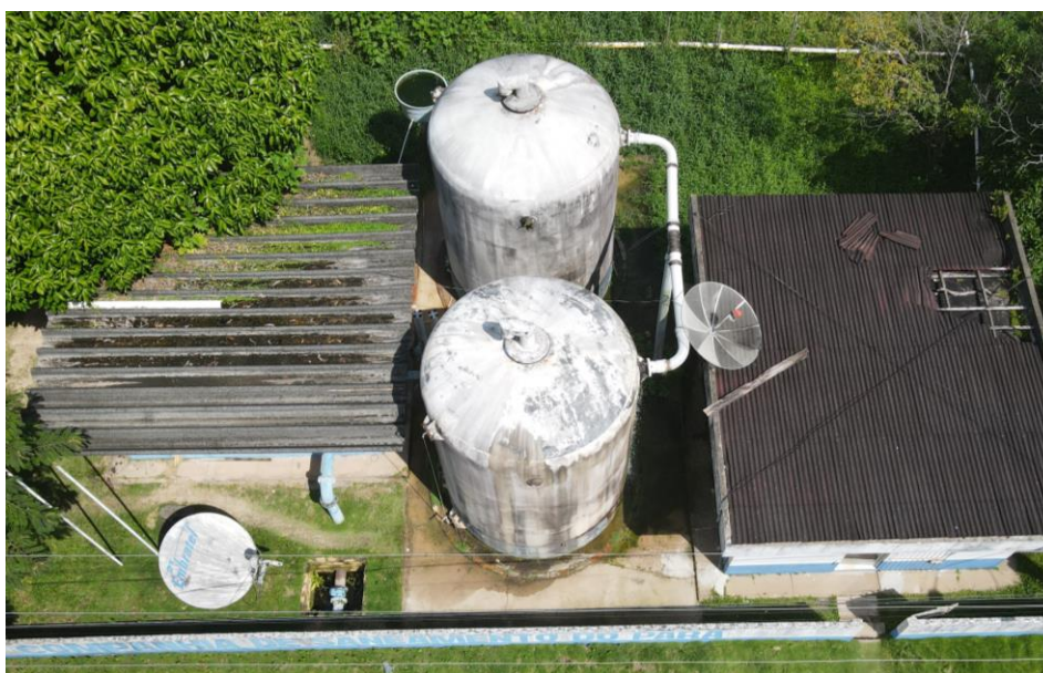
Figura 29. RAP-01, estrutura (panorâmica).
