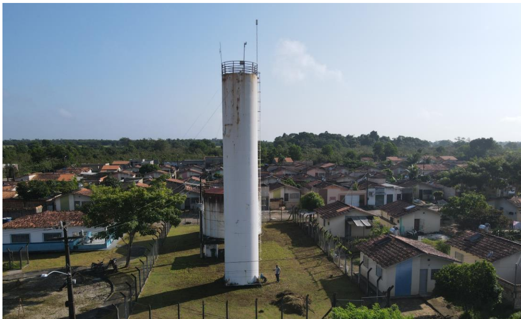
Figura 35. REL-04, estrutura (panorâmica).
