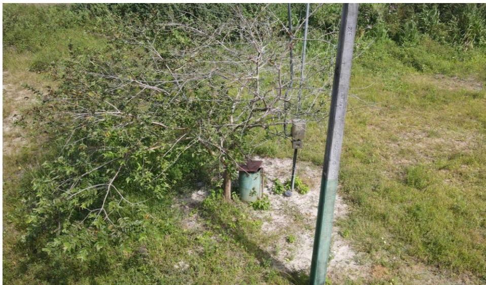
Figura 23. Captação – CAP14, poço tubular (panorâmica).
