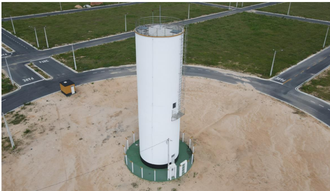
Figura 39. REL-09, estrutura (panorâmica).
