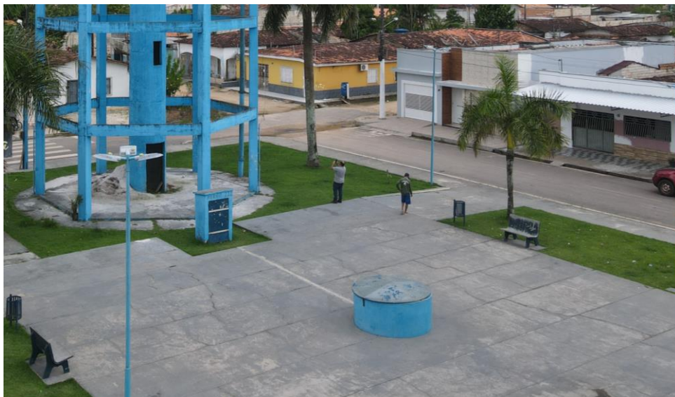
Figura 7. Captação - CAP03, poço tubular (panorâmica).
