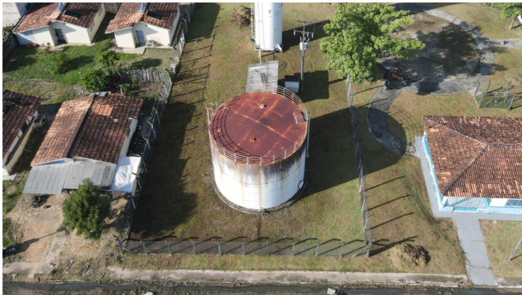
Figura 33. RAP-04, estrutura (panorâmica).
