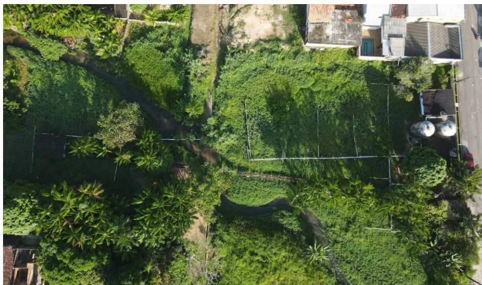
Figura 3. Captação - CAP01, poços a vácuo (panorâmica).
