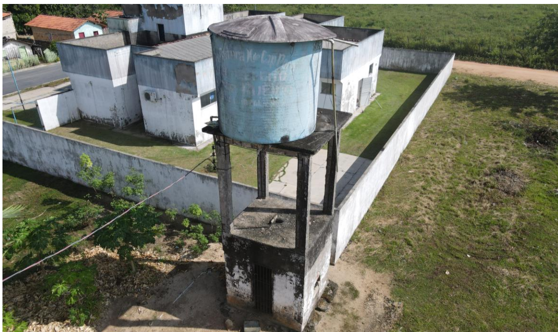
Figura 41. REL-13, estrutura (panorâmica).
