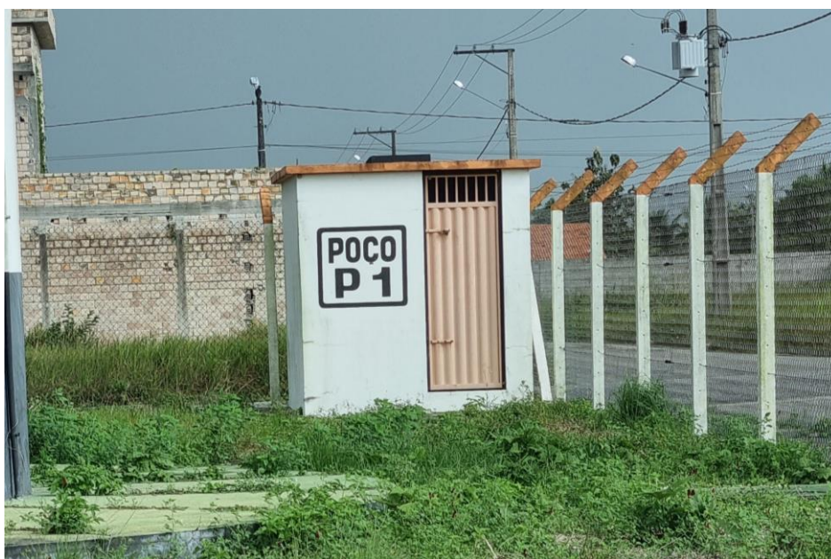
Figura 12. Captação - CAP08, poço tubular P01 (aproximada).
