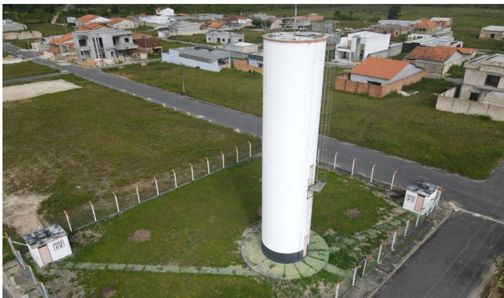
Figura 37. REL-08, estrutura (panorâmica).
