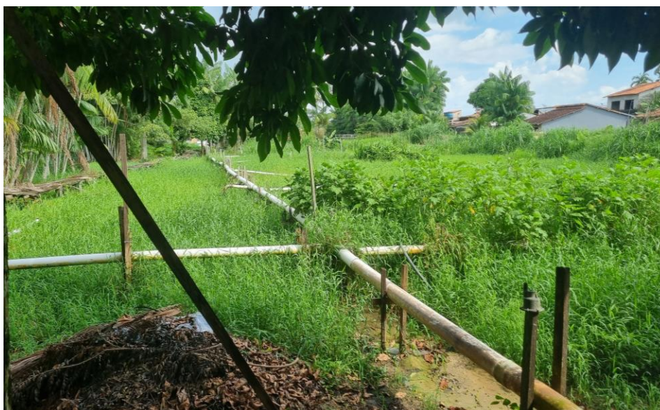
Figura 4. Captação - CAP01, poços a vácuo (aproximada).
