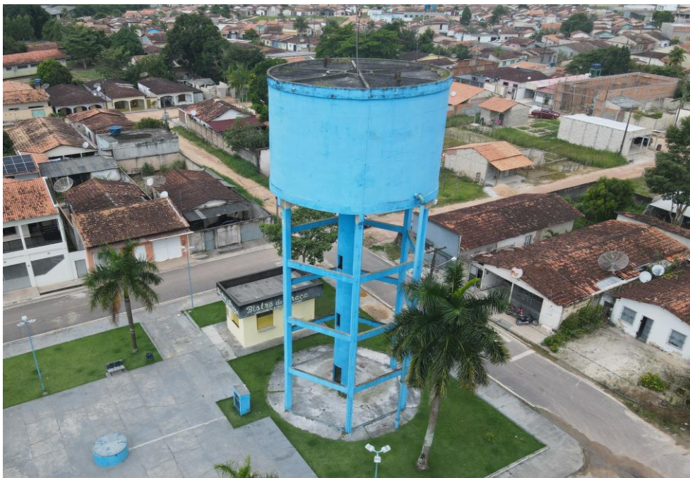
Figura 31. REL-03, estrutura (panorâmica).
