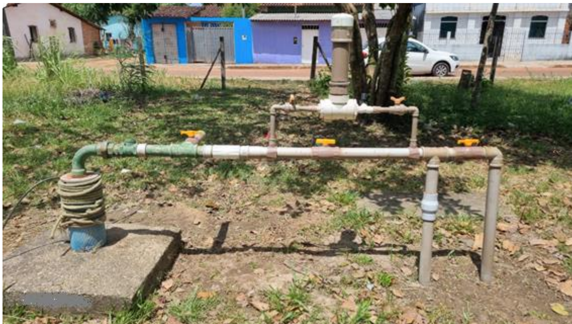
Figura 3. CRC01-CAPTAÇÃO, subterrâneo (poço tubular). Fonte: Consórcio, 2023.
