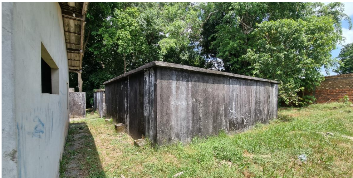
Figura 17. CRC02-RAP01, (reservatório apoiado).
