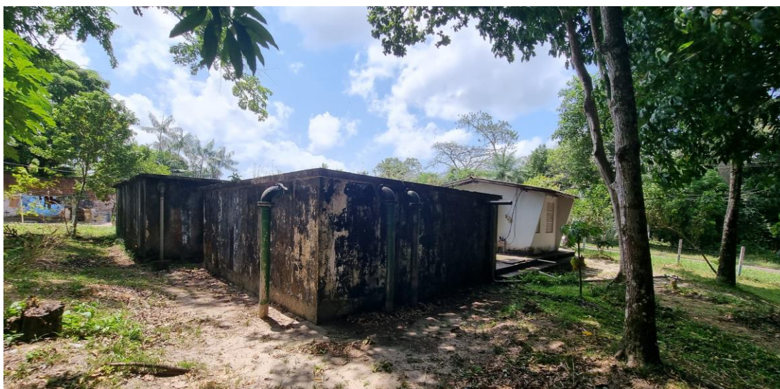
Figura 18. CRC02-RAP02, reservatório apoiado).
