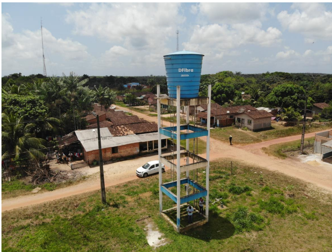
Figura 19. CRC07-REL, (reservatório elevado).
