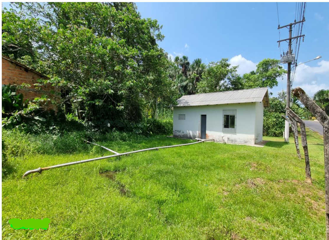
Figura 15. IGA09-CAPTAÇÃO, subterrâneo (sistema a vácuo - panorâmica).
