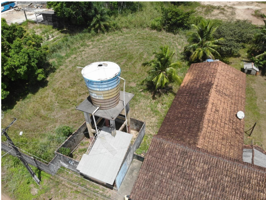
Figura 24. IGA04-REL, (reservatório elevado).
