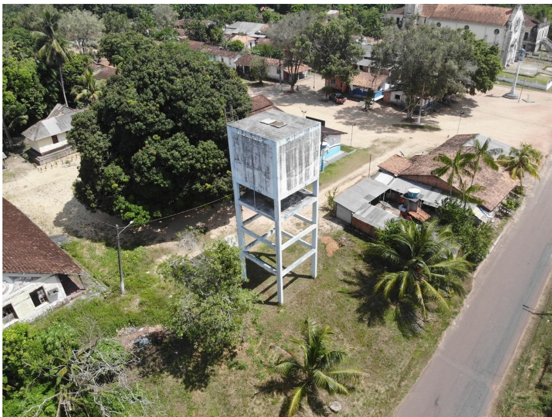
Figura 27. IGA10-REL, (reservatório elevado).
