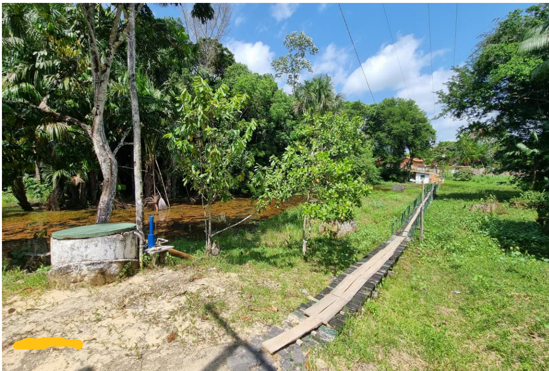
Figura 4. IGA01-CAPTAÇÃO001, subterrâneo (sistema a vácuo - panorâmico).
