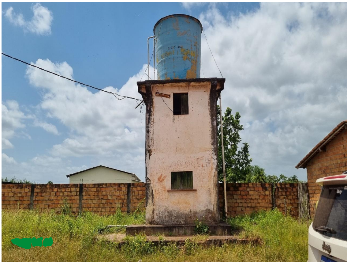
Figura 25. IGA06-REL, (reservatório elevado).
