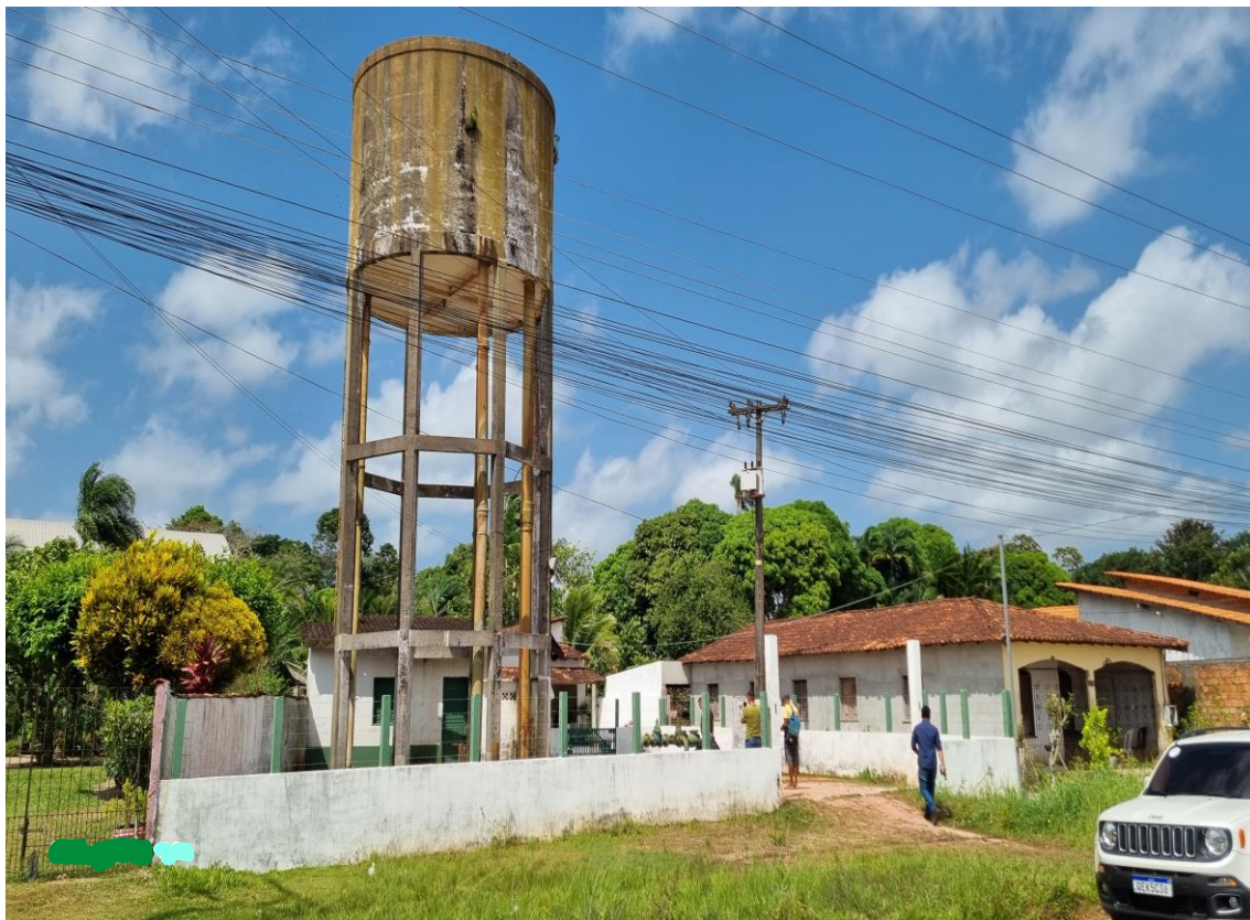
Figura 22. IGA02-REL, (reservatório elevado).
