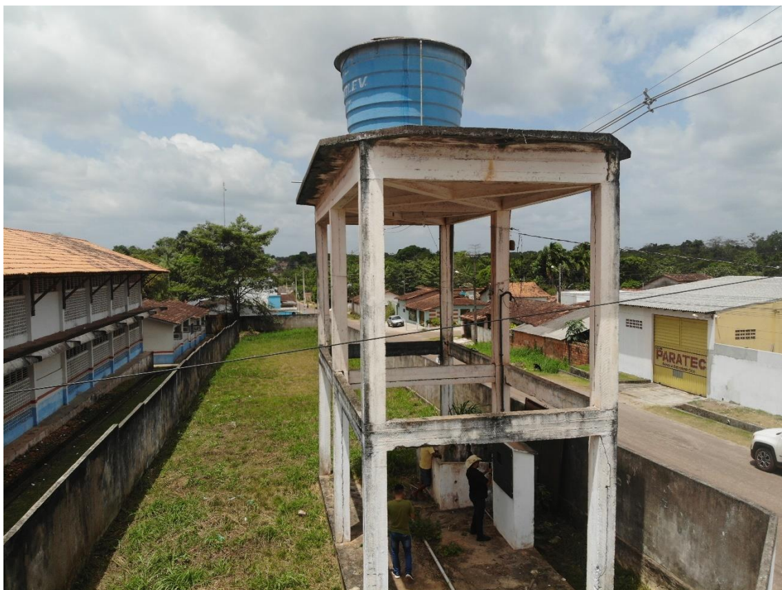
Figura 26. IGA07-REL, (reservatório elevado).
