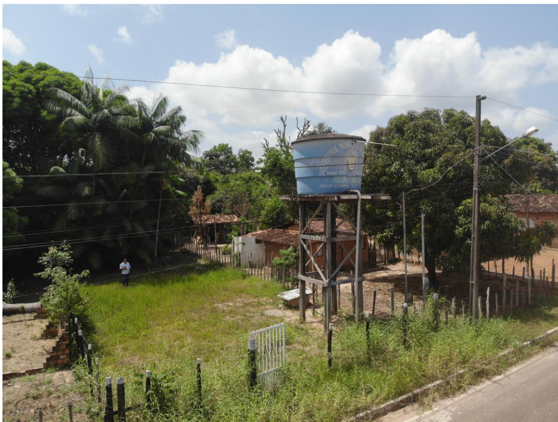
Figura 23. IGA03-REL, (reservatório elevado).
