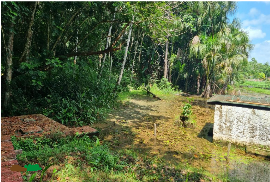
Figura 6. IGA01-CAPTAÇÃO002, superficial (tomada de água- panorâmica).
