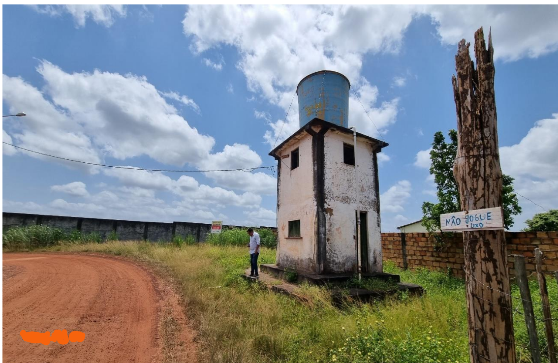
Figura 11. IGA06-CAPTAÇÃO, subterrâneo (poço tubular).
