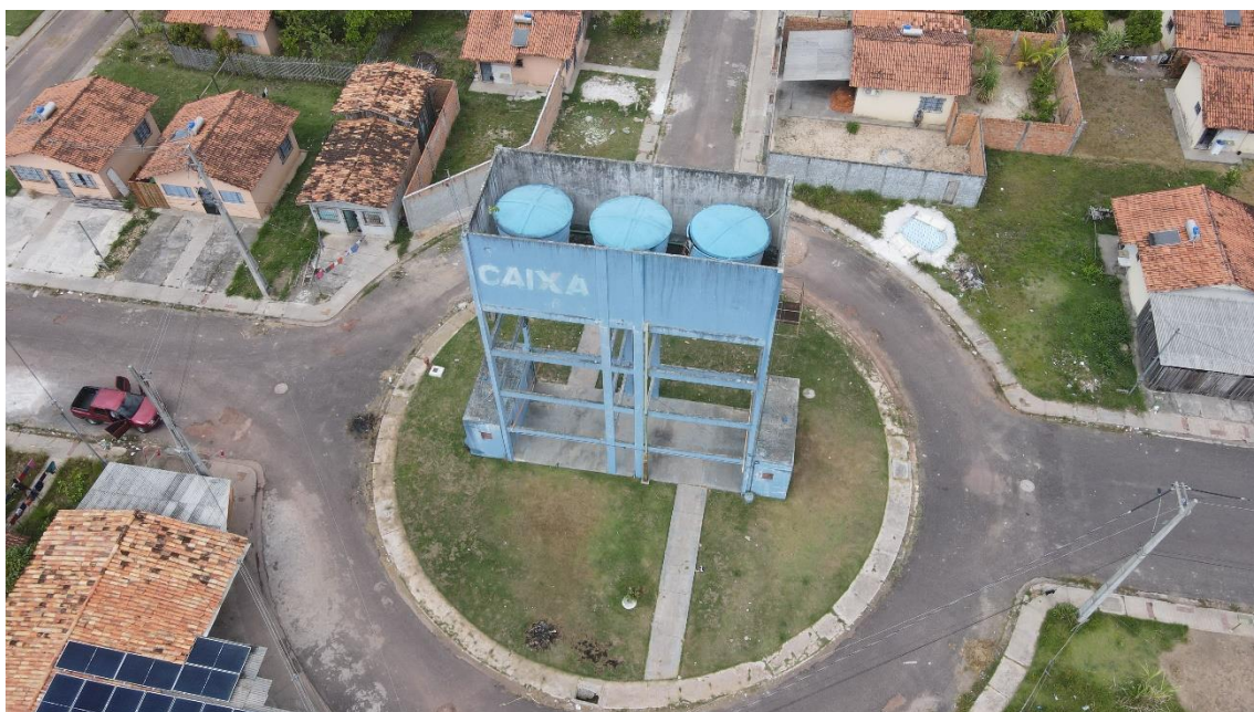
Figura 14. IGA06-REL, reservatório elevado, operado pela prefeitura e responsável pelo abastecimento do Conj. Ticiania Miranda.
