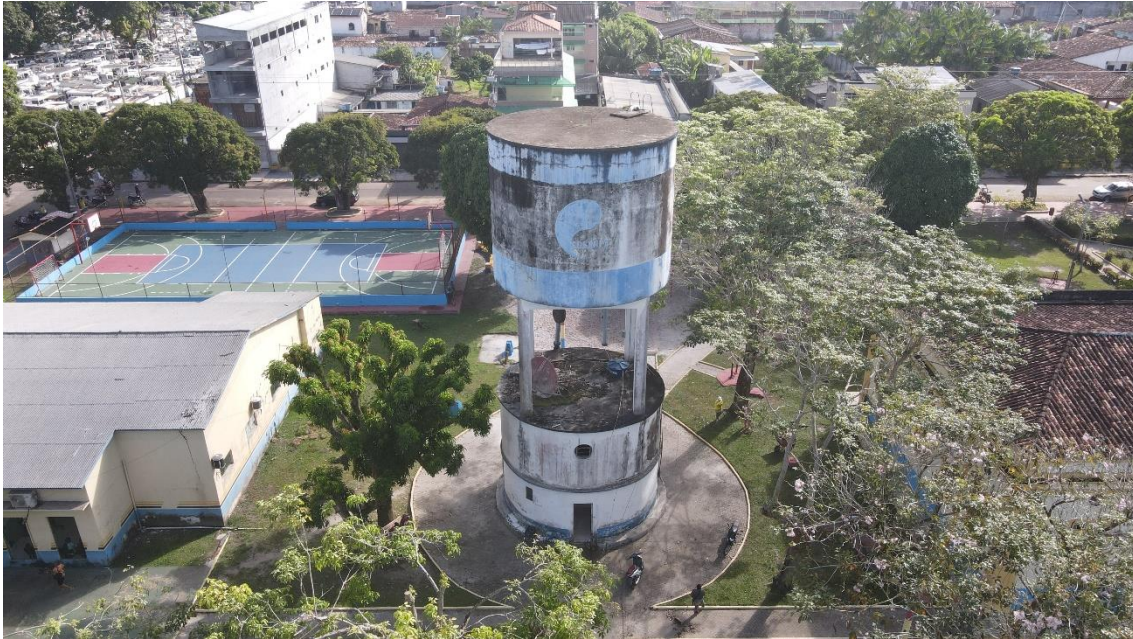
Figura 15. IGA07-REL, reservatório elevado (desativado), localizado Rua Lauro Sodré. Fonte: Consórcio, 2023.
