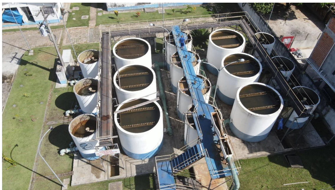
Figura 7. IGA02-ETA (Estação de Tratamento de Água).
