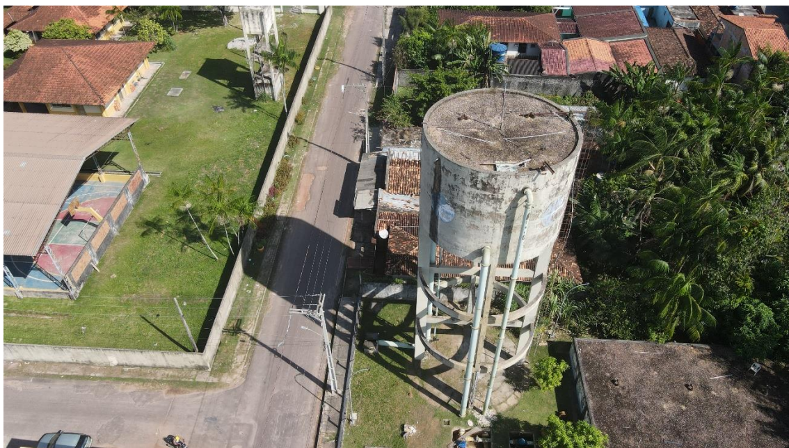
Figura 11. IGA02-REL, reservatório elevado, localizado no terreno da ETA (IGA02-ETA). Fonte: Consórcio, 2023.
