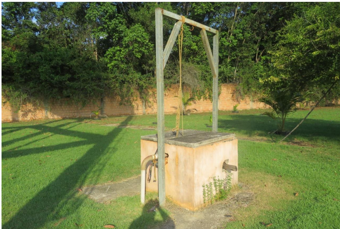
Figura 5. Captação-MOJ07, Poço tubular. Fonte: Consórcio, 2023.
