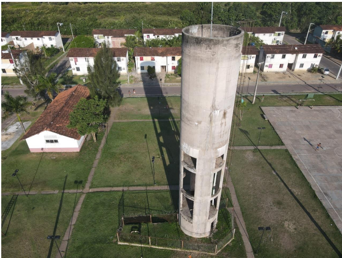
Figura 17. REL- MOJ06, Estrutura.
