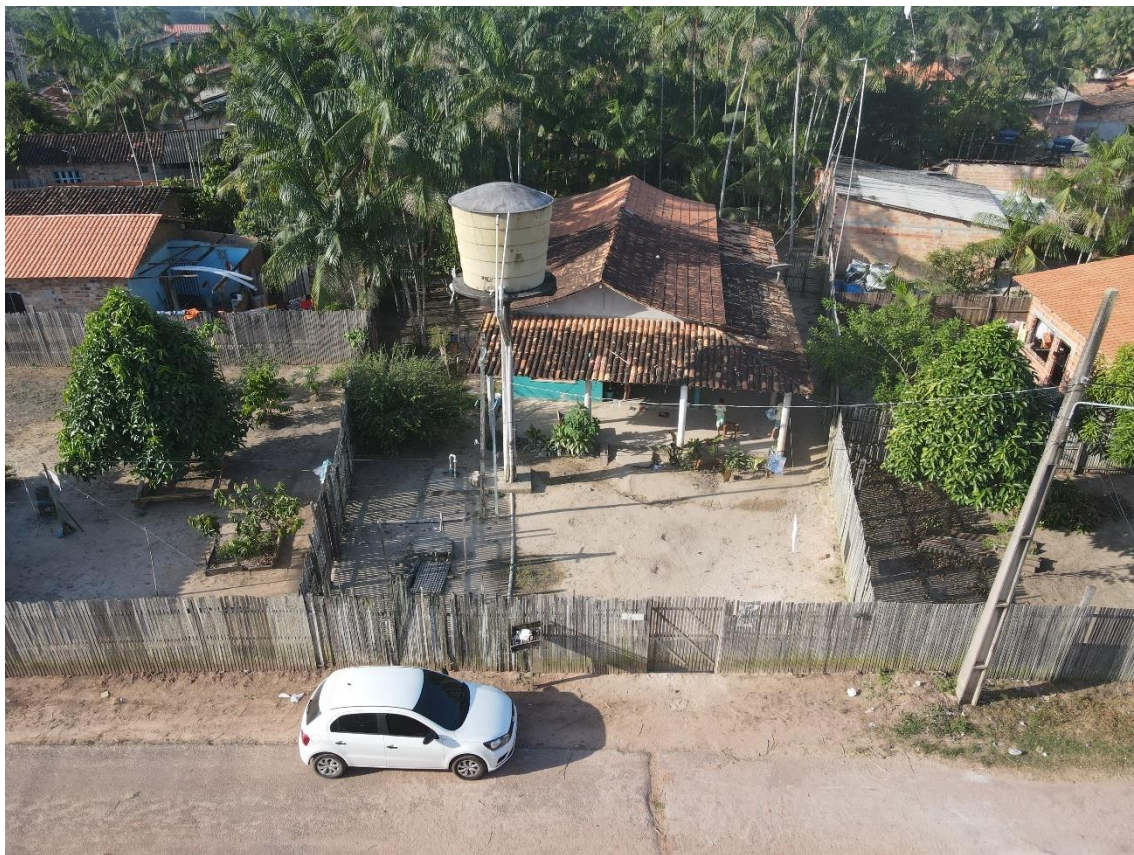
Figura 19. REL – MOJ10, Estrutura.
