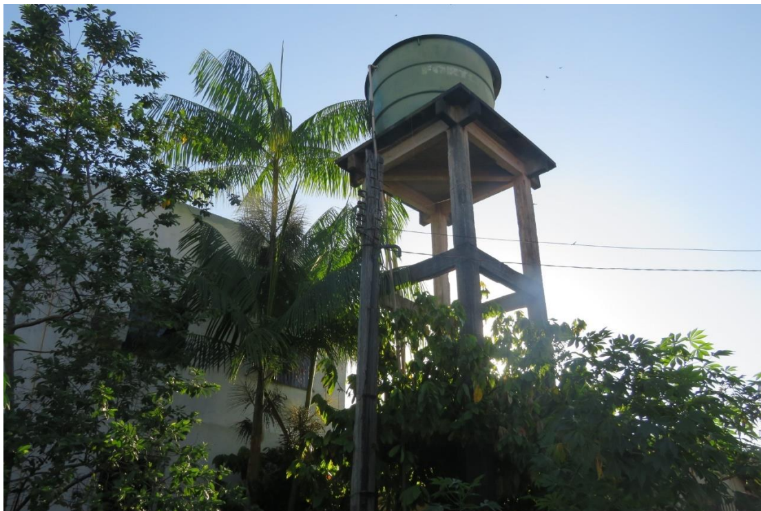
Figura 20. REL – MOJ13, Estrutura.
