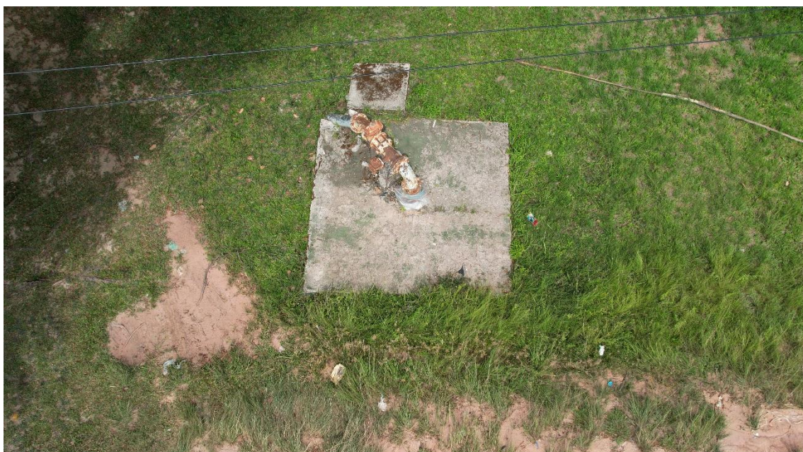
Figura 4. SAL01-CAPTAÇÃO002, poço tubular. Fonte: Consórcio, 2023.
