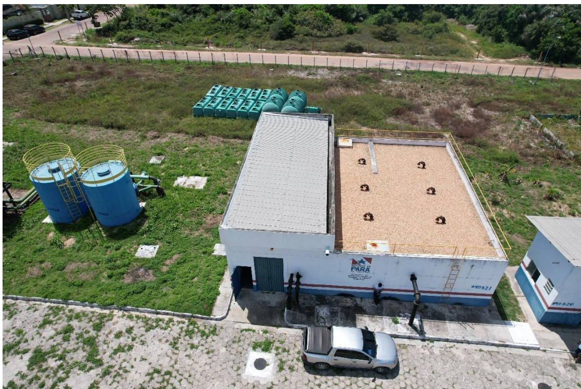
Figura 59. SAL17-RAP (reservatório apoiado).
