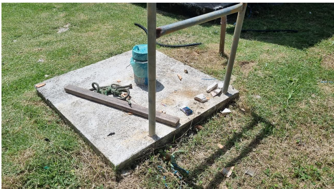
Figura 30. SAL19-CAPTAÇÃO002, poço tubular. Fonte: Consórcio, 2023.
