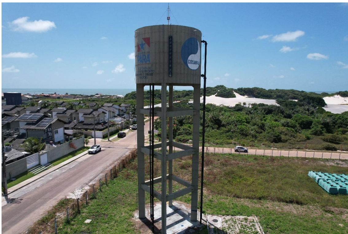
Figura 60. SAL17-REL (reservatório elevado).
