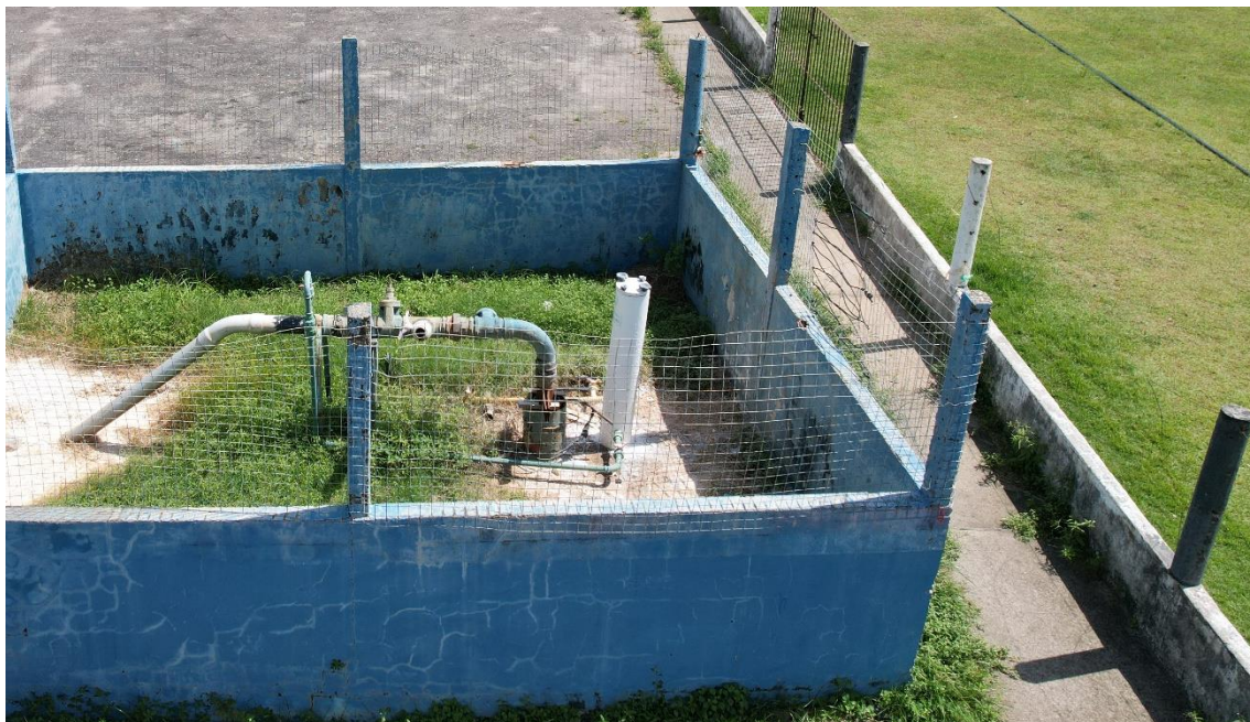
Figura 40. SAL12-TRATAMENTO02, Tratamento de desinfecção (cloro pastilha).
