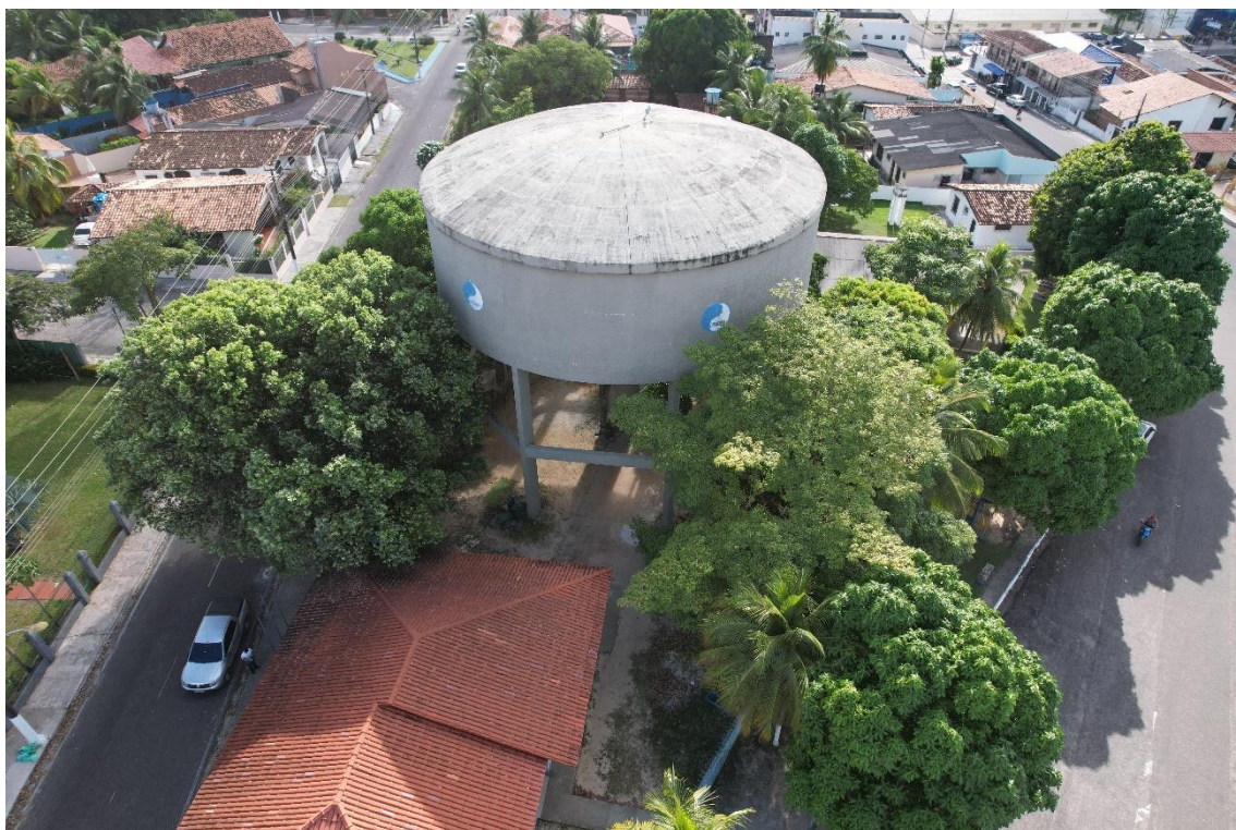
Figura 56. SAL10-REL (reservatório elevado).
