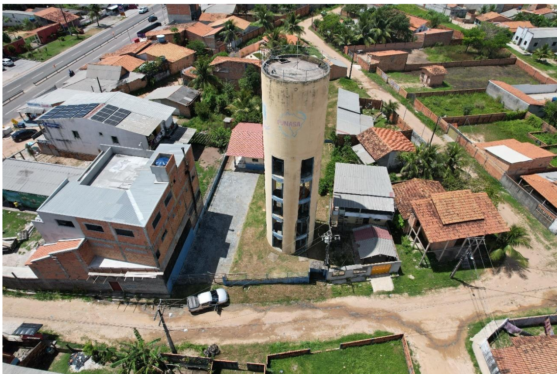
Figura 61. SAL19-REL (reservatório elevado).
