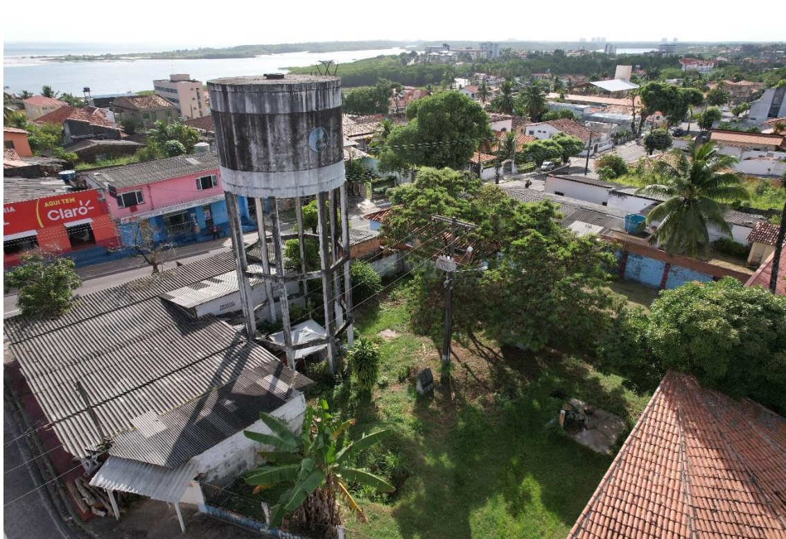
Figura 55. SAL09-REL (reservatório elevado).
