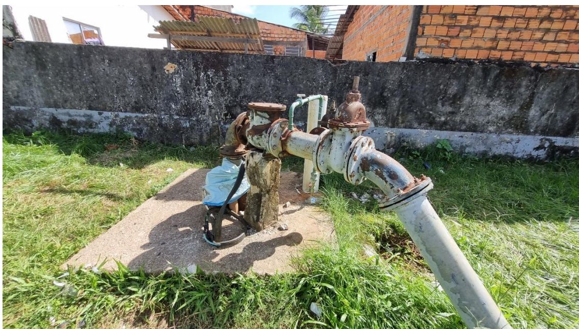
Figura 41. SAL16-TRATAMENTO, Tratamento de desinfecção (cloro pastilha).
