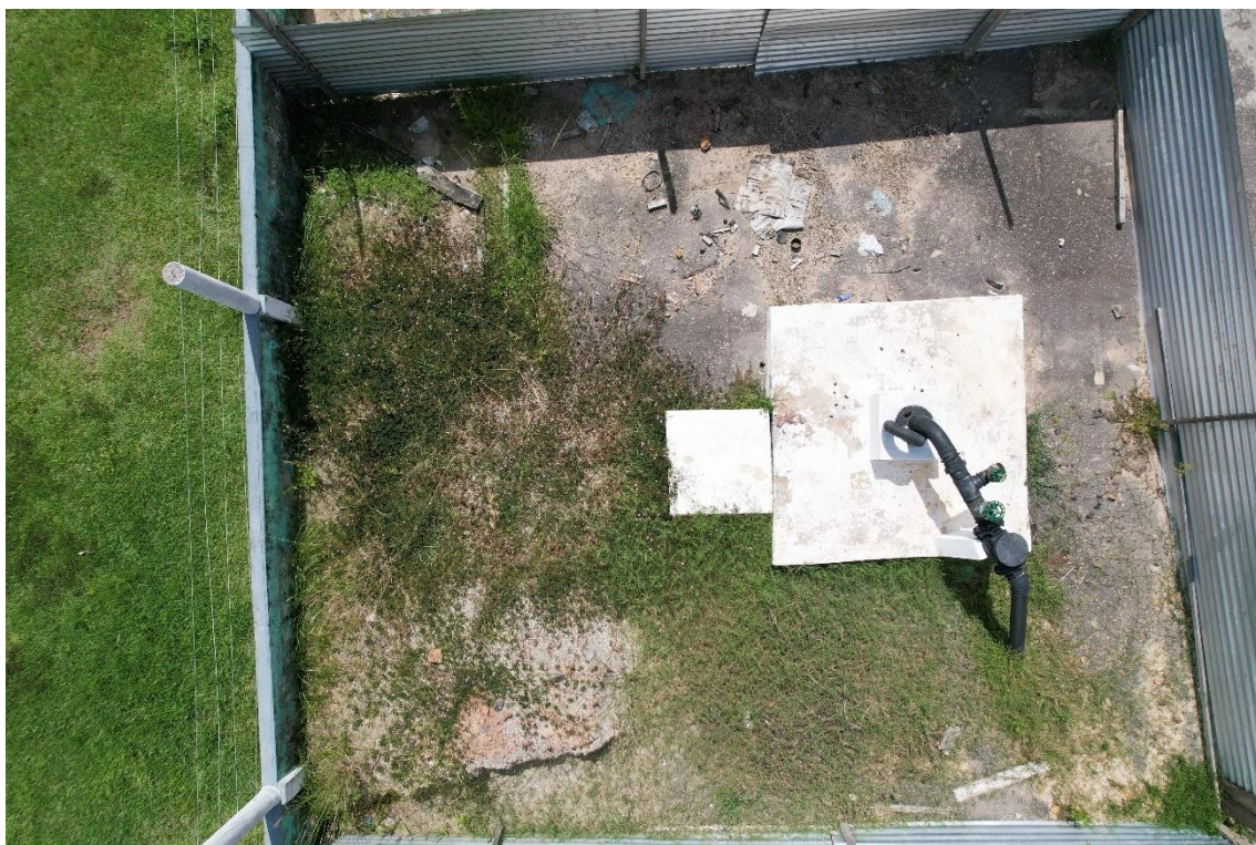
Figura 28. SAL018-CAPTAÇÃO, poço tubular.
