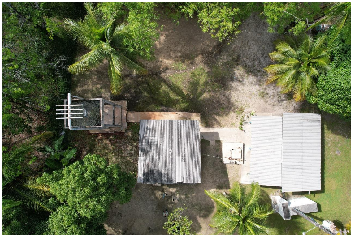
Figura 52. SAL04-RAP (reservatório apoiado).
