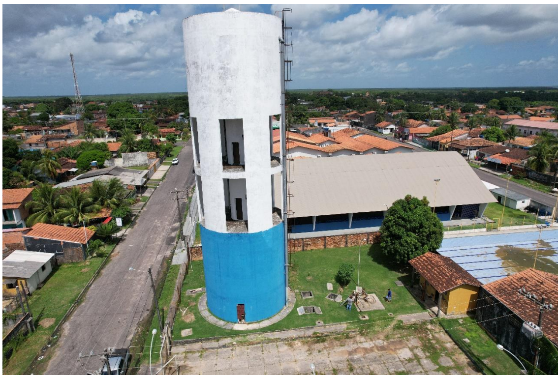
Figura 57. SAL11-REL (reservatório elevado).
