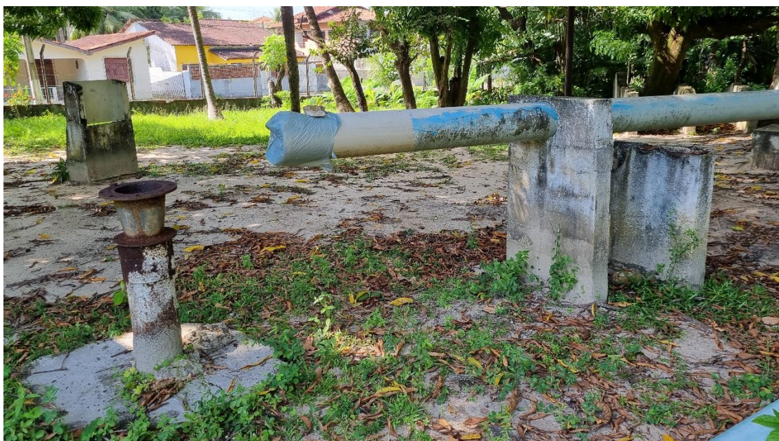
Figura 12. SAL05-CAPTAÇÃO002, poço tubular. Fonte: Consórcio, 2023.
