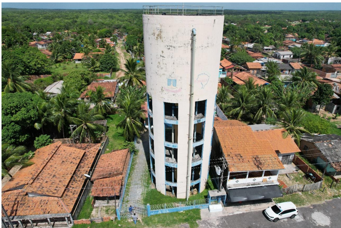
Figura 58. SAL12-REL (reservatório elevado).
