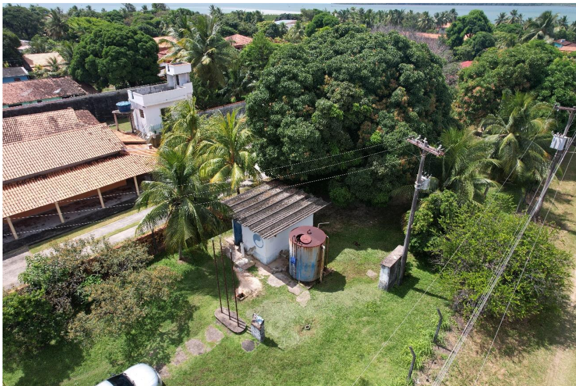
Figura 54. SAL08-RAP (reservatório apoiado).
