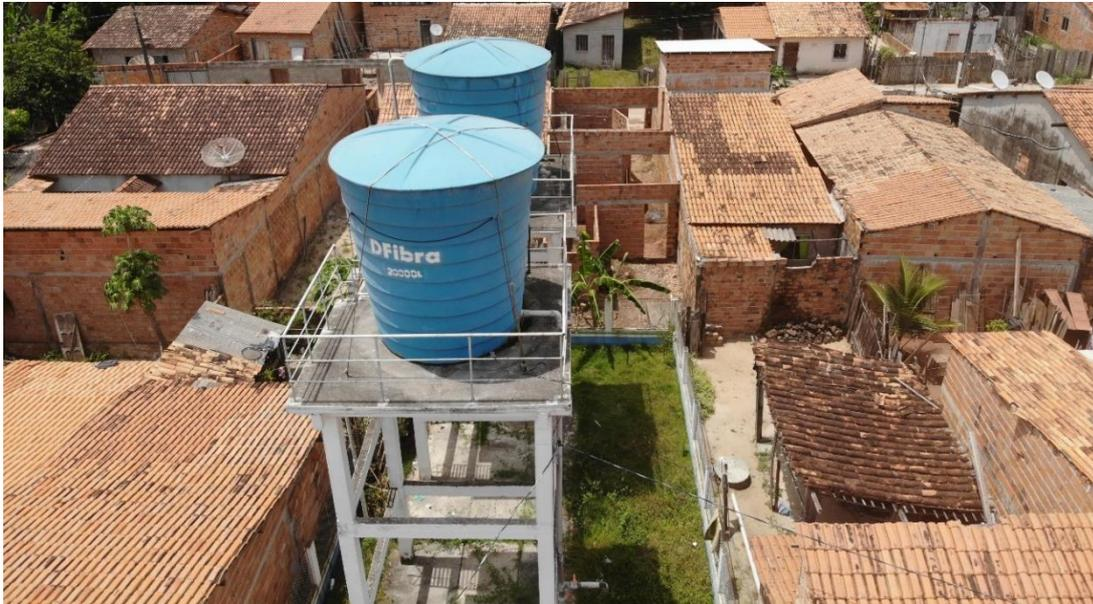
*Figura 54. SMG14-RELO1 e RELO2, em fibra e estrutura de concreto.*
