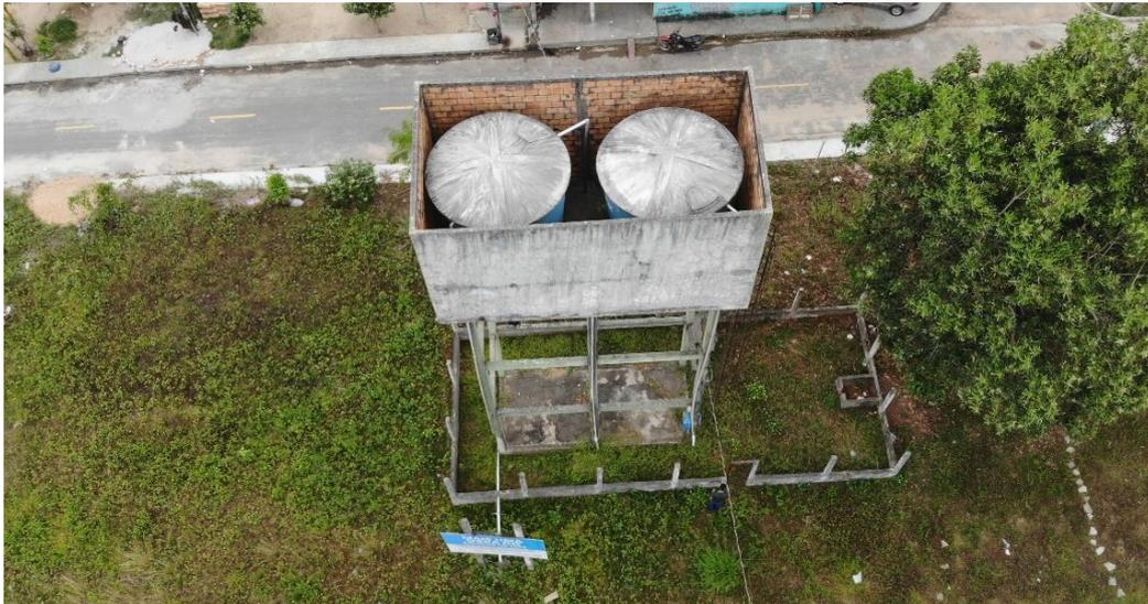
*Figura 37. SMG04-REL01 e REL02, em fibra estrutura de concreto.*
