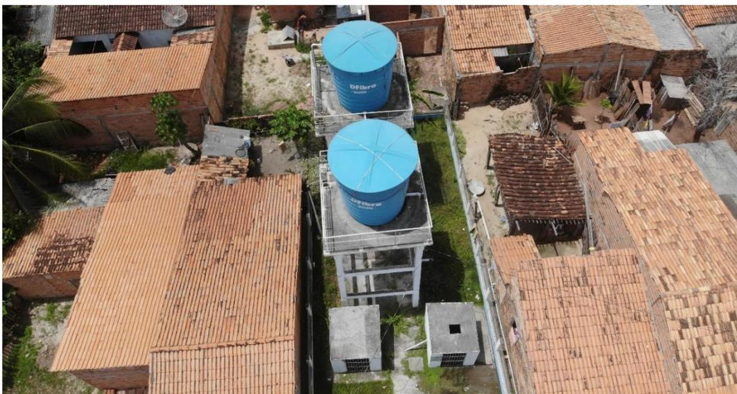
*Figura 53. SMG14-REL01 e REL02, em fibra e estrutura de concreto.*
