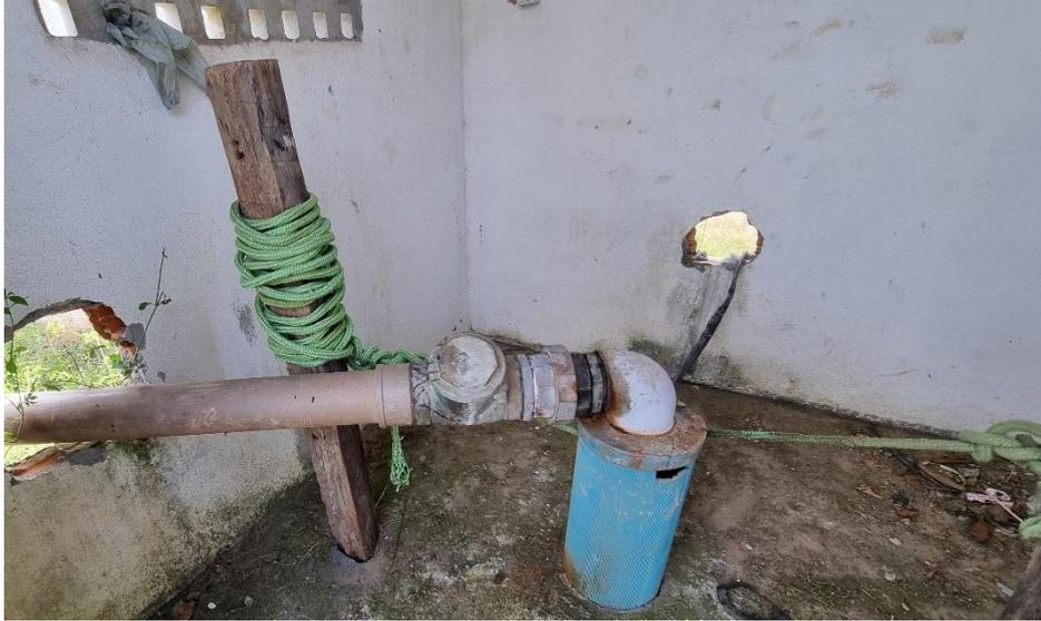
*Figura 18. SMG15-CAPTAÇÃO001 – Captação em Poço*
