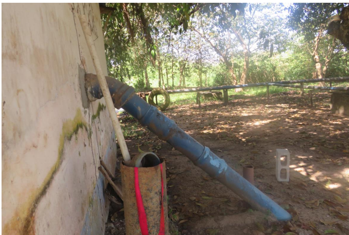
Figura 7. TAI01-CAPTAÇÃO002, sistema a vácuo (panorâmica).
