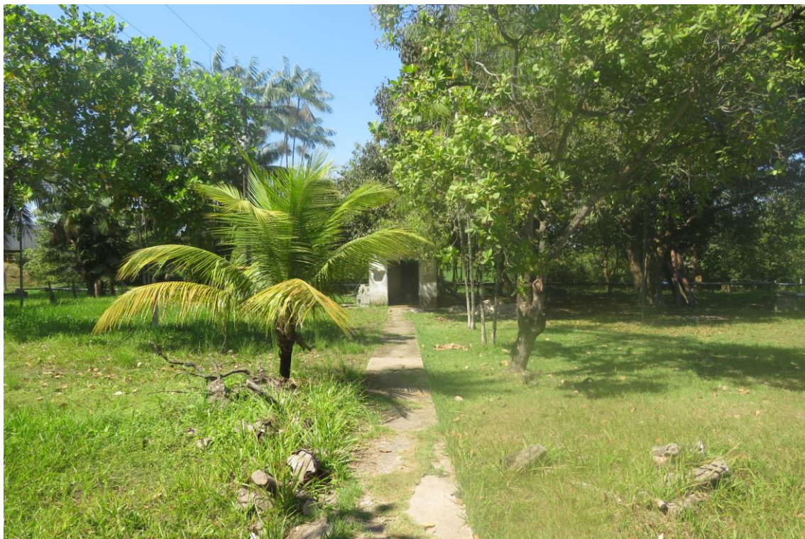
Figura 6. TAI01-CAPTAÇÃO002, sistema a vácuo (panorâmica).
