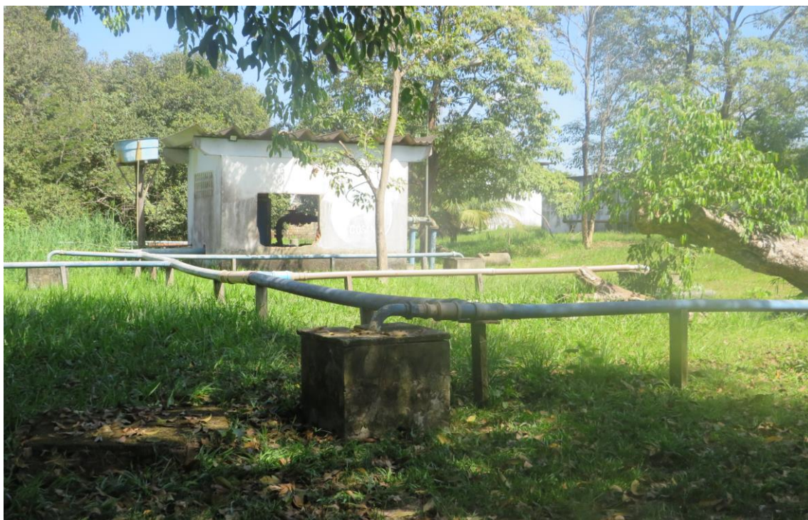
Figura 4. TAI01-CAPTAÇÃO001, sistema a vácuo (panorâmica).
