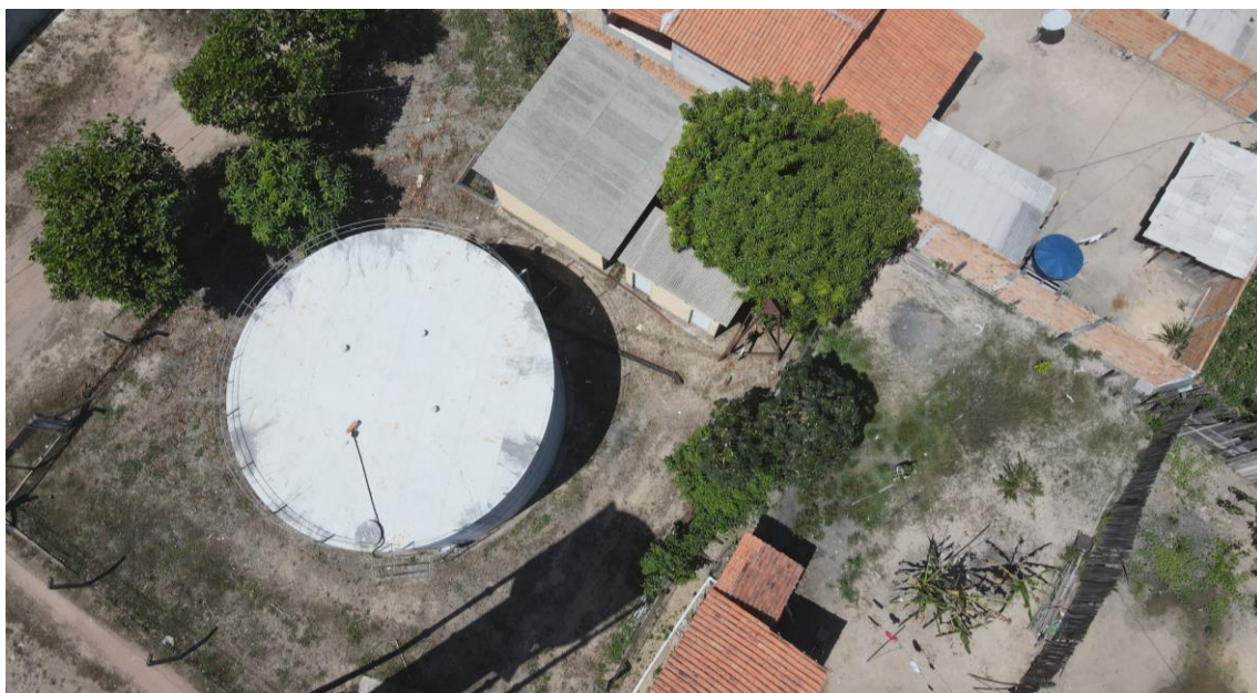
Figura 23. TAI05-RAP, (reservatório apoiado).
