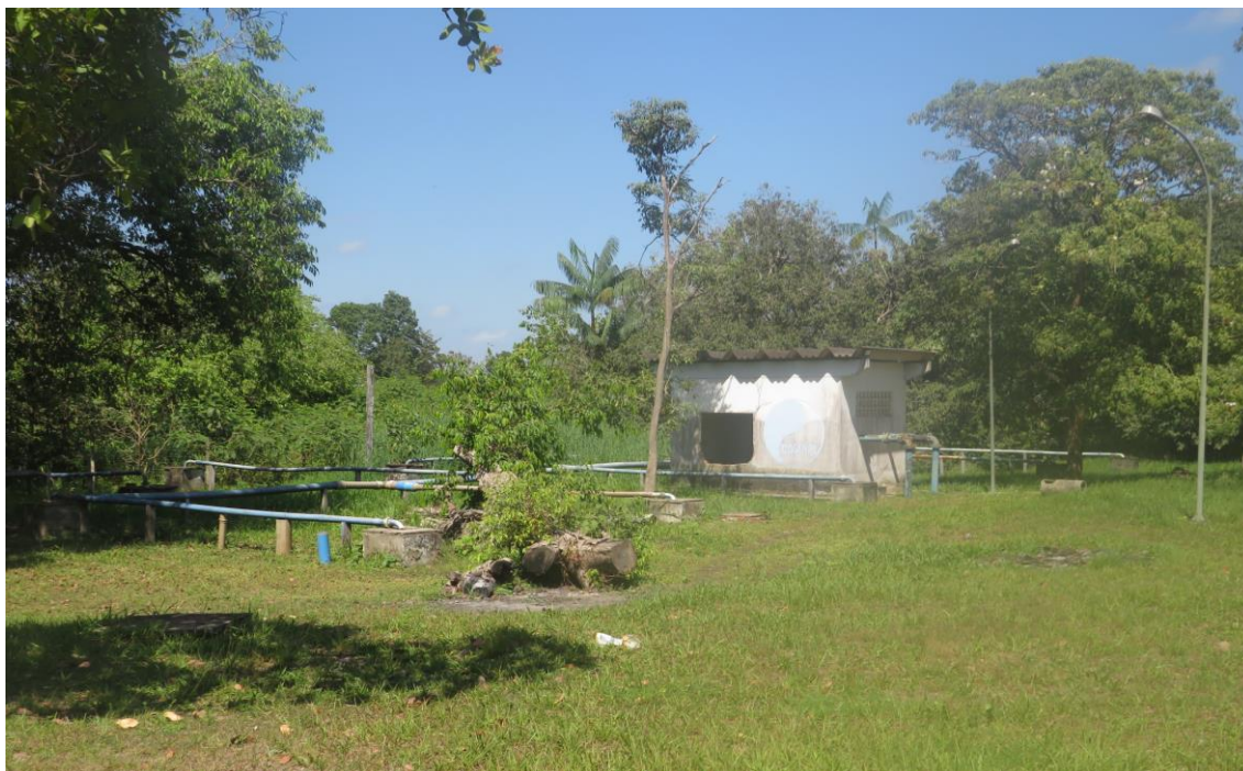
Figura 3. TAI01-CAPTAÇÃO001, sistema a vácuo (panorâmica).
