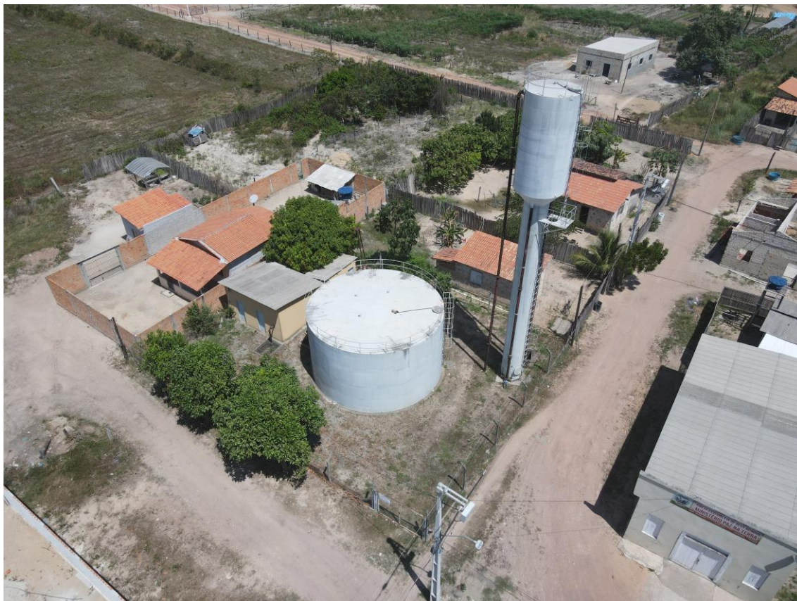
Figura 24. TAI05-REL, (reservatório elevado).
