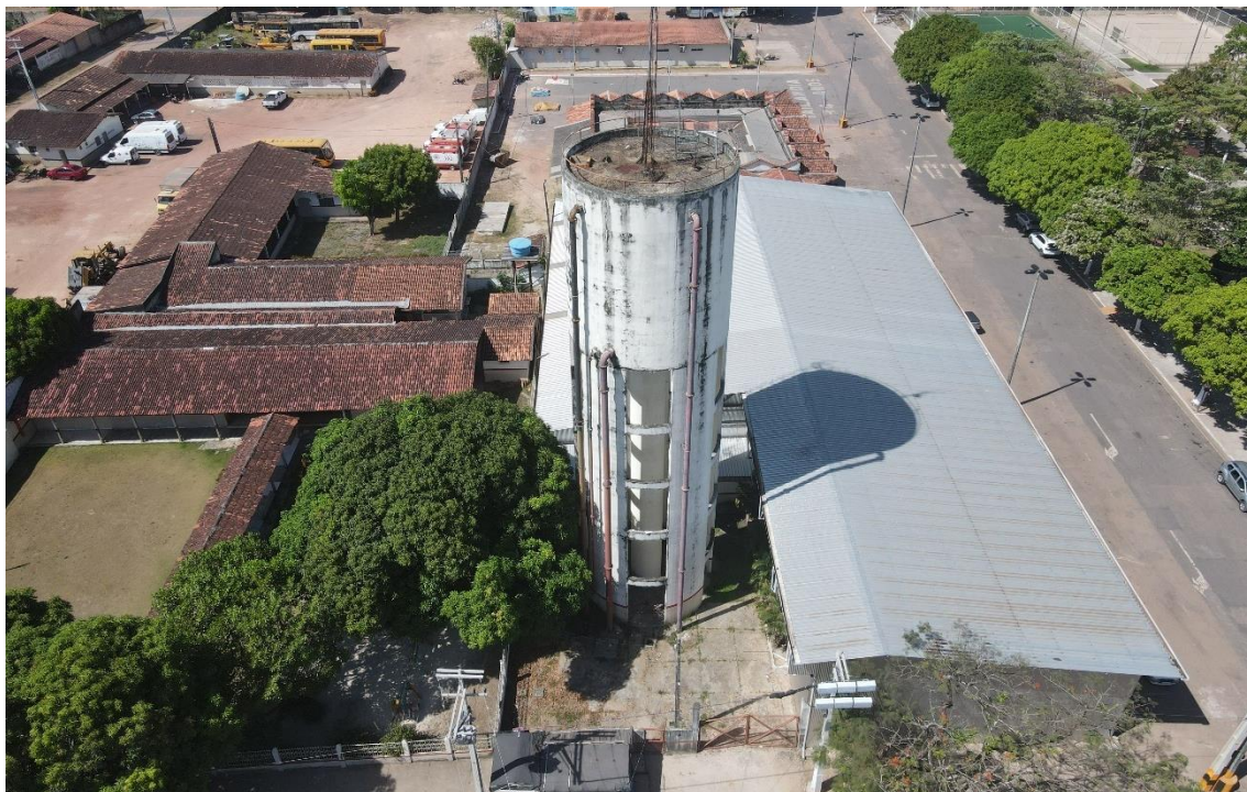
Figura 22. TAI02-REL, (reservatório Elevado).
