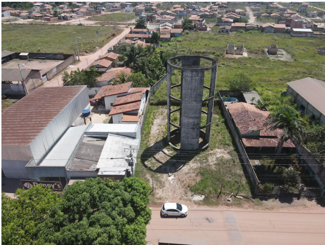
Figura 27. TAI09-REL, (reservatório elevado).
