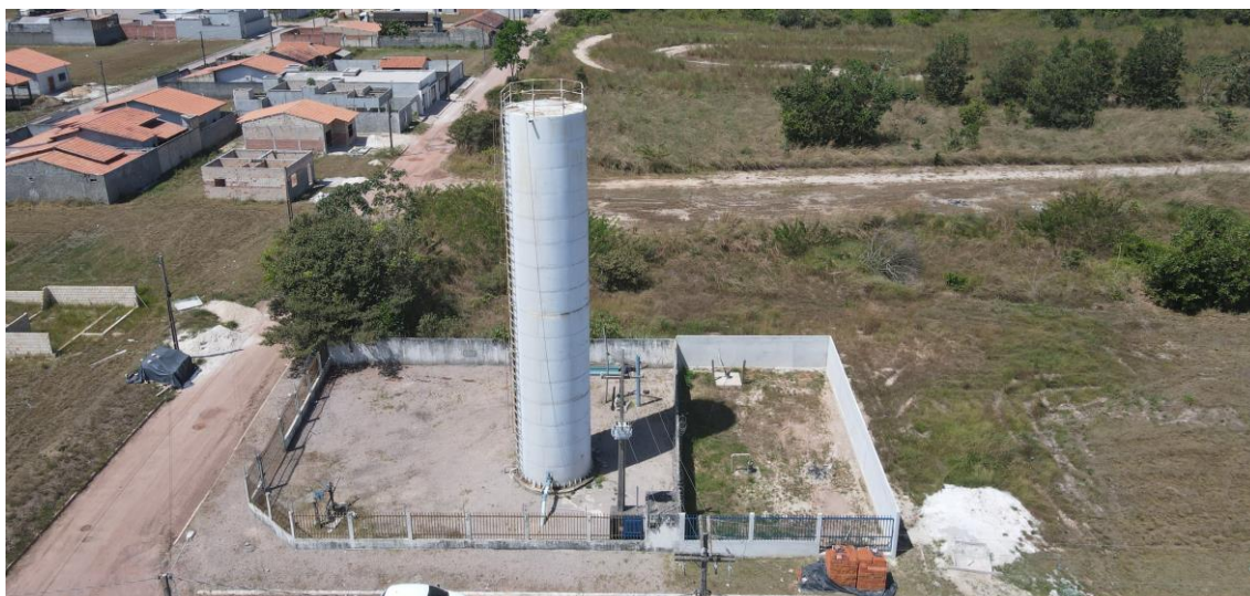
Figura 26. TAI08-REL, (reservatório elevado).
