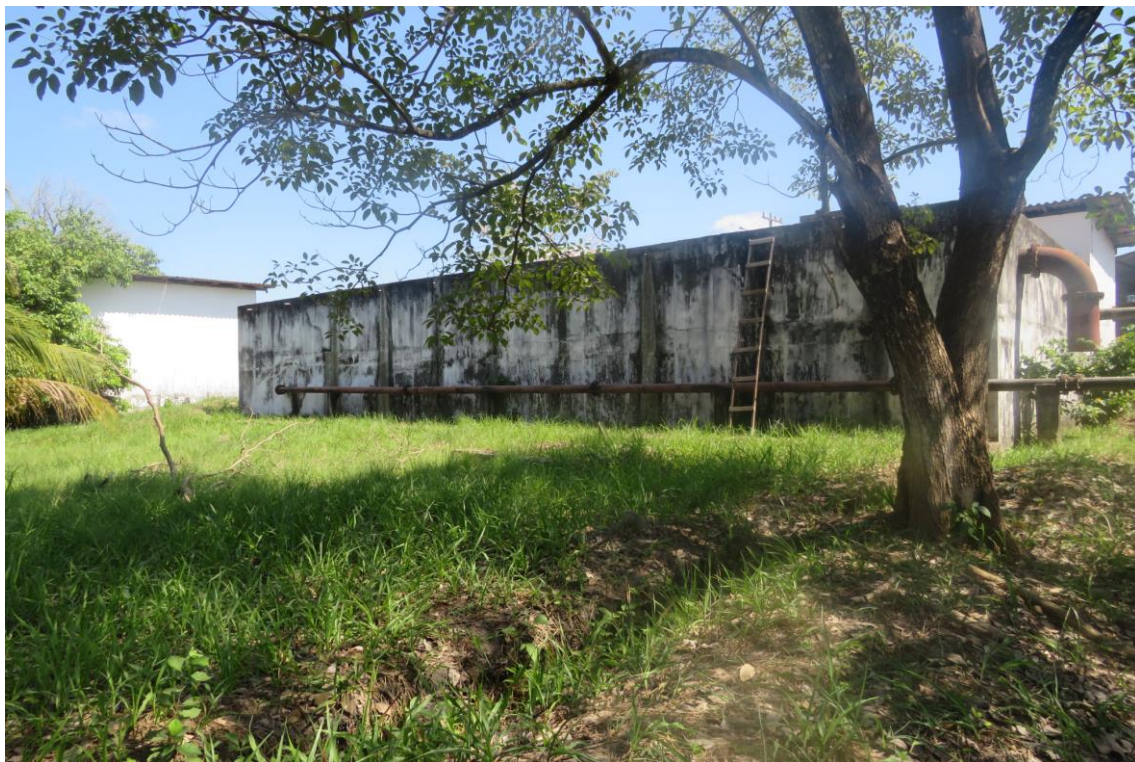
Figura 20. TAI01-RAP01, (reservatório apoiado).
