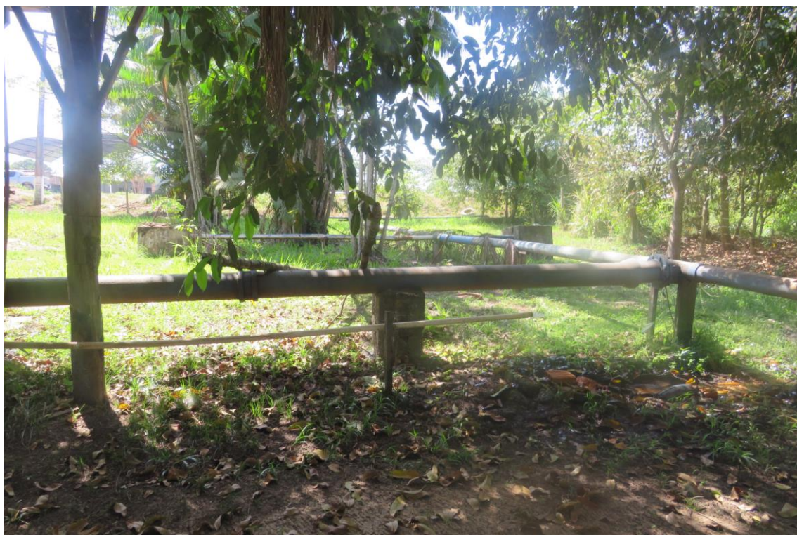
Figura 8. TAI01-CAPTAÇÃO002, sistema a vácuo (panorâmica).
