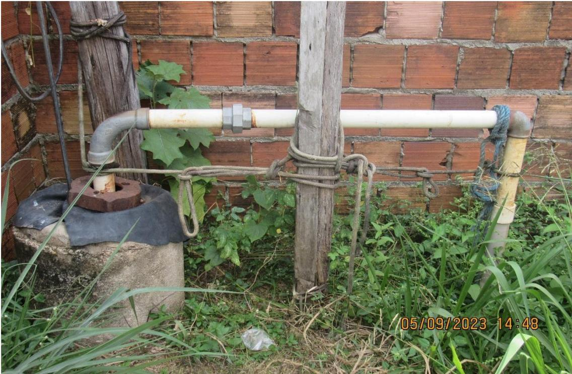
*Figura 20. TMA011-CAPTAÇÃO 02, subterrânea (poço tubular)
