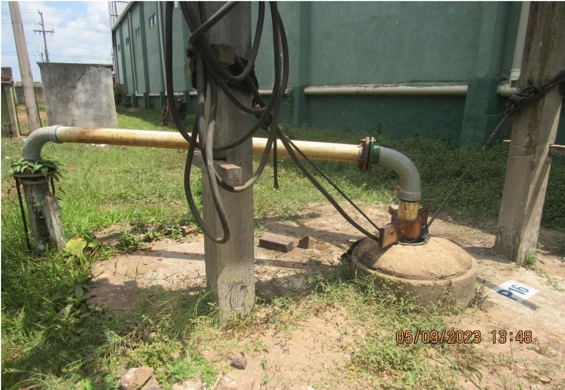
*Figura 14. TMA007-CAPTAÇÃO 04, subterrânea (poço tubular)*
