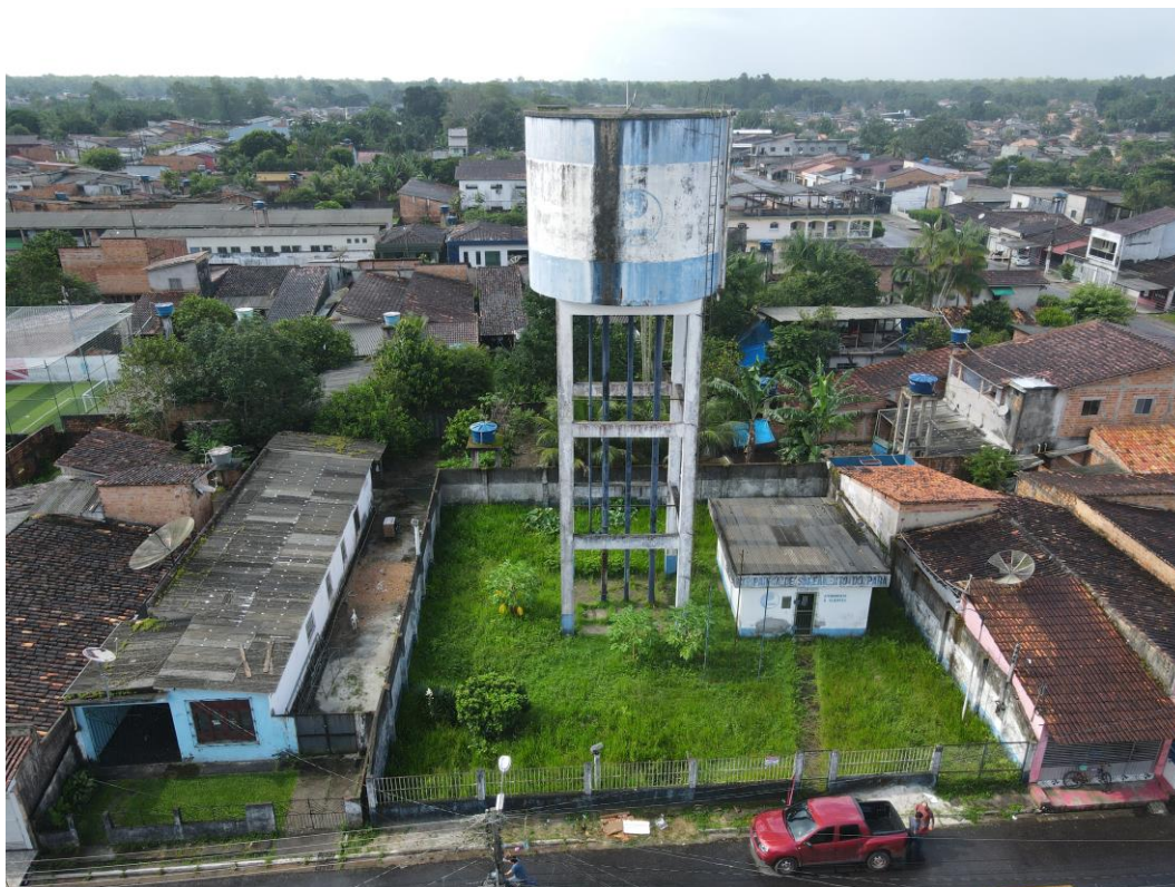
Figura 12. VIG01, Reservatório Elevado (Panorâmica).
