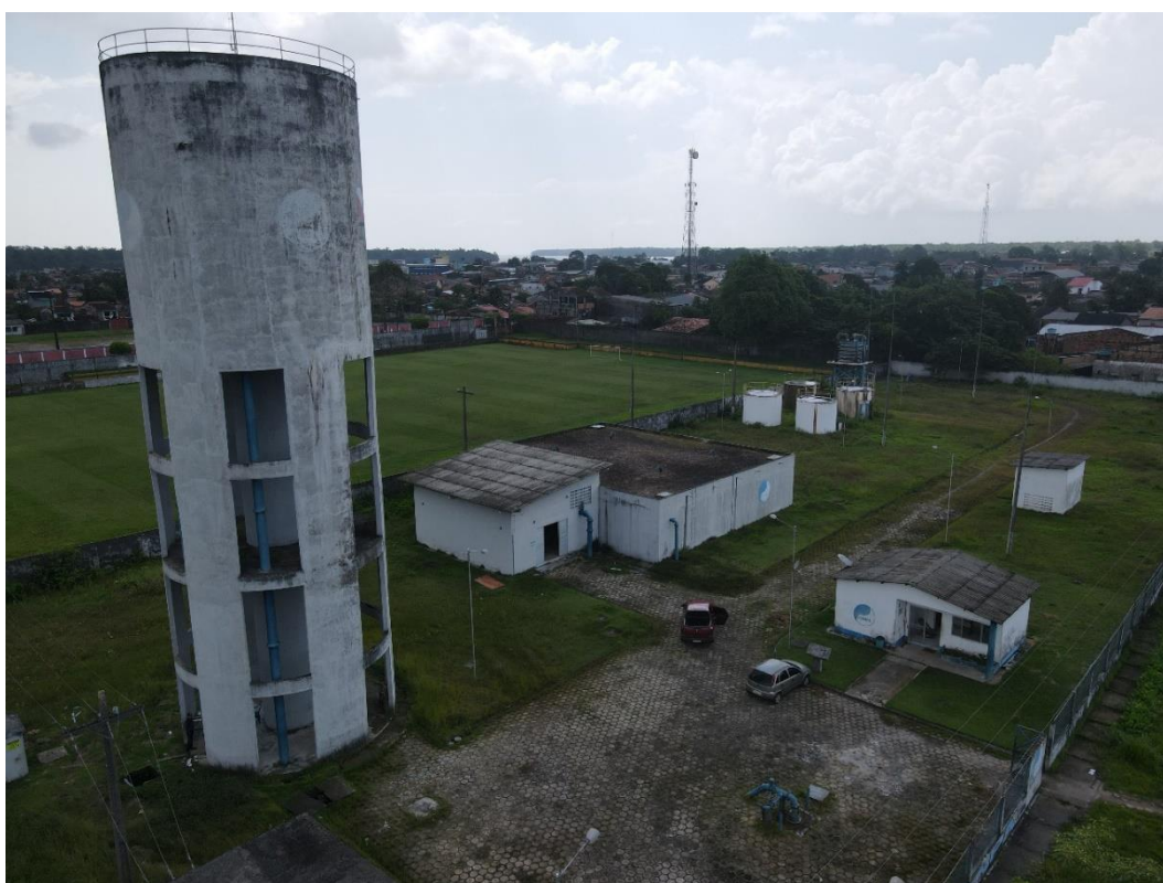
Figura 17. VIG03, Reservatório Elevado. Fonte: Consórcio, 2023.
