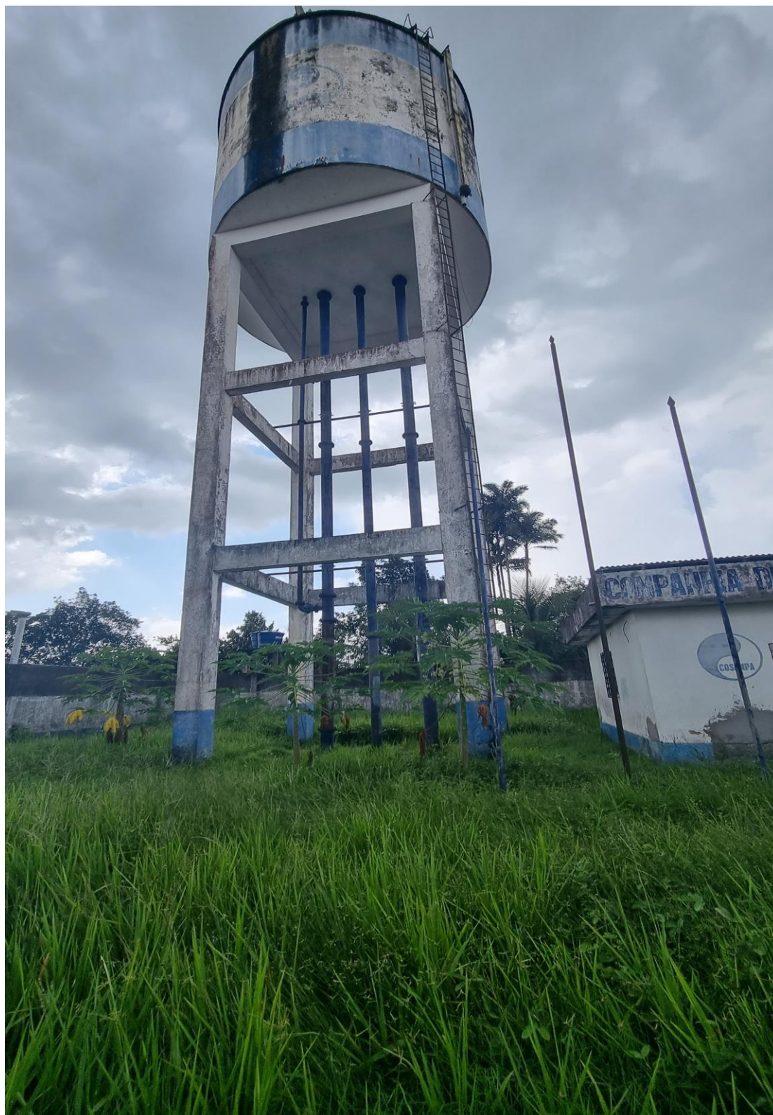
Figura 13. VIG01, Reservatório Elevado (Aproximado).
