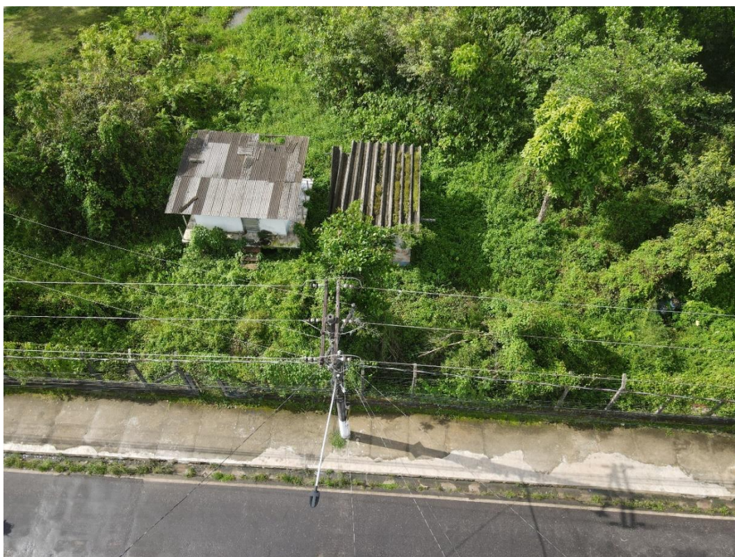
Figura 4. VIG02 - captação, (panorâmica). Fonte: Consórcio, 2023.
