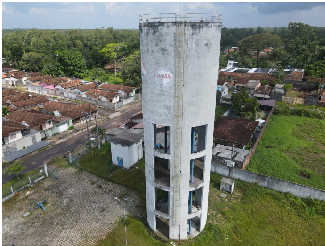
Figura 16. VIG03, Reservatório Elevado. Fonte: Consórcio, 2023.
