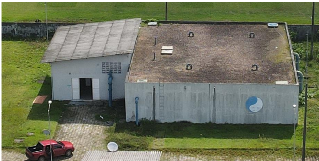
Figura 14. VIG03, Reservatório Apoiado.
