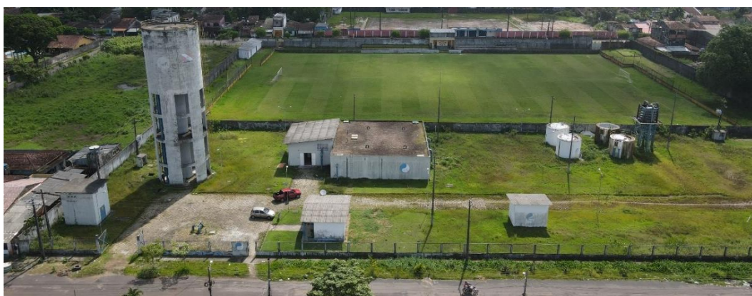
Figura 15. VIG03, Reservatório Apoiado (Panorâmica).
