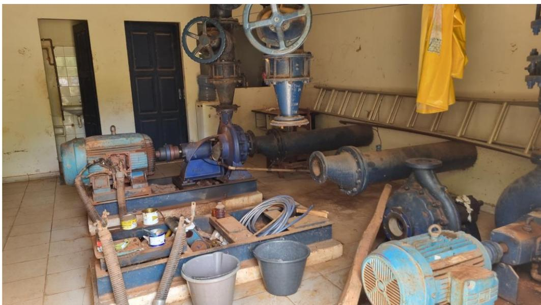
*Figura 8. VIS02 - conjunto de motobombas da EEAT.*
