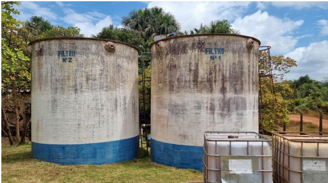
*Figura 5. VIS02 - ETA, filtros desativados (Aproximado)*
