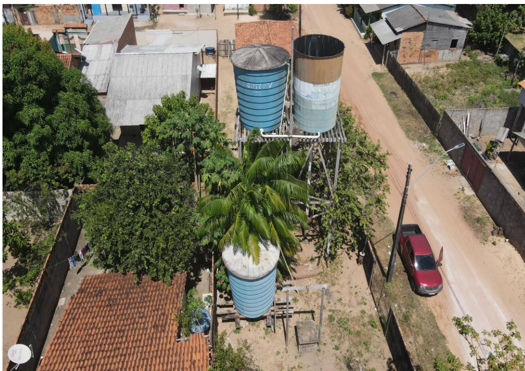
Figura 12. ALQ06-REL (reservatório elevado).
