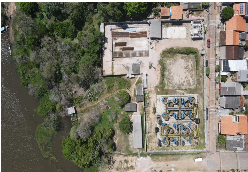
Figura 9. ALQ01-RAP02 (estrutura em obra)
