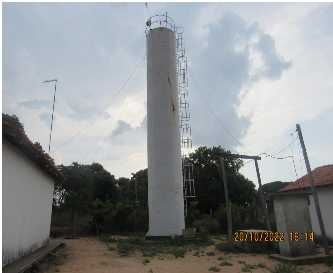
Figura 16. ALQ10-REL( reservatório elevado).
