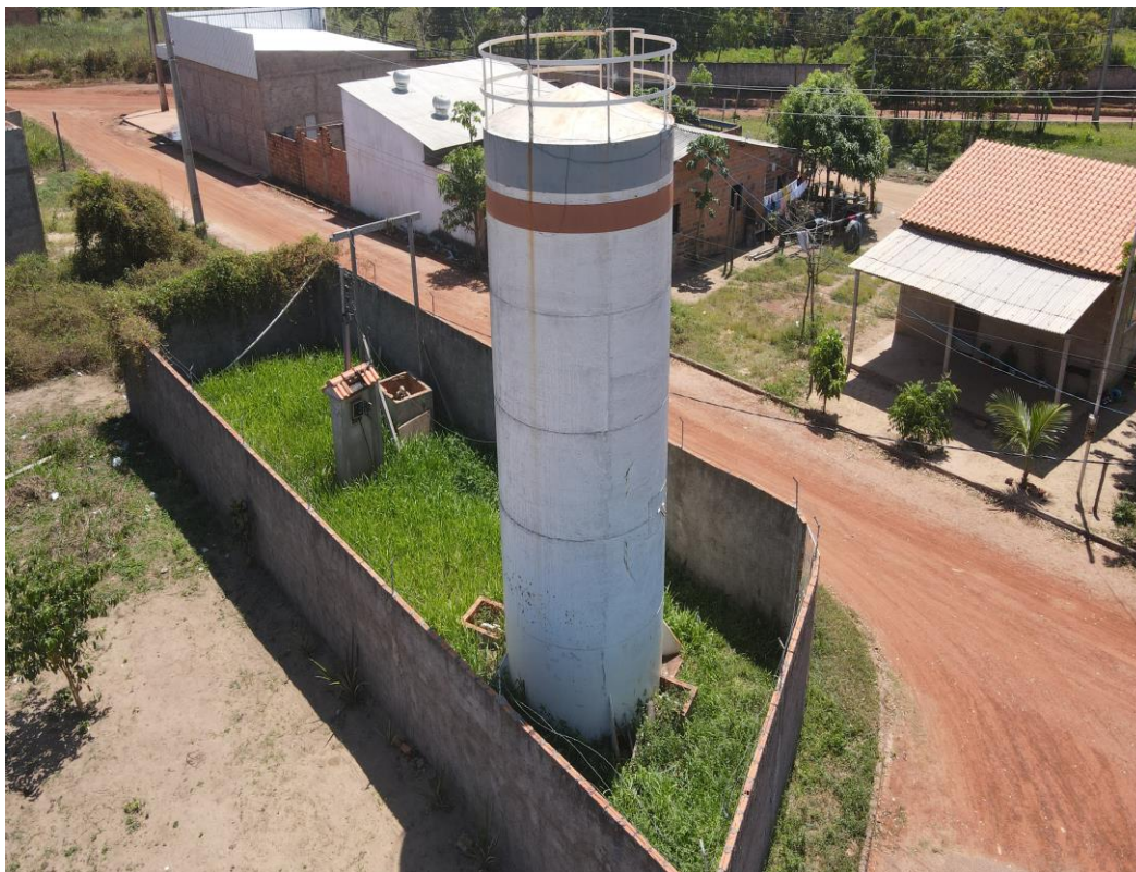
Figura 15. ALQ09-REL (reservatório elevado).
