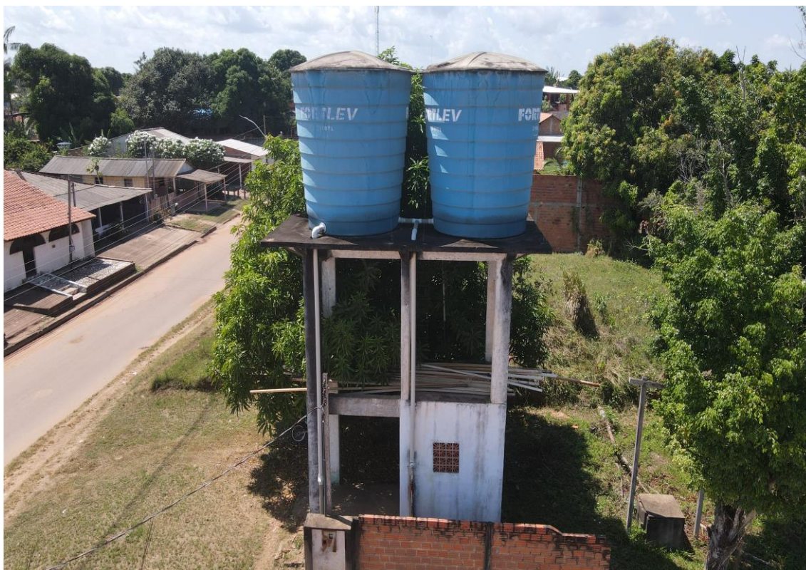
Figura 14. ALQ08-REL (reservatório elevado).
