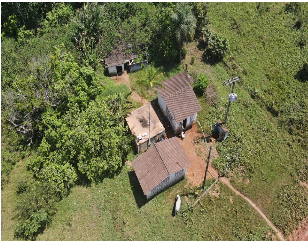
Figura 5. ALQ03 – CAPTAÇÃO, Poço subterrâneo (panorâmica).
