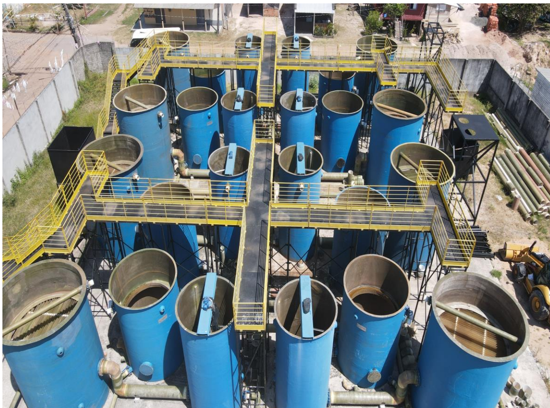
Figura 6. ALQ01-ETA (Estação de Tratamento de Água, em construção).
