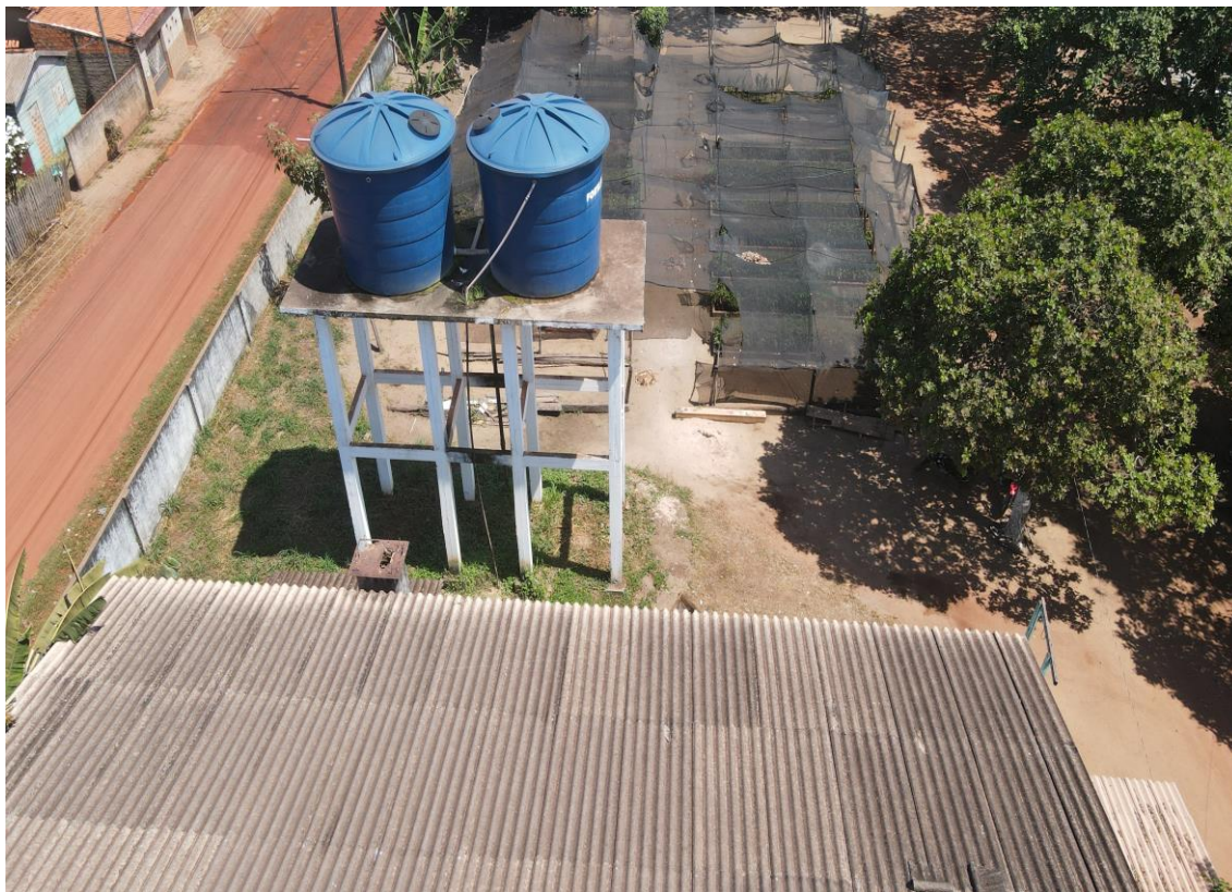
Figura 13. ALQ07-REL (reservatório elevado).
