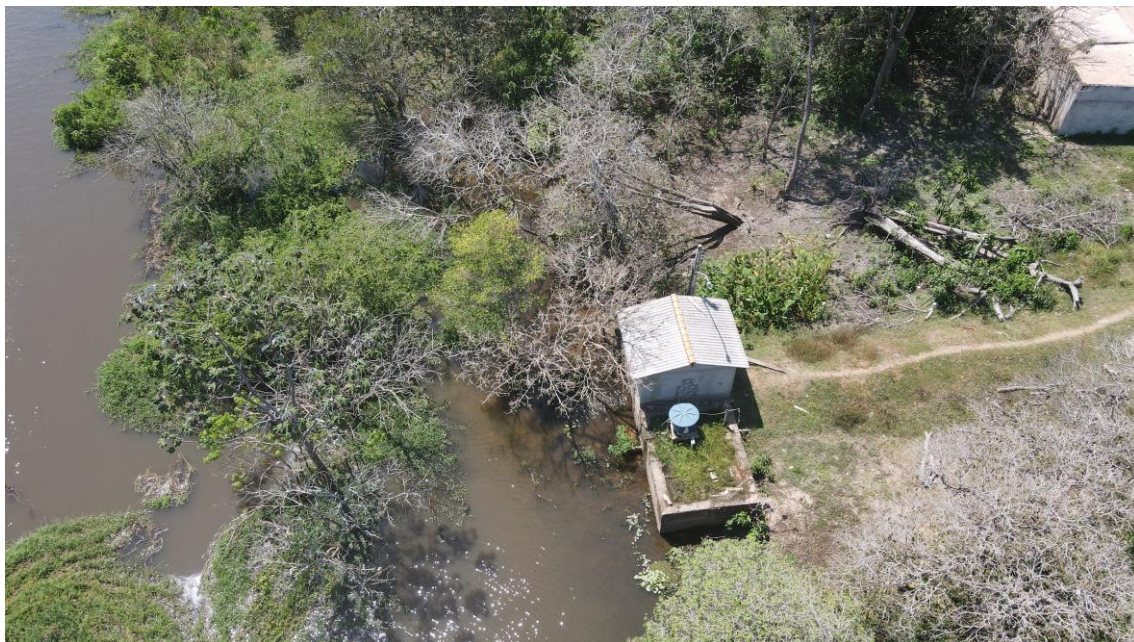
Figura 3. ALQ01-CAPTAÇÃO (poço subterrâneo).
