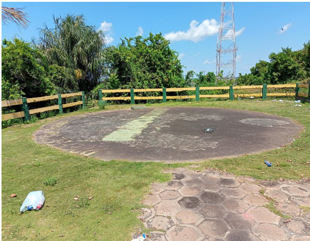
Figura 17. ALQ11-REN (reservatório enterrado).
