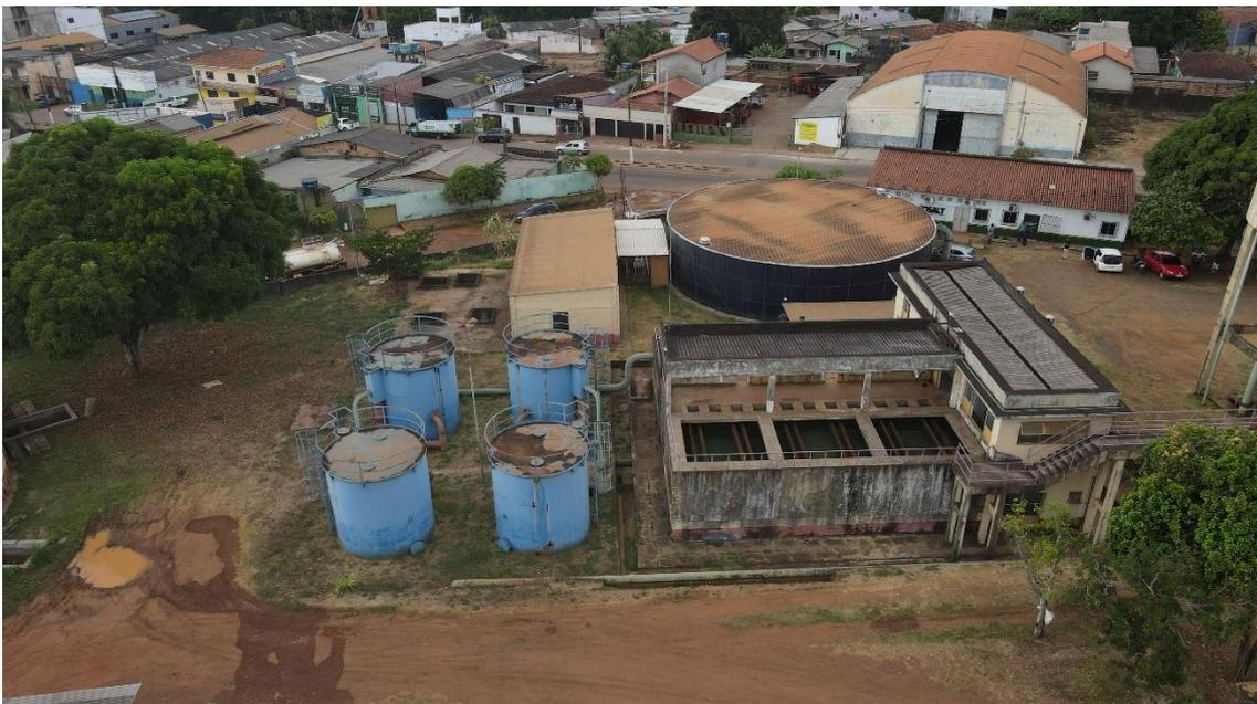
*Figura 29. Filtros em Aço, Filtros de Concreto e Tanque de Contato.*
