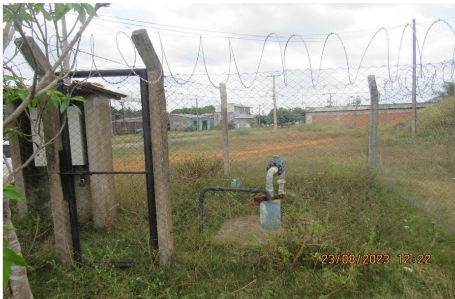
*Figura 16. ALT038-CAPTAÇÃO, subterrânea (poço tubular)*
