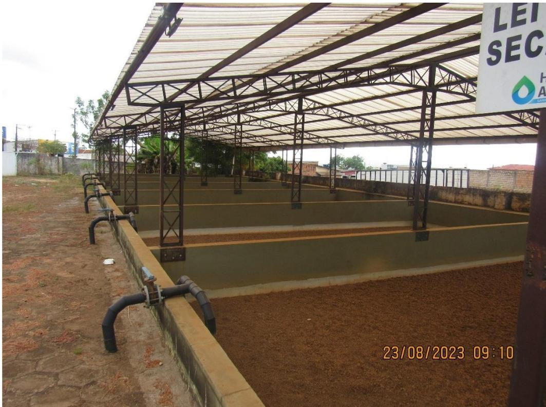
*Figura 32. Leito de secagem de lodo.*
