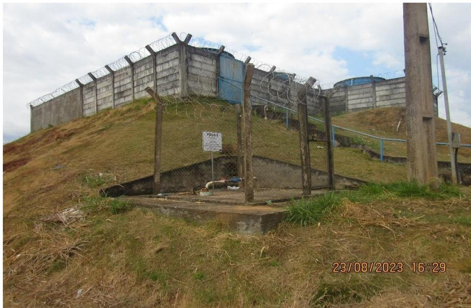
*Figura 22. ALT049-CAPTAÇÃO, subterrânea (poço tubular)*
