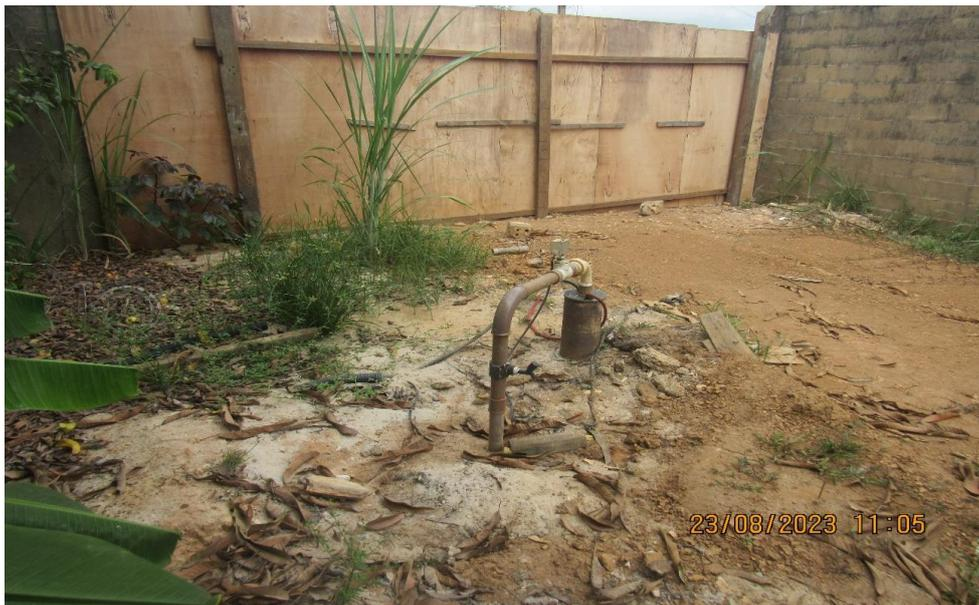
*Figura 8. ALT027-CAPTAÇÃO, subterrânea (poço tubular)*
