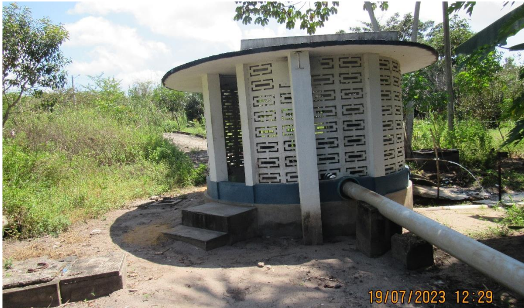
Figura 3. Captação - MON01, sistema de vácuo 01.
