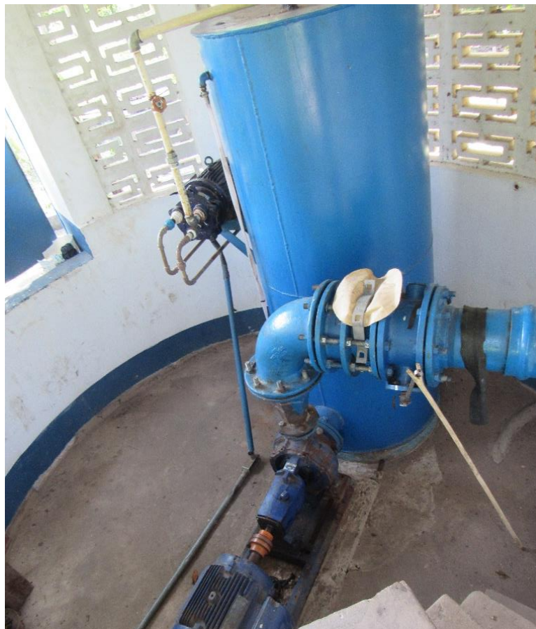
Figura 4. Captação - MON01, CMB do sistema de vácuo 01.
