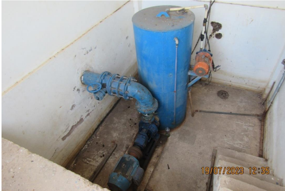
Figura 7. Captação - MON01, CMB do sistema de vácuo 04.
