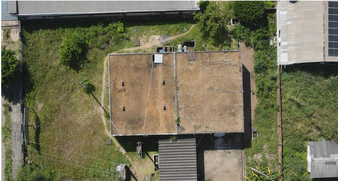
Figura 18. RAP02 e RAP03 - MON02 (panorâmica).
