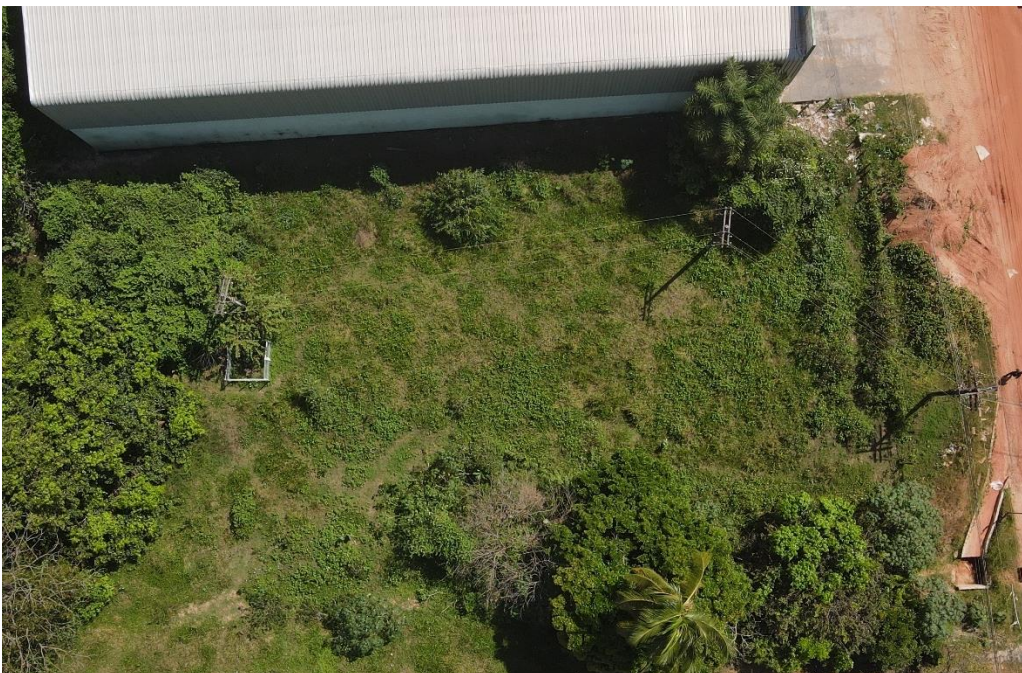
Figura 10. Captação - MON05, poço tubular inoperante (panorâmica).
