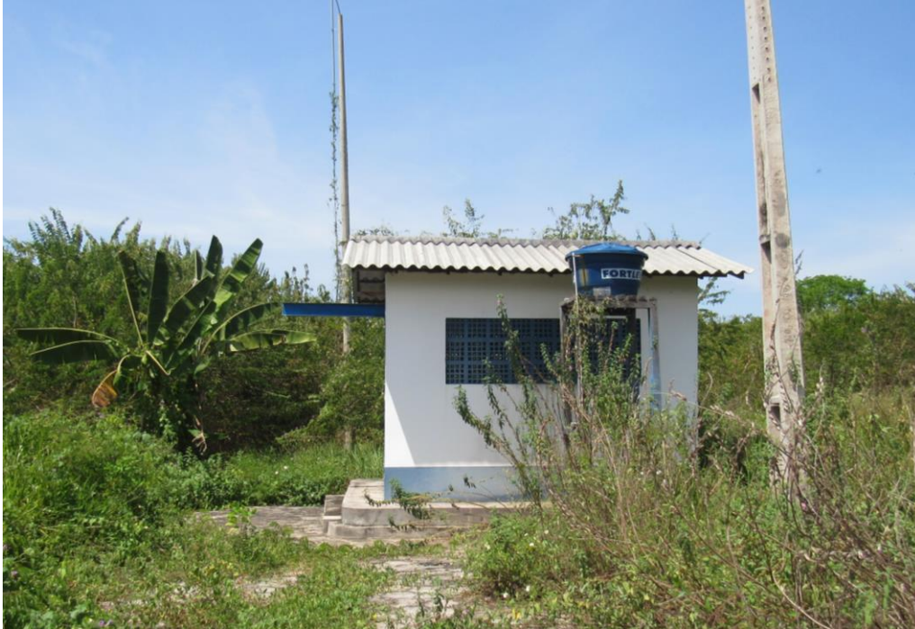
Figura 9. Captação - MON01, sistema de vácuo 05 (inoperante).
