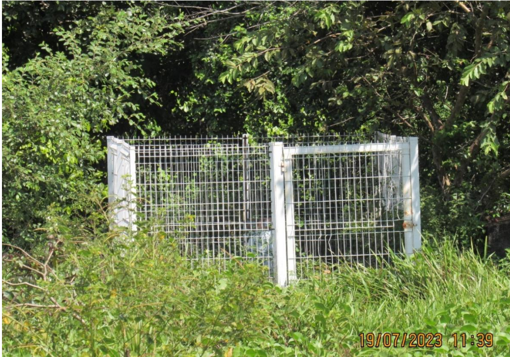
Figura 11. Captação - MON05, poço tubular inoperante (aproximada).
