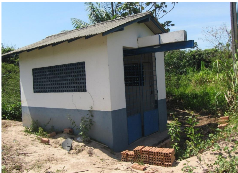
Figura 6. Captação - MON01, sistema de vácuo 03 (inoperante).
