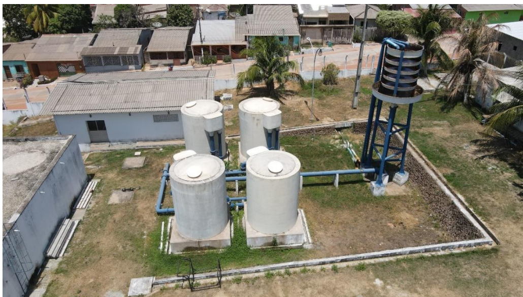
Figura 15. OBI08 – Unidade com obra inacabada e inoperante.
