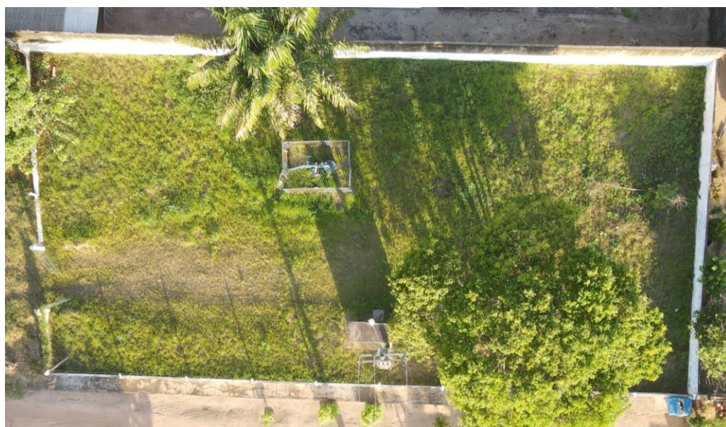
Figura 6. OBI05 – Captação, poço 4 (panorâmica).
