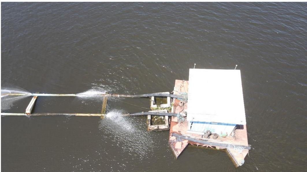
*Figura 4. Captação - Flutuante em operação na unidade ORX01 (aproximada).*
