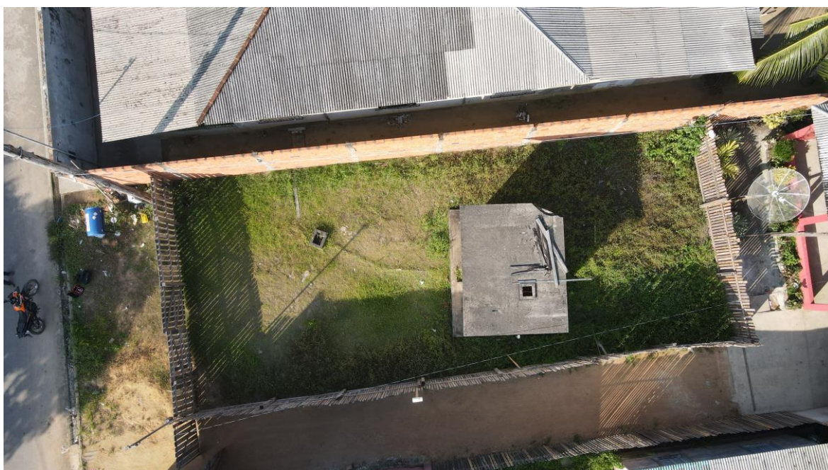
Figura 13. PDM04 - Captação, Poço Profundo (60m). Fonte: Consórcio, 2023.
