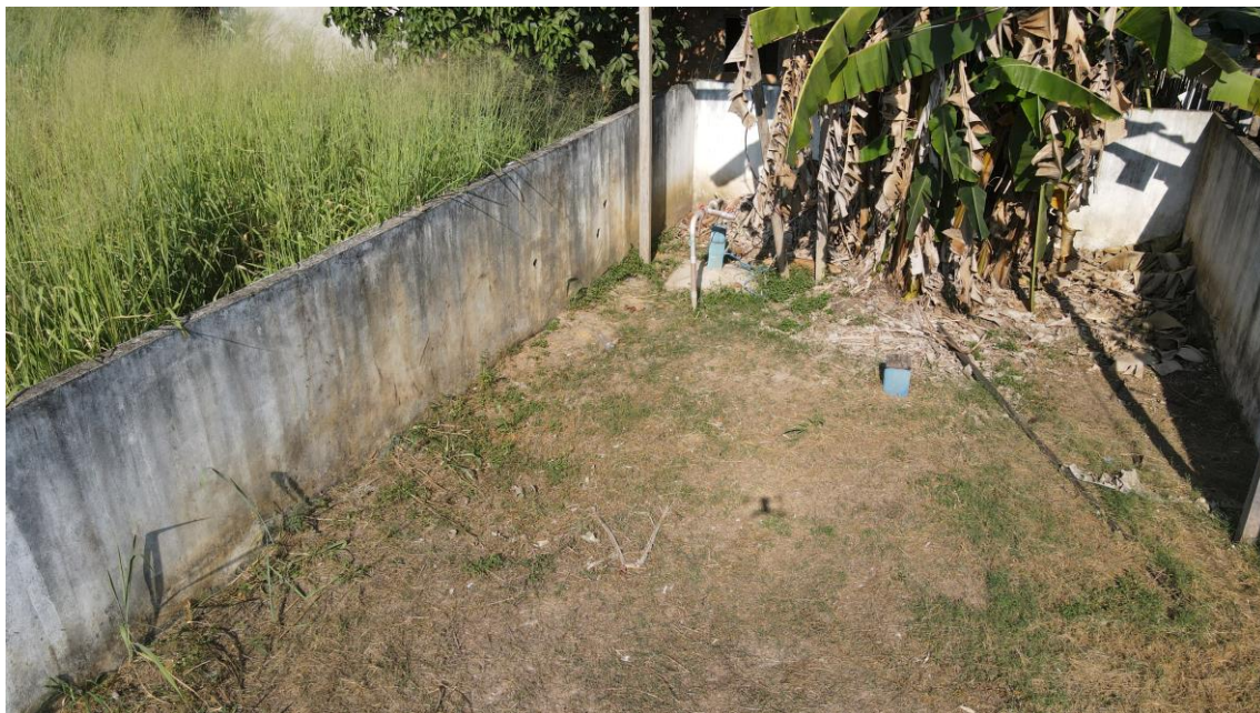
Figura 10. PDM02 - Captação, Poço Profundo (25m).
