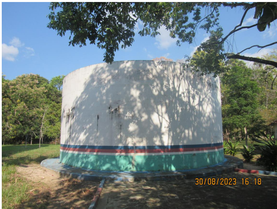
Figura 21. PDM01 - RAP02, SAA estrutura de concreto.
