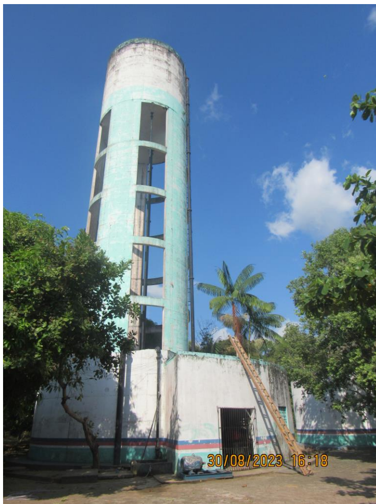
Figura 20. PDM01 - RAP01-REL e EEAT, SAA estrutura de concreto.
