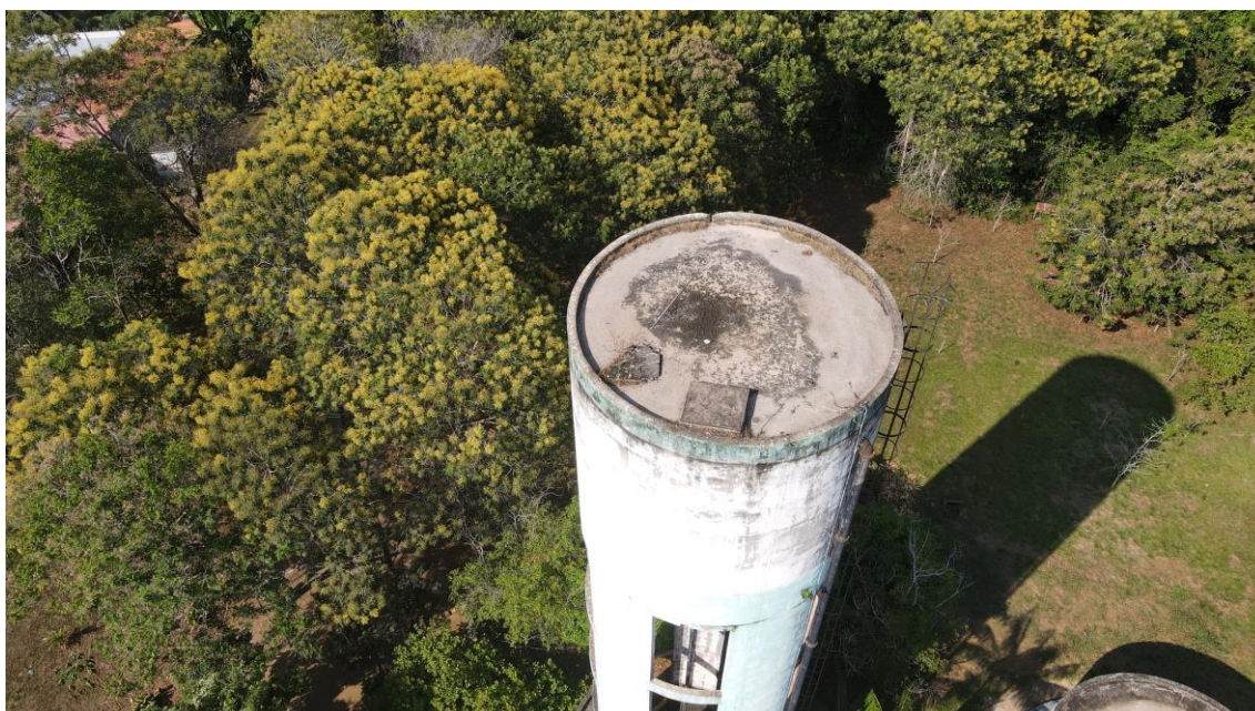
Figura 22. PDM01 - REL, SAA estrutura de concreto.
