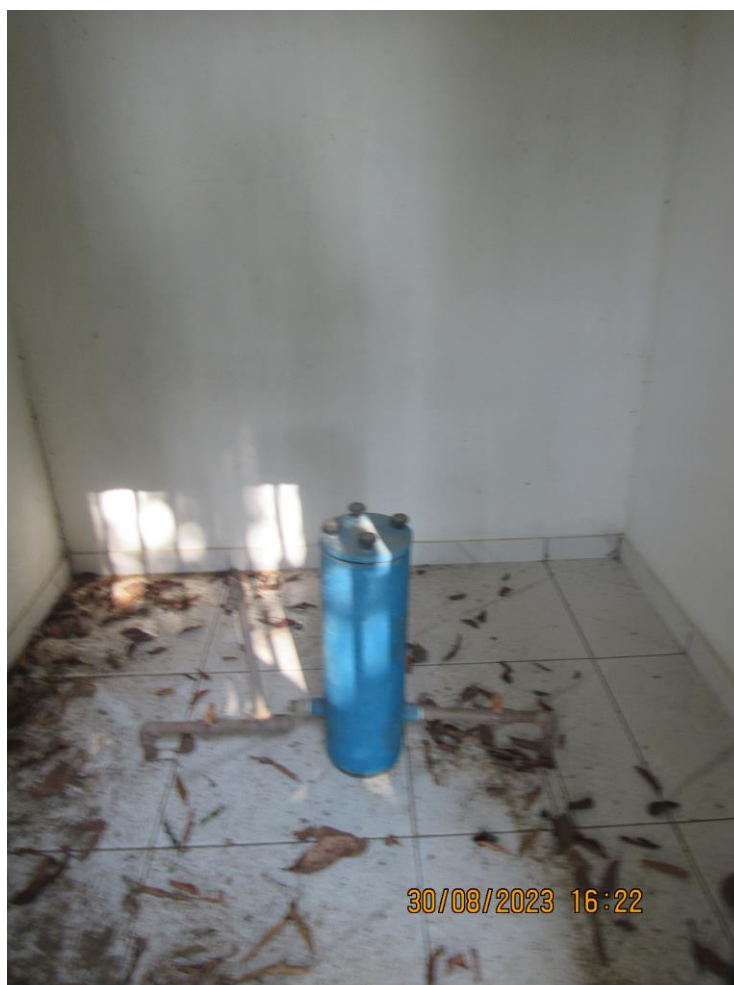
Figura 15. PDM01 - SAA Tratamento a cloro pastilha, do Poço 01.
