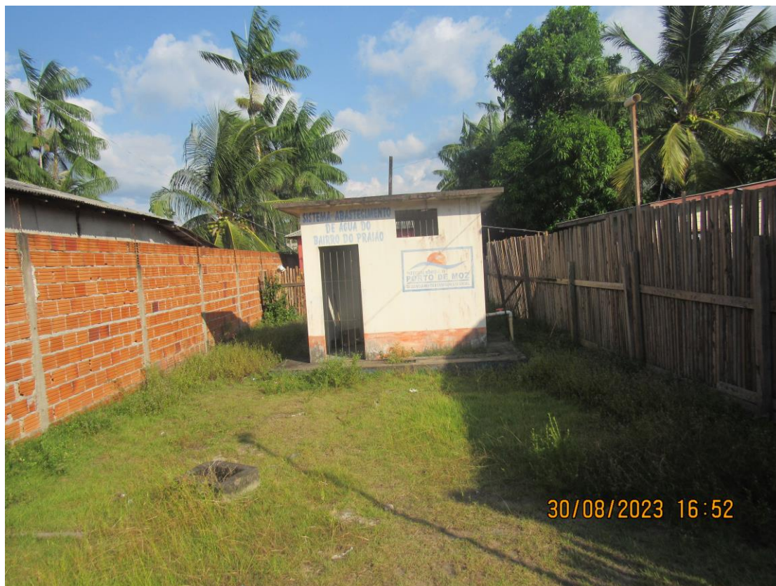
Figura 14. PDM04 - Captação, estrutura de microssistema.
