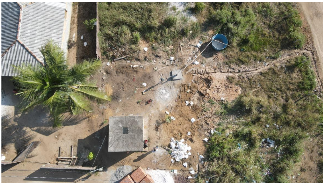
Figura 12. PDM03 - Captação, estrutura de microsistema. Fonte: Consórcio, 2023.
