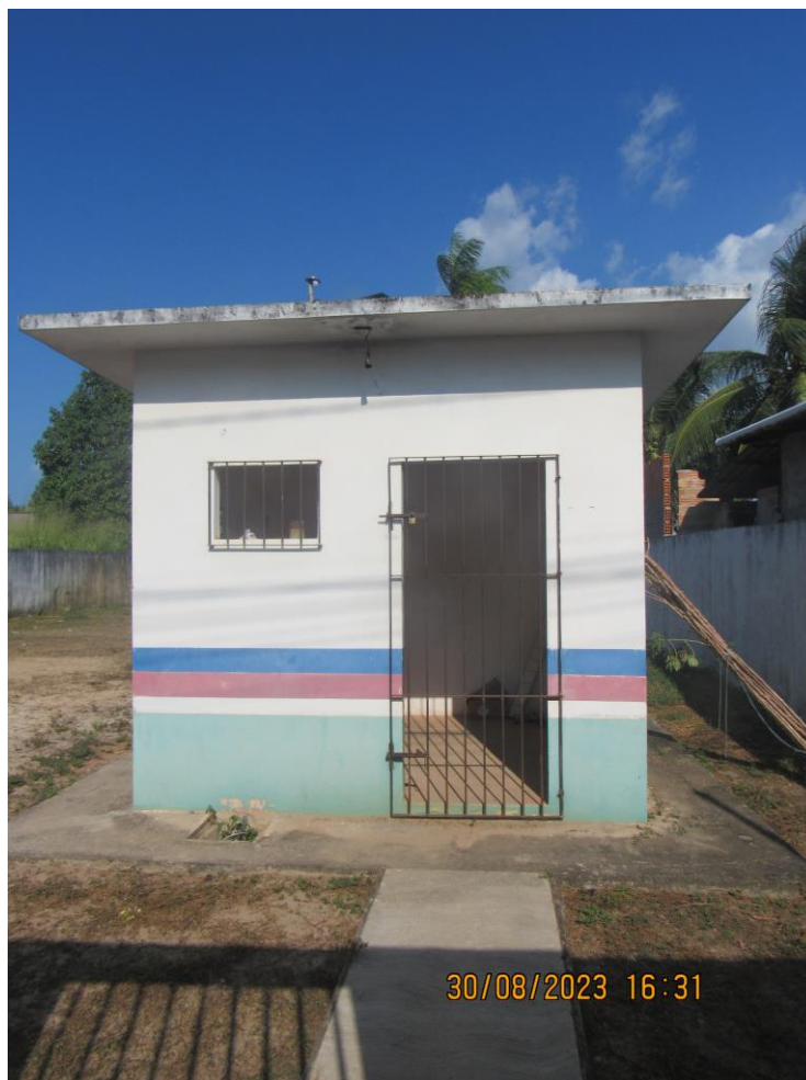
Figura 9. PDM02 - Captação, estrutura de microsistema.
