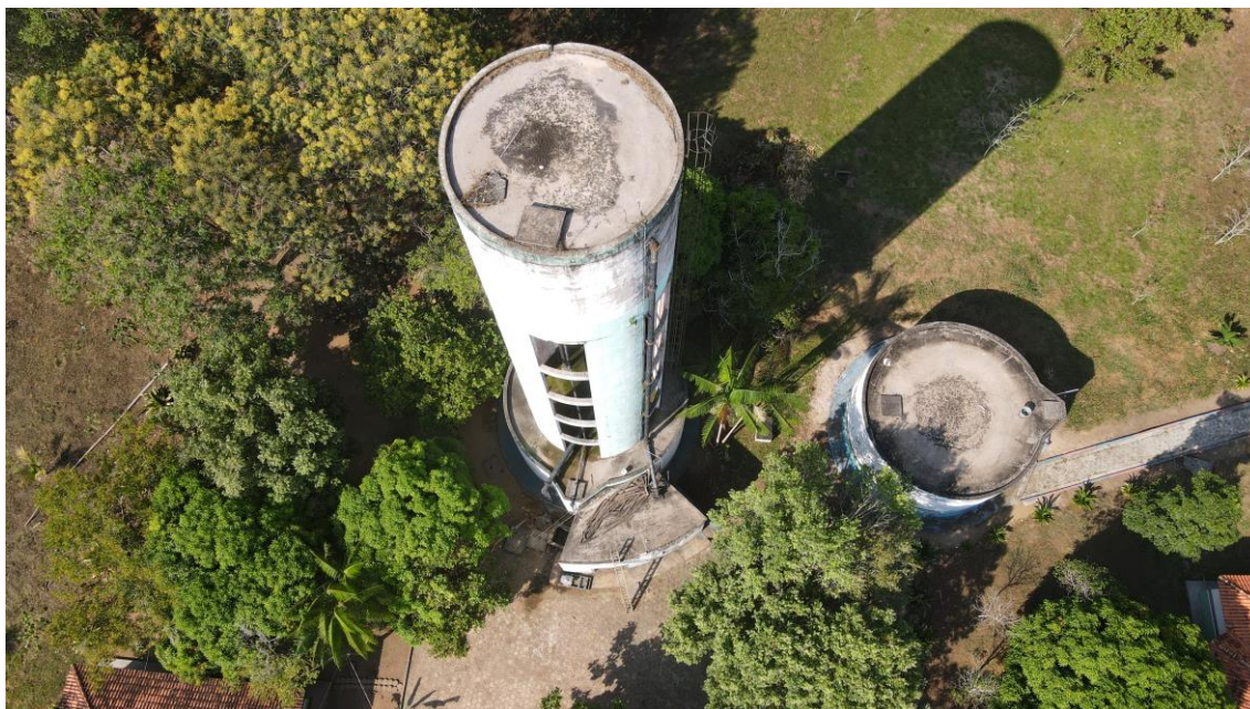
Figura 19. PDM01 - RAP01-REL e RAP02, SAA ambas estruturas de concreto.
