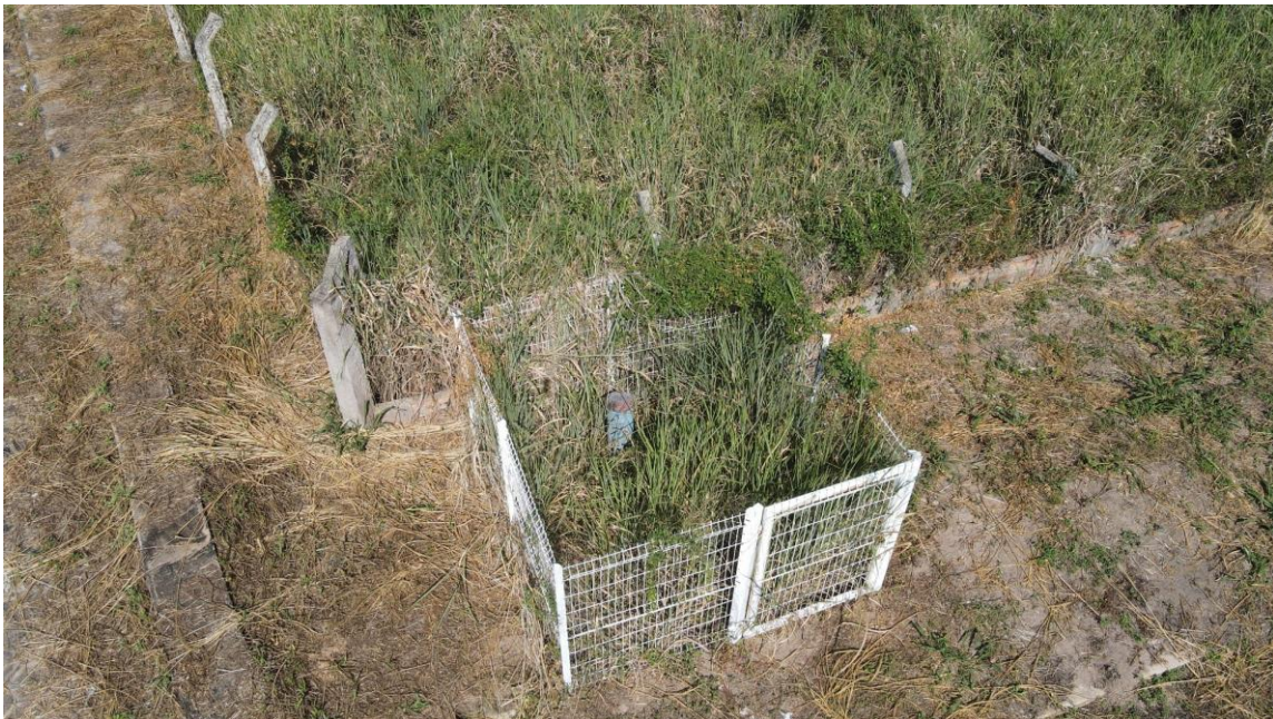
Figura 6. PRA02 – Captação, poço tubular (Desativado).
