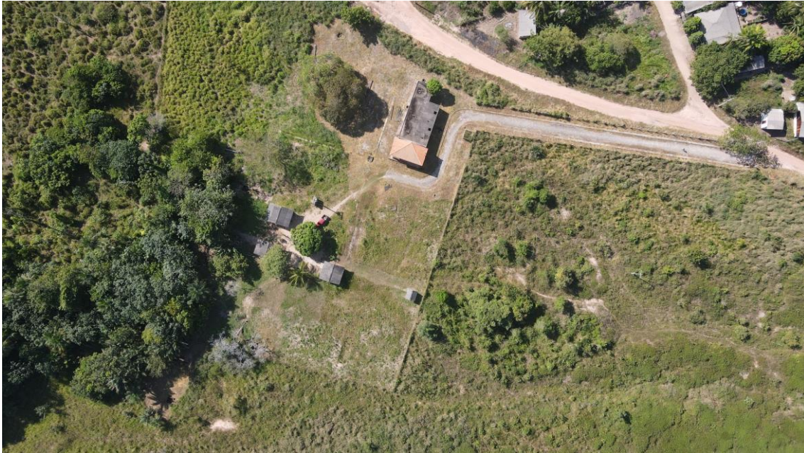
Figura 7. PRA02 – Captação, poço tubular. Fonte: Consórcio, 2023
