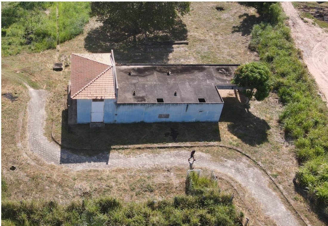
Figura 11. PRA02 – RAP e Elevatória (inoperantes) (Panorâmica)
