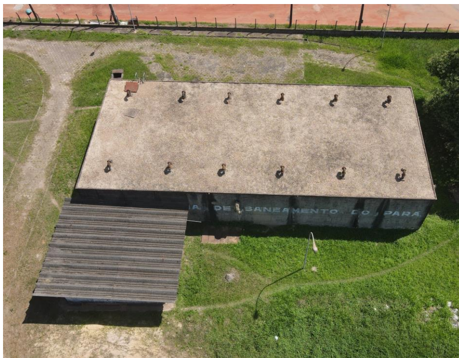
Figura 72. RAP-07, estrutura (panorâmica).
