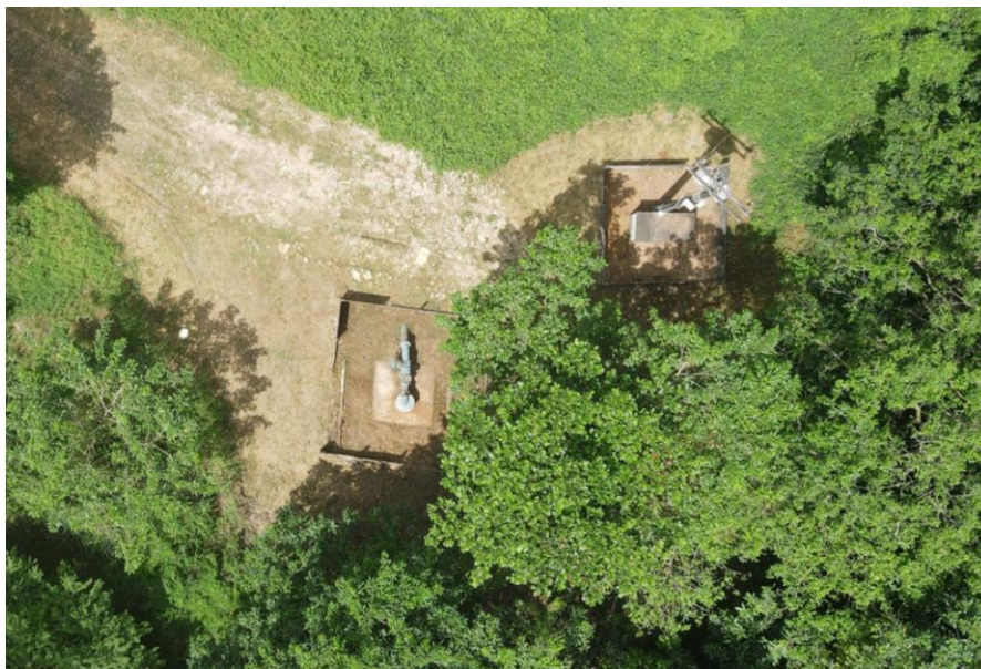
Figura 6. Captação - MAR02 (panorâmica).
