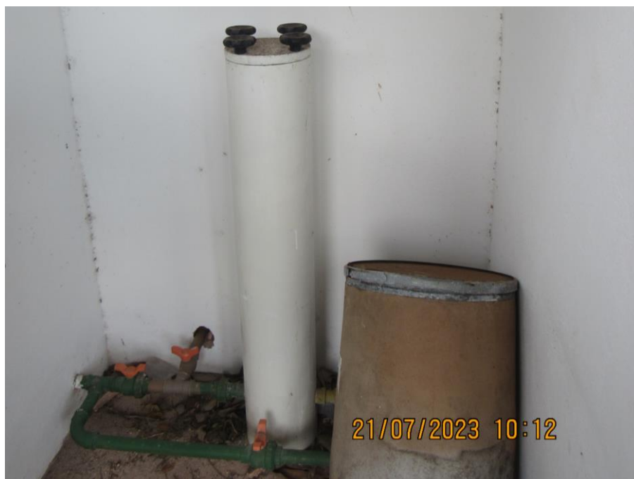
Figura 49. Tratamento Químico – STM006, cloro pastilha.
