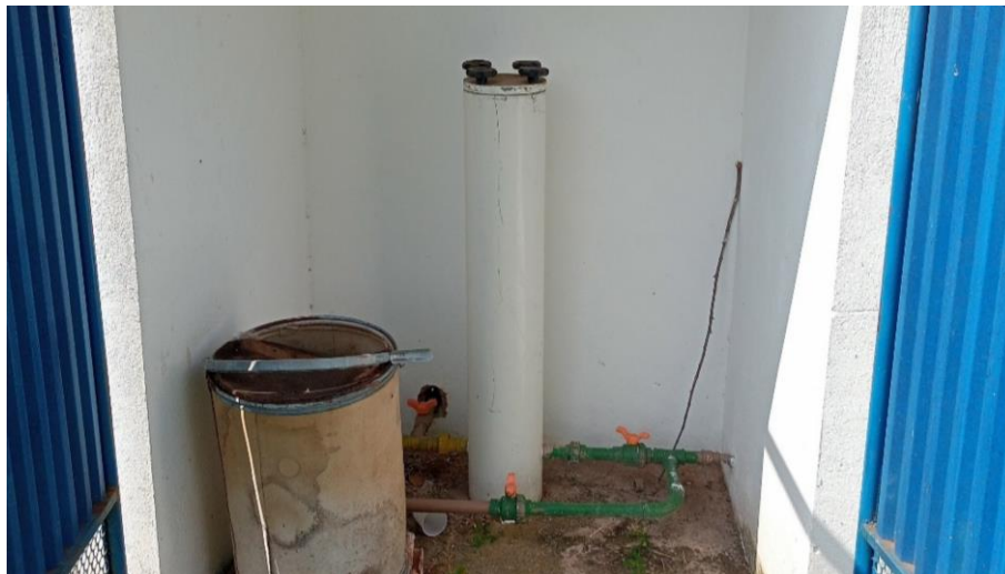
Figura 50. Tratamento Químico – STM014, cloro pastilha.
