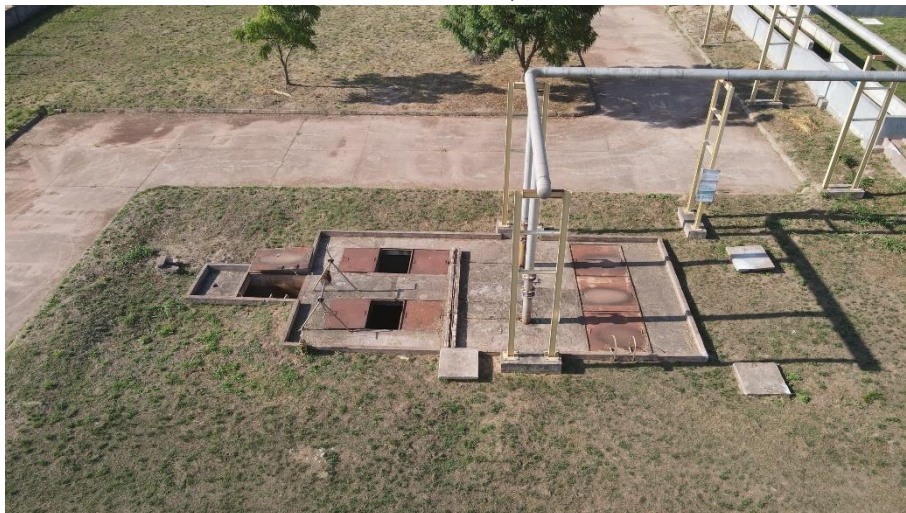
Figura 118. STM17-ETE Urumari, chegada do esgoto na ETE.
