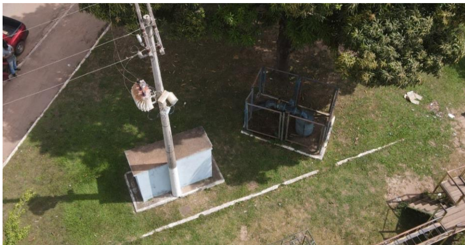
Figura 26. Captação – STM011 (panorâmica).
