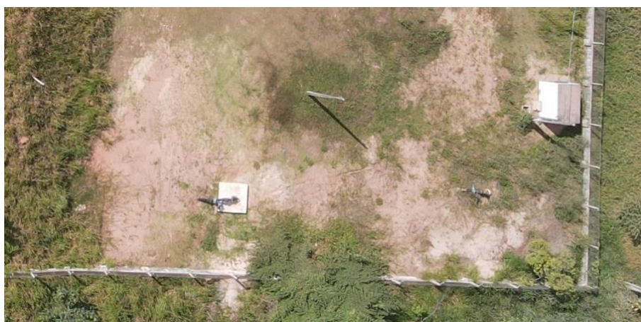
Figura 39. Captação – STM020 (panorâmica).
