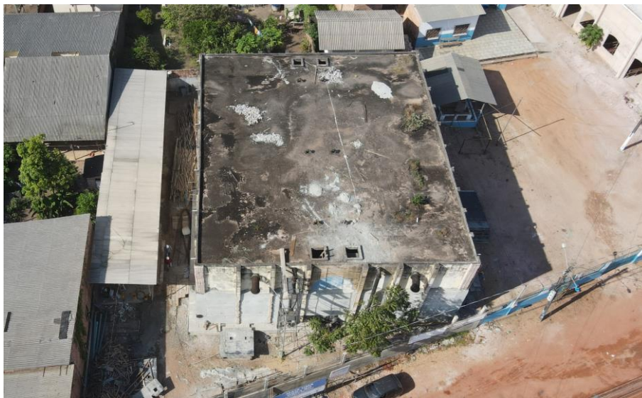
Figura 88. RAP-26 desativado, estrutura (panorâmica).
