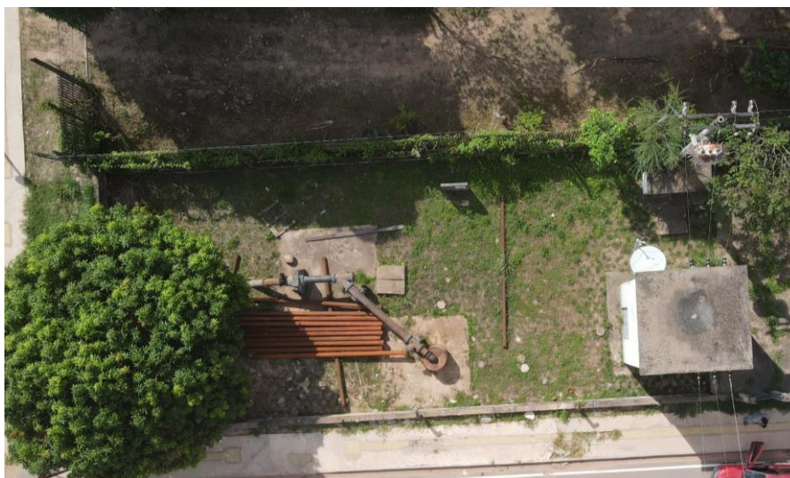
Figura 20. Captação – STM008 (panorâmica).
