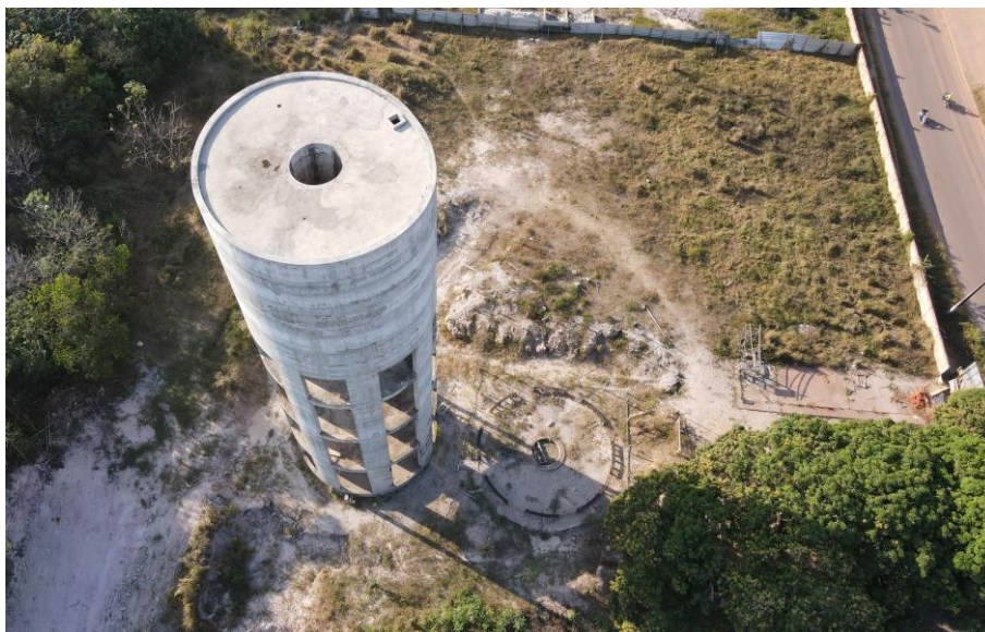
Figura 83. RAP-23, estrutura (panorâmica).
