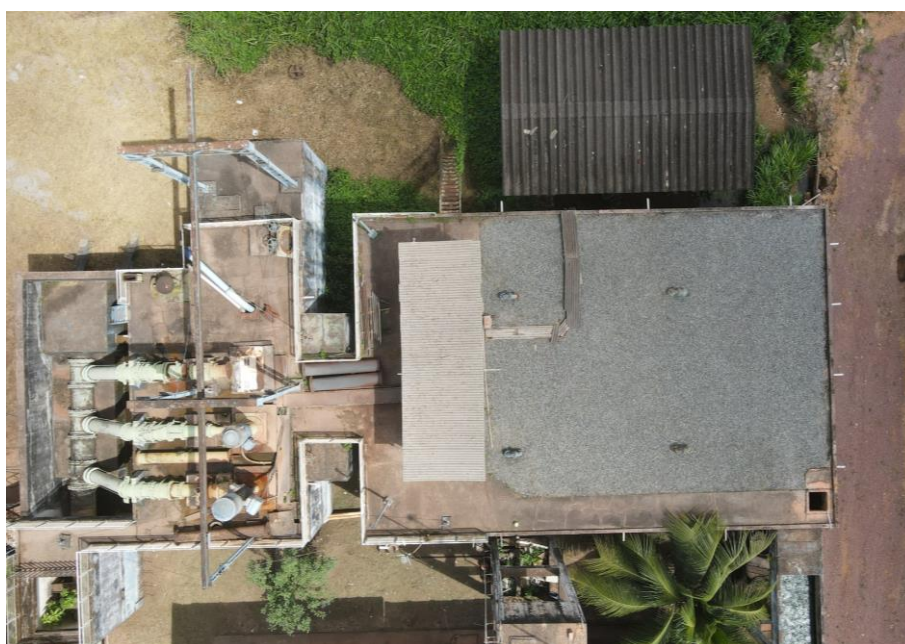
Figura 68. RAP2-02, estrutura (panorâmica).
