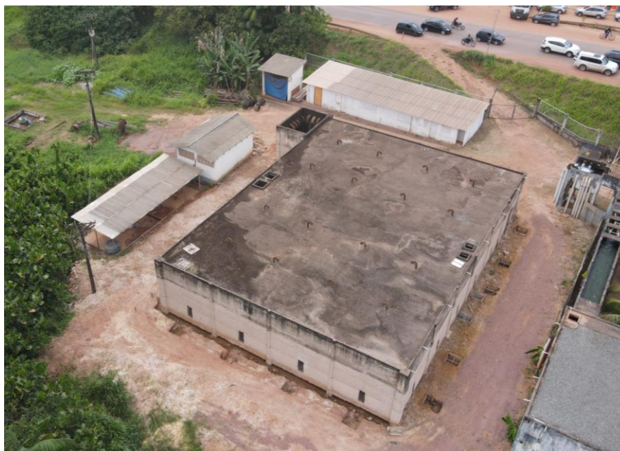
Figura 67. RAP1-02 desativado, estrutura.
