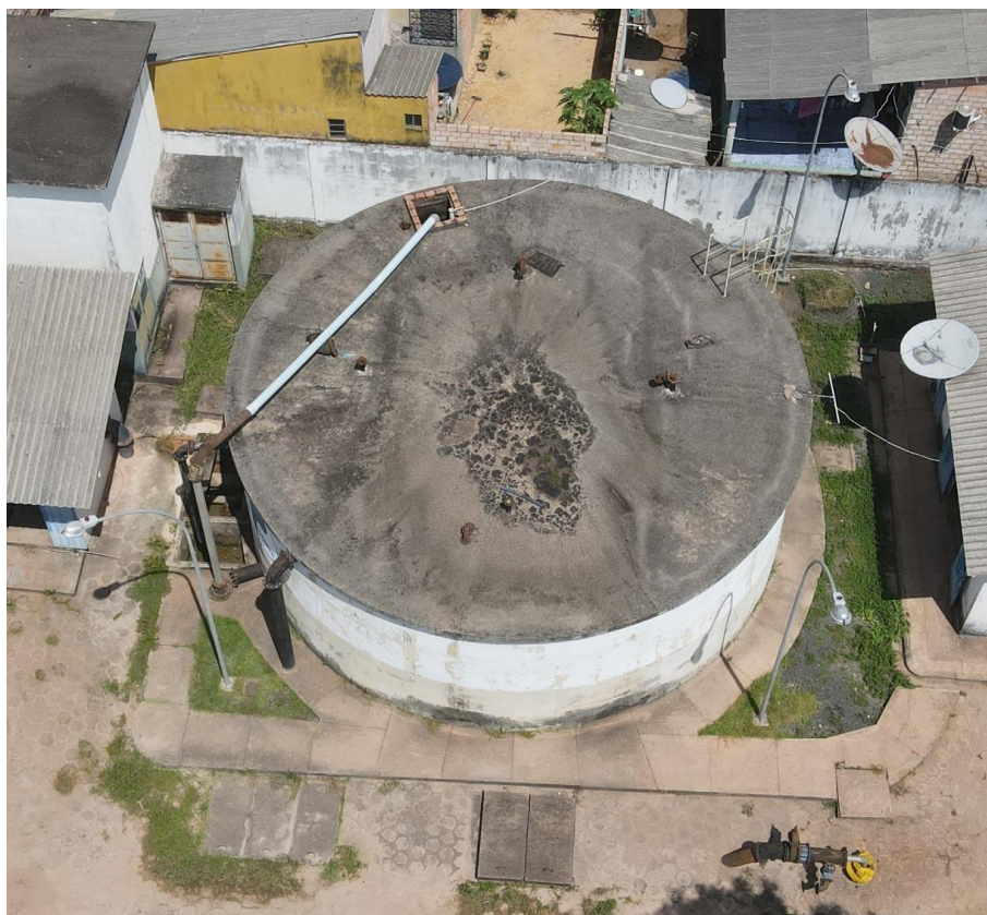
Figura 77. RAP-13, estrutura (panorâmica).
