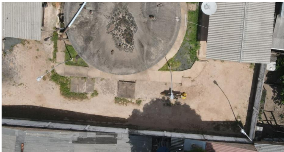
Figura 31. Captação – STM013 (panorâmica).
