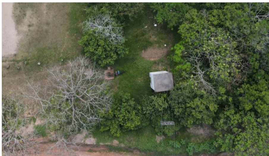
Figura 24. Captação – STM010 (panorâmica).
