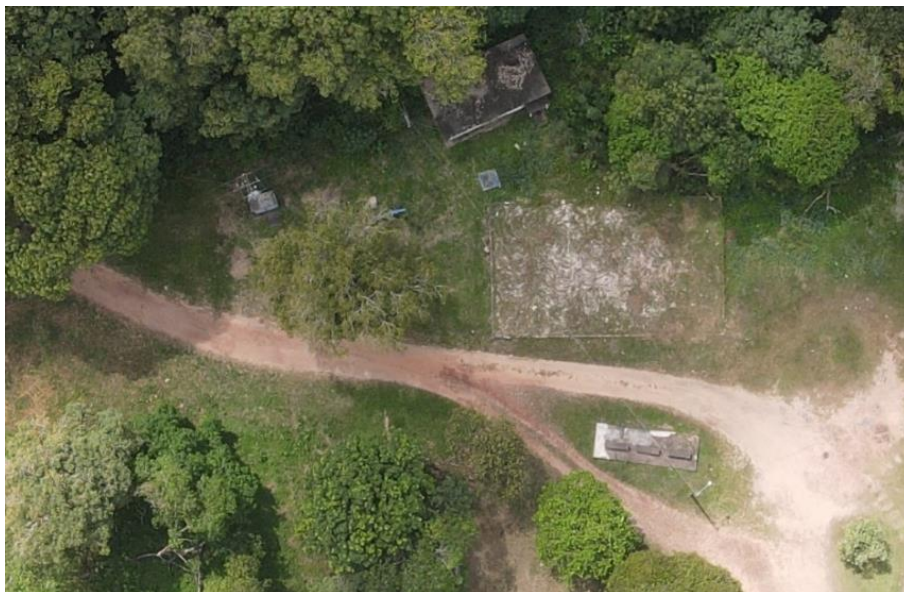
Figura 16. Captação – STM004 (panorâmica).
