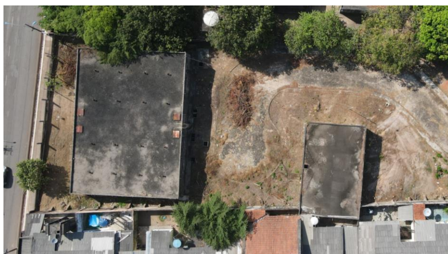
Figura 85. RAP2-25 e RAP1-25 desativado, estrutura (panorâmica).
