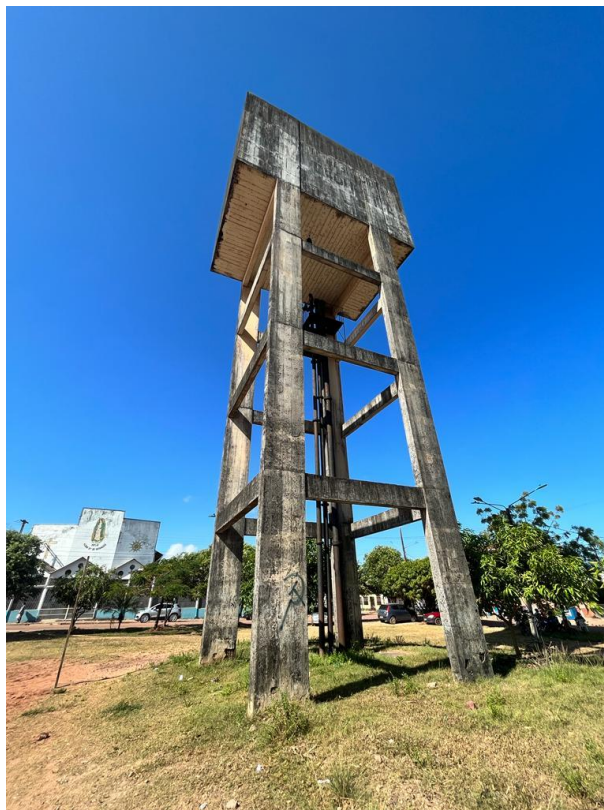
Figura 98. REL-39, estrutura- desativado
