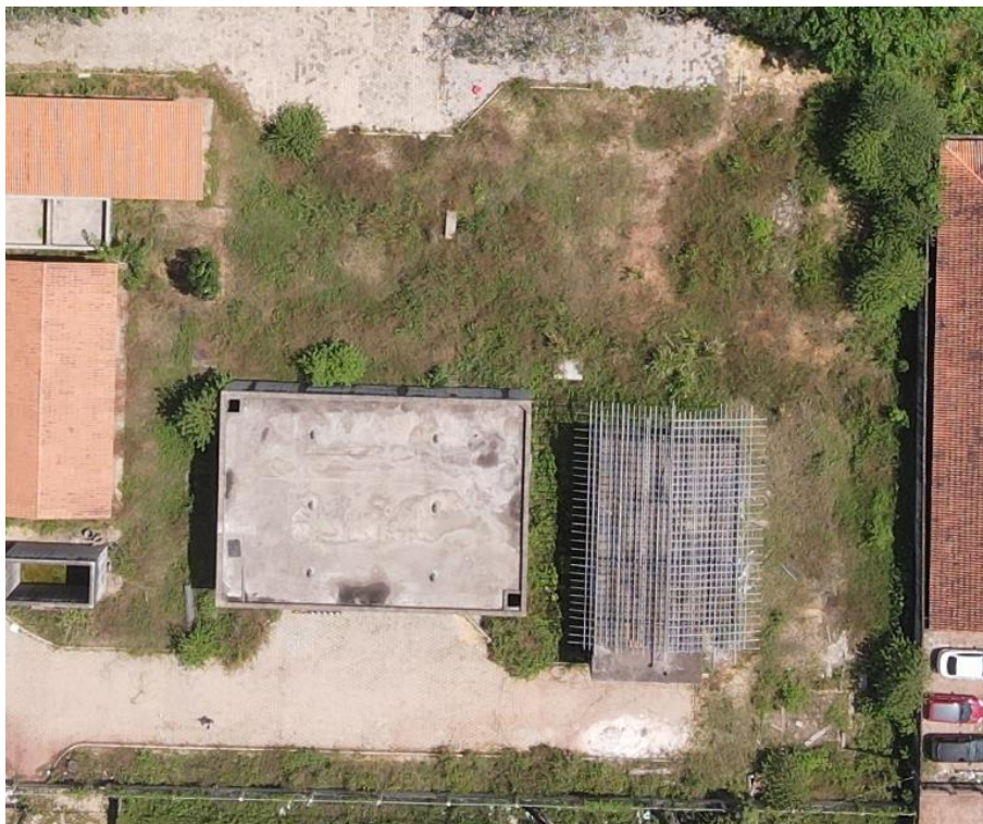
Figura 90. RAP-27, estrutura (panorâmica).
