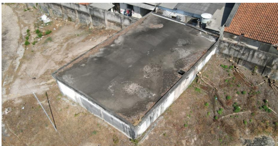
Figura 87. RAP1-25 desativado, estrutura.
