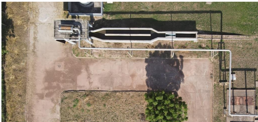
Figura 119. STM17-ETE Urumari, peneiras rotativas, gradeamento, desarenador e medidor Parshall.
