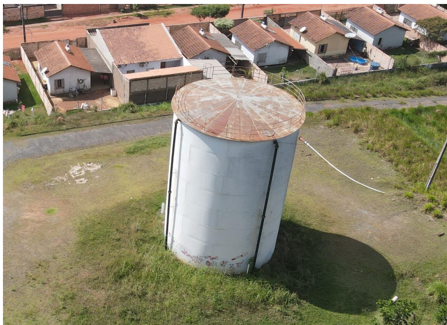
Figura 80. RAP-20, estrutura (panorâmica).
