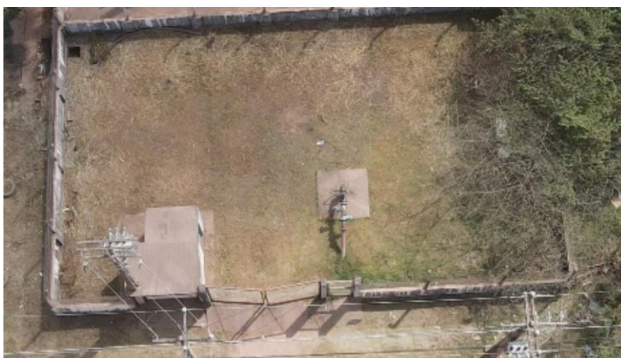
Figura 37. Captação – STM019 (panorâmica).
