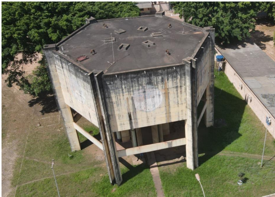
Figura 74. REL-07, estrutura (panorâmica).
