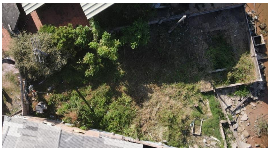
Figura 48. Captação – STM040 (inoperante).
