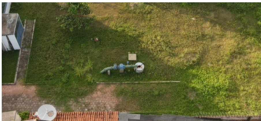
Figura 42. Captação – STM021 (panorâmica).
