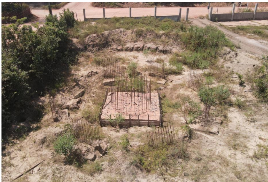
Figura 82. REL-22, base estrutural.
