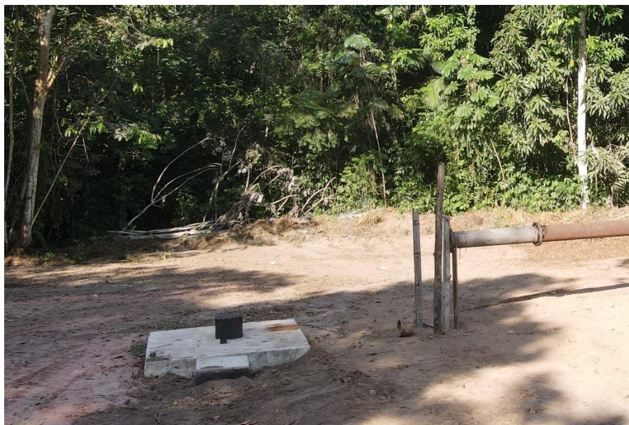
Figura 10. Captação – STM003 (inoperante).
