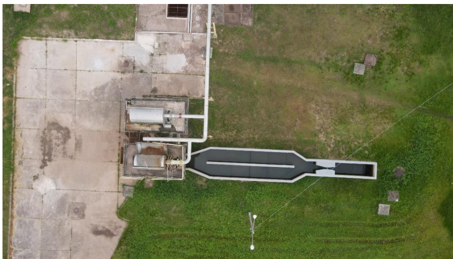
Figura 112. STM16-ETE Irurá, desarenador e medidor Parshall.
