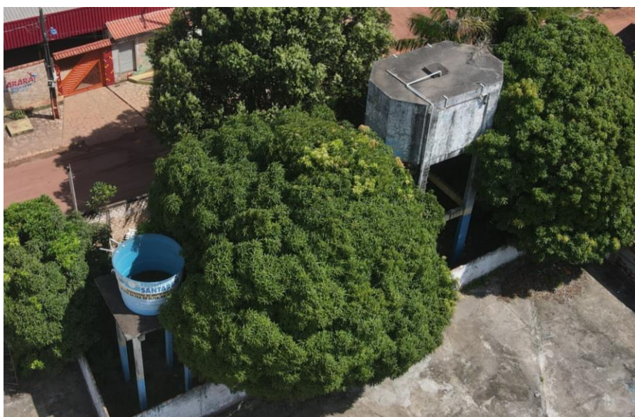
Figura 95. REL1-34 desativado e REL2-34, estrutura (panorâmica).
