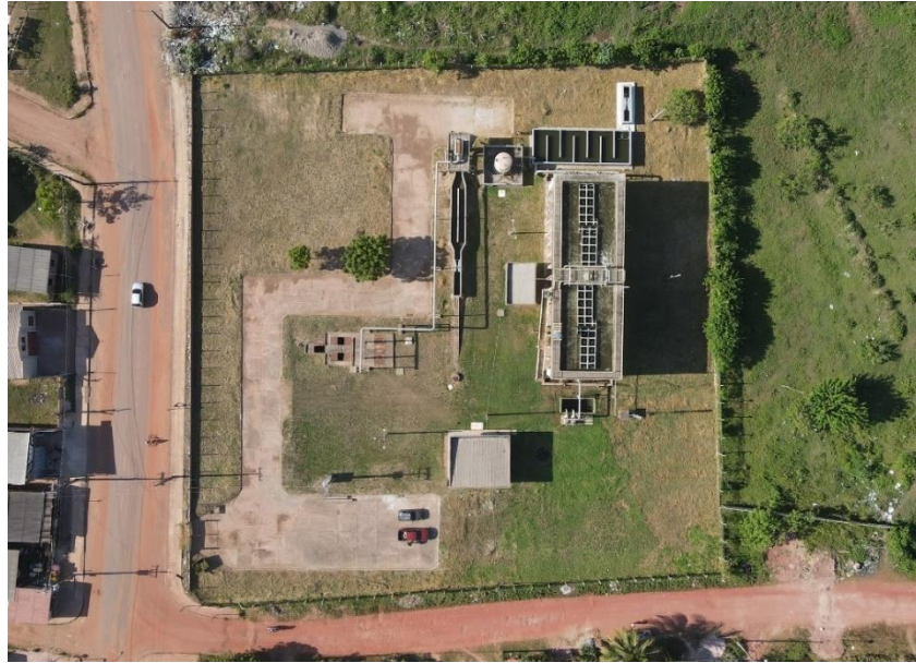
Figura 117. STM17-ETE Urumari, em operação (panorâmica).
