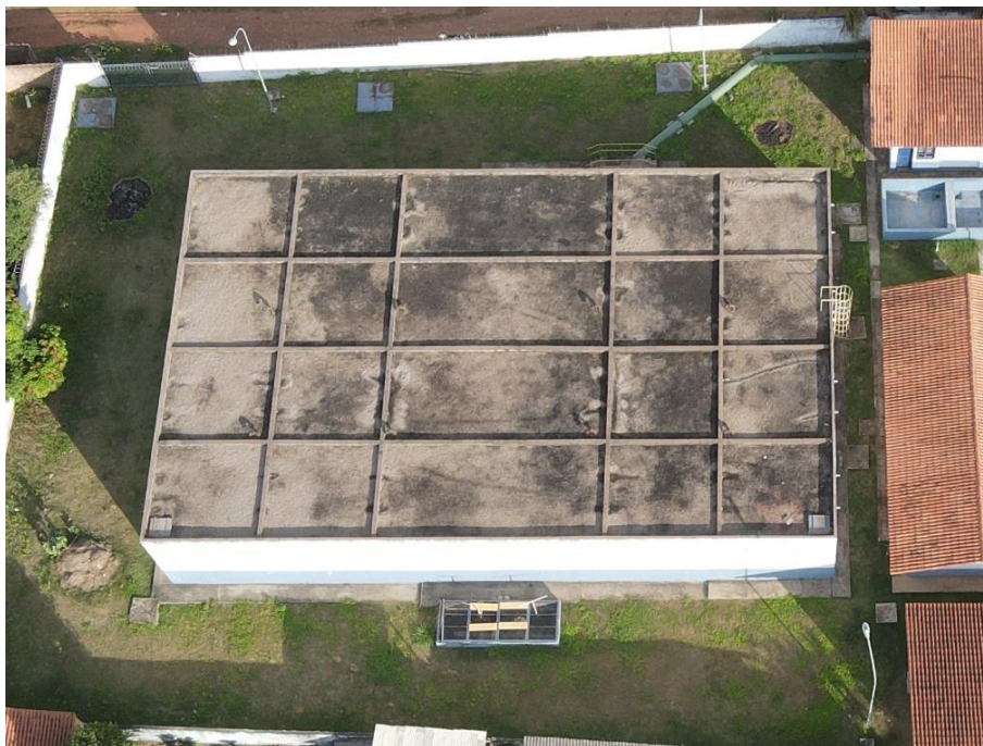
Figura 78. RAP-15, estrutura (panorâmica).
