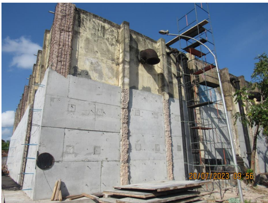
Figura 89. RAP-26 desativado, estrutura.
