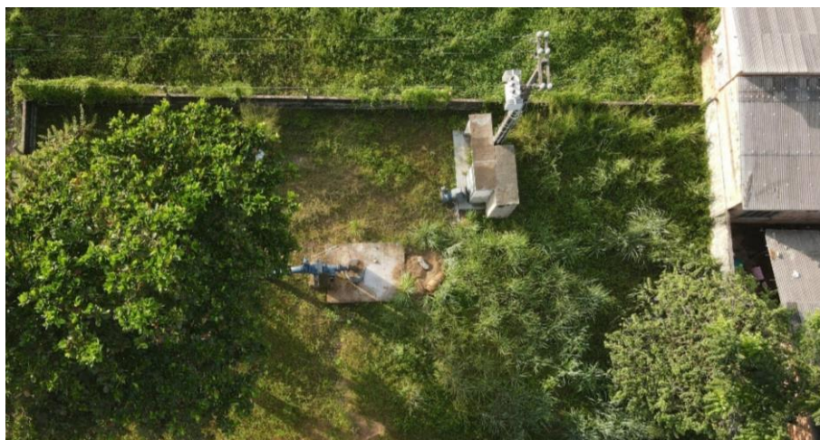
Figura 22. Captação – STM009 (panorâmica).
