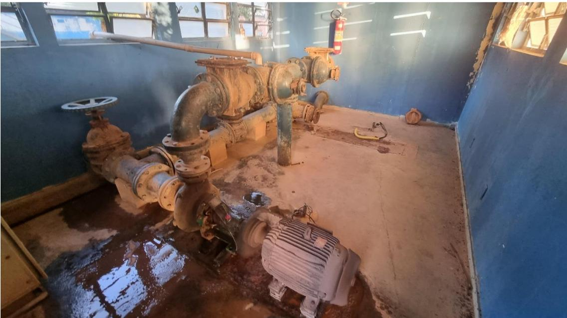
*Figura 9. EEAT 01, conjunto de motor-bomba.*
