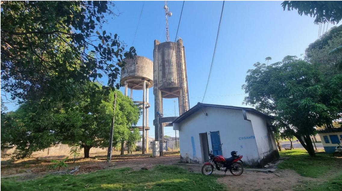
*Figura 13. Reservatório de Lavagem de Filtros e Elevado, (aproximado).
