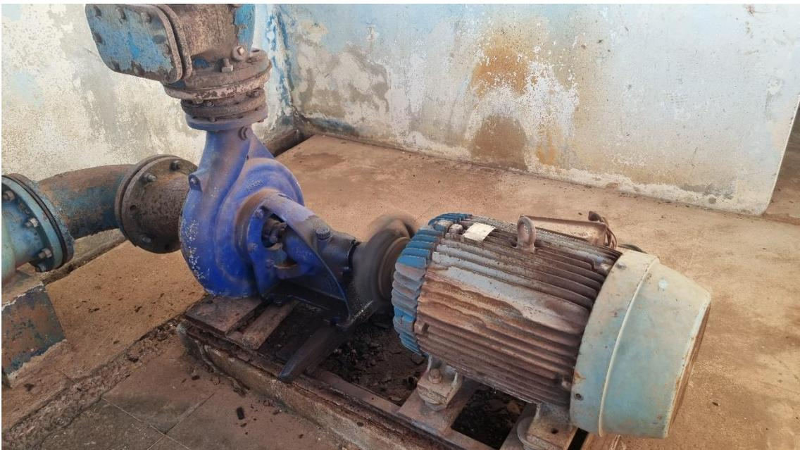
*Figura 5. EEAB 01, motor-bomba.*
