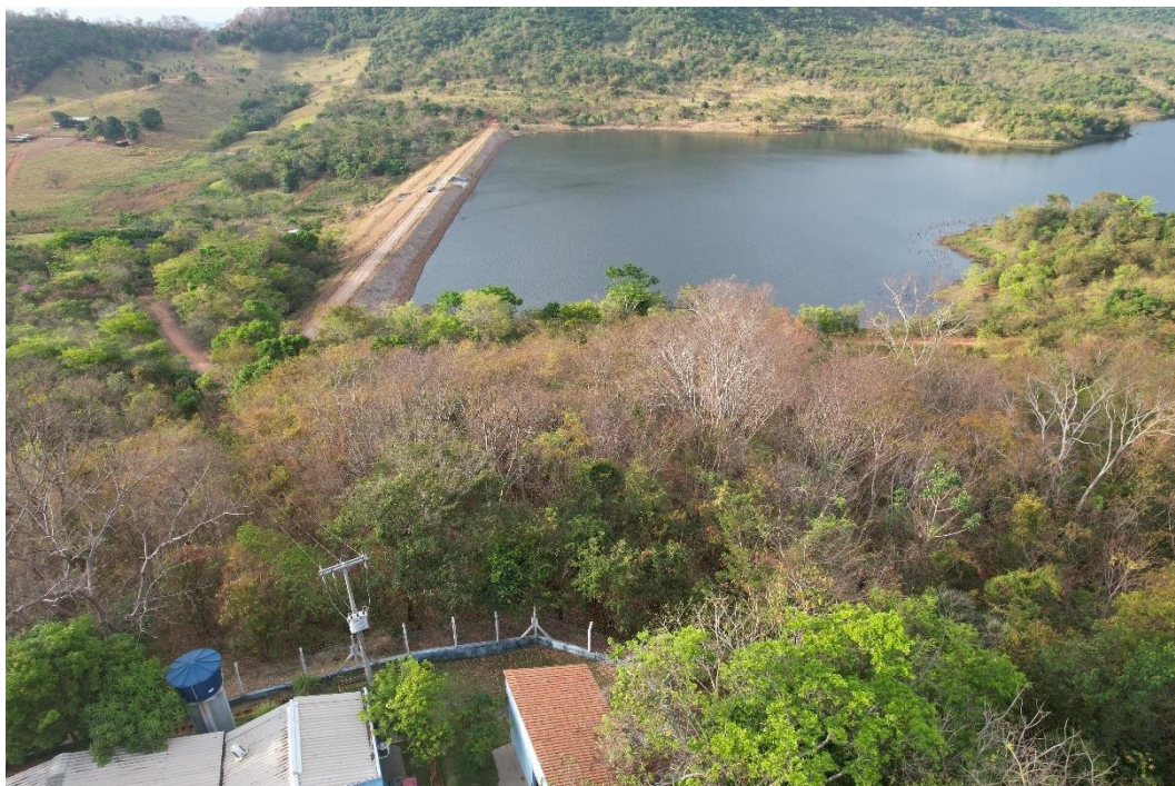
Figura 3. Captação Superficial de Água - CNA 01.
