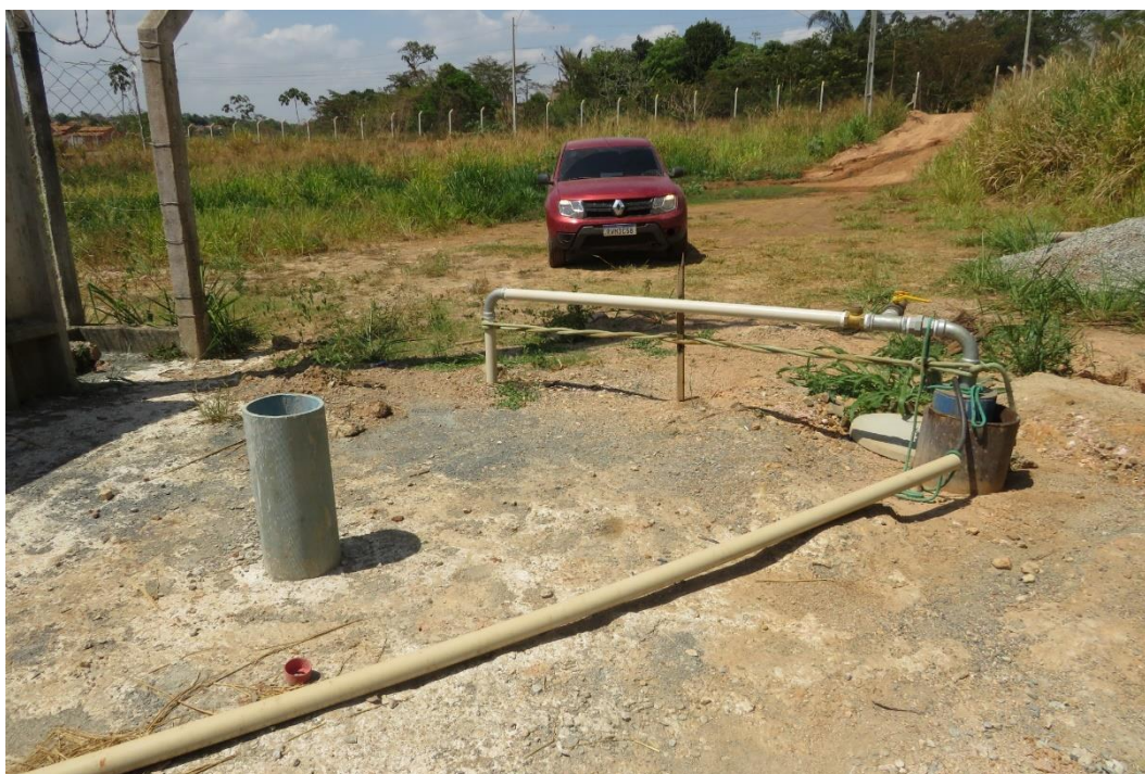
Figura 24. Captação de Água - CNA33 (poço tamponado)
