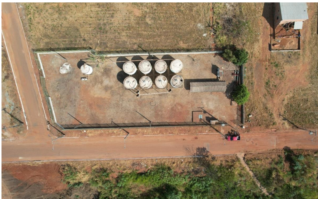
Figura 92. CNA05 - Estação de Tratamento de Esgotos (ETE)
