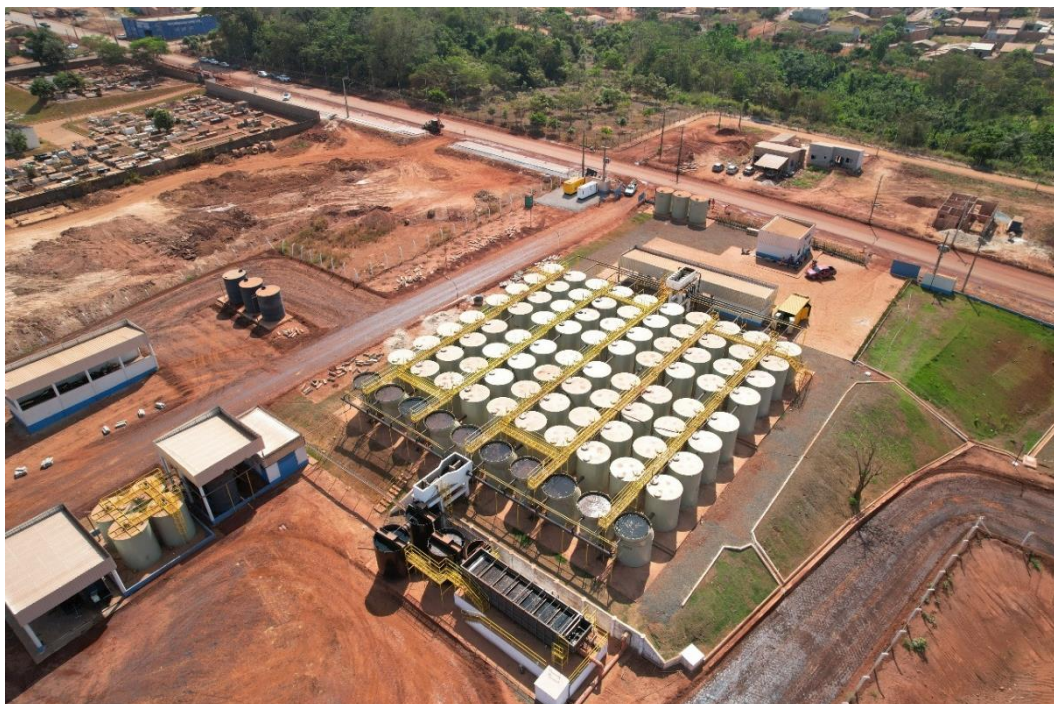
Figura 94. CNA06 - Estação de Tratamento de Esgotos (ETE)
