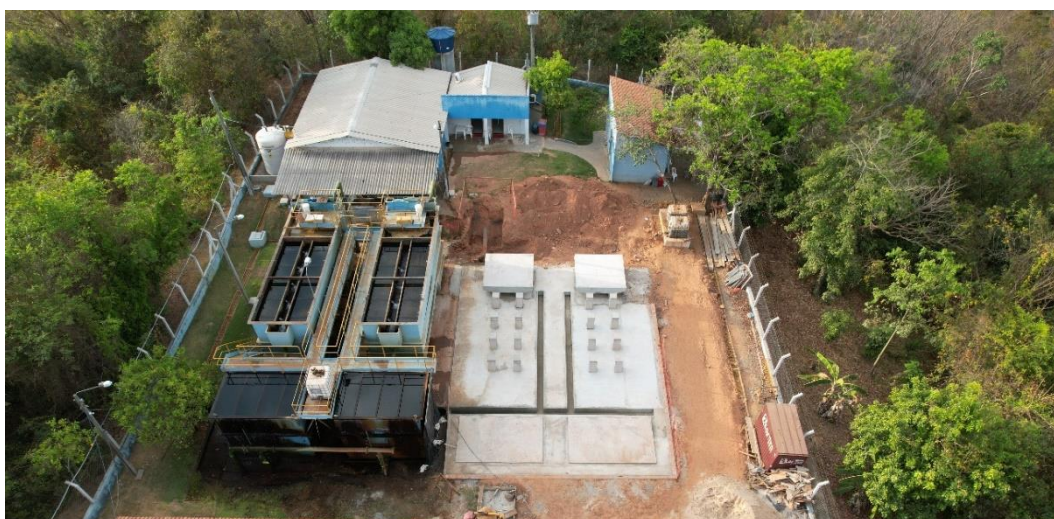
Figura 61. CNA01-ETA01-ETA- Estação de Tratamento de Água
