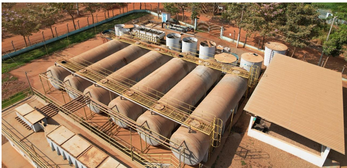
Figura 90. CNA04 - Estação de Tratamento de Esgotos (ETE)
