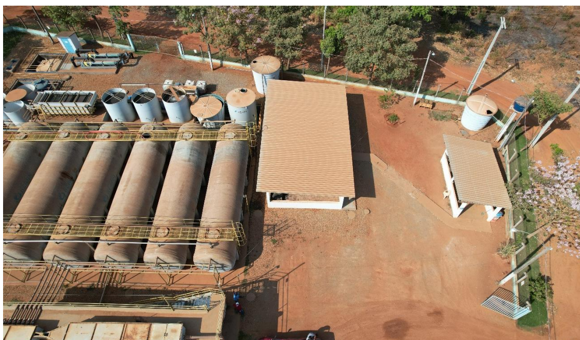
Figura 91. CNA04 - Estação de Tratamento de Esgotos (ETE)
