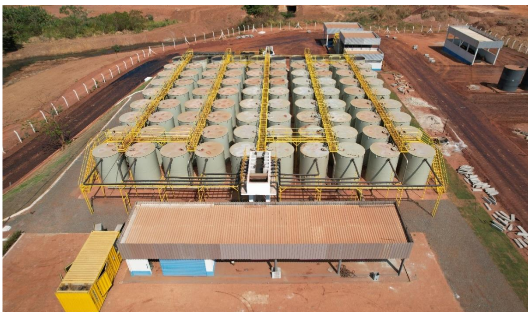
Figura 95. CNA06 - Estação de Tratamento de Esgotos (ETE)
