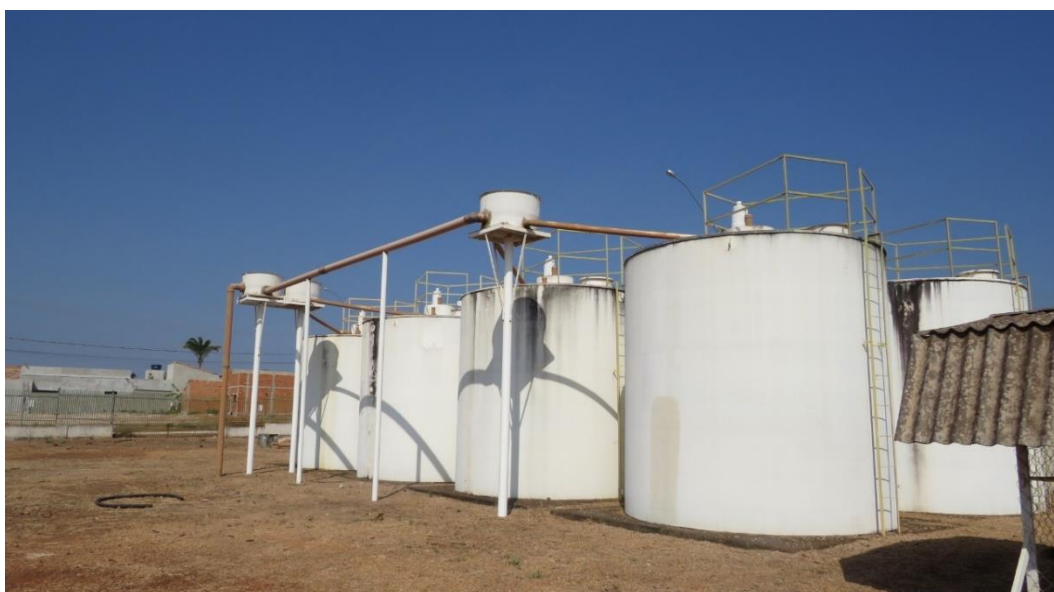
Figura 93. CNA05 - Estação de Tratamento de Esgotos (ETE)
