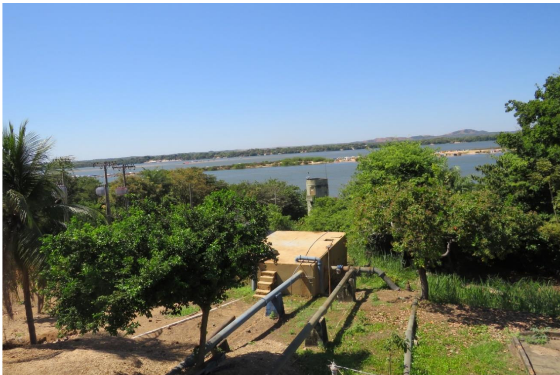
Figura 10. CNC01-RAP, (reservatório apoiado).
