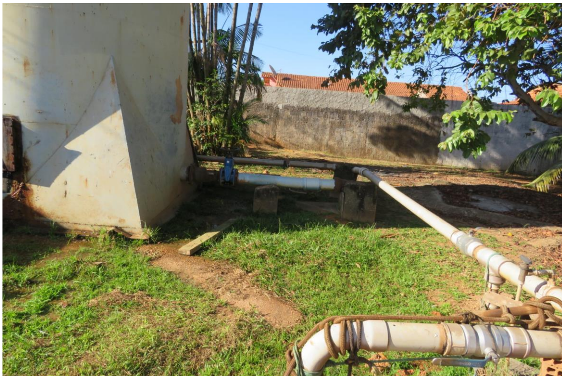
Figura 16. DOM13-CAPTAÇÃO, subterrâneo (poço tubular).
