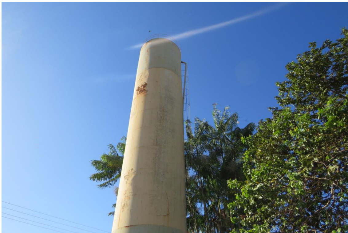
Figura 42. DOM13-REL, (reservatório elevado).
