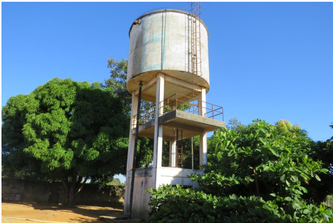
Figura 34. DOM06-REL, (reservatório elevado).
