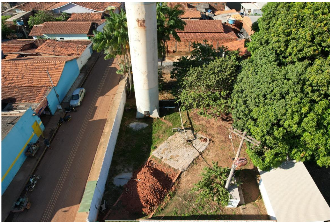
Figura 39. DOM10-REL, (reservatório elevado).
