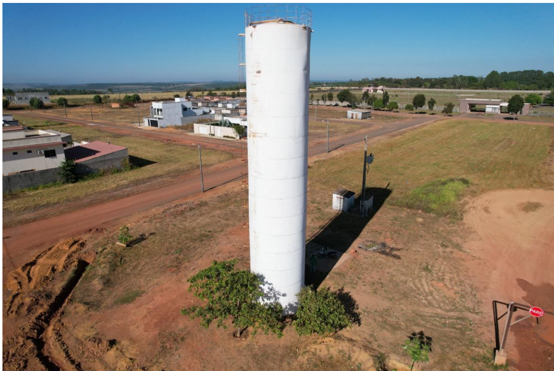
Figura 40. DOM11-REL, (reservatório elevado).
