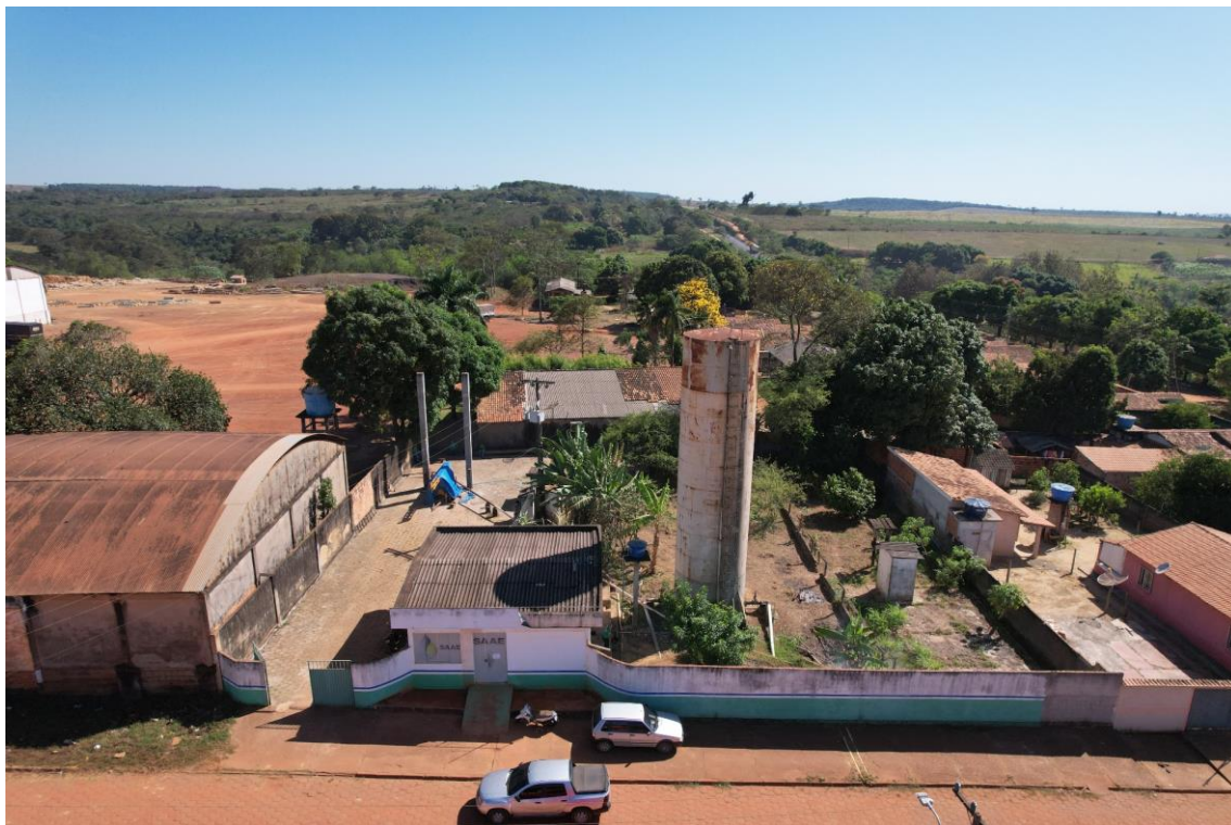
Figura 46. DOM16-REL, (reservatório elevado).
