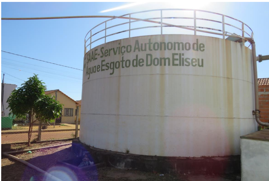
Figura 35. DOM08-RAP, (reservatório apoiado).
