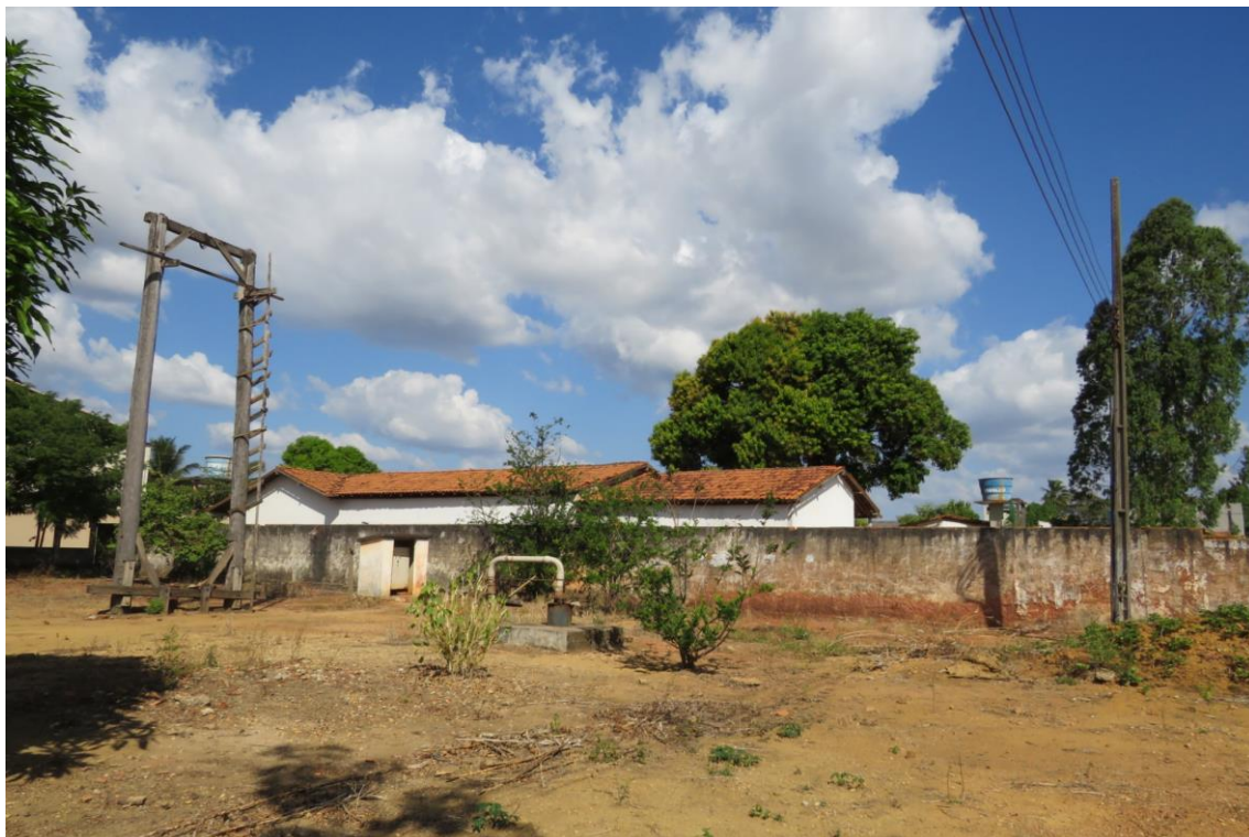
Figura 6. DOM02-CAPTAÇÃO, subterrâneo (poço tubular).
