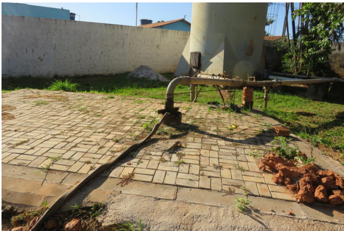
Figura 13. DOM10-CAPTAÇÃO, subterrâneo (poço tubular).
