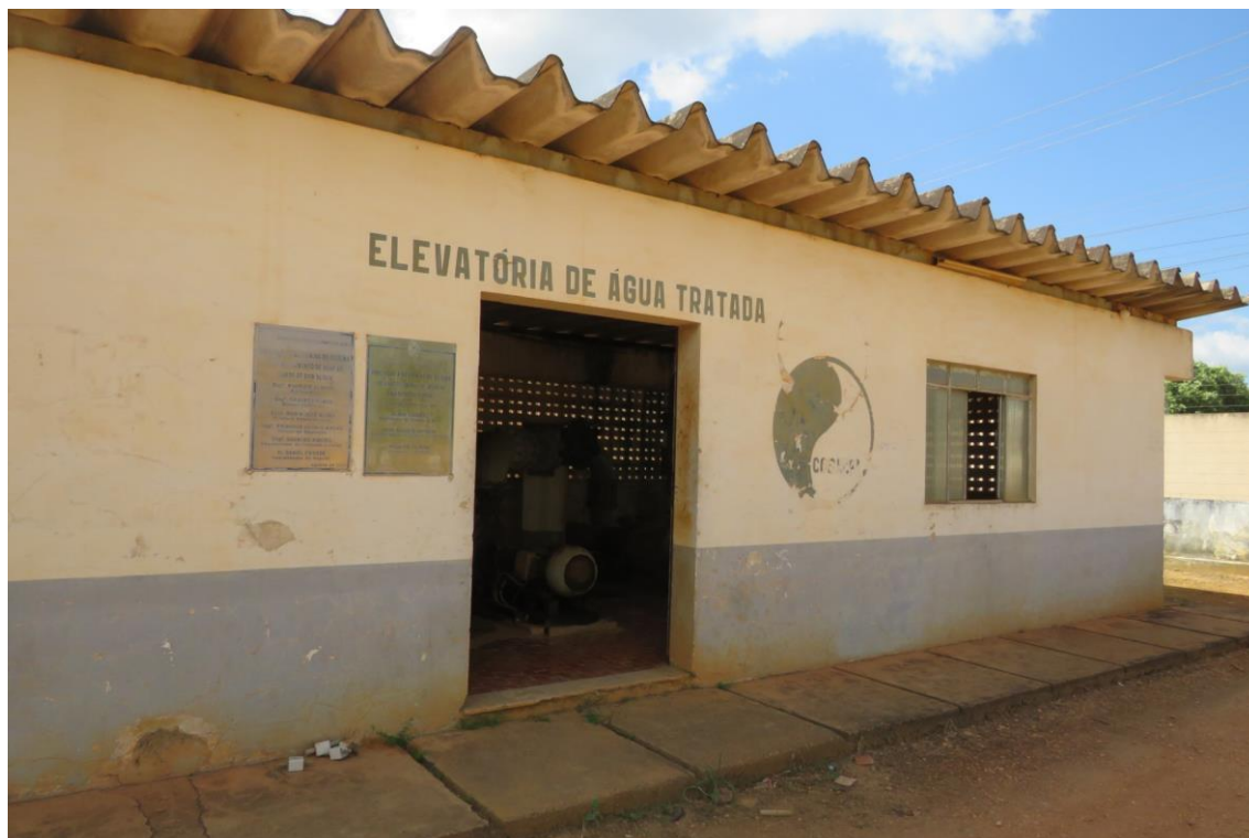
Figura 26. DOM02-EEAT, (Estação Elevatória de Água Tratada).
