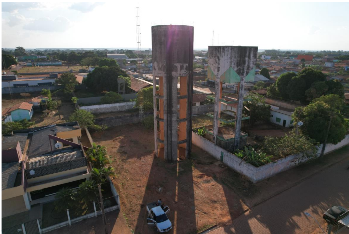
Figura 43. DOM12-REL02, (reservatório elevado).
