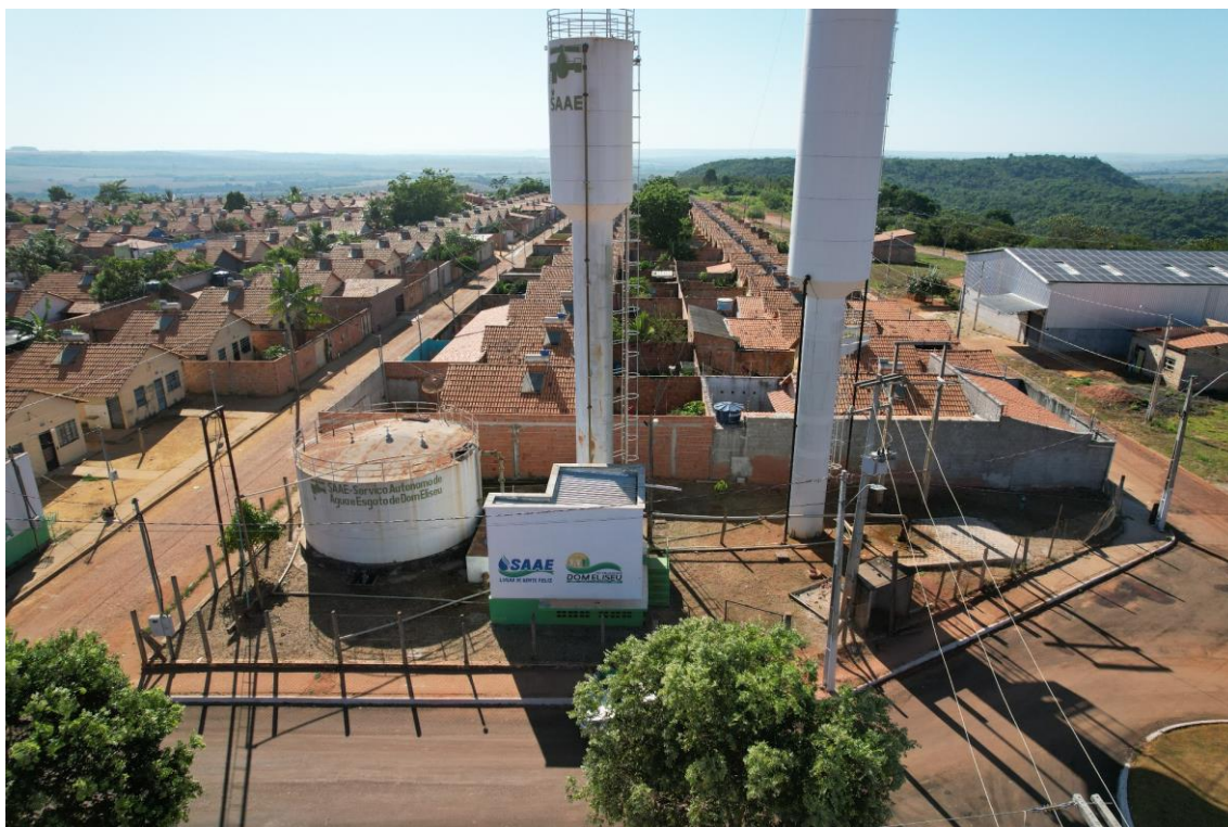
Figura 36. DOM08-REL01, (reservatório elevado).
