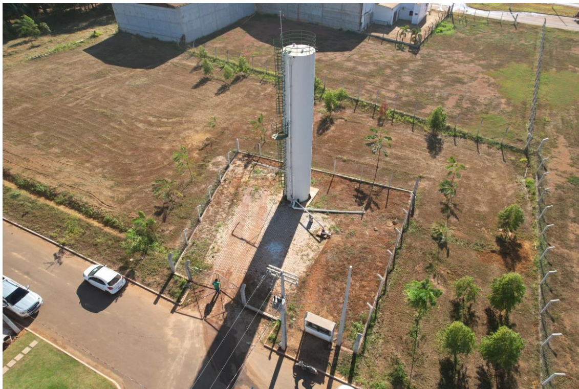
Figura 47. DOM18-REL, (reservatório elevado).
