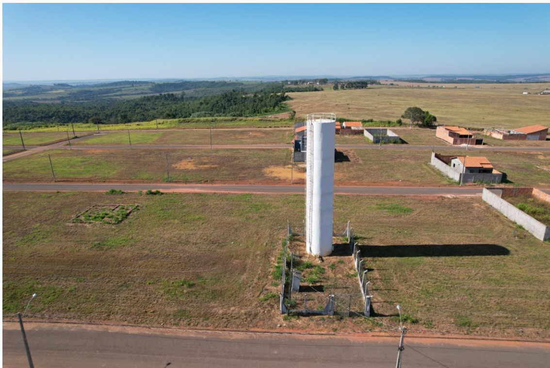
Figura 38. DOM09-REL, (reservatório elevado).
