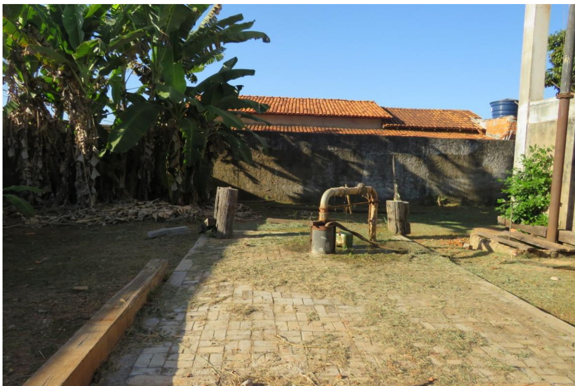
Figura 8. DOM04-CAPTAÇÃO, subterrâneo (poço tubular).
