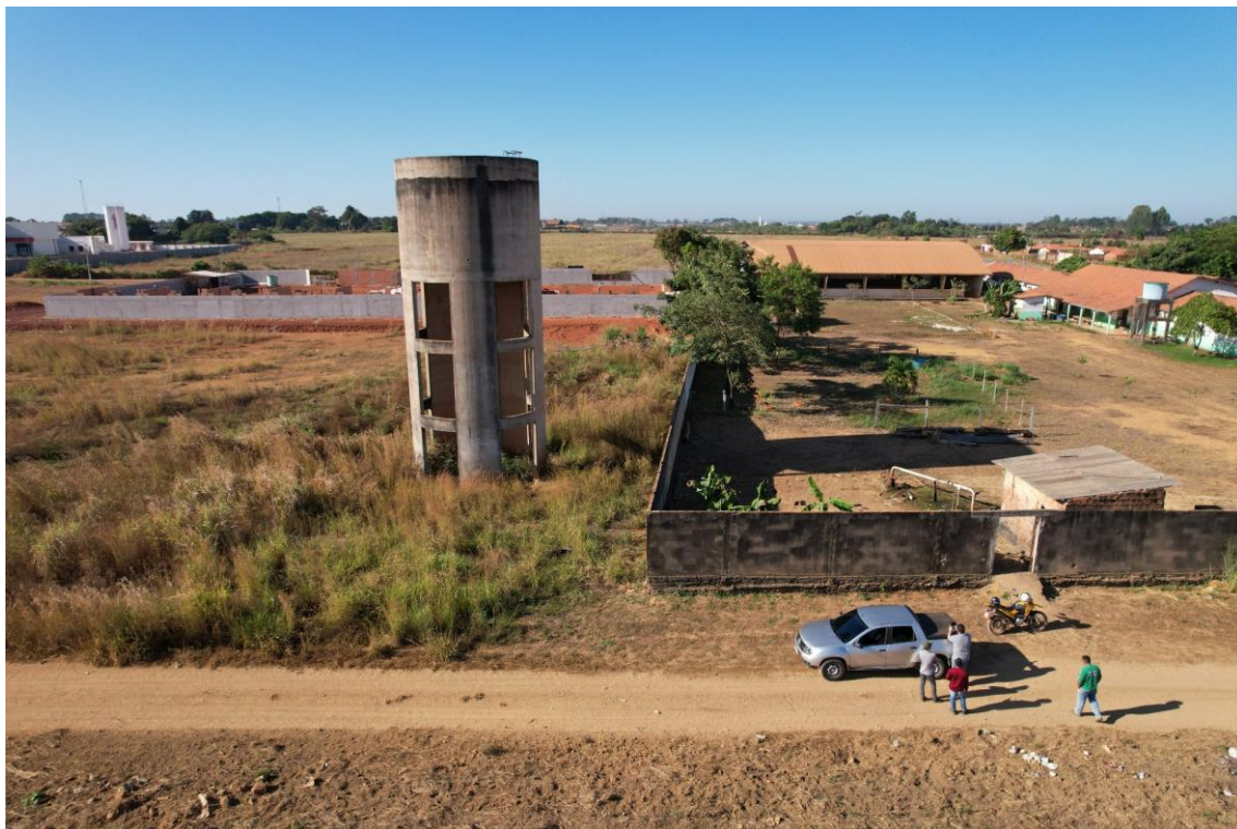
Figura 44. DOM14-REL, (reservatório elevado).
