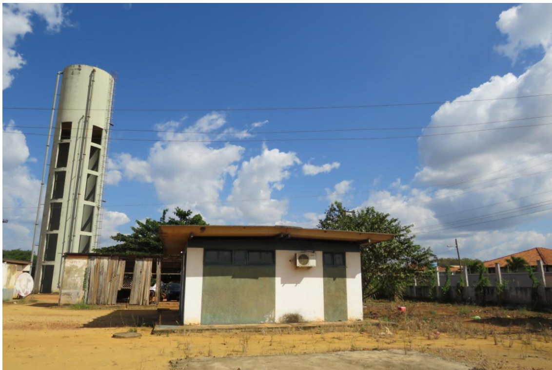
Figura 31 . DOM02-REL, reservatório elevado (lavagem de filtros).
