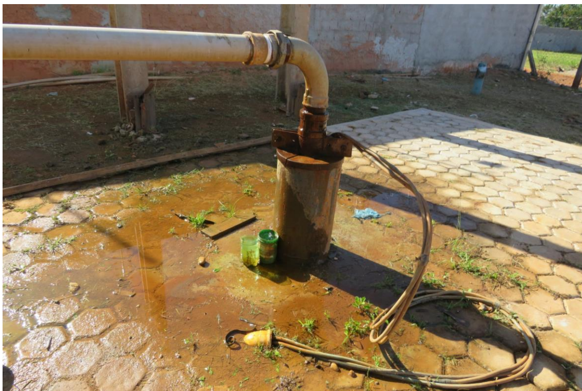
Figura 12. DOM08-CAPTAÇÃO, subterrâneo (poço tubular).
