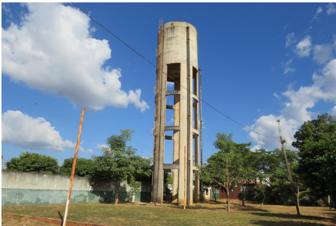
Figura 32. DOM03-REL, (reservatório elevado).
