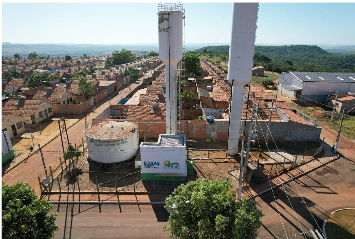
Figura 37. DOM08-REL02, (reservatório elevado).
