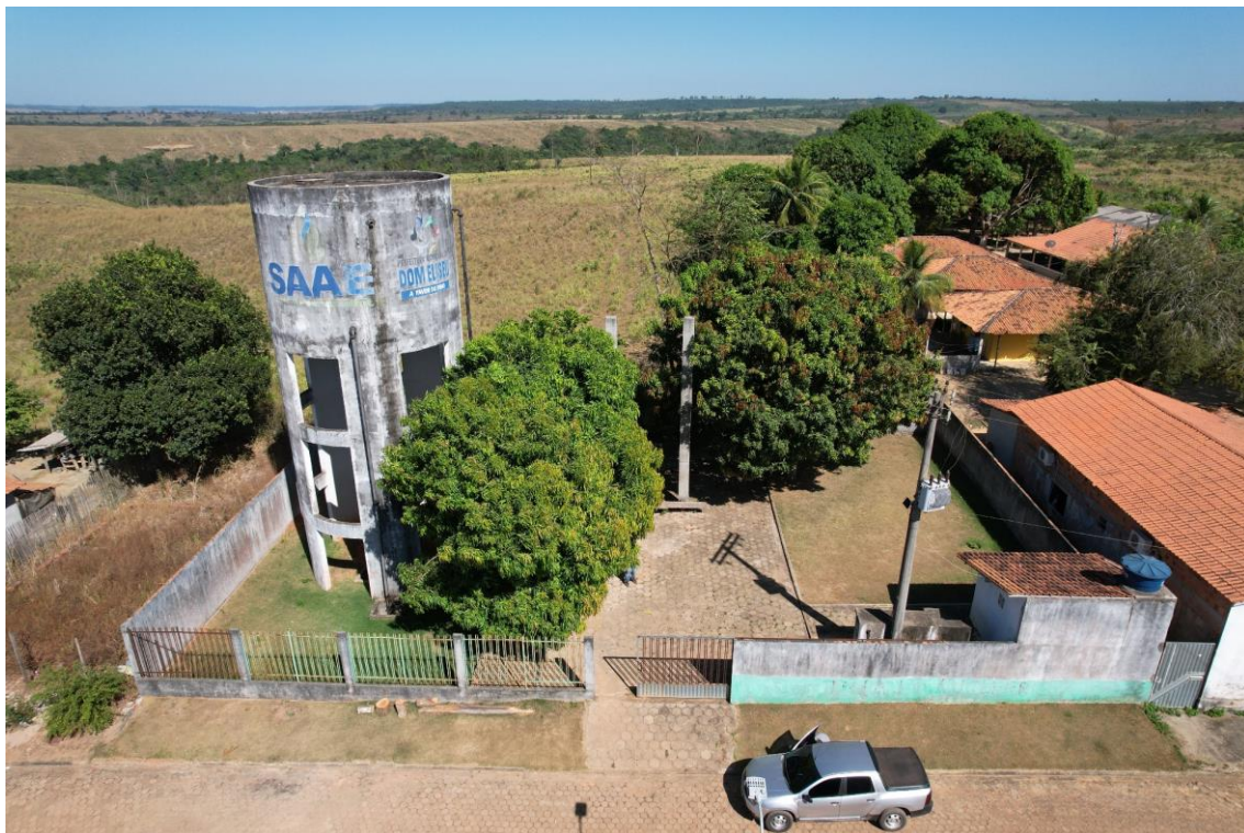
Figura 45. DOM15-REL, (reservatório elevado).
