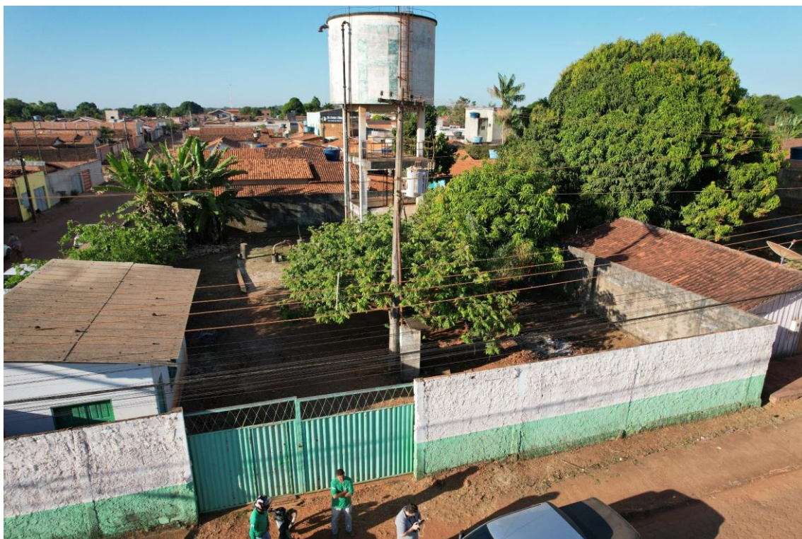
Figura 33. DOM04-REL, (reservatório elevado).
