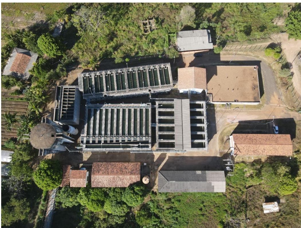
Figura 7. MRB01-ETA- Estação de Tratamento de Água, Nova Marabá.
