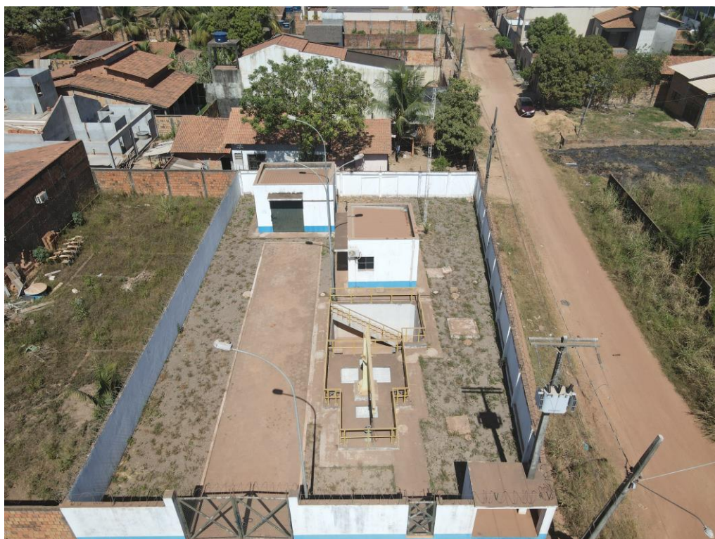
Figura 29. MRB09 - Estação Elevatória de Esgoto (EEE - E)
