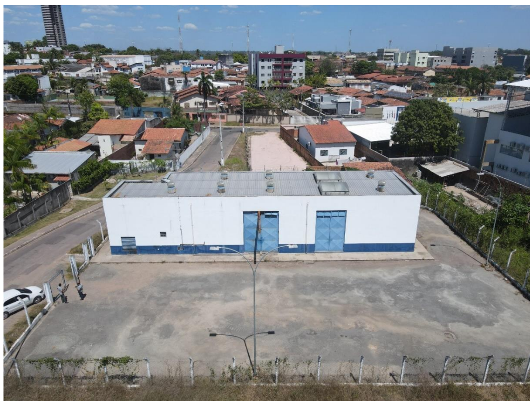
Figura 31. MRB11- Estação Elevatória de Esgoto (EEE – GROTA).
