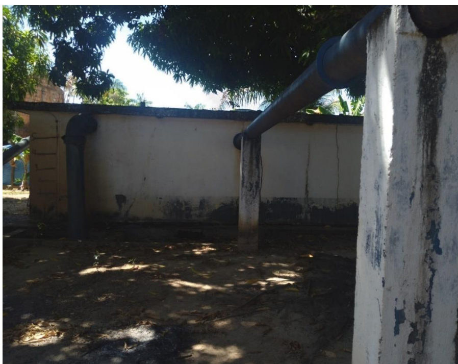
Figura 14. MRB02-RAP, reservatório Apoiado.
