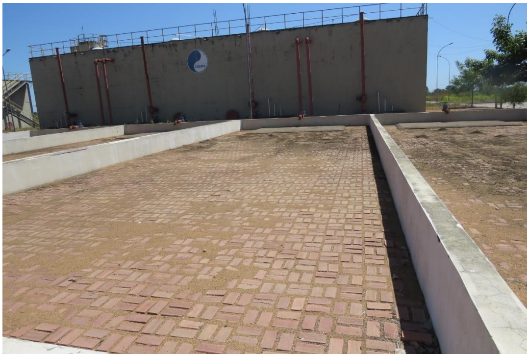
Figura 36. MRB10 – Leito de Secagem da Estação de Tratamento de Esgoto (ETE).
