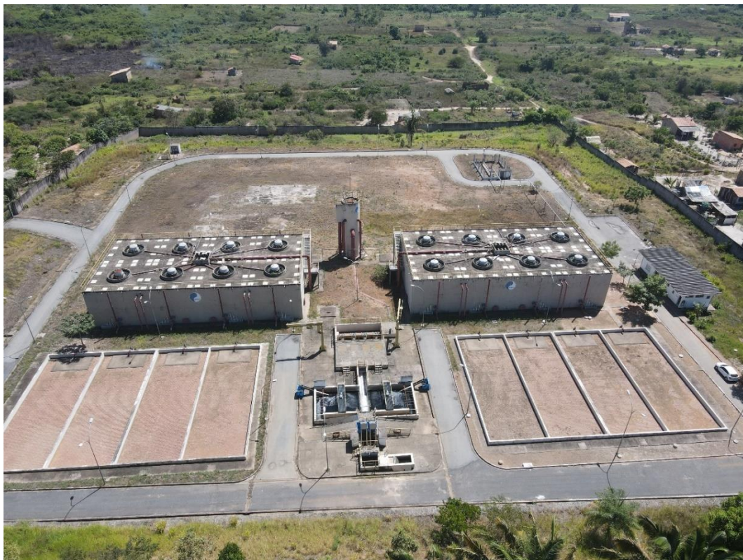
Figura 35. MRB10-Estação de Tratamento de Esgoto (ETE).
