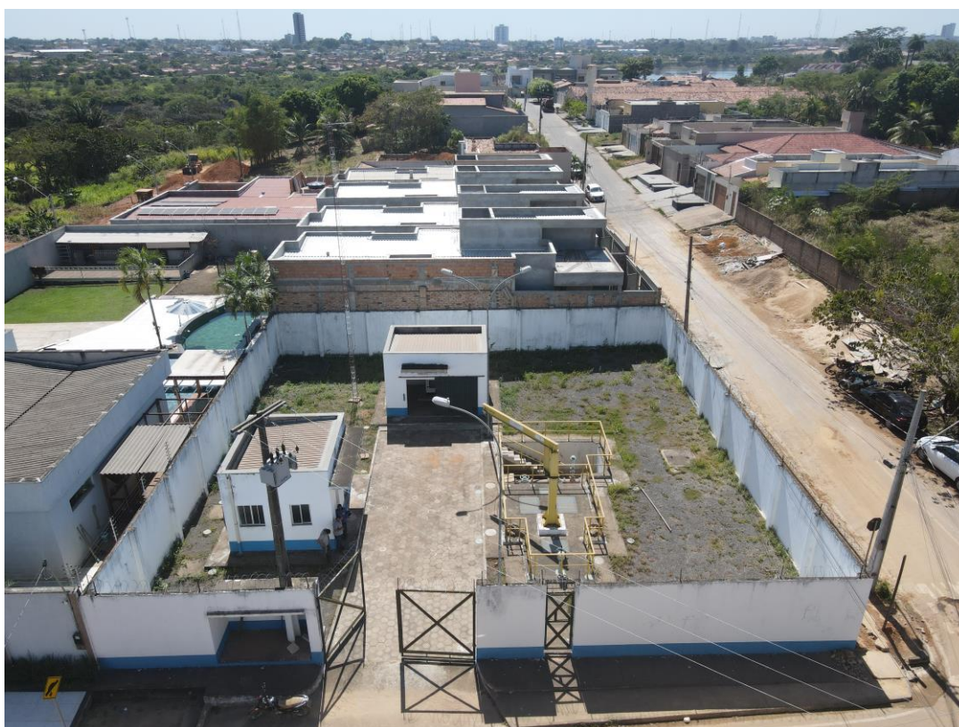
Figura 27. MRB08- Estação Elevatória de Esgoto (EEE - D) Fonte: Consórcio, 2023
