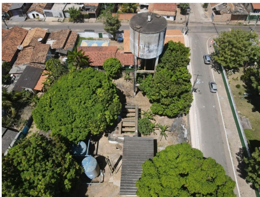
Figura 6. MRB02-ETA- Estação de Tratamento de Água, Marabá Pioneira.
