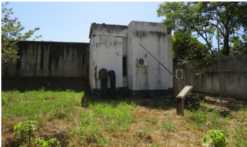
Figura 15. MRB03-RAP, reservatório Apoiado.
