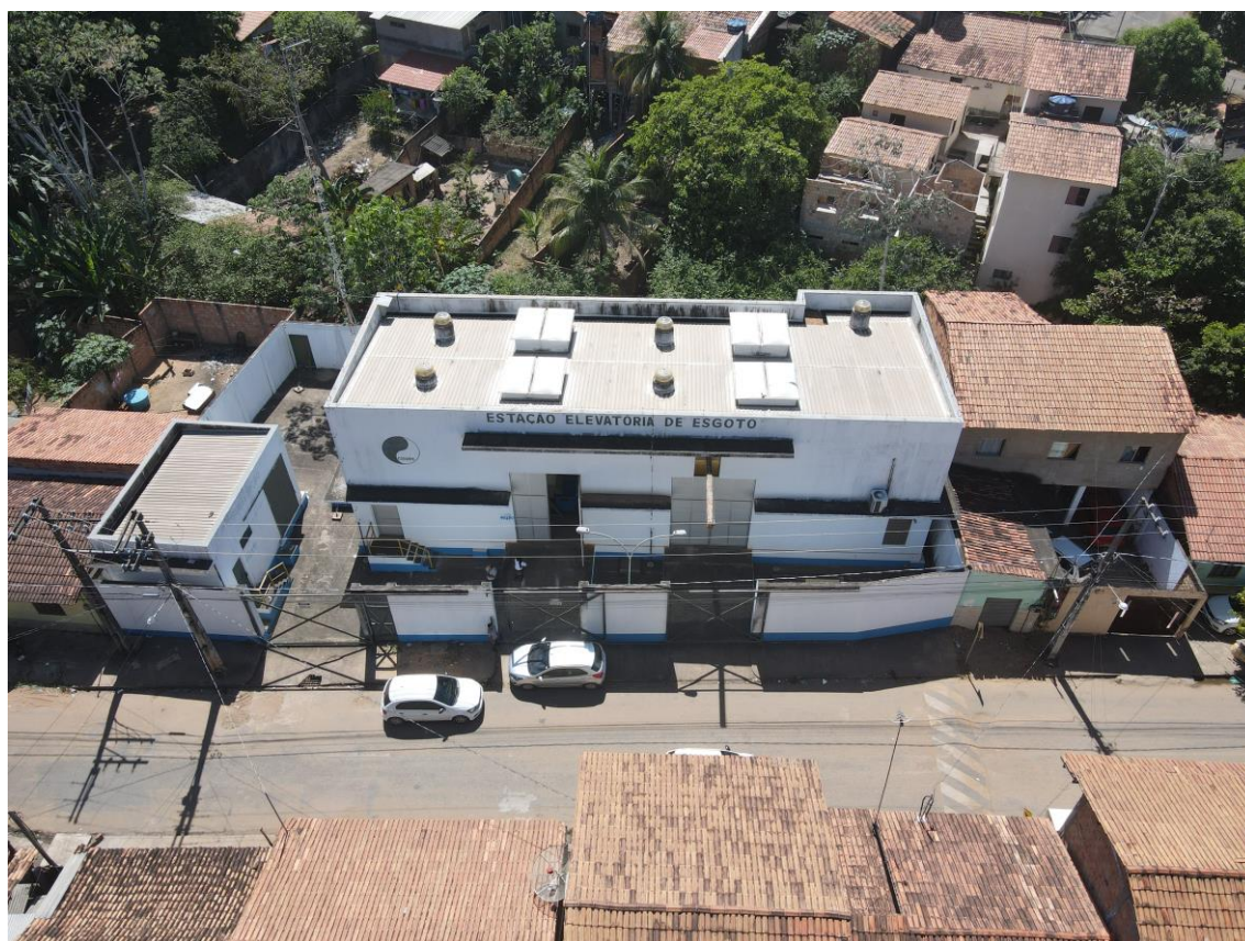
Figura 25. MRB06- Estação Elevatória de Esgoto (EEE – A)
