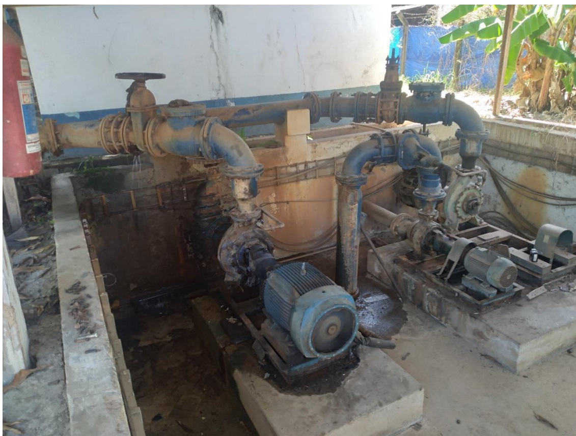
Figura 9. MRB02-EEAT Marabá Pioneira, conjunto de motobombas.
