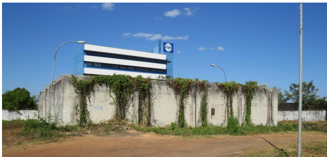
Figura 18. MRB04-RAP01, reservatório Apoiado.
