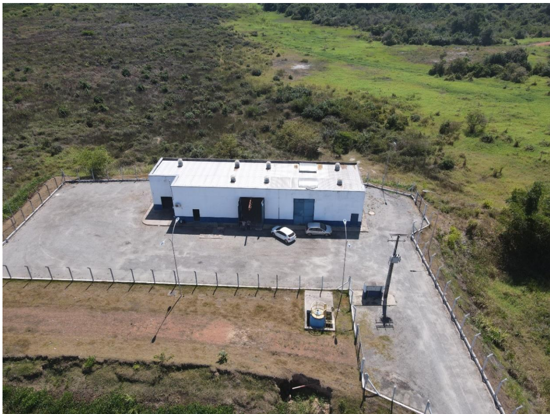
Figura 33. MRB12-Estação Elevatória de Esgoto (EEE - ITACAIUNAS).
