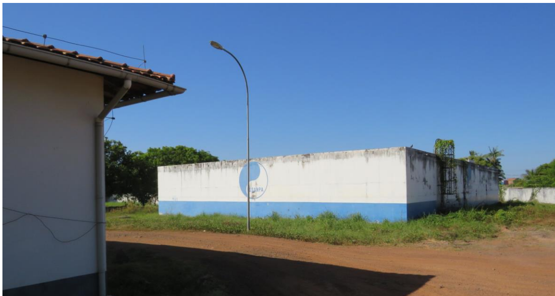
Figura 19. MRB04-RAP02, reservatório Apoiado.
