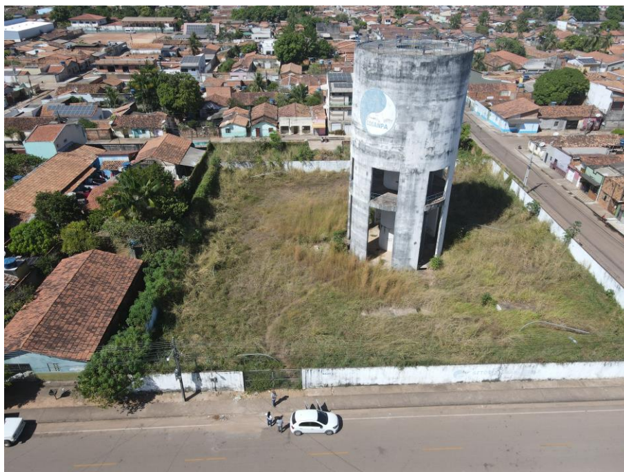
Figura 22. MRB07-REL, reservatório elevado.
