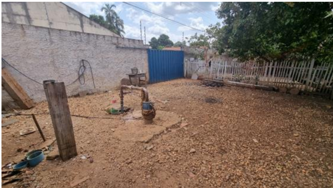
Figura 11. RON07-CAPTAÇÃO, captação subterrânea (bairro Gusmão).
