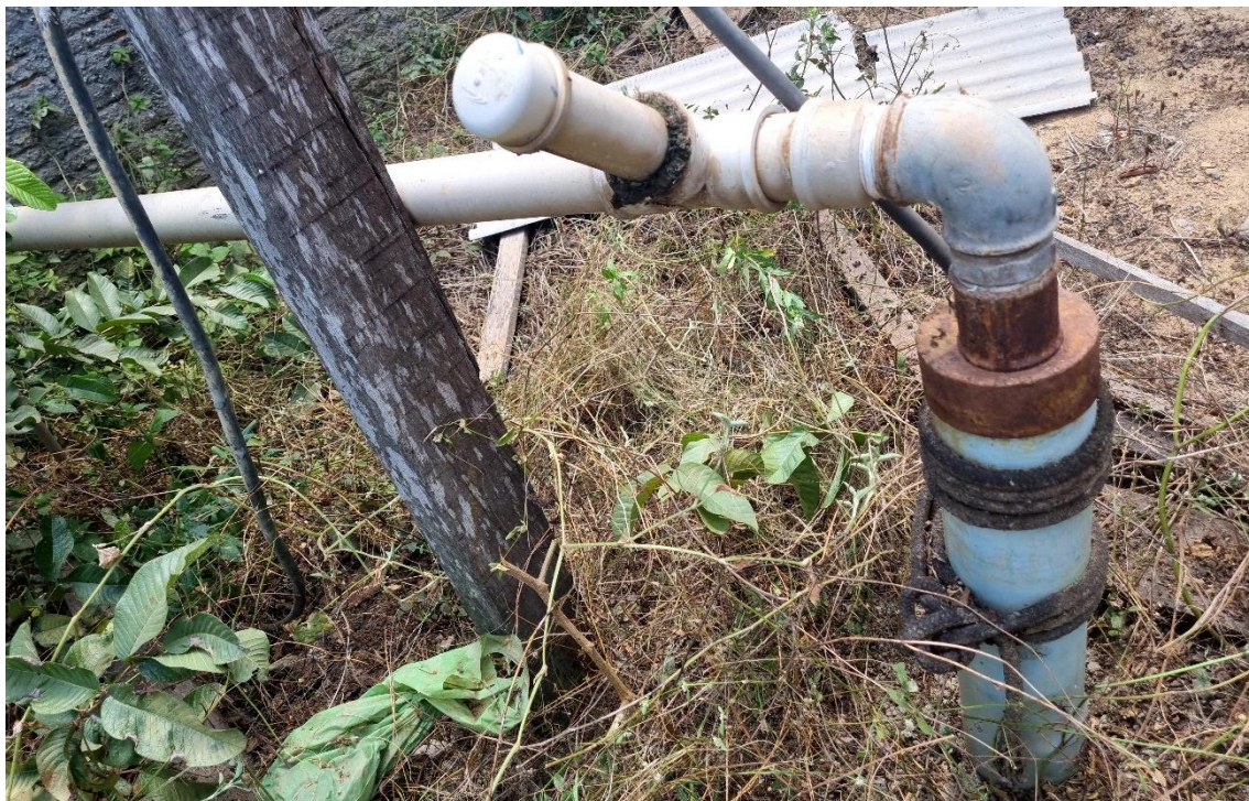
Figura 9. RON05-CAPTAÇÃO, captação subterrânea (bairro João Miranda).
