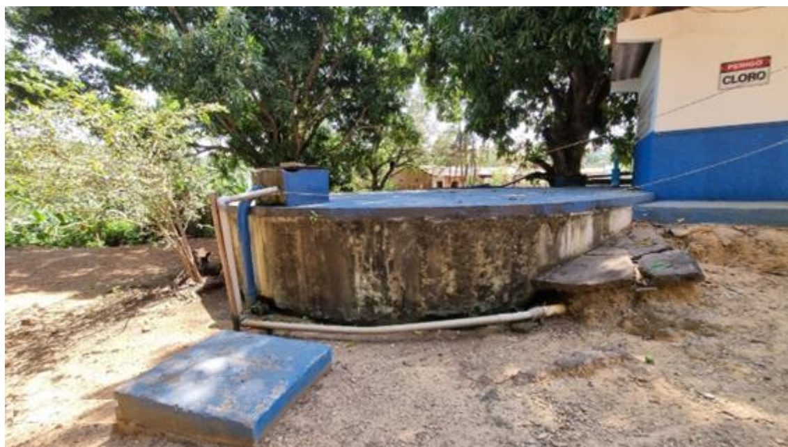
Figura 30. Reservatório apoiado (RON01-RAP), estrutura.
