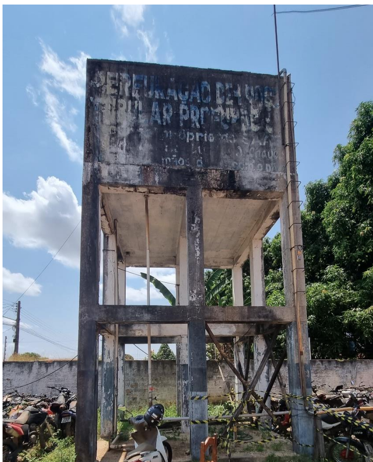
Figura 33. Reservatório elevado (RON04-REL), estrutura.
