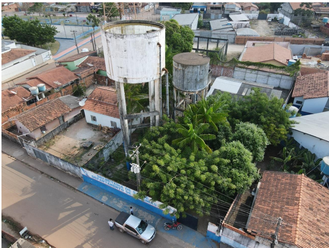
Figura 40. Reservatórios elevados (RON09-REL01 e RON09-REL02, respectivamente, da direita para esquerda), estruturas.
