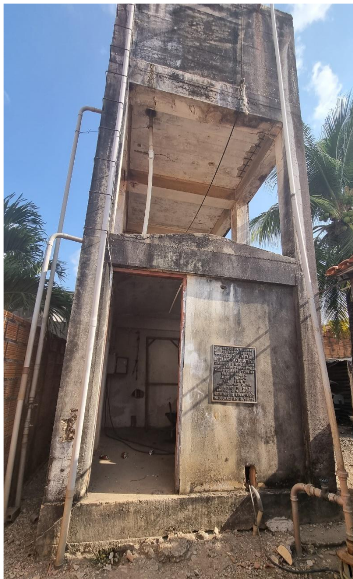
Figura 41. Reservatório elevado (RON14-REL), estrutura.
