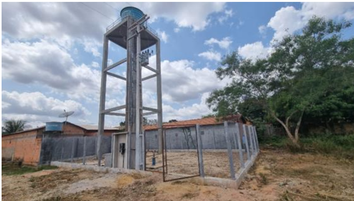
Figura 35. Reservatório elevado (RON08-REL), estrutura – em implantação.
