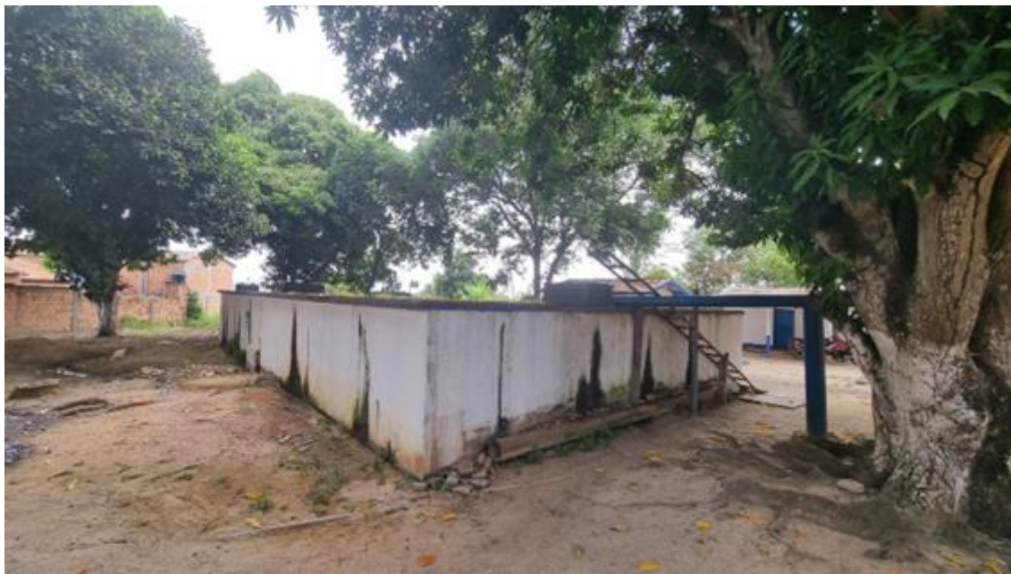
Figura 37. Reservatório apoiado (RON10-RAP), estrutura.
