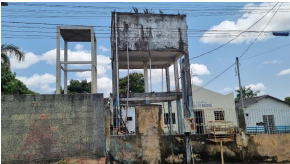
Figura 34. Reservatório elevado (RON05-REL), estrutura.
