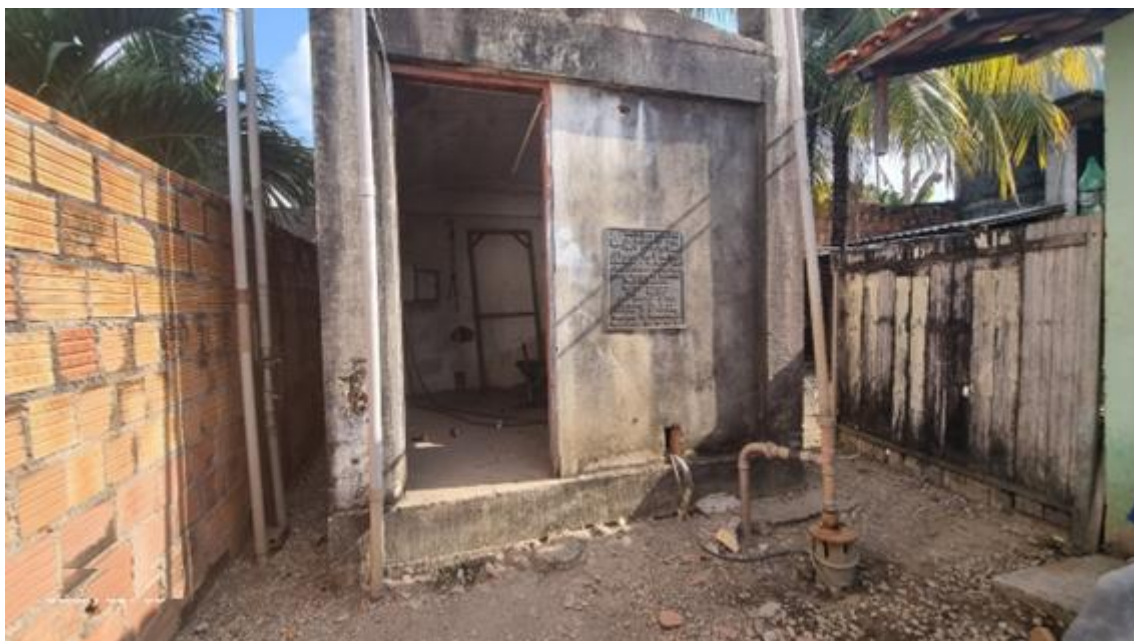
Figura 24. RON14-CAPTAÇÃO, captação subterrânea (bairro Centro/Poço do Branco). Fonte: Consórcio, 2023.
