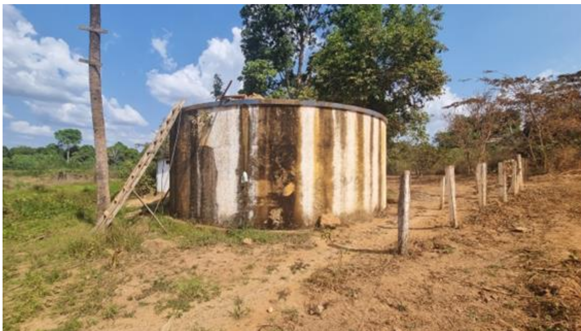
Figura 39. Reservatório apoiado (RON12-RAP), estrutura.
