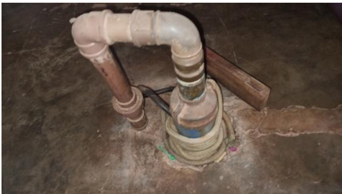
Figura 10. RON06-CAPTAÇÃO, captação subterrânea (bairro João Miranda).
