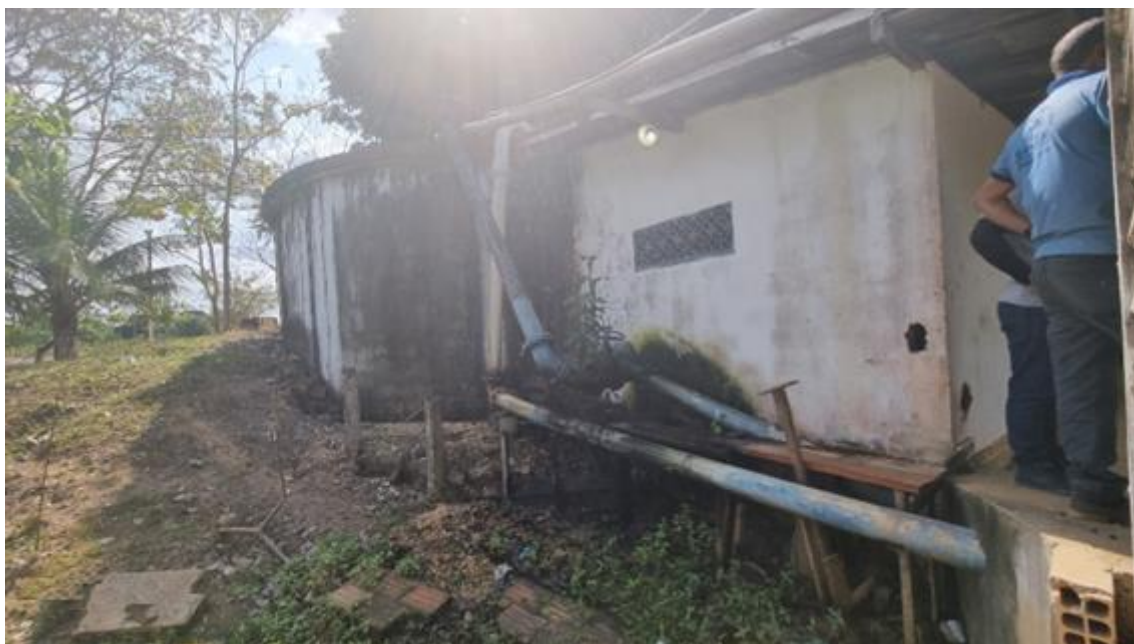
Figura 38. Reservatório apoiado (RON11-RAP), estrutura.
