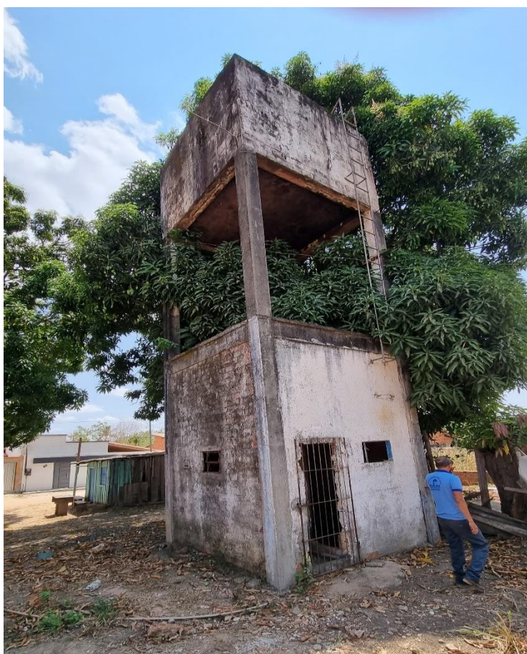
Figura 32. Reservatório elevado (RON03-REL), estrutura.
