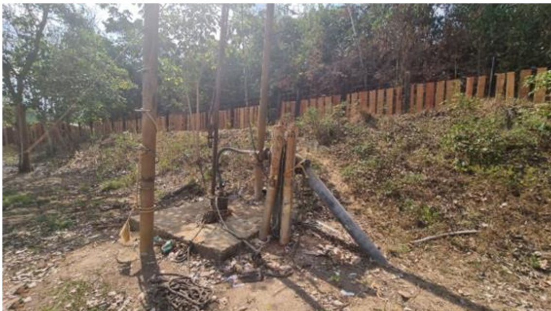
Figura 18. RON11-CAPTAÇÃO003, captação subterrânea (bairro Jaderlândia/Baixo Recalque).
