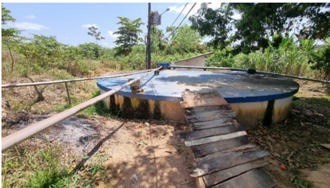
Figura 31. Reservatório apoiado (RON02-RAP), estrutura.
