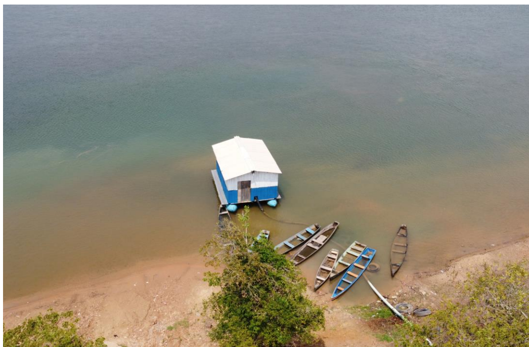
Figura 4. Captação – SFX01, Sistema Flutuante (panorâmica).
