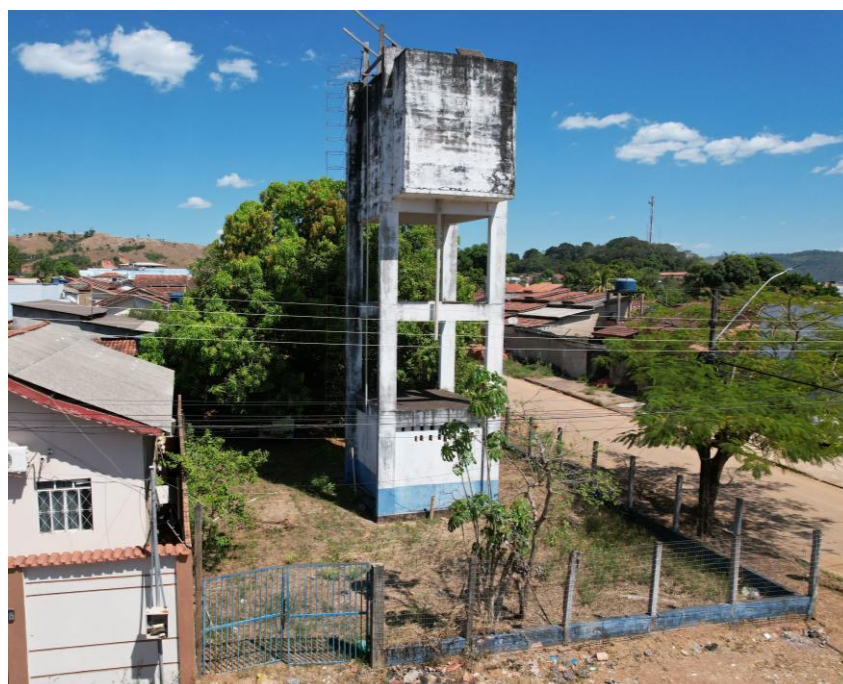
Figura 18. REL desativado – SFX05, estrutura (panorâmica).
