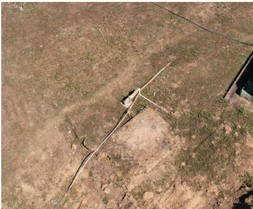
Figura 11. Captação – SFX13. Poço Tubular (panorâmica)
