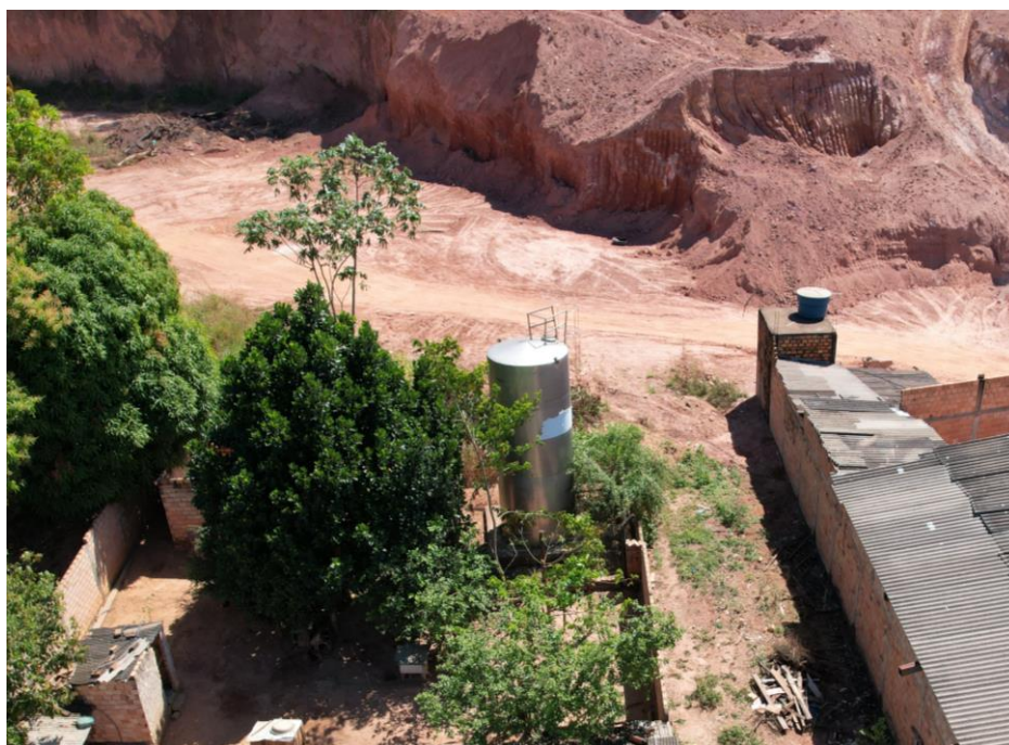
Figura 20. REL – SFX08, estrutura (panorâmica).
