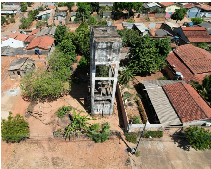
Figura 19. REL – SFX06, estrutura (panorâmica).
