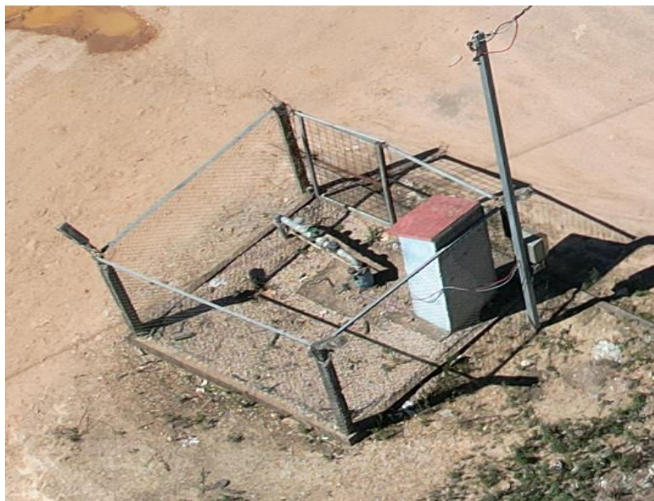
Figura 10. Captação – SFX11, poço tubular (panorâmica).
