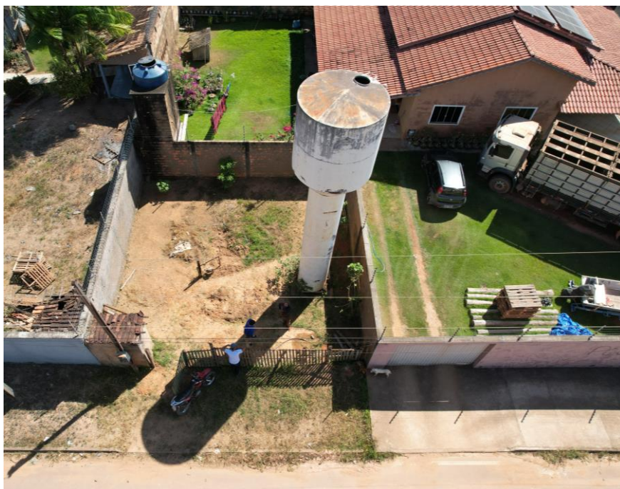
Figura 21. REL – SFX15, estrutura (panorâmica).
