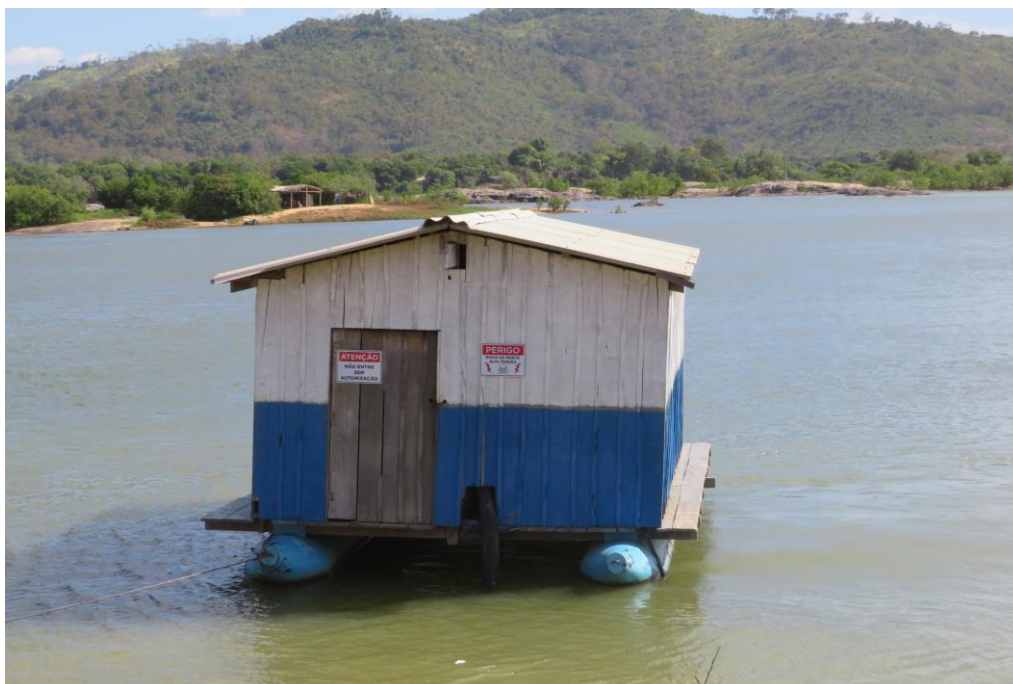
Figura 3. Captação – SFX01, sistema flutuante (aproximada).
