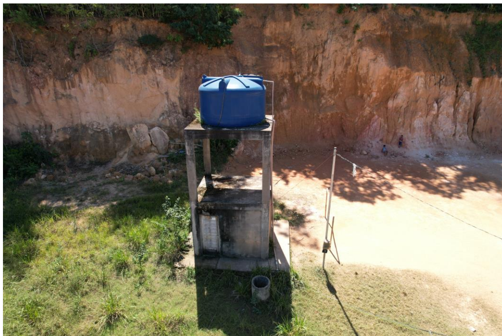
Figura 17. REL – SFX04, estrutura (panorâmica).
