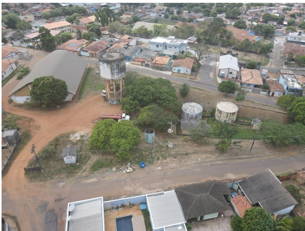
Figura 33. Reservatórios – TUI02, Vista panorâmica.
