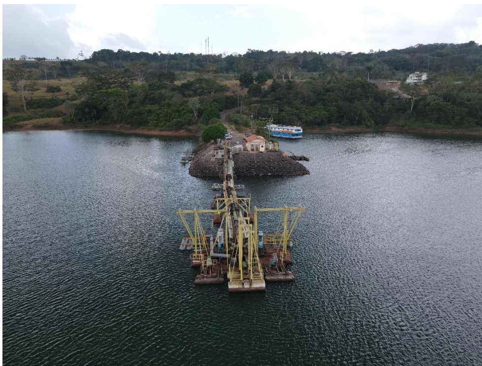
Figura 13. Captação – TUI12, Vista panorâmica.
