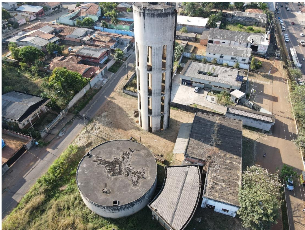
Figura 40. Reservatórios – TUI10, Vista panorâmica.
