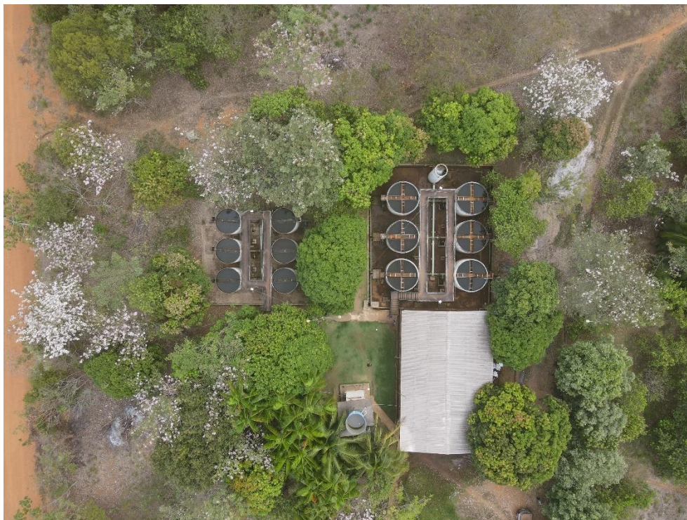
Figura 14. ETA – TUI01, Vista panorâmica
