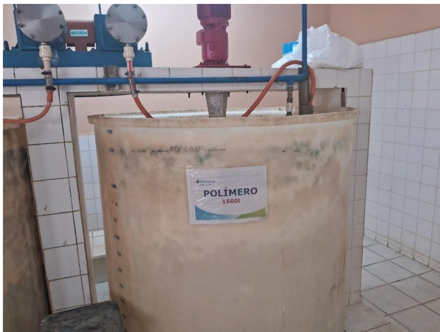
Figura 21. ETA – TUI01, Casa de química 02.
