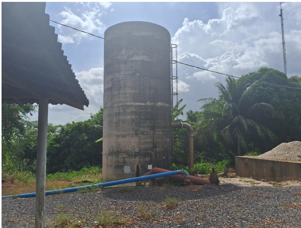
Figura 42. REL02 – TUI11, Estrutura.
