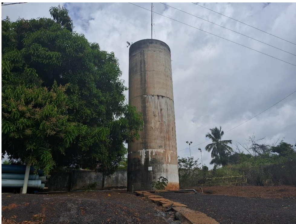
Figura 41. REL01 – TUI11, Estrutura.
