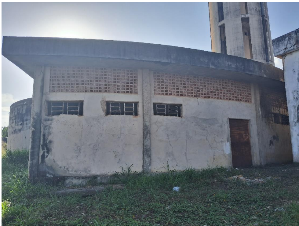
Figura 27. EEAT – TUI10, Estação desativada.
