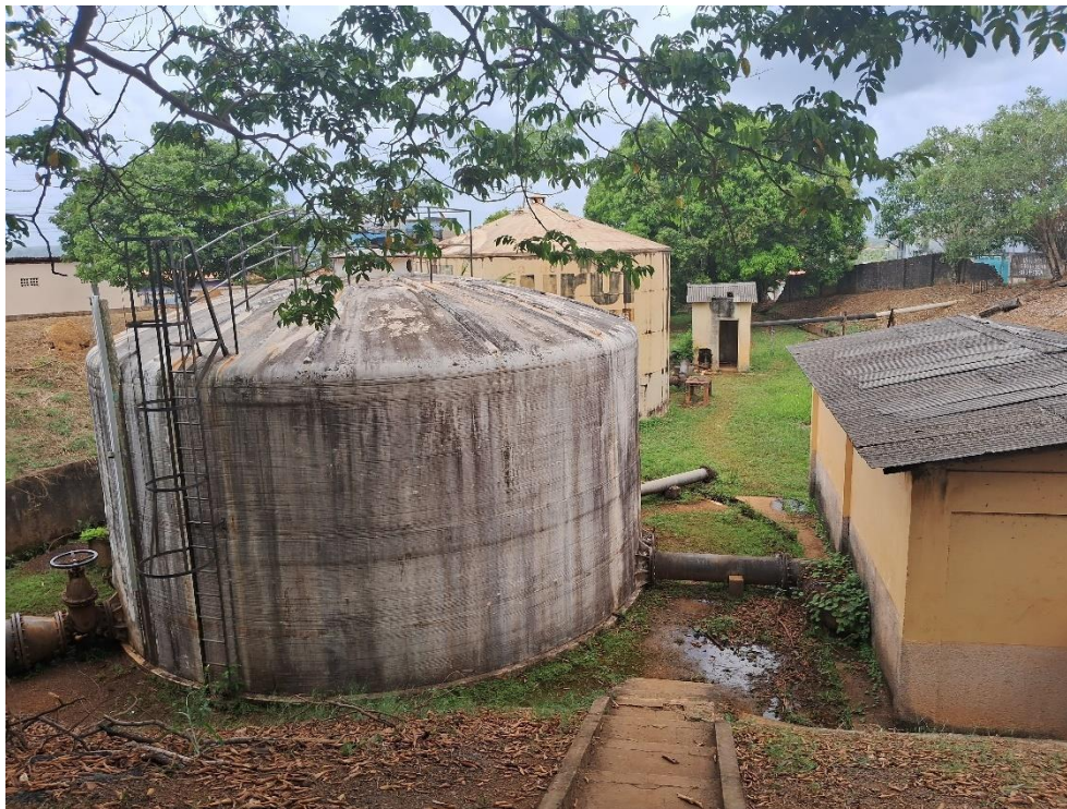
Figura 31. RAP01 – TUI02, Estrutura.
