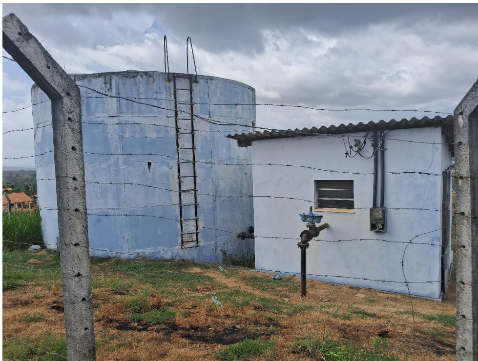
Figura 38. RAP – TUI07, Estrutura.
