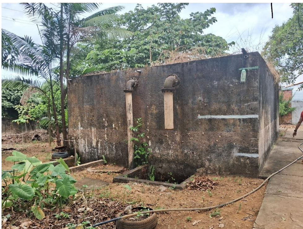
Figura 36. RAP – TUI05, Estrutura.
