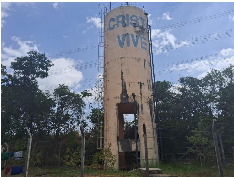
Figura 39. REL – TUI08, Estrutura.
