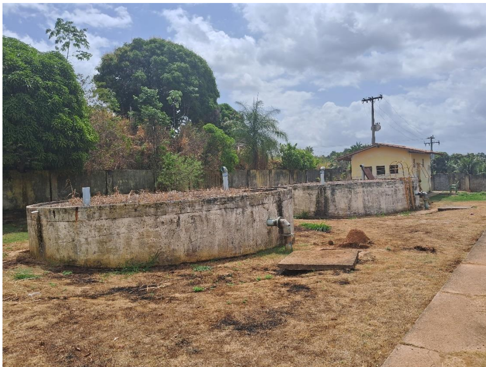
Figura 34. RAP – TUI03, Estrutura.
