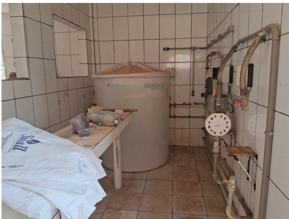
Figura 15. ETA – TUI01, Casa de química.
