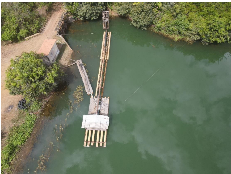
Figura 10. Captação – TUI09, Vista panorâmica. Fonte: Consórcio, 2023.
