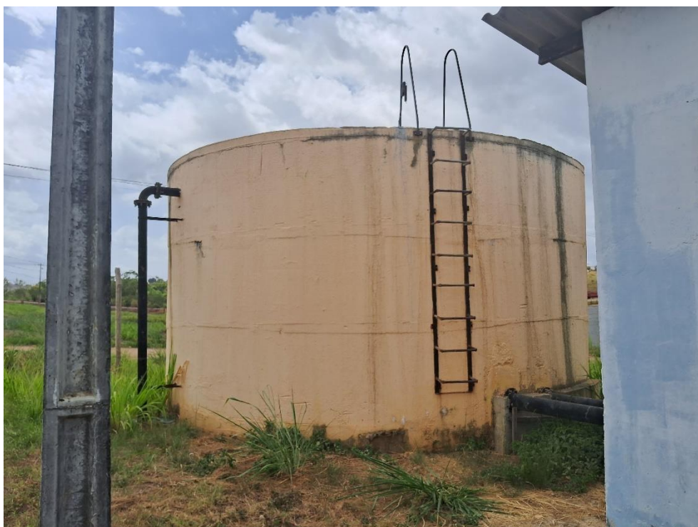
Figura 37. RAP – TUI06, Estrutura.
