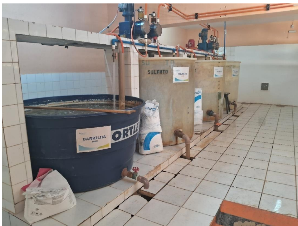
Figura 20. ETA – TUI01, Casa de química 01.
