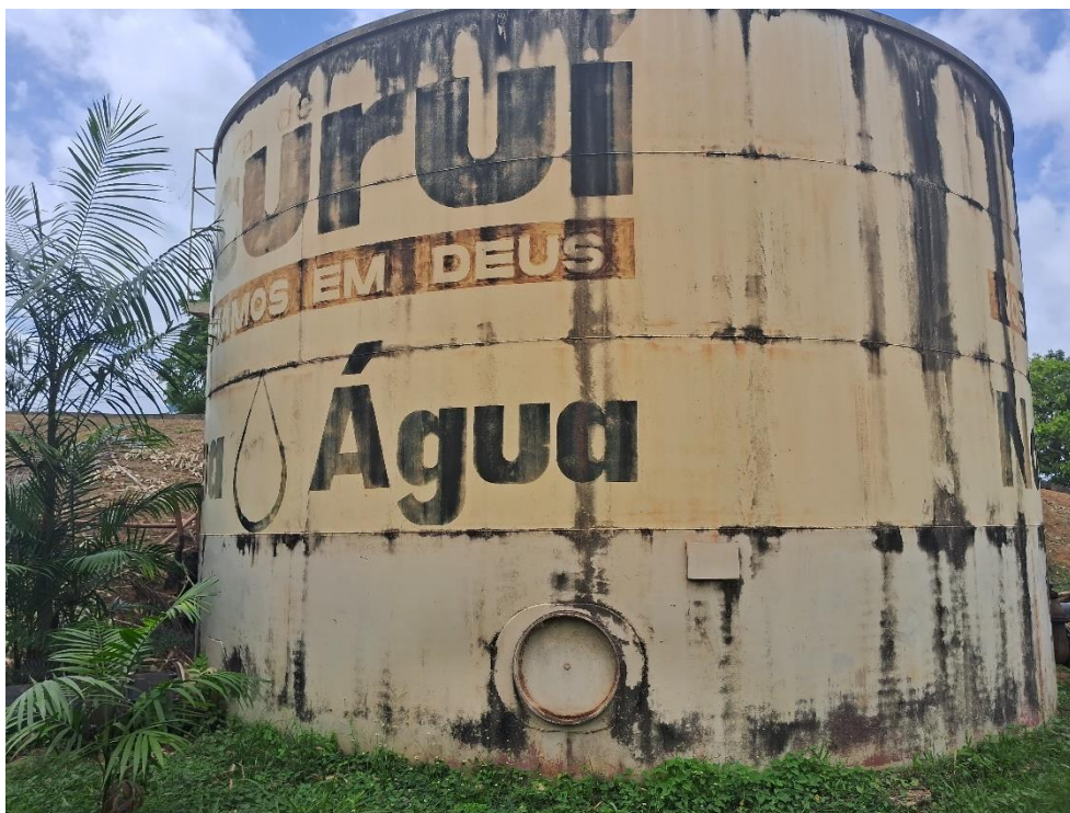
Figura 32. RAP02 – TUI02, Estrutura.
