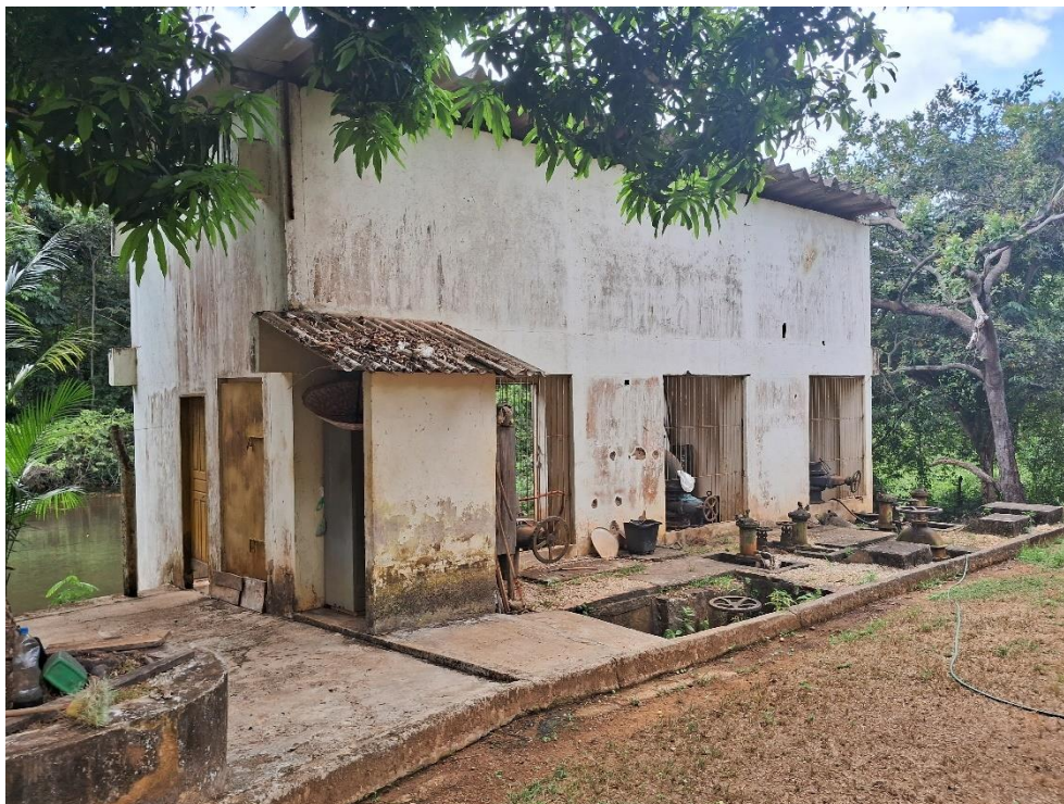
Figura 3. Captação - TUI01, Casa de motobombas.
