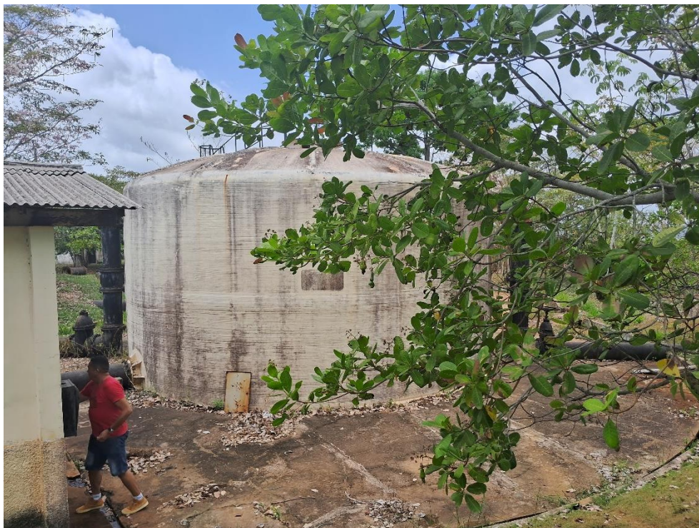
Figura 29. RAP01 – TUI01, Estrutura.
