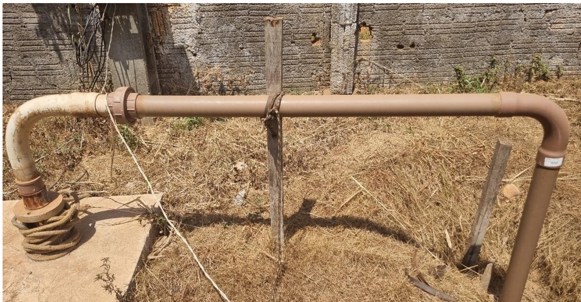
Figura 15. ULI13-CAPTAÇÃO. Captação subterrânea (bairro Vitório Depra).
