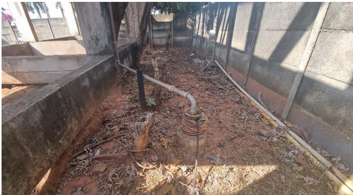
Figura 3. ULI01-CAPTAÇÃO. Captação subterrânea (bairro centro).
