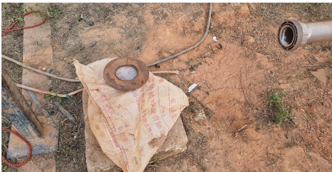
Figura 8. ULI06-CAPTAÇÃO. Captação subterrânea (bairro Bela Vista). Em manutenção no momento da visita. Fonte: Consórcio, 2023.
