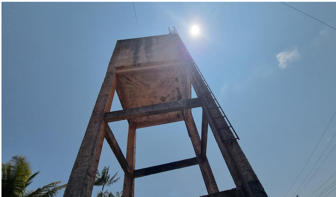
Figura 38. ULI14-REL: vista geral da estrutura.
