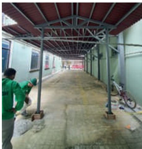
Ampliação da cobertura do estacionamento, dando mais conforto no acesso ao órgão
